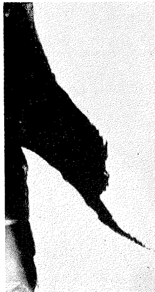
Fig. 8.—Grieta de trellado
