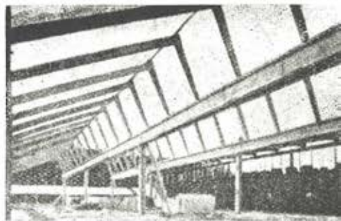
Fig. 16.—Vista de la estructura de la cubierta, una vez terminada.
