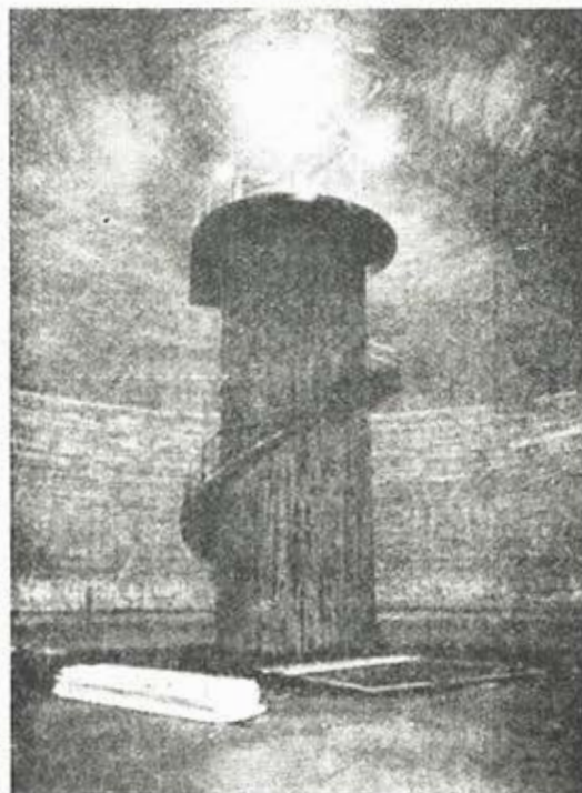
Fig. 12.—Interior de un depósito de agua, de 17 millones de litros de capacidad, construido en Suecia.
