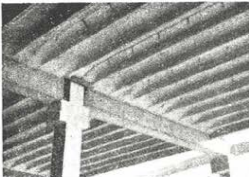
Fig. 21c.—Las placas del forjado vistas por su parte inferior.
