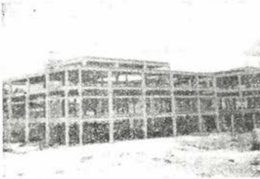
Fig. 21a.—Una vista del edificio durante su construcción.
