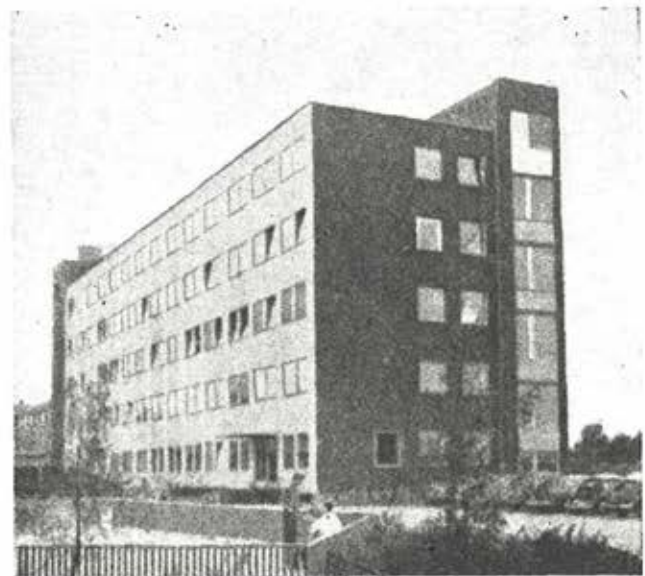
Fig. 27b.—El edificio terminado.
