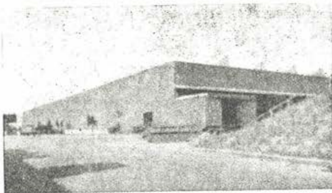
Fig. 8.—Vista del edificio industrial de una sola planta.
