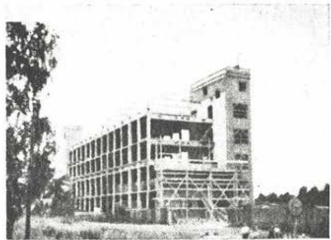
Fig. 27a.—Una vista del edificio durante su construcción.
