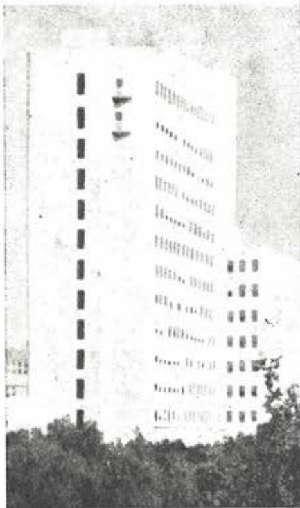
Fig. 30.—Vista del edificio terminado.
