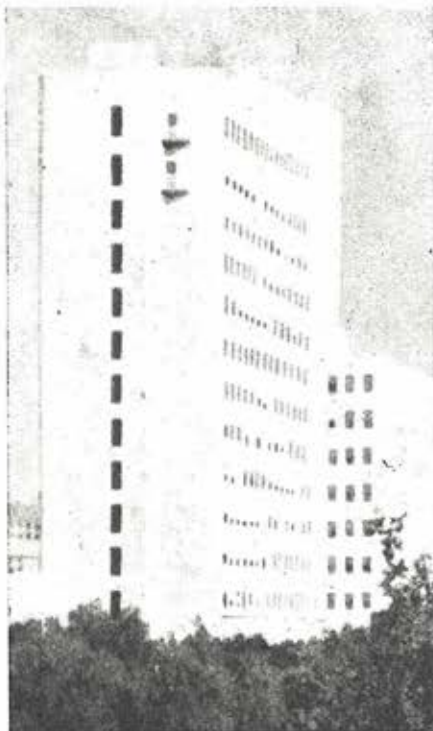
Fig. 30.—Vista del edificio terminado.
