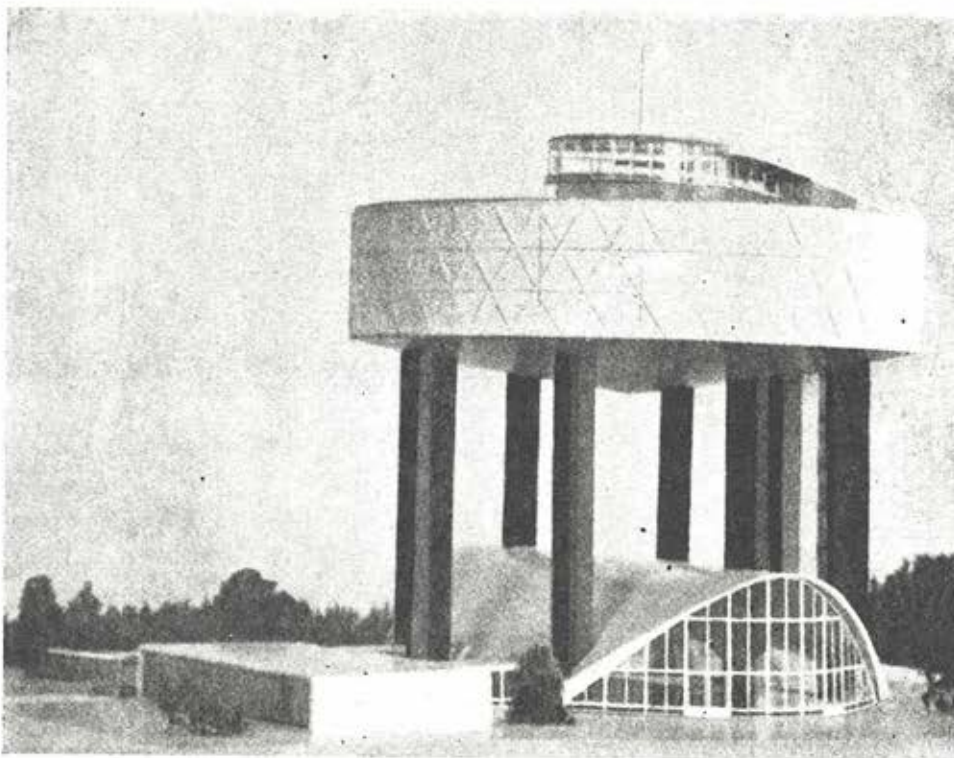
Fig. 14.—Depósito elevado de agua, de seis millones de litros de capacidad, construido en Dinamarca. Al nivel del terreno lleva un depósito supletorio de emergencia que puede utilizarse como piscina.
