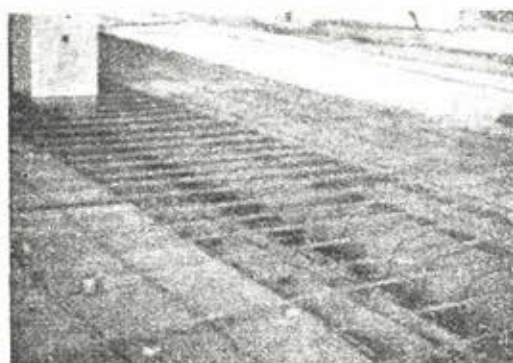
Fig. 21b.—Vista del forjado antes de hormigonar «in situ» la capa superior.
