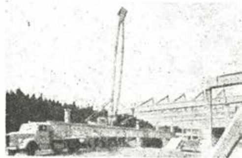
Fig. 15.—Vista de la estructura durante su construcción.
