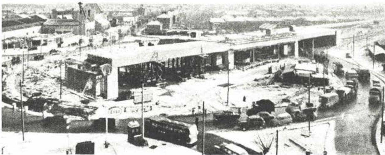
Fig. 4.—El viaducto de Chiswick durante su construcción. Atraviesa la plaza circular de Chiswick mediante cuatro tramos, casi iguales, de unos 38 m de longitud cada uno. Cada tramo está constituido por quince vigas de 38 m situadas unas al lado de las otras. A su vez, cada viga está formada por tres elementos prefabricados, de hormigón pretensado, de 11,60 m, 14,52 m y 11,60 m de longitud. Pueden observarse las columnas metálicas que sirven para el apoyo provisional de los elementos de las vigas. Estos elementos prefabricados fueron trasladados sobre remolques y colocados en obra con el auxilio de una grúa de 45 toneladas.
