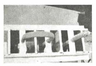
Fig. 12.—Moldes para la fabricación de los bloques de anclaje del tipo C. Aparecen ya situados los anclajes Freyssinet y los «Ductubes».
