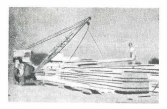
Fig. (C).—Apilado de postes de hormigón pretensado, de sección en I, en la zona de almacenaje. Cuando el terreno no está perfectamente liso y nivelado, deben colocarse los postes sobre apoyos aislados situados a 1,80 m entre ejes.
