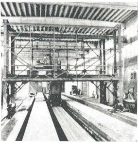
Fig. 4.—Un detalle de la máquina especial de hormigonado. — Fig. 5.—Puente - grúa en el que va montada la máquina de hormigonado y que se mueve sobre carriles a una velocidad de 1,5 m por minuto.
