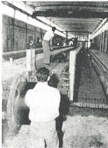
Fig. 2.—Colocación de los cables utilizados como armadura de pretensado. — Fig. 3. Dispositivo para el tesado automático de las armaduras.
