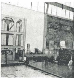
Fig. 2.—Colocación de los cables utilizados como armadura de pretensado. — Fig. 3. Dispositivo para el tesado automático de las armaduras.
