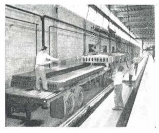
Fig. 6.—Sierra mecánica, refrigerada por agua, utilizada para cortar los paneles a la longitud requerida.—Fig. 7.—Dispositivo para el traslado de los paneles desde la bancada de fabricación a los remolques que habrán de llevarlos al almacén.
