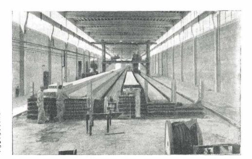
Fig. 1.—Una vista de la nave de fabricación en la cual podrán producirse diariamente, 2.000 m² de paneles de hormigón pretensado para forjados de piso o de cubierta.
