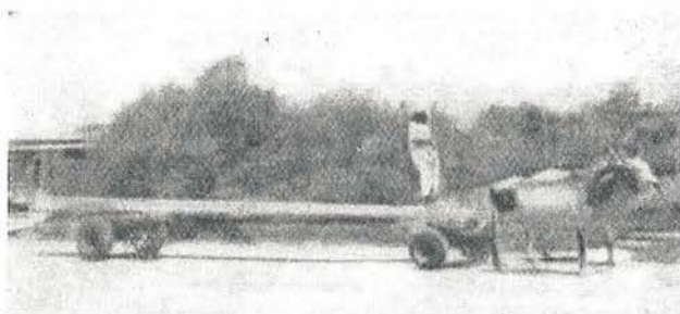
Fig. (D).—Un carretón con remolque para el transporte de postes en las zonas rurales. El juego delantero de ruedas es giratorio e independiente.
