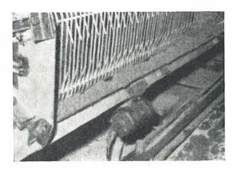
Fig. (C).—Hormigonado y vibrado de la cara inferior de la tubería. El molde exterior se va colocando a medida que avanza el hormigonado.
