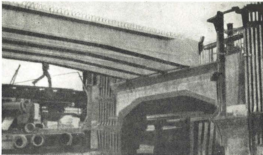
Fig. 3. Muelle de Erith, sobre el Támesis. Vigas de hormigón pretensado enlazan entre sí, dos a dos, los pilotes, asegurándose de esta forma la estabilidad transversal de la estructura contra los choques de los barcos.
