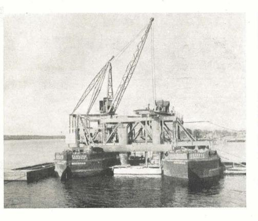
Fig. 13. Puente de Abidjan. Instalación para la hinca en el lago, de los pilotes sobre los cuales se cimentan las pilas. Entre las dos chalanas, enlazadas entre si por un pórtico, se distingue la parte superior de uno de los cajones huecos de la pila. Las perforaciones para los pilotes tenían 1,50 m de diámetro.
