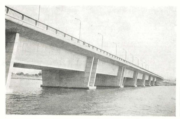
Fig. 7. El puente de Abidjan, mixto para ferrocarril y carretera, de 550 m de longitud, en hormigón pretensado. Consta de 8 tramos de 46,5 m de luz entre ejes de pilas y dos viaductos de acceso de 89 m.
