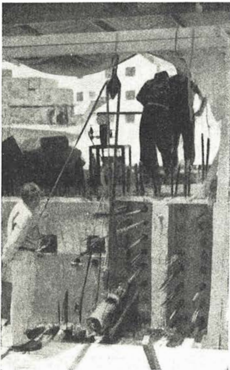
Fig. 14.—Puesta en tensión de los cables.
