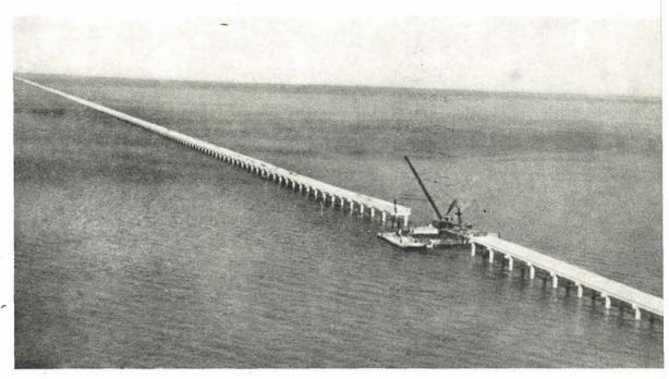
Fig. 14. El puente sobre el lago Pontchartrain, cerca de Nueva Orleáns (Estados Unidos). Estructura de hormigón pretensado, de 38 km de longitud (2.232 tramos de 17 metros).
