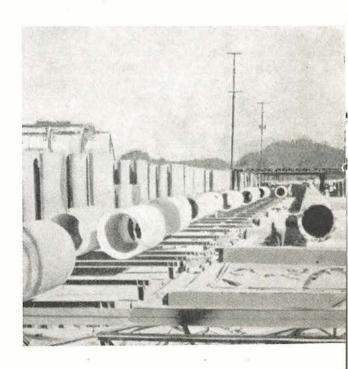
Fig. 20. Puente sobre el lago Pontchartrain. Uno de los tramos durante su colocación. El puente consta de 2.232 tramos análogos de 17 m de longitud y 10 m de anchura, prefabricados.
