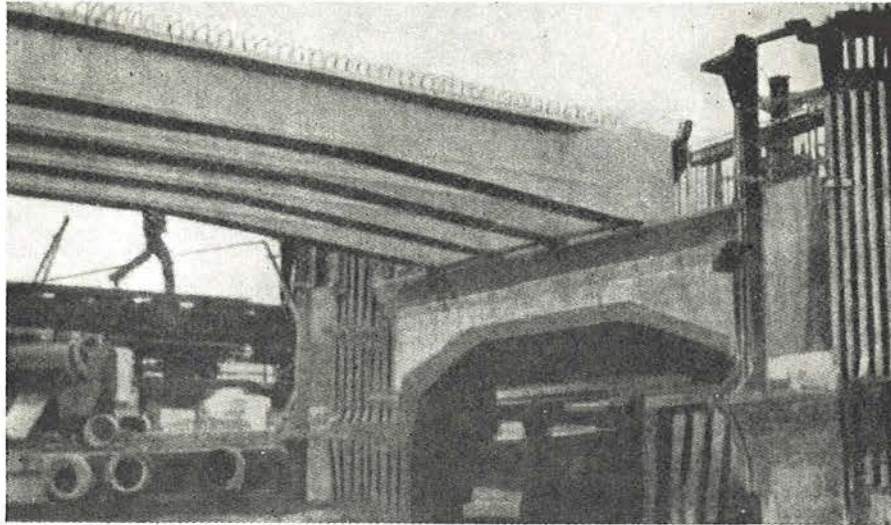
Fig. 3. Muelle de Erith, sobre el Támesis. Vigas de hormigón pretensado enlazadas entre sí, dos a dos, los pilotes, asegurándose de esta forma la estabilidad transversal de la estructura contra los choques de los barcos.
