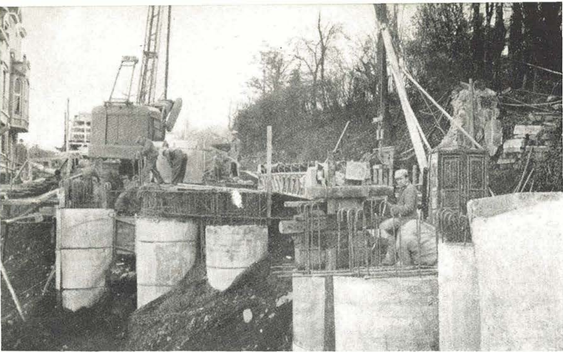
Fig. 30. Construcción del nuevo muro de contención de la estación de Guillemins, en Lieja. Vista de la parte superior de las entibaciones circulares de hormigón armado, para los pozos de cimentación, durante la ejecución. Encima llevan una placa de hormigón armado.
