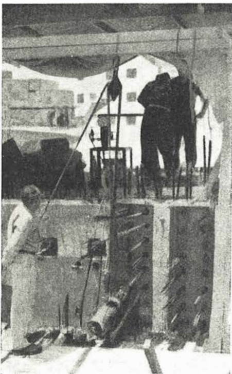
Fig. 14.—Puesta en tensión de los cables.
