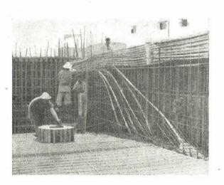
apoyos, era de unos 12 kg/cm². Fue transformada por el pretensado horizontal, en una compresión de 10,5 kg/cm².
