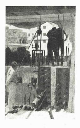
Fig. 14.—Puesta en tensión de los cables.
