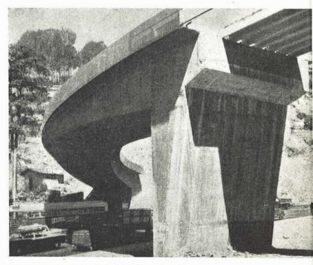
Fig. 16.—Obra terminada. En la fotografía aparece claramente la curvatura de la directriz del tablero (5,50 m de excentricidad con relación al eje de pilares).
