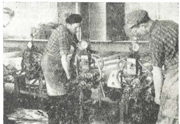
Fig. 4. Tesado de barras en traviesas postesadas.
