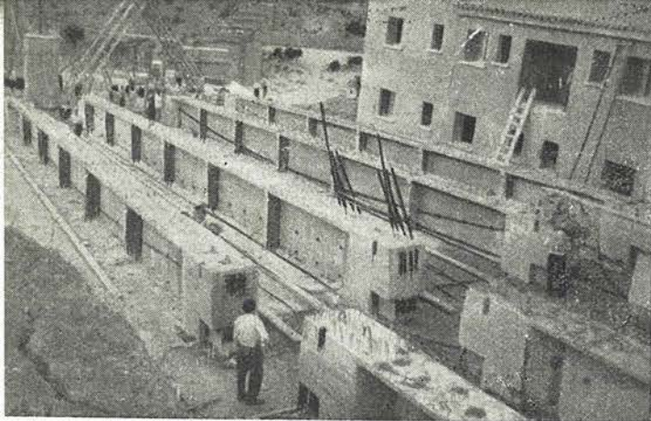
Era de prefabricación.
