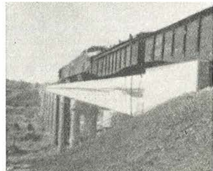
Fig. 14. Puente de la Compañía del Pacífico, en Houston, Texas.
