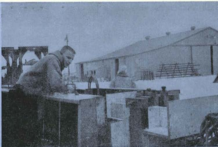
Comprobación del hormigón armado.
