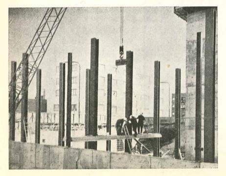
Fig. 4.—Colocación de una de las losas del forjado.
