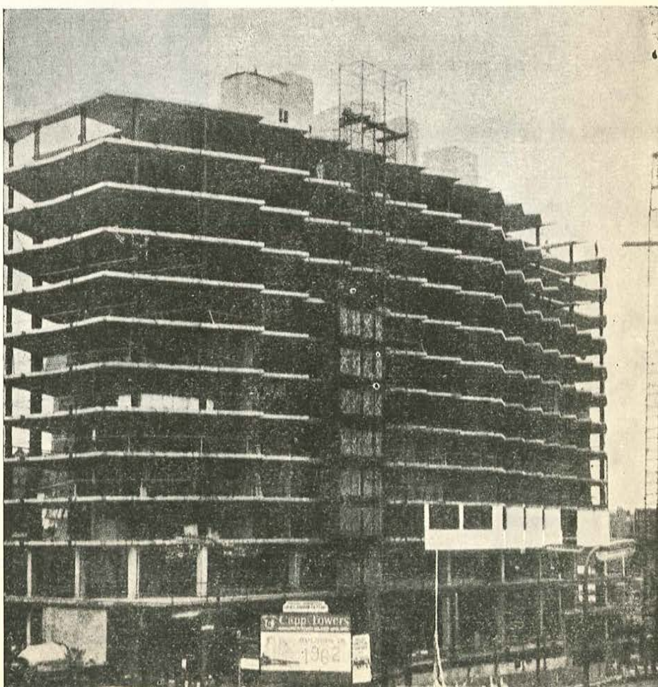
Fig. 33.—Vista de conjunto de la estructura, completa en sus elementos horizontales; se han colocado ya los primeros paneles verticales de fachada.
