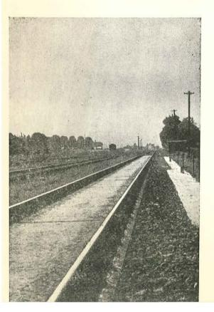
La placa pretensada está constituida por dos nervios longitudinales arriostrados por una solera de sección variable.
