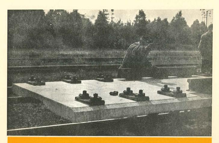
Sujeción de las pletinas de anclaje sobre las placas pretensadas
