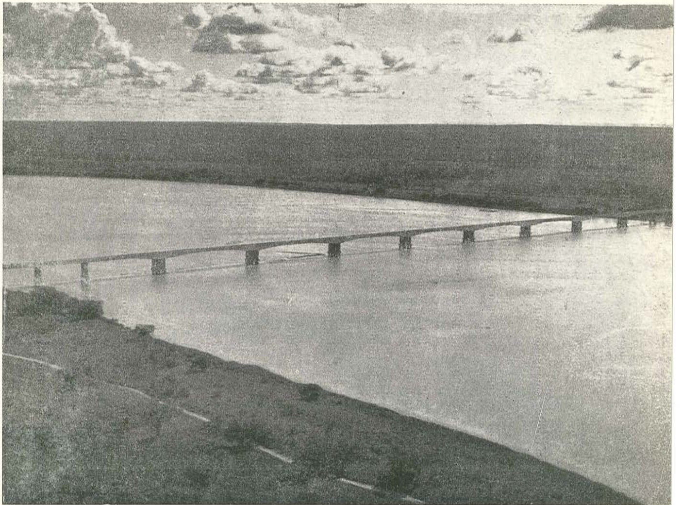
Figs. 35-36.—Dos vistas del puente durante las últimas fases de su construcción
