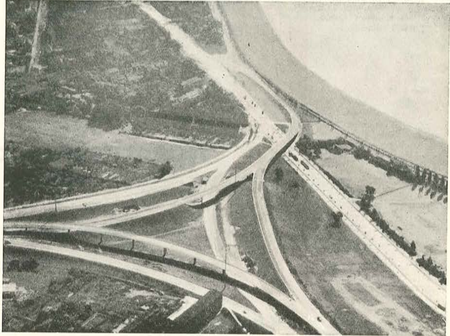
Fig. 13.—Cruce a distinto nivel en la autopista Heerdter, en Düsseldorf, Alemania Occidental. El tablero del ramal elevado está constituido por una o dos vigas cajón, de hormigón pretensado, sustentadas por una sola fila central de soportes circulares elípticos (película F. I. P.).
