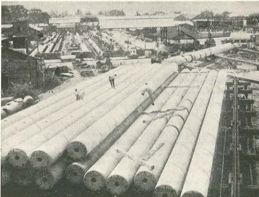
Fig. 14.—Pilotaje de un puente en North Klang Straits, Malaya. Se necesitaron para este puente 1.500 pilotes de hormigón pretensado, de 45,5 m de longitud cada uno. Los pilotes tienen un diámetro exterior de 87,5 centímetros y paredes de 11,6 cm de espesor (película F. I. P.).
