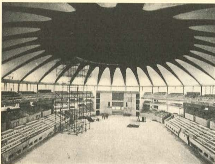
Palacio de deportes, en Lyon (Francia): La cúpula de la cubierta, que tiene 85 m de diámetro, descansa sobre un anillo pretensado que se apoya, a su vez, sobre 28 soportes. Este anillo, al propio tiempo, forma la cubierta-terrazza de la galería. La gran anchura del anillo le permite resistir el esfuerzo de pandeo originado por la cúpula. La cúpula tiene 7 cm de espesor y lleva en el borde 28 lunetos que proporcionan una buena iluminación natural al interior del edificio.
