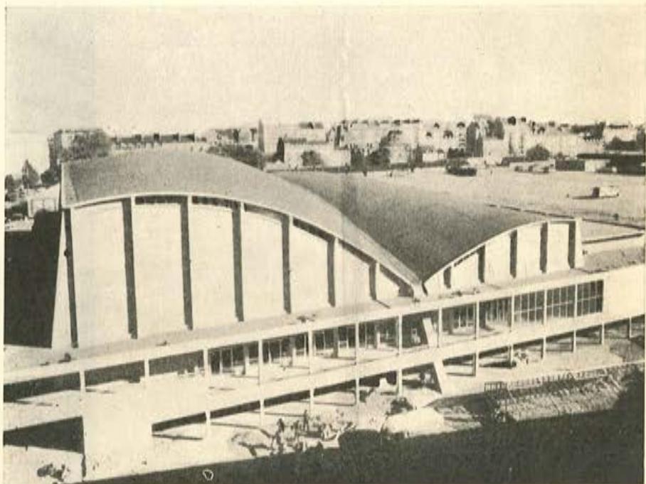
Palacio de deportes, en Rennes (Francia): Este edificio, de 78 m de longitud y 46,80 m de anchura, tiene una cubierta cuya estructura resistente está constituida por dos arcos parabólicos que se apoyan, en el centro, sobre otro arco parabólico de luz igual a la longitud del local.
