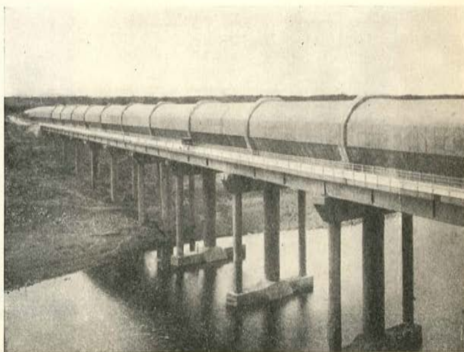
Sifón en el valle de Kuru (India): Una conducción de más de 1,5 km de longitud y 6 m de diámetro, lleva el agua para riego, a lo largo del valle, con una presión equivalente a una altura monométrica de 26 m. Parte de la conducción se apoya sobre un puente de 11 tramos, que se aprovecha también como puente de carretera.
