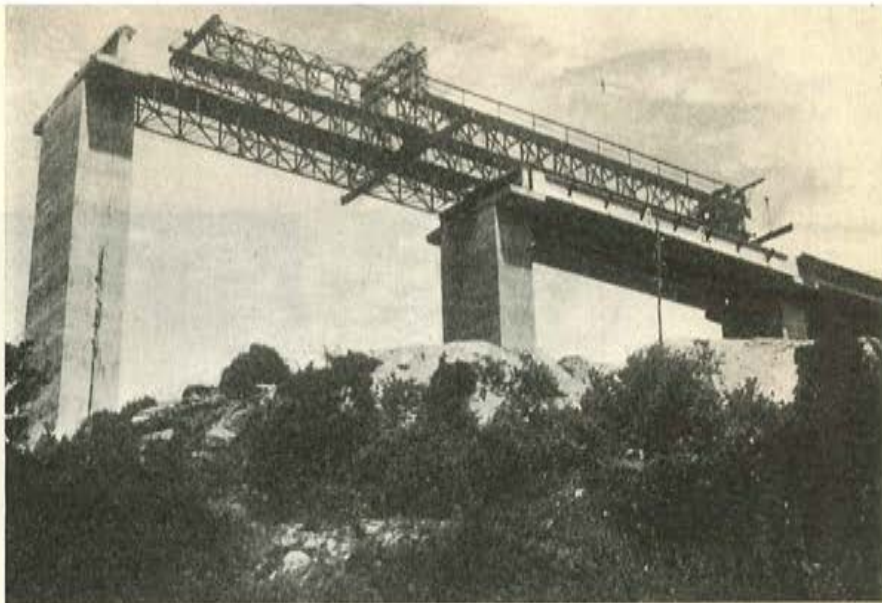
Viaducto sobre el lago Taloro (en Cerdeña): El viaducto está formado por ocho tramos de hormigón pretensado.
