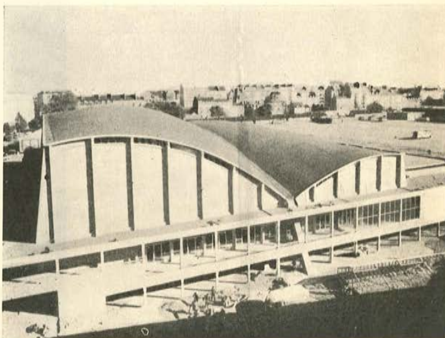
Palacio de deportes, en Rennes (Francia): Este edificio, de 78 m de longitud y 46,80 m de anchura, tiene una cubierta cuya estructura resistente está constituida por dos arcos parabólicos que se apoyan, en el centro, sobre otro arco parabólico de luz igual a la longitud del local.
