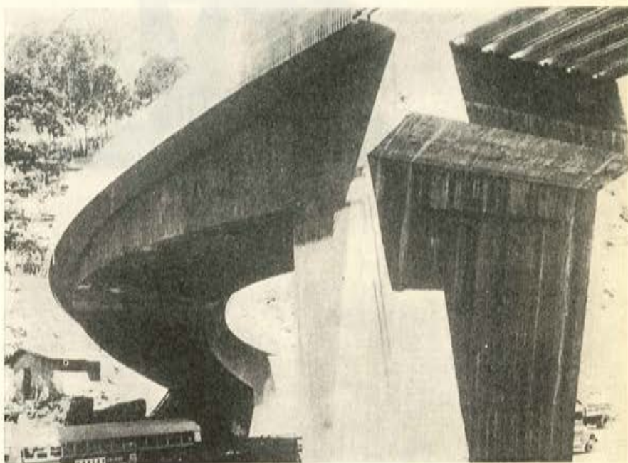
Puente helicoidal (Caracas): Se trata de un puente curvo, de hormigón pretensado, de 53,72 m de luz. Su sección en cajón está dimensionada para resistir el momento torsor originado por la curvatura del puente. Las pilas pretensadas se proyectaron para soportar el momento de vuelco y se apoyan sobre zapatas que vuelan 5 m por uno de los lados.
