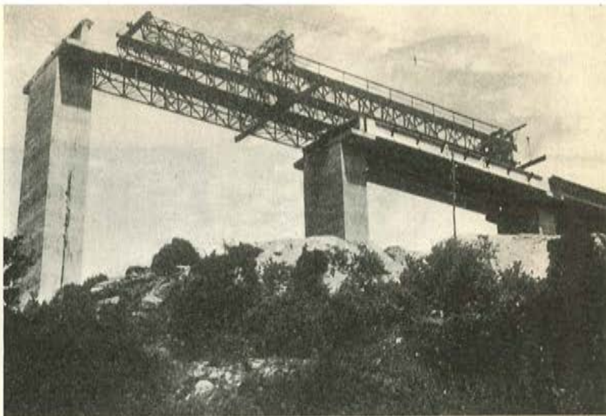
Viaducto sobre el lago Taloro (en Cerdeña): El viaducto está formado por ocho tramos de hormigón pretensado.
