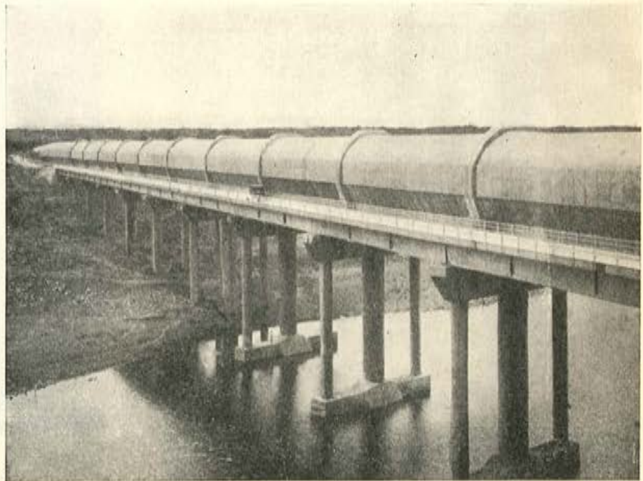
Sifón en el valle de Kunu (India): Una conducción de más de 1,5 km de longitud y 6 m de diámetro, lleva el agua para riego, a lo largo del valle, con una presión equivalente a una altura monométrica de 26 m. Parte de la conducción se apoya sobre un puente de 11 tramos, que se aprovecha también como puente de carretera.
