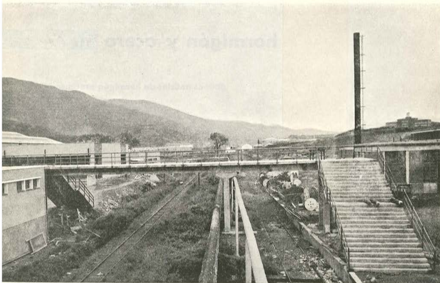
Pasarela de peatones en Bilbao. Constructor: AYNCO, S. A. - Bilbao
