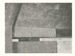
Fig. 1.—Apoyos constituidos por placas de material elástico.
