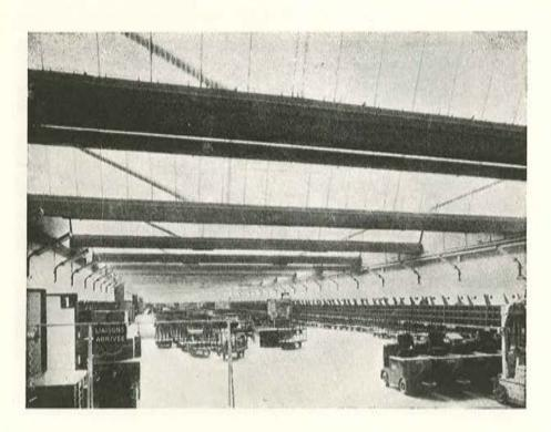
Edificio del "Paris Press", en la Villette, Francia. En él se ha utilizado ampliamente el pretensado, con lo cual se ha conseguido una cubierta de 22 metros de lux libre.
