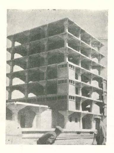
Edificio industrial, de varias plantas, en Wroclaw, Polonía. En todo el edificio se ha utilizado la prefabricación en gran escala. Los forjados de las plantas van pretensados en dos direcciones.
