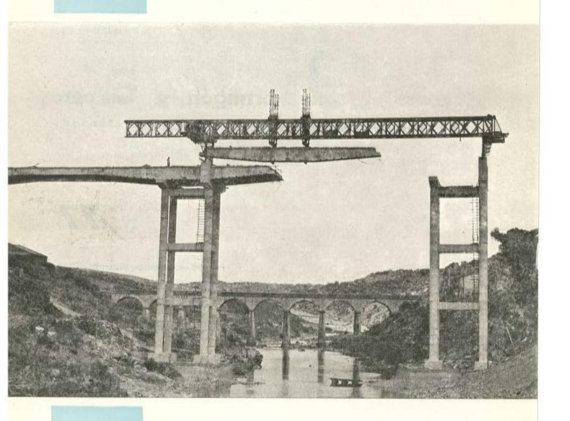
puente de Ahigal, Hidroeléctrica Española; montaje de tramos en ménsula; postesado con cables Ø 12 mm
