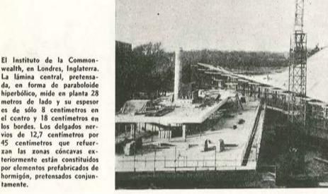
El Instituto de la Commonwealth, en Londres, Inglaterra. La lámina central, pretensada, en forma de paraboloide hiperbólico, mide en planta 28 metros de lado y su espesor es de sólo 8 centímetros en el centro y 18 centímetros en los bordes. Los delgados nervios de 12,7 centímetros por 45 centimetros que refuerzan las zonas cóncavas exteriormente están constituidos por elementos prefabricados de hormigón, pretensados conjun-
