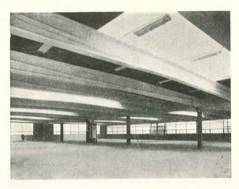
La fábrica Billman, en San Quintín, Francia. Tiene cubierta plana sobre vigas continuas, de 18 metros de lux, pretensadas mediante cables exteriores. La continuidad de las vigas se consigue utilixando barras pretensadas.
