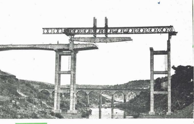
puente de Ahigal, Hidroeléctrica Española; montaje de tramos en ménsula; postesado con cables ∅ 12 mm
