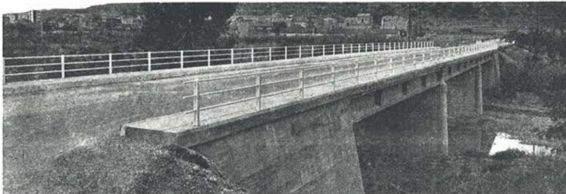
Puente sobre el río Cardener en S. Juan de Vilatorrada. 3 tramos de 20 - 25 - 20 m. Postensado con 80 cables BS-100, 8 BS-64 y 20 BD-60. Peso total de acero: 14.557 Kg.
