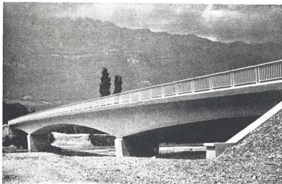
Fig. 17.—Puente de Goncelin sobre el río Isère, en Francia.
