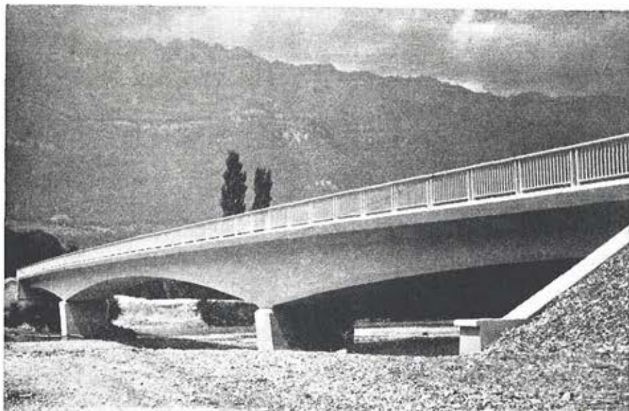
Fig. 17.—Puede de Goncelin sobre el río Isère, en Francia.
