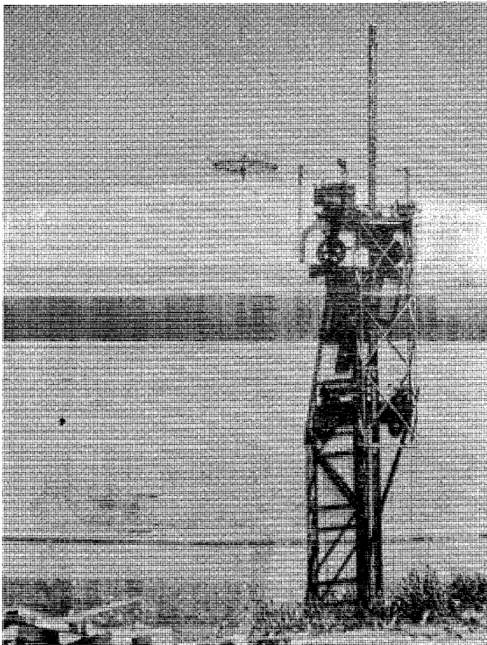
Máquina de pretensar depósitos.
