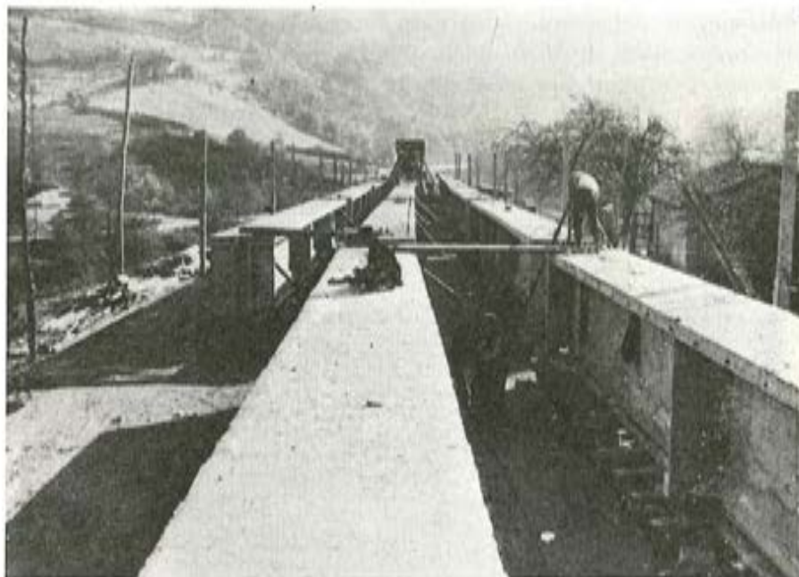
Fig. 3.—Puente de Migoya (Asturias)
