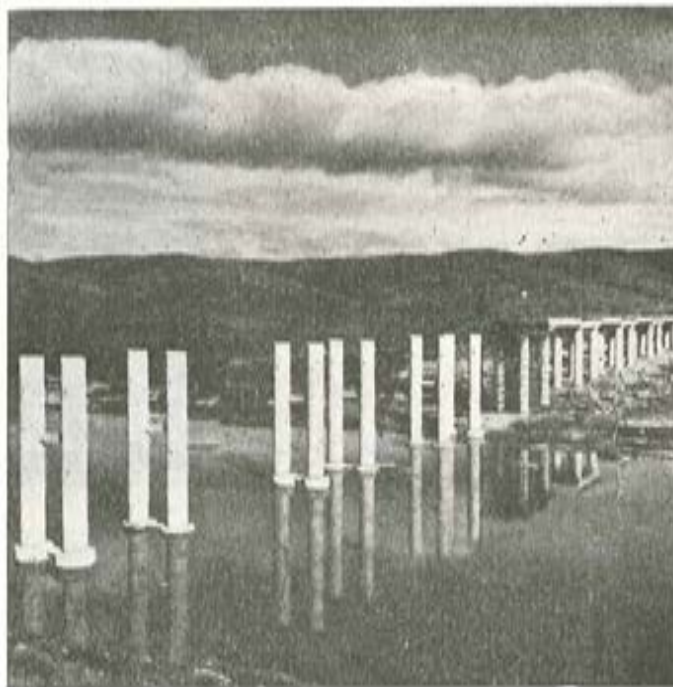
Fig. 12.—Viaducto de Sancti-Spiritu (Badajoz)
