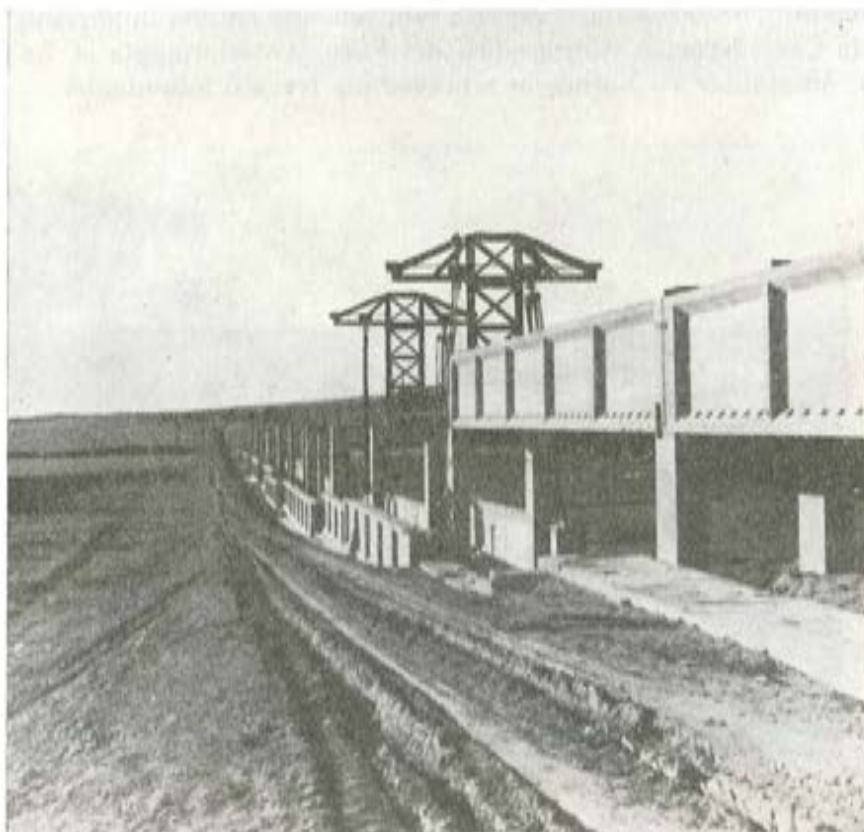
Fig. 14.—Acueducto de El Gato, en Palma del Río (Córdoba)
