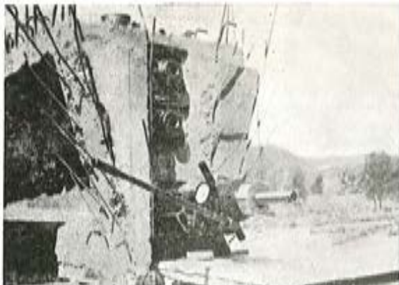
Tensado de una viga de un tramo de 20 m.
