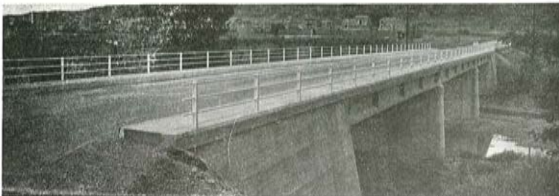
Puente sobre el río Cardener en S. Juan de Vilatorrada. 3 tramos de 20 - 25 - 20 m. Postensado con 80 cables B5-100, B 85-64 y 20 B0-60. Peso total de acero: 14.557 Kg.
