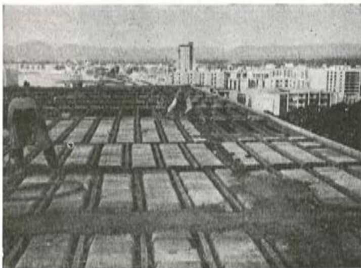
Fig. 2.—Forjado cerámico pretensado dispuesto para hormigonado.
