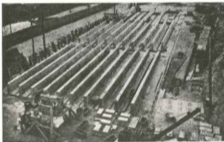
Fig. 20.—Vigas para el muelle de la Térmica en el puerto de Pasajes (Guipúzcoa)
