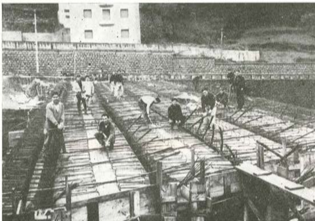
Fig. 9.—Puente sobre el río Deva, en Elgóibar (Guipúzcoa)
