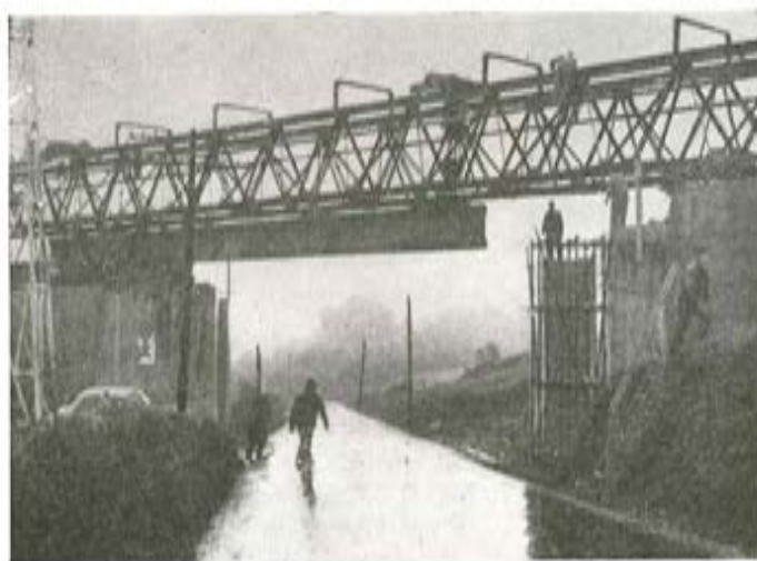
Fig. 4.—Puente de Perlora (Gijón)
