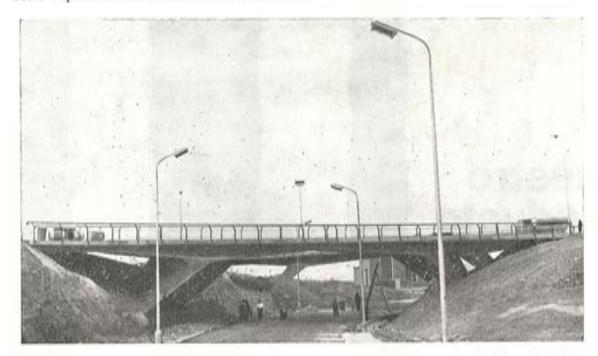
Superiormente, después de terminar la estructura resistente, se hará el recubrimiento necesario con hormigón y se pavimentará con 8 cm de espesor de aglomerado asfáltico.
