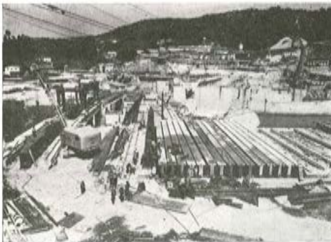
Fig. 6.—Puente sobre la presa de Velle (Orense). Parque de fabricación
