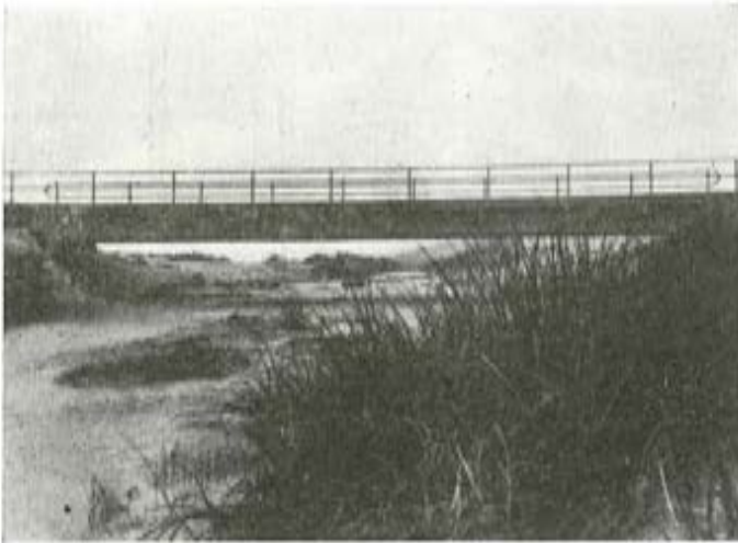
Fig. 5.—Puente de Villanueva de los Infantes (Valladolid)
