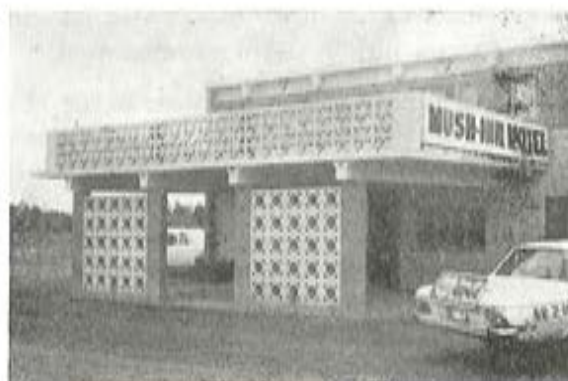
Fig. 4.—Anchorage (Mush Inn Motel): Ejemplo de edificio con viguetas pretensadas. No ha sufrido daños.
