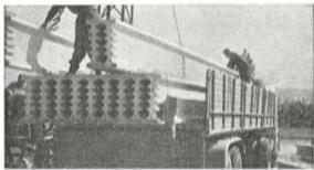
Vigas pretensadas para puentes
