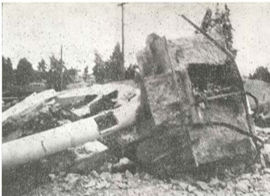
Fig. 10.—Anchorage (Four Seasons Building: Vista de una abrazadera de fijación de una placa de forjado sobre una columna metálica.
