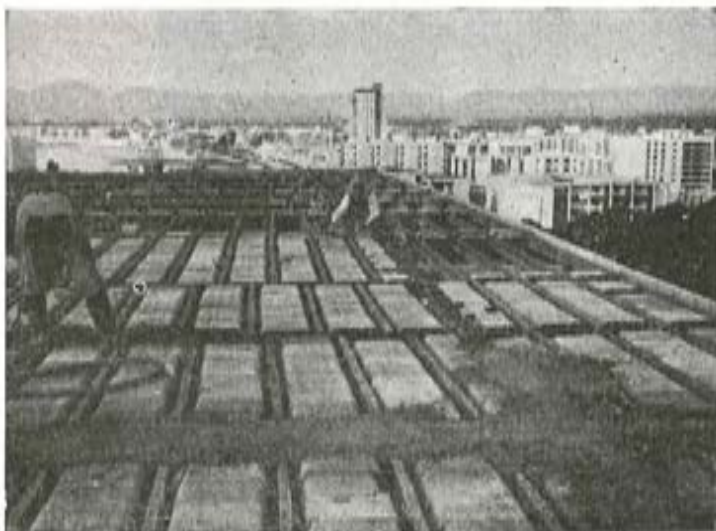
Fig. 2.—Forjado cerámico pretensado dispuesto para hormigonado.
