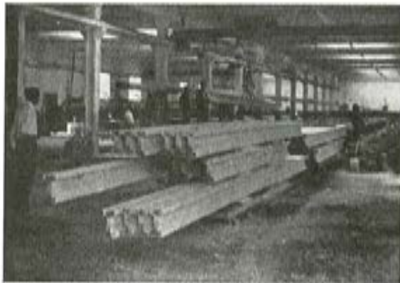
Fig. 3.—Desmoldeo y retirada de los moldes de las viguetas fabricadas.
