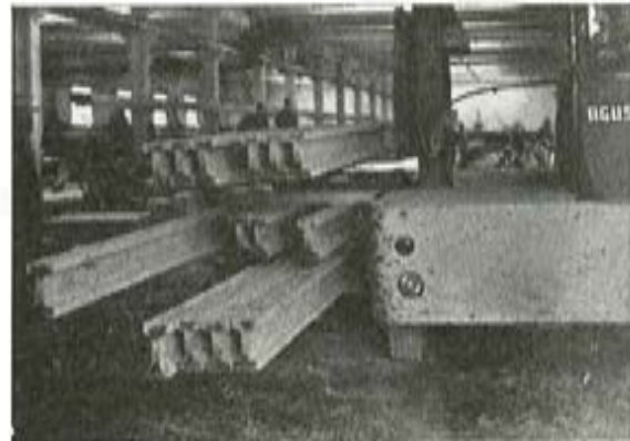
Fig. 4.—Transporte de viguetas al exterior de la nave de fabricación.
