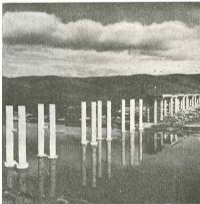
Fig. 12.—Viaducto de Sancti-Spiritu (Badajoz)
