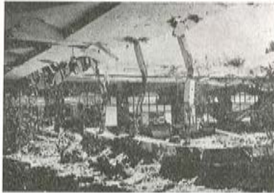
Fig. 2.—Skopje: El Palacio de la Feria, Vista interior después del derrumbamiento.
