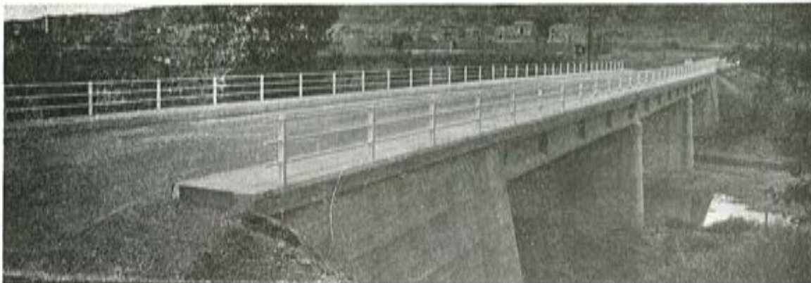
Puente sobre el río Cardener en S. Juan de Vilatorrada. 3 tramos de 20 - 25 - 20 m. Postensado con 80 cables B5-100, B 85-64 y 20 B0-60. Peso total de acero: 14.557 Kg.
