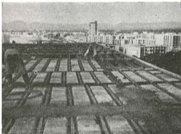
Fig. 2.—Forjado cerámico pretensado dispuesto para hormigonado.
