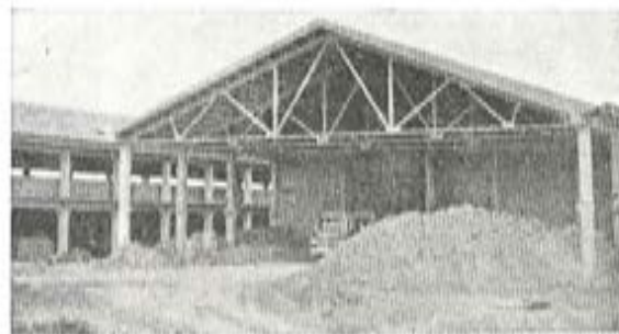
Cubiertas de naves
