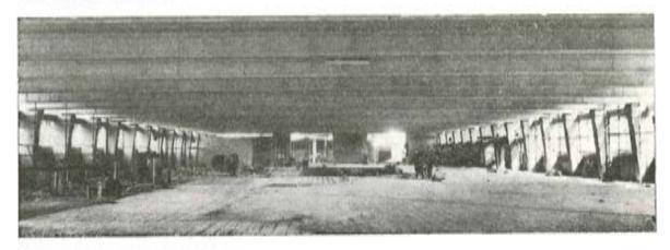
El número necesario de ternas de cables para absorber las tracciones en la cabeza inferior de la viga en la sección central ha sido de 21, que se han levantado según se puede ver en una de las figuras adjuntas, a medida que van disminuyendo los momentos y aumentando los esfuerzos cortantes.
