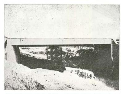
Fig. 2.—Puente sobre el torrente La-moggia (Bolonia): Es el primer puente italiano realizado a base de dovelas prefabricadas. Se construyó durante los años 1949-1950, utilizando el sistema Magnel.
