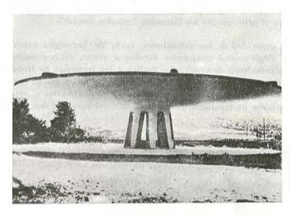
Fig. 9.—Mercado cubierto de Vergato (Bolonia): Construido en 1955, su estructura está formada por una serie de vigas-ménsula, radiales, sobre planta circular, empotradas en los soportes centrales.
