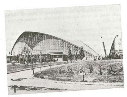
Fig. 12.—Nuevo Palacio de Exposiciones, en Turin: Cada uno de los arcos que constituyen la cubierta funciona como funicular bajo su peso propio.
