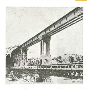
Fig. 3.—Puente sobre el Santerno, en Filetto (Bolonia): Construido en 1953. Los cables van exteriores, adosados al nervio de las vigas.
