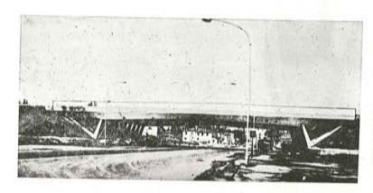
Fig. 7.—Puente de la Via Olímpica, en Roma: Las vigas fueron construidas, por voladizos sucesivos, a partir de las pilas extremas, provistas de tirantes que permiten regular los esfuerzos que actúan sobre la viga en cada momento (1959-1960).
