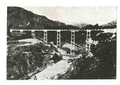
Fig. 1.—Viaducto sobre el río Piave, en Vallesella (Belluno): Es el primer viaducto italiano en hormigón pretensado. Se construyó durante los años 1949-1950, utilizando el sistema Freyssinet.
