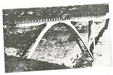
Fig. 4.—Pasarela sobre el "Fosso di Lussia" Vagli di Sotto (Garfagnana): Construido en 1955. Ejemplo de puente en arco, de tres articulaciones, prefabricado en dos semiarcos.
