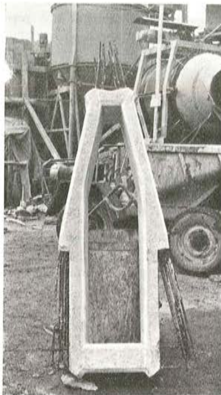
Fig. 15.—El elemento 1, de hormigón armado prefabricado
