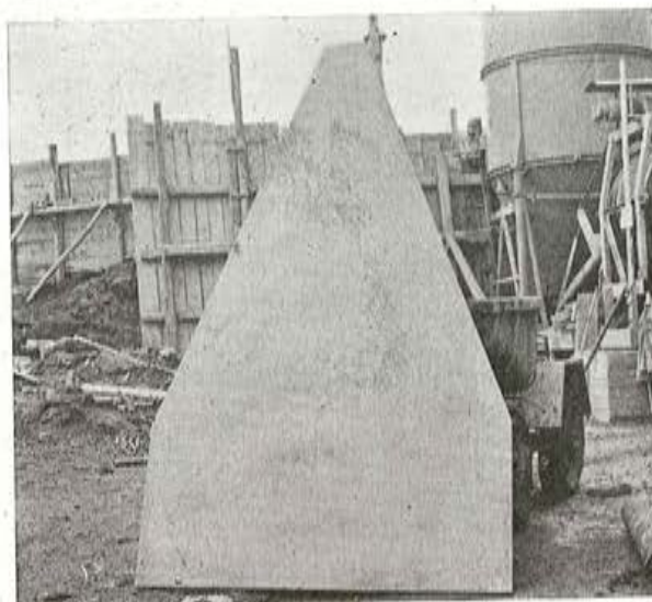
Fig. 19.—Placa de cerramiento, de hormigón armado, prefabricada
