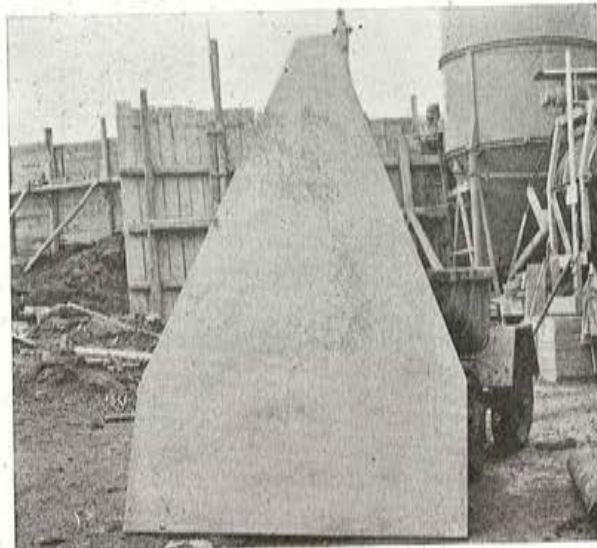
Fig. 19.—Placa de cerramiento, de hormigón armado, prefabricada
