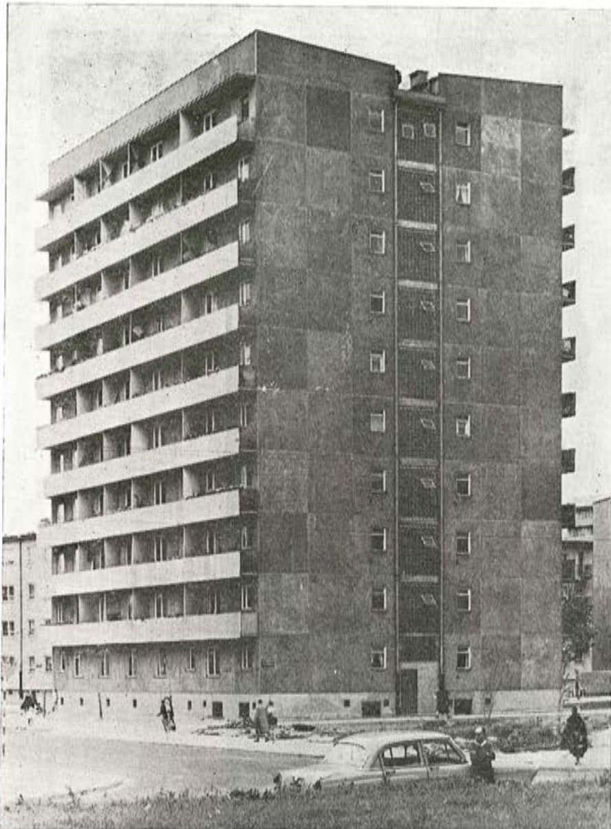
Otro ejemplo de edificio, construido en Varsovia, utilizando grandes paneles prefabricados de hormigón.
