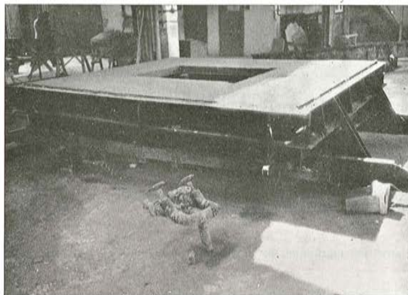
Panel, con hueco de ventana, hormigonado en molde horizontal.
