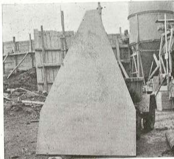
Fig. 19.—Placa de cerramiento, de hormigón armado, prefabricada
