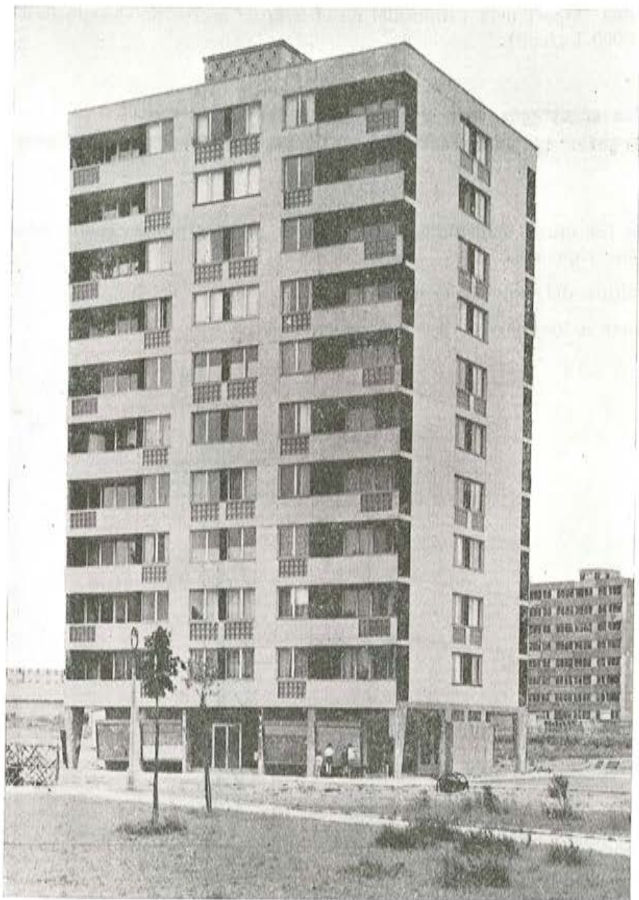
Ejemplo de edificio, construido en Varsovia, utilizando grandes paneles prefabricados de hormigón.
