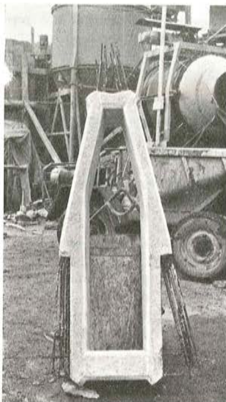
Fig. 15.—El elemento 1, de hormigón armado prefabricado
