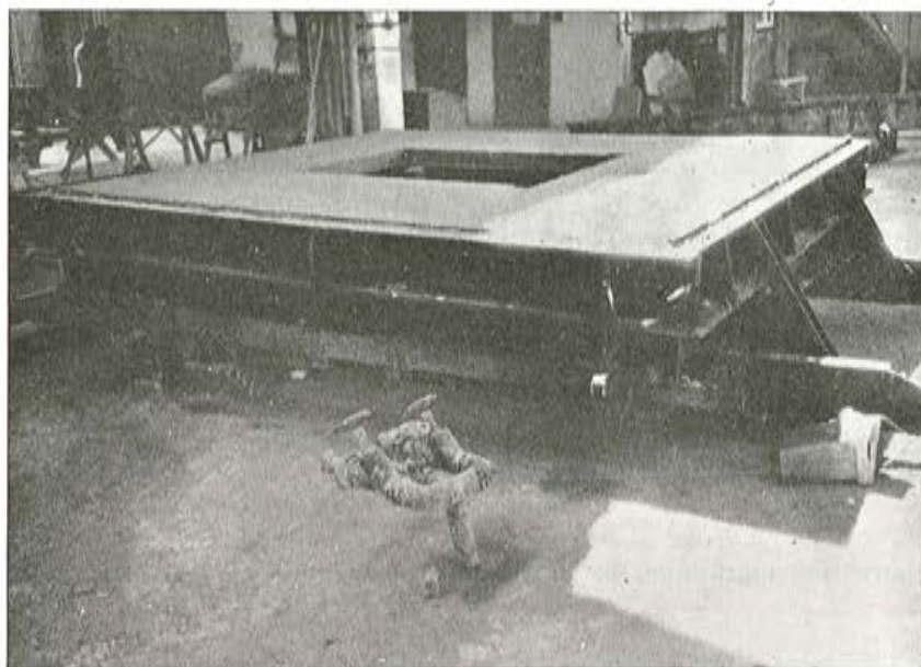
Panel, con hueco de ventana, hormigonado en molde horizontal.
