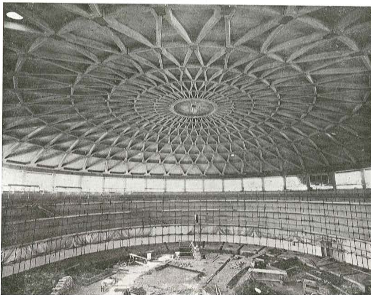
Fig. 25.—Vista, desde el interior, de la cúpula terminada
