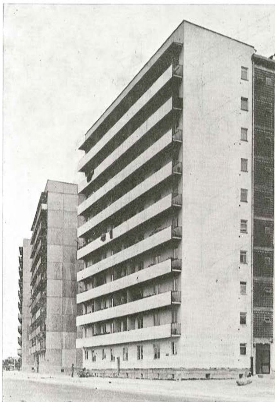
Otro ejemplo más de edificio, construido en Versovia, utilizando grandes paneles prefabricados de hormigón.
