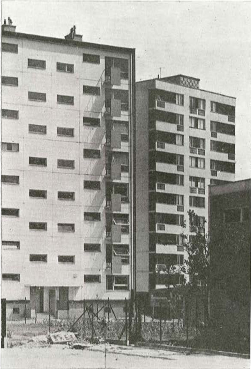
Un segundo ejemplo de edificio, construido en Varsovia, utilizando grandes paneles prefabricados de hormigón.
