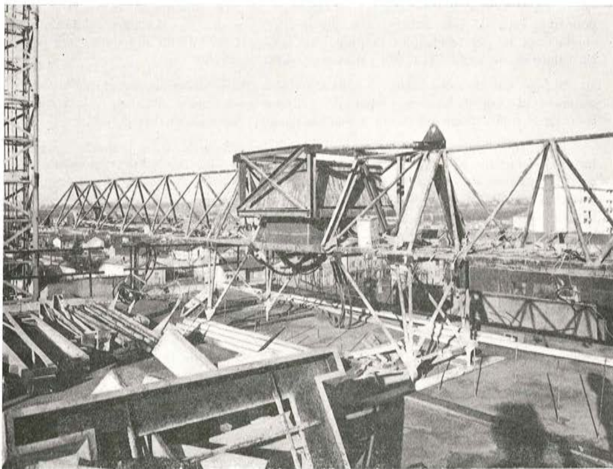
Fig. 4. — Iniciación de las operaciones de endurecimiento de los forjados mediante el empleo de resistencias eléctricas, en un conjunto de edificios constituido por 300 viviendas. La potencia eléctrica utilizada, de muy baja tensión — inferior a 50 voltios —, era del orden de 120 kW, para una superficie unitaria de 185 metros cuadrados.
