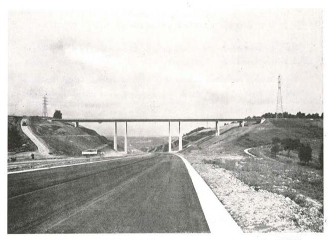
Puente de Saive, en la autopista Amberes-Lieja. En su construcción se utilizaron 24 vigas PREFLEX de luces variables entre 19,60 m y 34,40 m.
