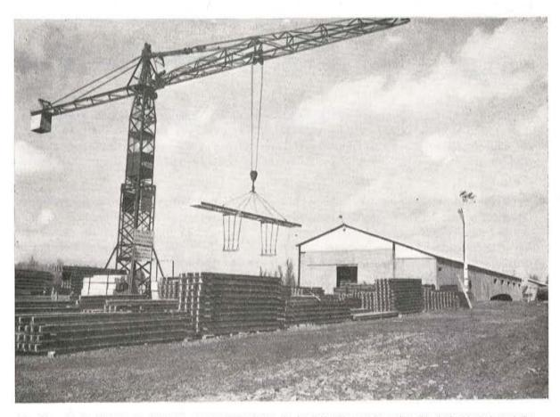
Fig. 3. — En la fábrica de Graçay, el endurecimiento de las viguetas pretensadas de cerámica y hormigón se acelera empleando las armaduras como resistencias eléctricas de calentamiento. A las veintidos horas, en ausencia del personal, un reloj regula automáticamente el calentamiento de la bancada fabricada durante el día.
