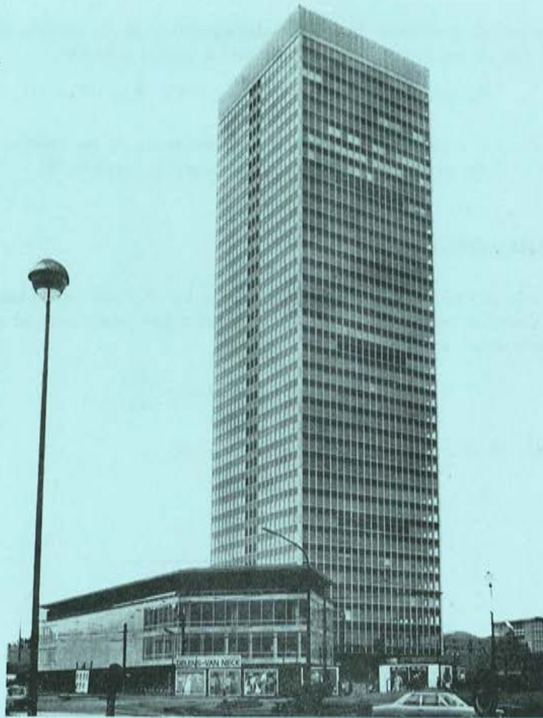
Edificio "Tour du Midi", en Bruselas. Se utilizaron 144 vigas PREFLEX de 40 m de longitud, en la construcción de la torre, y 16 en los edificios anejos.
