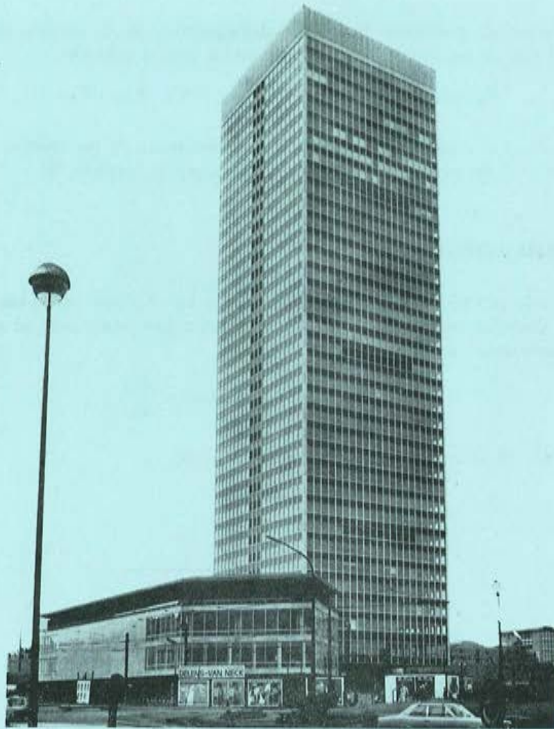
Edificio "Tour du Midi", en Bruselas. Se utilizaron 144 vigas PREFLEX de 40 m de longitud, en la construcción de la torre, y 16 en los edificios anejos.
