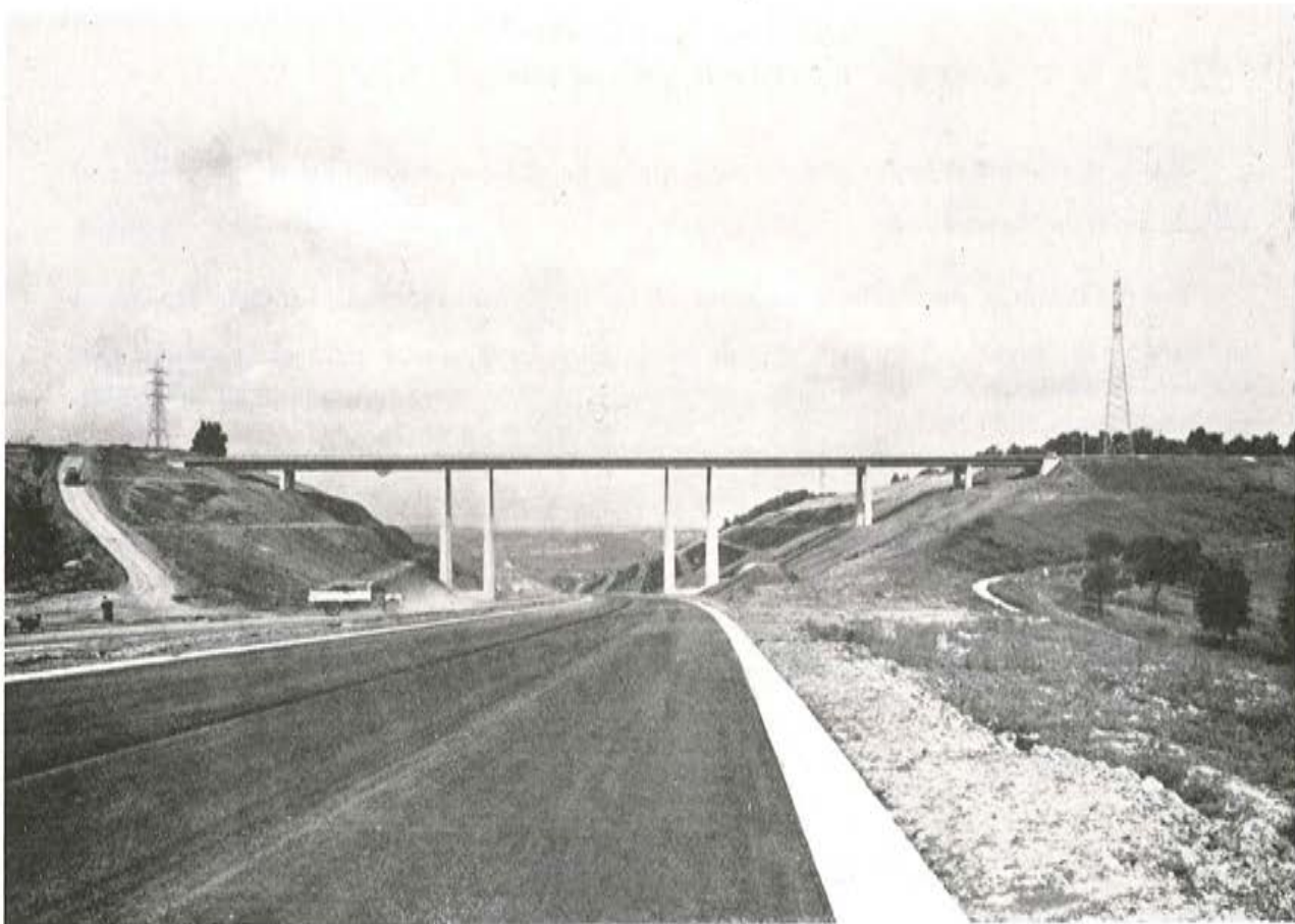
Puente de Saive, en la autopista Amberes-Lieja. En su construcción se utilizaron 24 vigas PREFLEX de luces variables entre 19,60 m y 34,40 m.
