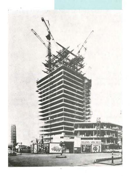
Edificio "Tour du Midi", en Bruselas. Montaje de vigas PREFLEX de 40 m, de longitud, con la de tensiones) no podrá ser otra, en este instante, que la representada por la línea AB de la figura 6D, teniendo en cuenta que:
