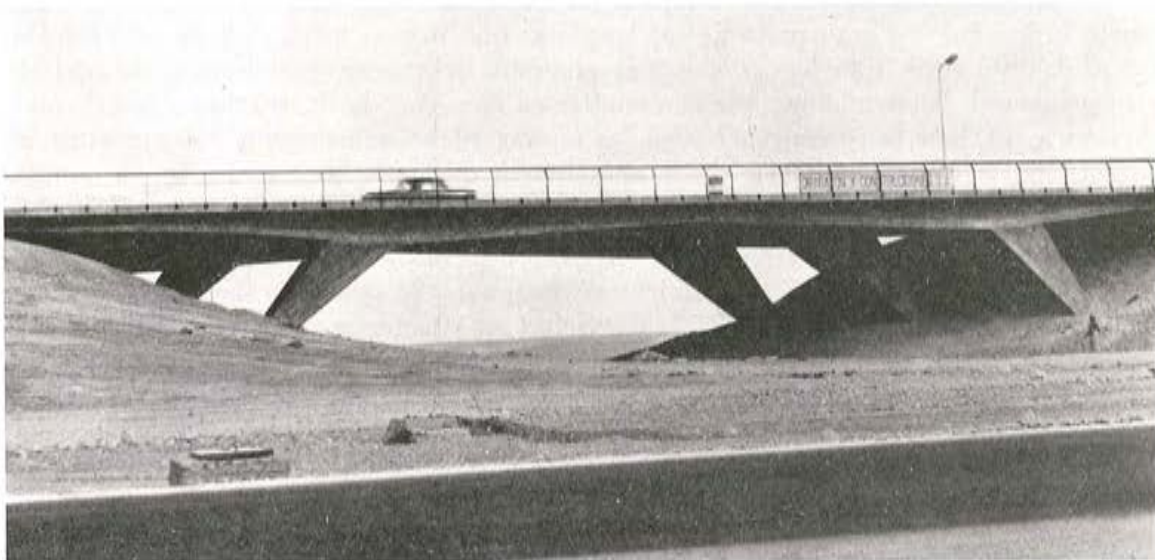
Acceso al aeropuerto de Barajas: Paso superior núm. 1.
