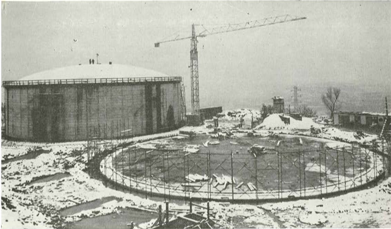
Depósito de 13.000 m. 3 de capacidad en Ugarte (Vizcaya) Constructor: Colomina G. Serrano, S. A. Proyecto: Confederación Norte de España y Coviconsult
