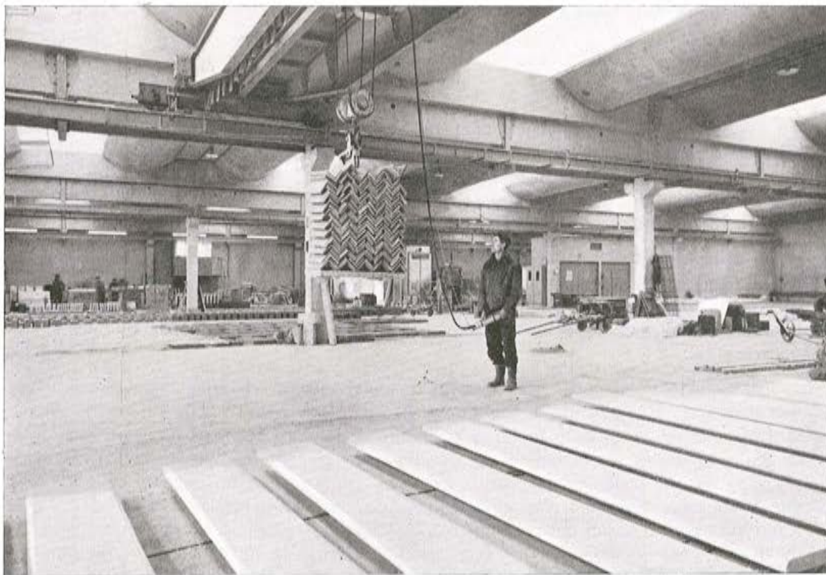
Fig. 5. — En esta empresa, dedicada a la fabricación de placas de hormigón, las piezas se colocan sobre el pavimento, calentado por electricidad, de una nave de grandes dimensiones. De esta forma, durante la noche, se consigue alcanzar un endurecimiento satisfactorio.
