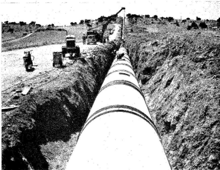
Tramo de colocación.
