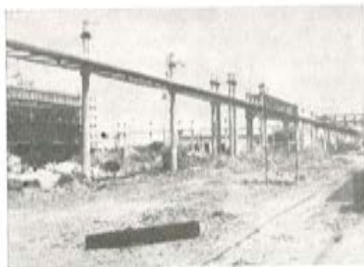
Fig. 5. — Postes para apoyo de un oleoducto.
