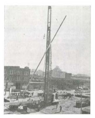
Pilote pretensado de gran longitud, de una sola pieza, utilizado para la cimentación de un edificio en una ciudad americana.
