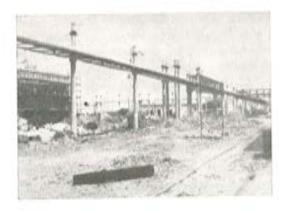
Fig. 5. - Postes para apoyo de un oleoducto.
