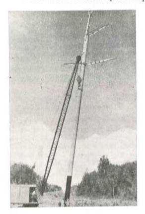
Fig. 16. — Elevación de un poste simple por medio de una grúa.
