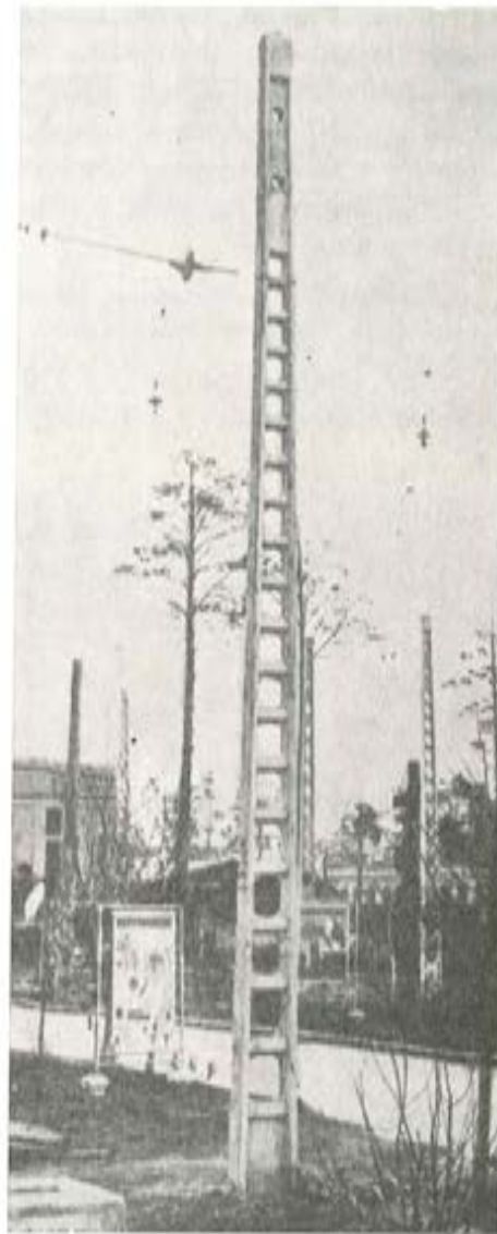
Fig. 13. — Poste tipo escalera utilizado en el tendido de líneas eléctricas para ferrocarril.
