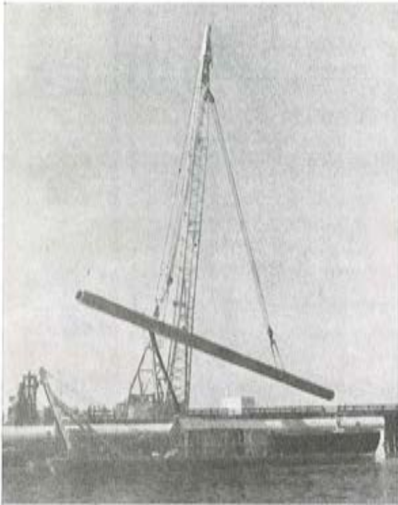
Transporte mediante grúa, hasta su lugar de ubicación, de un pilote cilíndrico hueco de hormigón pretensado.
