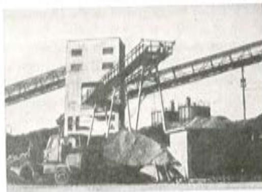
Fig. 6. — Postes utilizados como soportes de cintas transportadoras.
