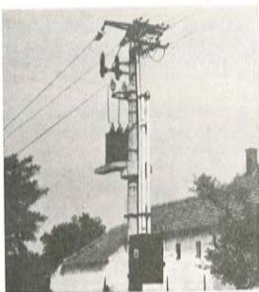
Fig. 3. — Poste simple con transformador incorporado.
