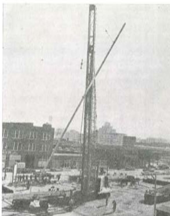
Pilote pretensado de gran longitud, de una sola pieza, utilizado para la cimentación de un edificio en una ciudad americana.
