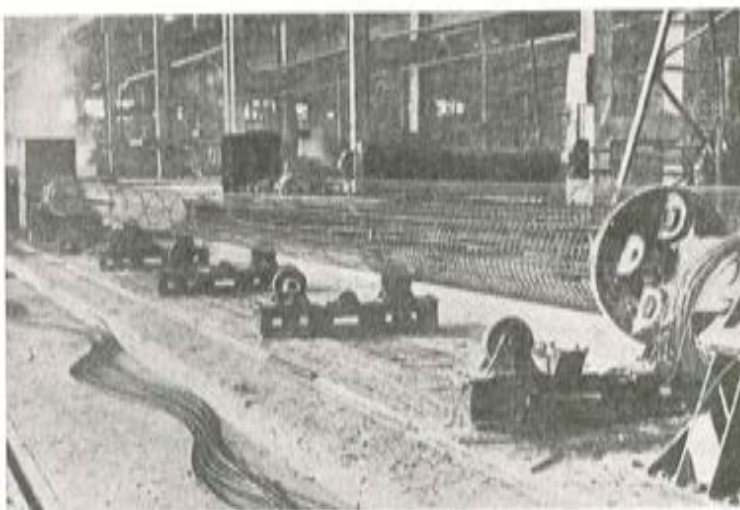
Fig. 15. — Vista de las armaduras longitudinales, helicoidales y estribos. En primer plano pueden verse los cables pretesosos.
