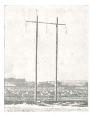
Fig. 12. — Pórtico en π, autoestable, para un solo circuito.
