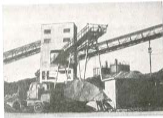
Fig. 6. — Postes utilizados como soportes de cintas transportadoras.
