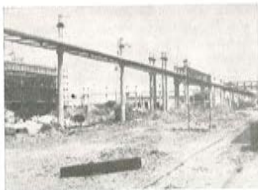
Fig. 5. — Postes para apoyo de un oleoducto.
