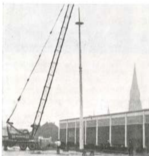
Fig. 7. — Un poste de 24 m terminado en una antena metálica de 6 m. La base del poste tiene 75 cm de diámetro.
