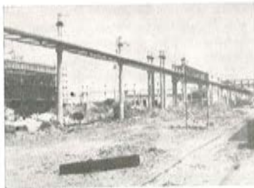
Fig. 5. — Postes para apoyo de un oleoducto.
