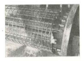
Fig. 14. — Extremos de los cables de pretensado fijados a las placas de anclaje.
