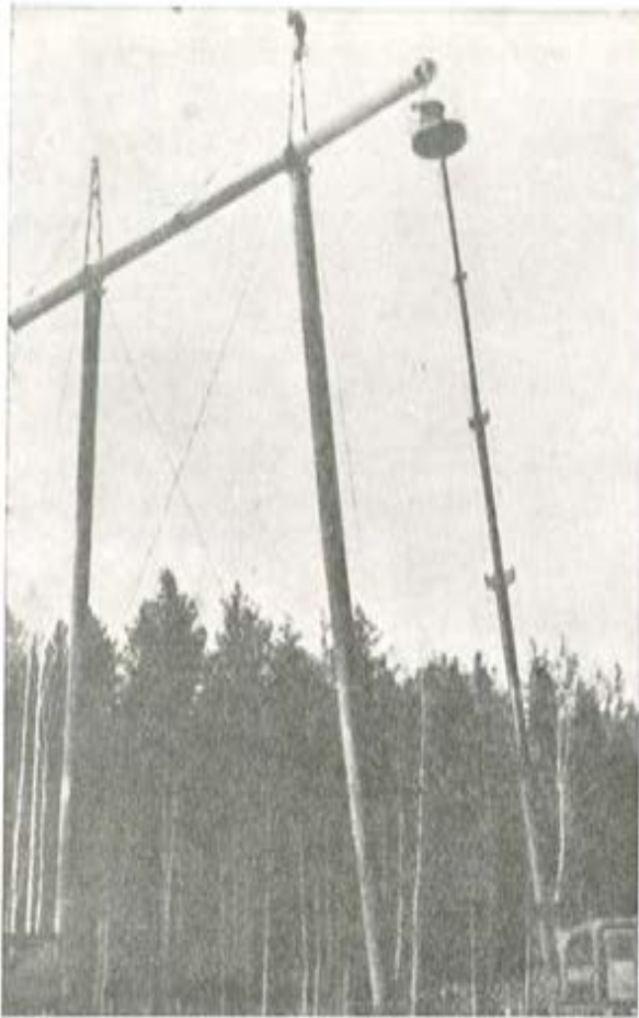
Fig. 11. — Pórtico en \pi , atirantado, para un solo circuito, durante el montaje.
