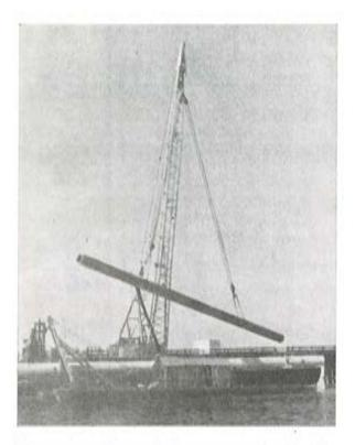
Transporte mediante grús, hasta su lugar de ubicación, de un pilote cilíndrico hueco de hormigón pretensado.
