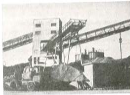
Fig. 6. — Postes utilizados como soportes de cintas transportadoras.
