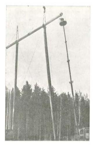
Fig. 11, — Pórtico en π, atirantado, para un solo circuito, durante el montaje.
