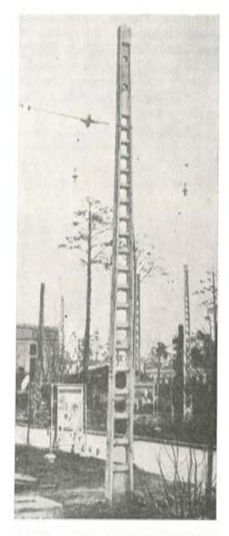
Fig. 13. — Poste tipo escalera utilizado en el tendido de líneas eléctricas para ferrocarril.
