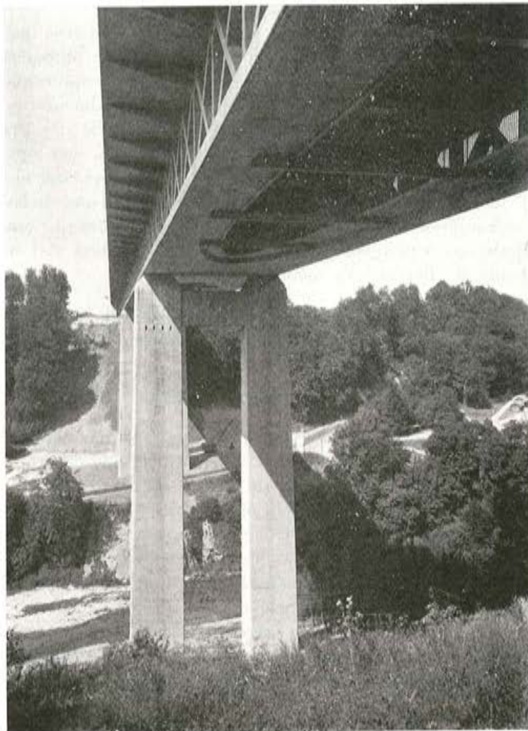
Fig. 1. — Detalle del puente sobre el Mangfall.
