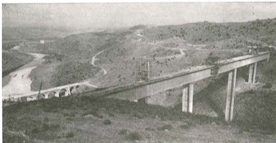
Fig. 11. — Puente de la Plata.
