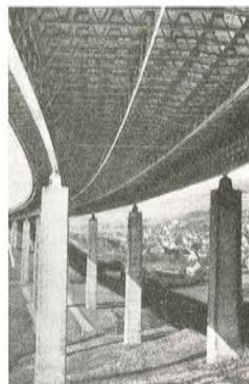
Fig. 26.—Vista inferior del puente de Kauppen, terminado.
