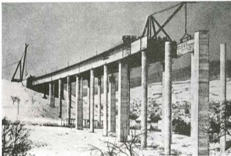
Fig. 23. — Vista de la construcción del puente de Kauppen. Esta solución ganó un concurso entre 67 proyectos. El puente consta de 6 vanos de 60-65 y 70 m de luz, con una longitud total de 390 m. Durante la construcción se colocaron apeos provisionales en puntos situados a los tercios de la luz.
