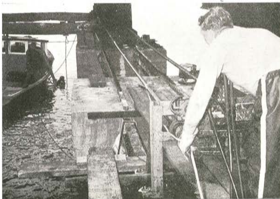
Fig. 13.—El gato de ripado tipo "Lift Slab".
