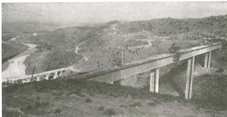
Fig. 11. — Puente de la Plata.
