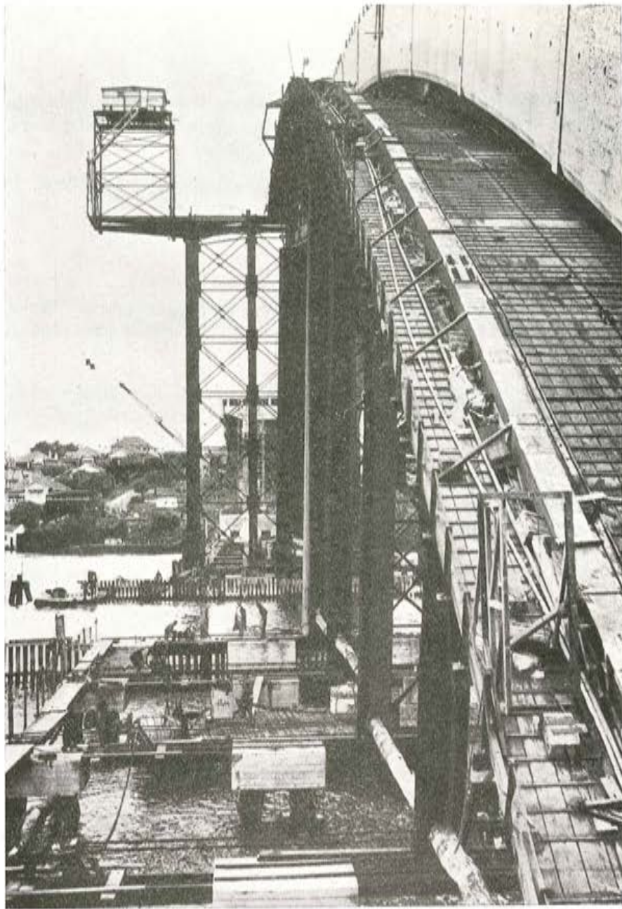
Fig. 12.—La cimbra durante la operación de ripado.
