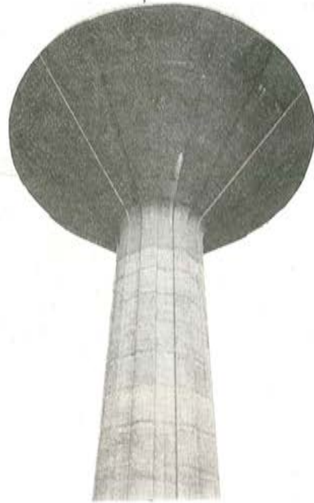
Depósito de agua, elevado, en Prat del Llobregat.
