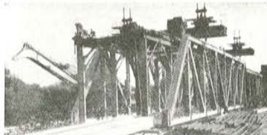
Fig. 21. — Puente Victoria, en el ferrocarril del noroeste de la India. Vigas en celosía, de 46,5 m de luz, con pretensado de los montantes para reducir las deformaciones secundarias bajo sobrecarga total.
