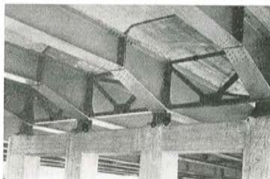
Fig. 33. — Aspecto final de la junta de la figura 32 después del desbloqueo.
