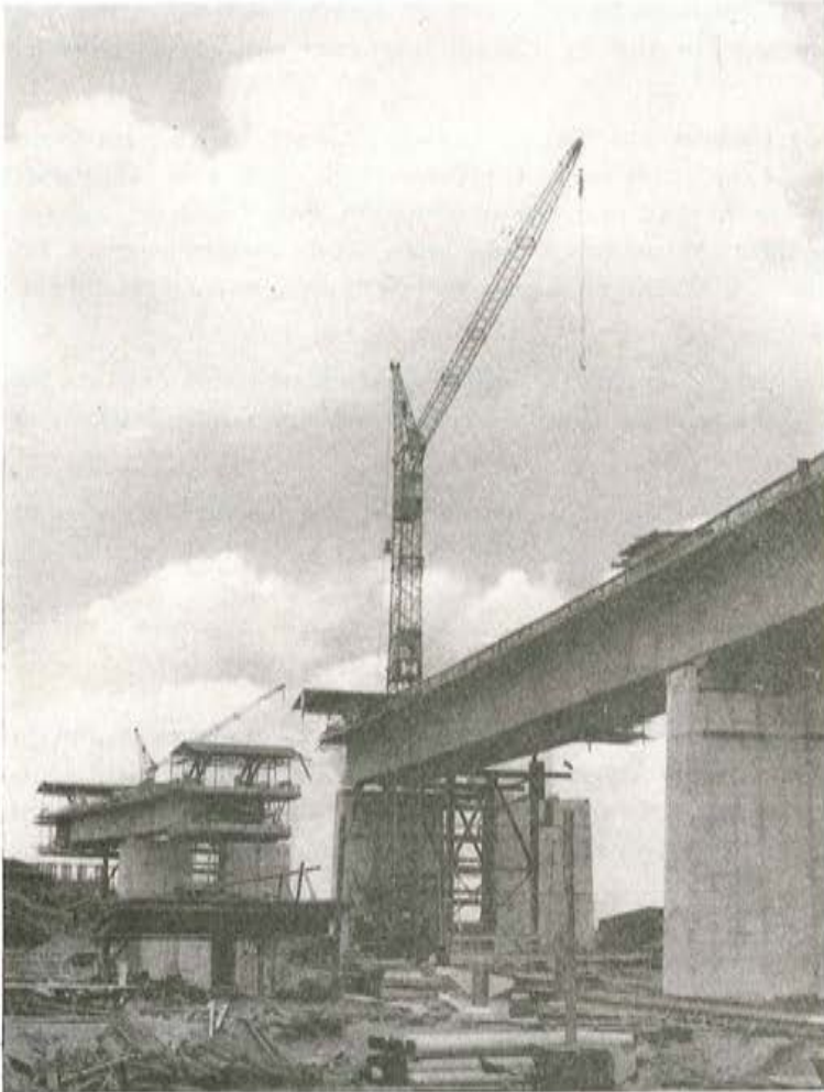
Fig. 2. — El puente de Berlín, durante su construcción.
