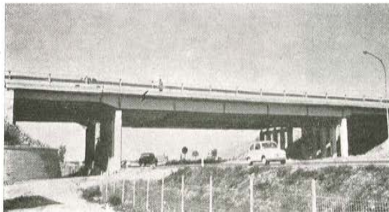
Fig. 31. — Puente en la autopista del Sol, en el tramo Florencia-Mare. Consta de tres tramos de 9-27-9 m de luz, y está constituido por cinco vigas de un metro de canto, con tablero de 18 cm de espesor. Para el pretensado se utilizó el procedimiento de desbloqueo de las juntas provisionales en la sección metálica.
