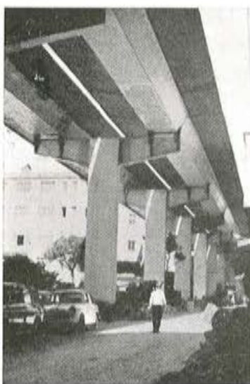
Fig. 34. — Vía elevada en Génova. Vista general de la obra.
