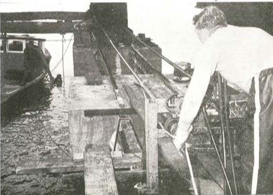
Fig. 13.—El gato de ripado tipo "Lift Slab".
