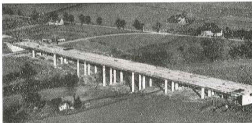
Fig. 27. — Puente de Liedbachtal. Consta de 8 tramos de 37,5 m de luz y una anchura total de tablero de 27 m. Está formado por seis vigas principales, de 1,50 m de canto; cuatro de ellas van sobre apoyos aislados y las otras dos, flotantes, apoyadas en diafragmas transversales.
