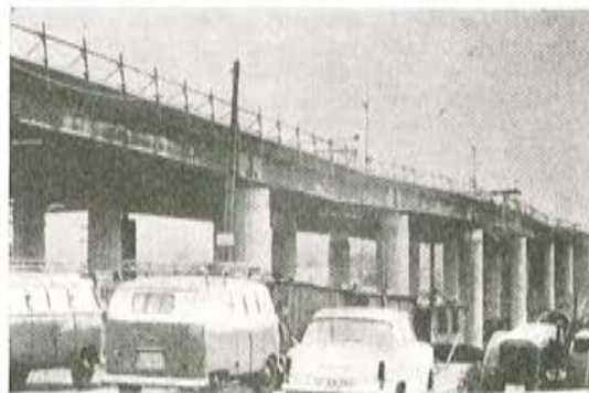
Fig. 30. —Aspecto de la obra del puente de Liedbachtal antes del pretensado y bloqueo de las juntas. Puede apreciarse la curvatura en la zona central del puente.
