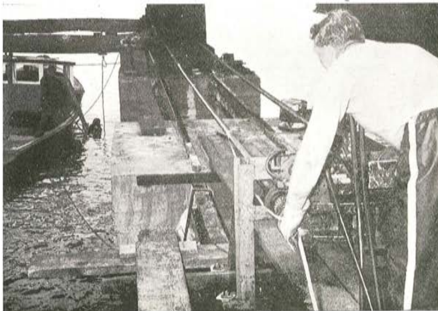
Fig. 13.—El gato de ripado tipo "Lift Slab".
