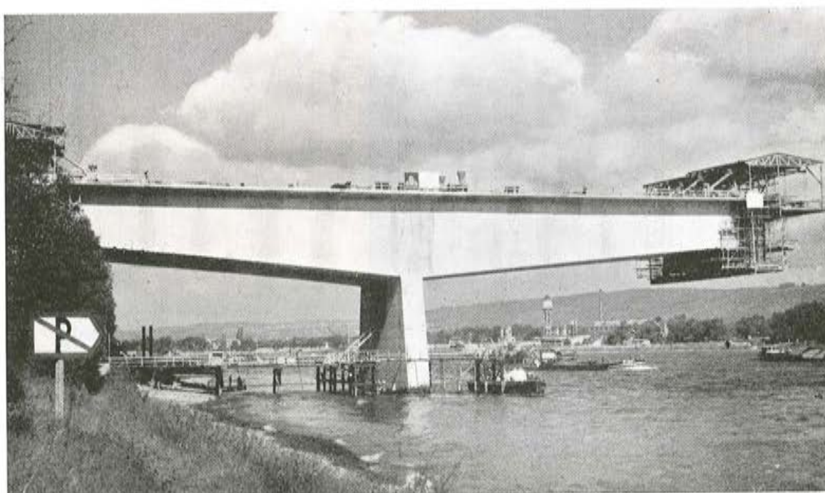
Fig. 13. — El puente de Bendorf comparte el tramo principal ya construido.
