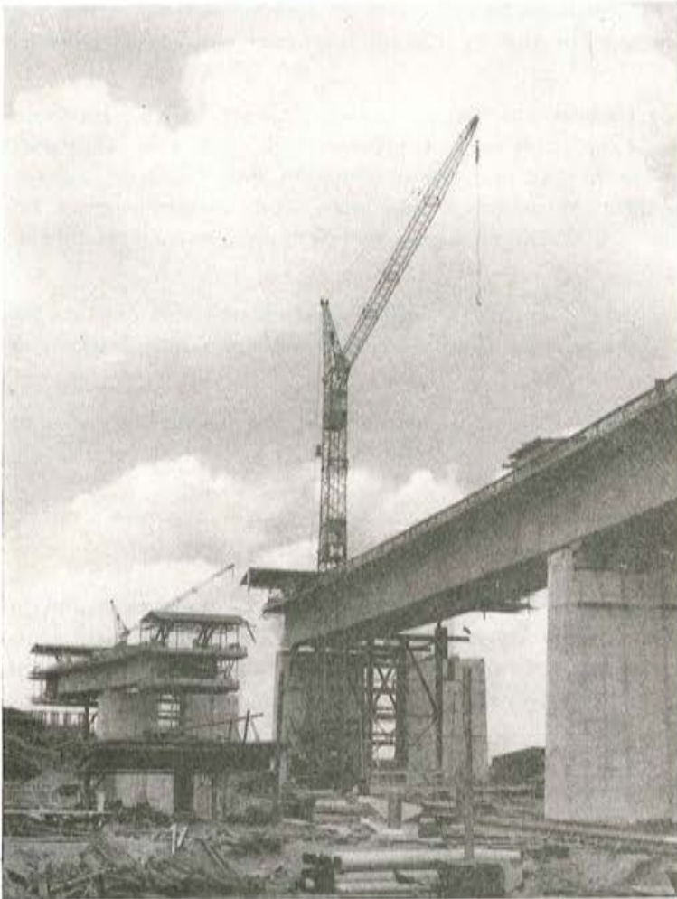
Fig. 2. — El puente de Berlín, durante su construcción.
