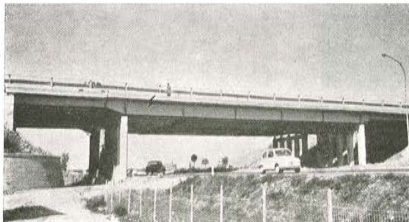
Fig. 31. — Puente en la autopista del Sol, en el tramo Florencia-Mare. Consta de tres tramos de 9-27-9 m de luz, y está constituido por cinco vigas de un metro de canto, con tablero de 18 cm de espesor. Para el pretensado se utilizó el procedimiento de desbloqueo de las juntas provisionales en la sección metálica.
