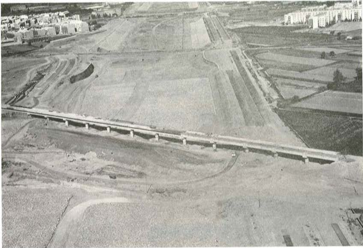
Puente FF.CC. Liria-Utiel (Plan Sur de Valencia) Construye: CUBIERTAS Y TEJADOS, S. A. Proyecto: Florencio del Pozo
