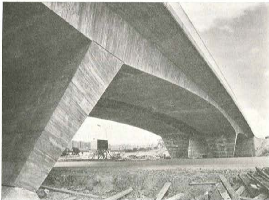
Paso superior sobre la carretera N-III. Acceso al barrio de Moratalaz.
