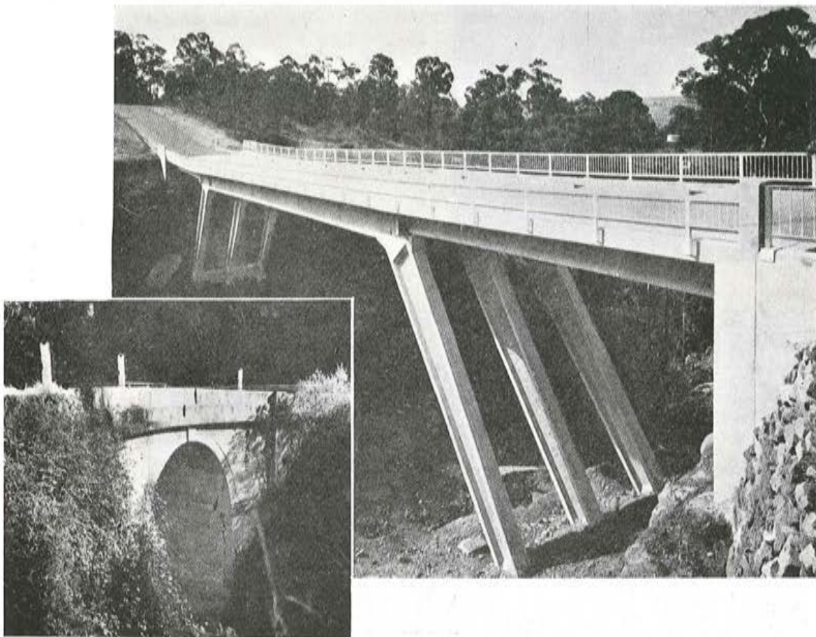
Fotografía 1: El nuevo puente de Lapstone, terminado. — Fotografía 2: A sólo unos pocos kilómetros de distancia del nuevo puente se encuentra ubicado el de Lennox, que es el más antiguo de los que aún subsisten en todo el continente australiano. Construido en piedra en 1833, para la carretera principal del Oeste, está constituido por un solo arco de 6 m, de luz.
