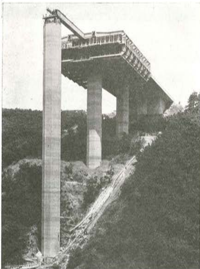
Fig. 14. — Construcción del puente del Elztaal. Detalle de la cimbra móvil autoportante.
