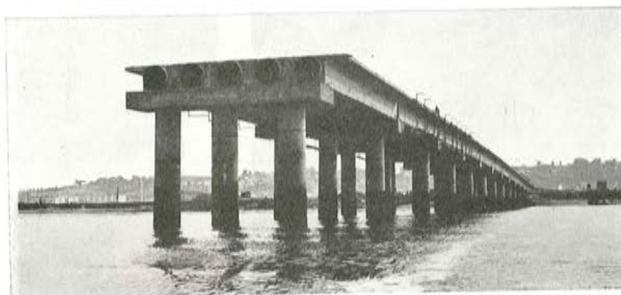
Puente-acueducto, en la desembocadura del Odiel, en la Bahía de Huelva.
