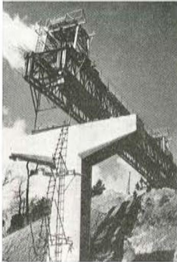
Fig. 22. — Puente de lanzamiento, de 60 m de longitud, para vigas de hormigón pretensado. Está formado por cuatro elementos en celosía, constituidos por piezas de 6 m de longitud que se unen mediante un pretensado. Las armaduras de pretensado están formadas por alambres de 7 mm de diámetro anclados en grupos de cuatro. El procedimiento de pretensado utilizado ha sido el P.S.C. El momento máximo que puede resistir este puente es de 900 m t.
