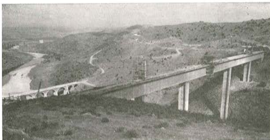
Fig. 11. — Puente de la Plata.
