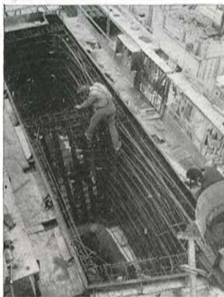
Fig. 62. — Introducción de la armadura en el molde.
