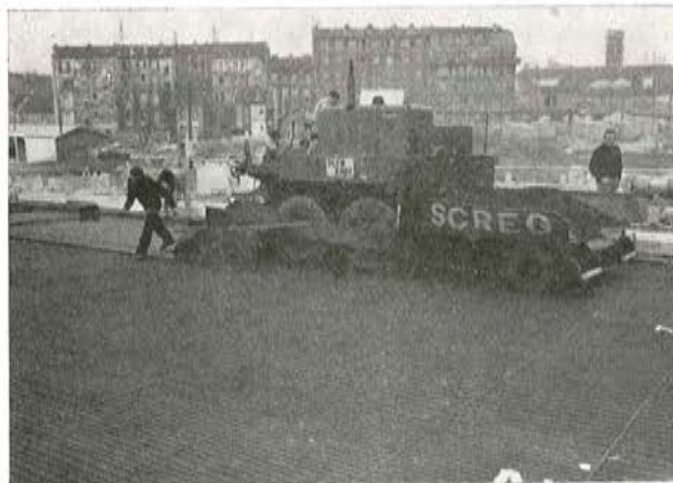
Fig. 110. — Revestimiento de los cables calefactores. Tipo semirremolque.
