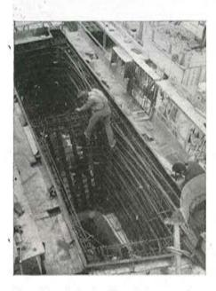
Fig. 62. — Introducción de la armadura en el molde.
