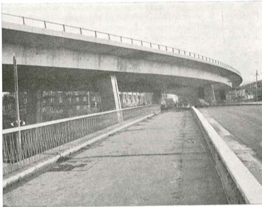
Fig. 20. — Paso bajo el viaducto de la R.N. 1, entre las pilas P3 y P2. La pila P2 está ubicada en el mismo eje de la R.N. 1, cuyos usuarios circulan a uno y otro lado del soporte izquierdo de la pila P2.
