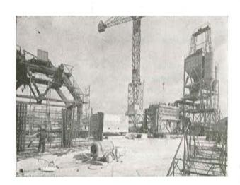
Fig. 24.— Conjunto del parque de almacenamiento en el estribo de Saint-Denis. En primer plano, a la derecha, el almacén de placas de forjado,
