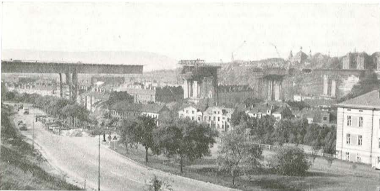
Vista del puente durante su construcción.
