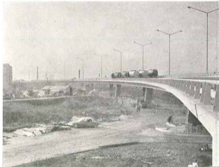
Fig. 84. — Vista de las pruebas de carga.
