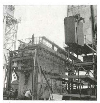
Fig. 63. — Colocación de un núcleo del encofrado interior.
