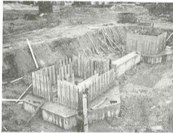
Fig. 47. — Ejecución de los macizos sobre pilotes.
