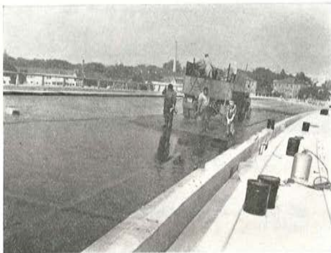
Fig. 104. — Ejecución de la capa de estanquidad, con buen tiempo.
