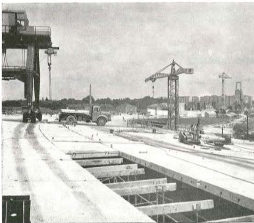
Fig. 72. — Colocación de las placas del forjado.
