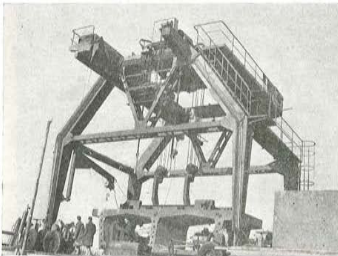
Fig. 67. — Vista de conjunto del pórtico de transporte.
