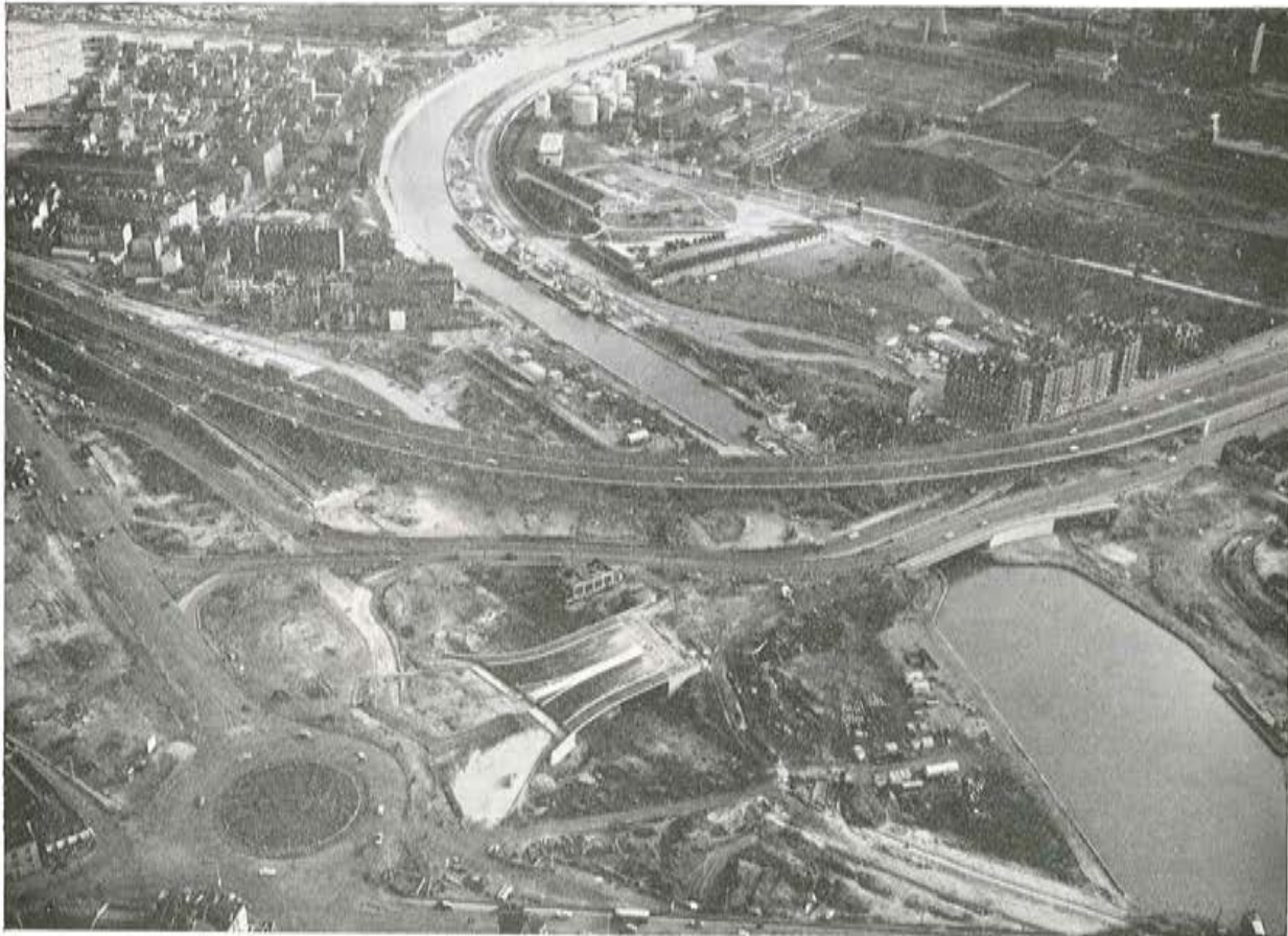
Fig. 4.—El nudo de la "Porte de Paris", durante su construcción. El viaducto en curva está ya en servicio. París se encuentra a la derecha.
