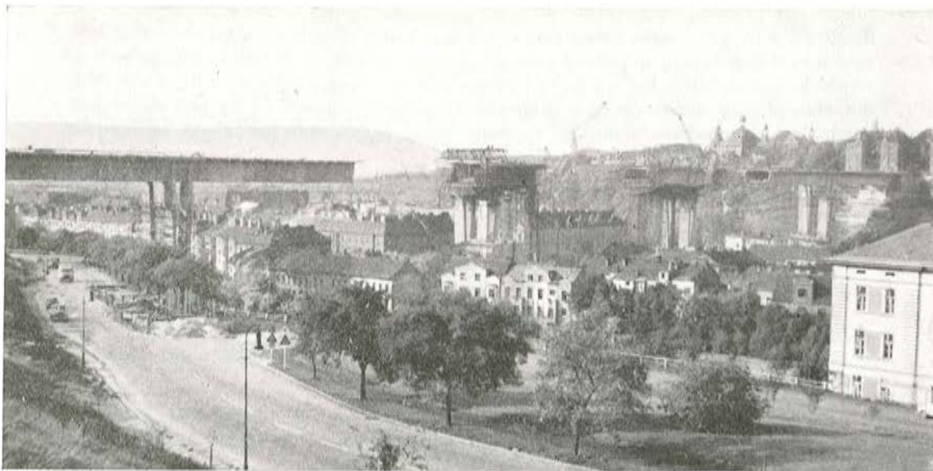
Vista del puente durante su construcción.
