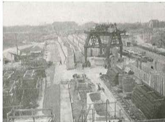
Fig. 24. — Conjunto del parque de almacenamiento en el estribo de Saint-Denis. En primer plano, a la derecha, el almacén de placas de forjado.
