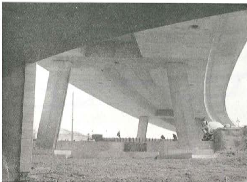
Fig. 6. — Vista de la obra por debajo del tablero.
