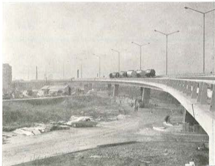
Fig. 84. — Vista de las pruebas de carga.
