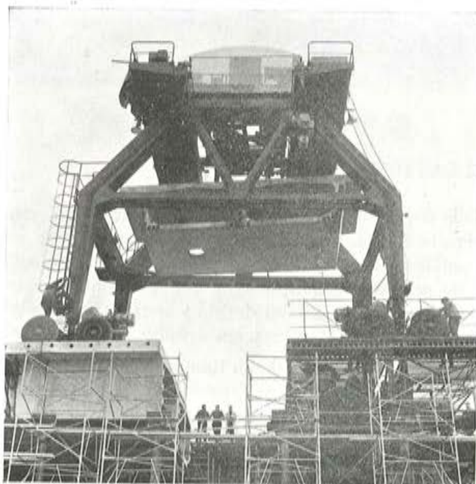
Fig. 70. — Llegada de una dovela.
