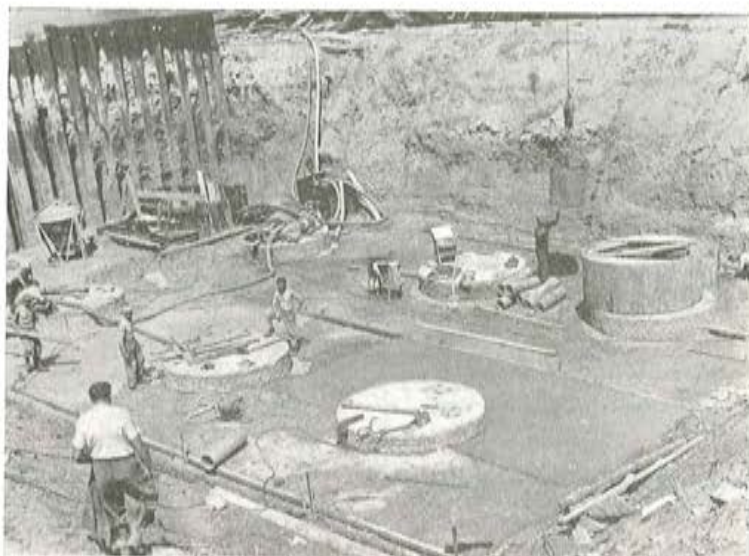
Vista de las cabezas de los pilotes de cimentación para una de las pilas.
