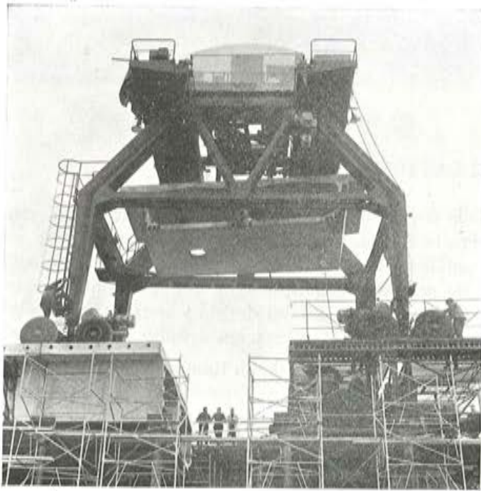
Fig. 70. — Llegada de una dovela.
