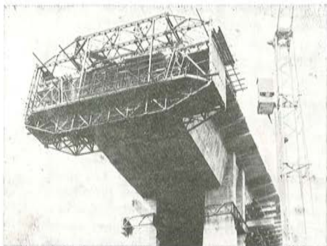
Detalle del carretón con el encofrado móvil, para la construcción de los tramos en voladizo.
