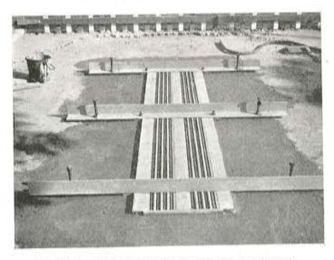
Fig. 102. - Junta de ensayo después del hormigonado,
