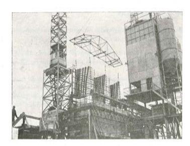
Fig. 61. — Colocación de la armadura de una dovela.
