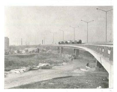
Fig. 84. — Vista de las pruebas de cargá.
