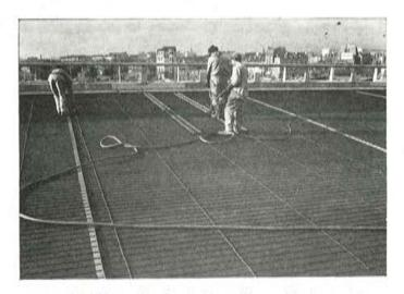
Fig. 109. — Fijación de los cables calefactores.
