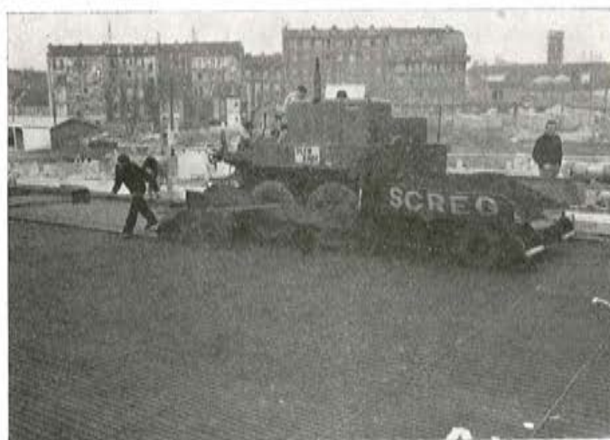
Fig. 110. — Revestimiento de los cables calefactores. Tipo semirremolque.
