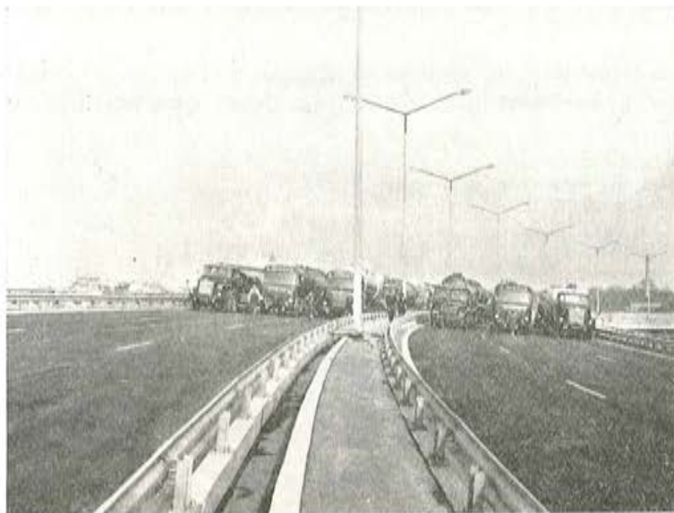
Fig. 83. — Vista de las pruebas de carga.
