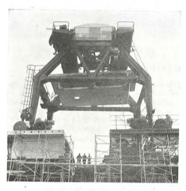
Fig. 70. - Llegada de una dovela.
