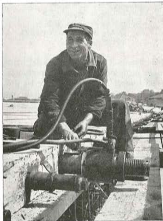
Fig. 79. — Tesado de los cables del forjado superior. En primer plano, anclaje de un cable tesado, mantenido en posición mediante las correspondientes cuñas.
