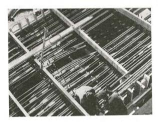
Fig. 53. — Disposición de los cables en la parte superior de una riostra de apoyo sobre un soporte.
