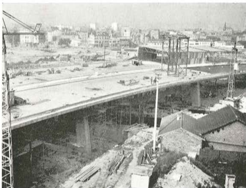
Fig. 105. — Vista general de la obra durante la ejecución de la capa de estanquidad; obsérvese el abrigo móvil de protección.
