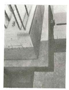
Fig. 52. — Colocación de una articulación de base. Obsérvense dos de los tres tornillos de nivelación, así como los alojamientos destinados a los gatos de ripado de las bases de los soportes bajo carga.
