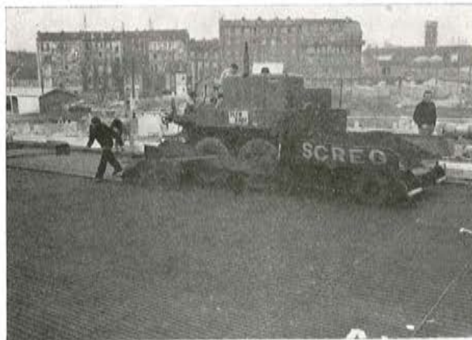
Fig. 110. — Revestimiento de los cables calefactores. Tipo semirremolque.
