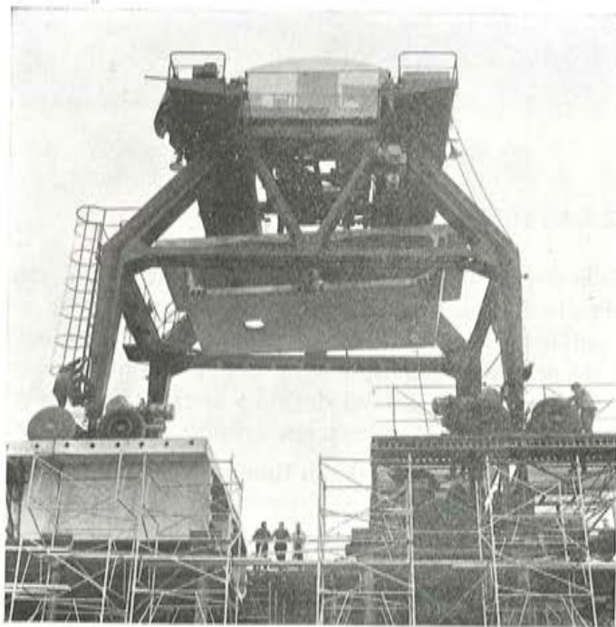
Fig. 70. — Llegada de una dovela.
