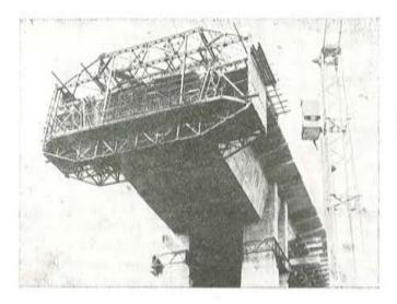
Detalle del carretón con el encofrado móvil, para la construcción de los tramos en voladizo.
