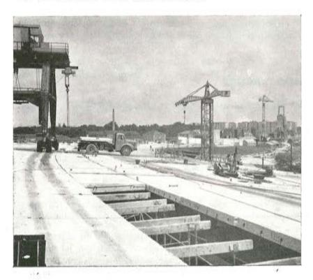
to. Este sellado se realizaba mediante martillos neumáticos. Durante este tiempo, se colocaba la primera familia de cables longitudinales destinados a introducir la primera mitad del pretensado en el tramo considerado, y la segunda en el tramo anterior.
