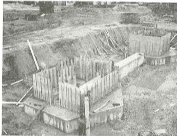
Fig. 47. — Ejecución de los macizos sobre pilotes.
