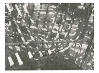
Fig. 54. — Colocación de cables en el extremo inferior de una riostra de apoyo, en su unión con el alma lateral de una sección en cajón.
