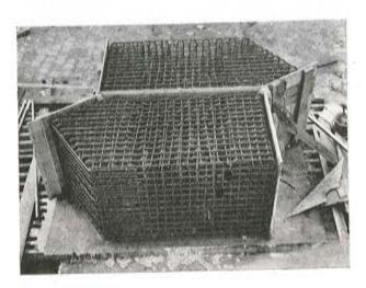
Fig. 35. — El modelo de ensayo antes del hormigonado.
