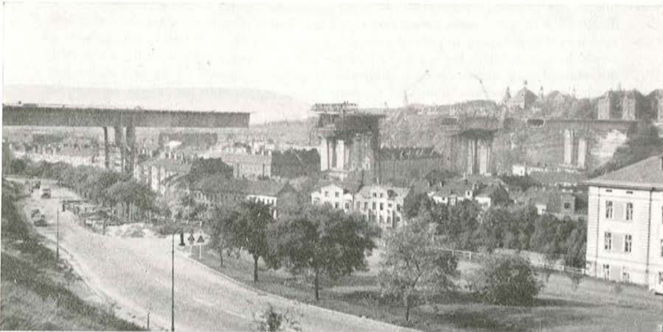
Vista del puente durante su construcción.
