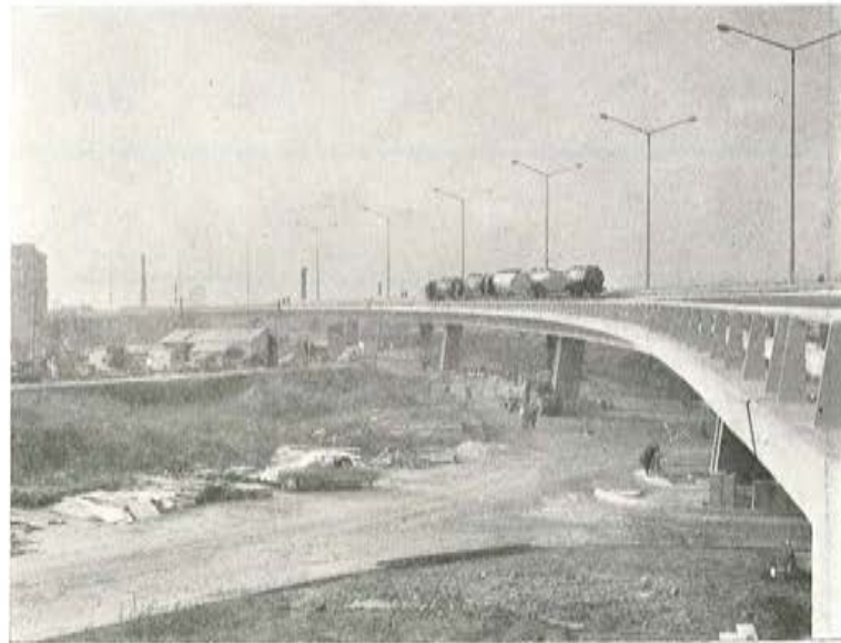
Fig. 84. — Vista de las pruebas de carga.
