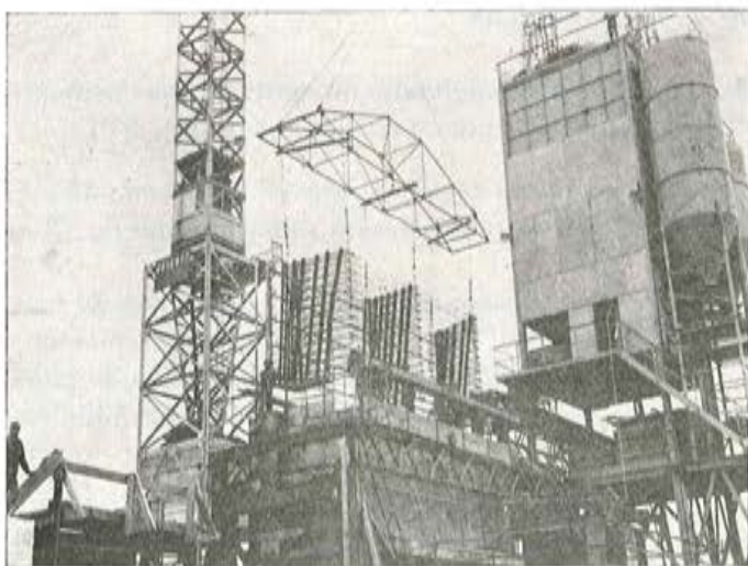
Fig. 61. — Colocación de la armadura de una dovela.
