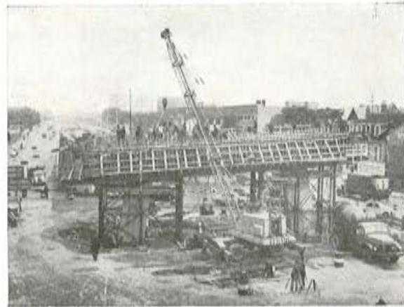
Fig. 26. — Construcción de la pila P1.
