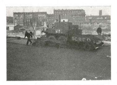
Fig. 110. — Revestimiento de los cables calefactores. Tipo semirremolque.
