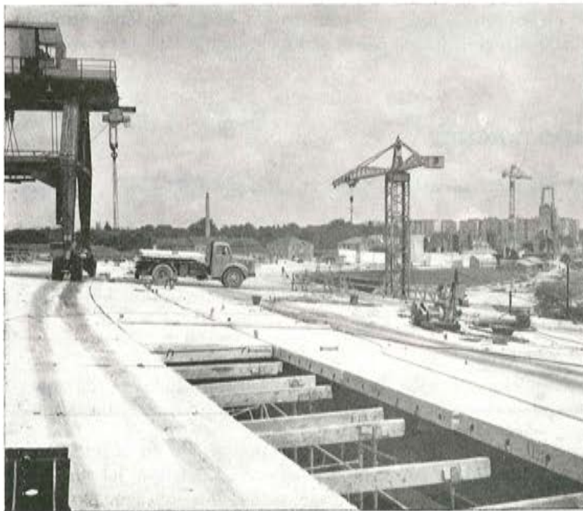
Fig. 72. — Colocación de las placas del forjado.
