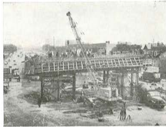
Fig. 26. — Construcción de la pila P1.
