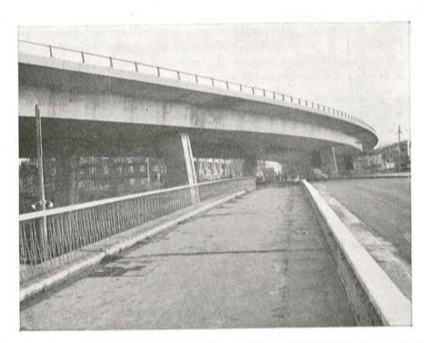
Fig. 20. — Paso bajo el viaducto de la R.N. 1, entre las pilas P3 y P2. La pila P2 está ubicada en el mismo eje de la R.N. 1, cuyos usuarios circulan a uno y otro lado del soporte izquierdo de la pila P2.
