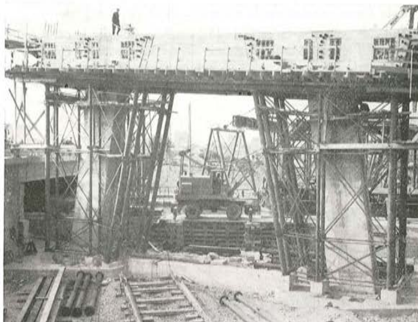
Fig. 55. — Vista de la cara de la riostra de apoyo con los anclajes del primer grupo de cables y los tubos en espera para los del segundo grupo.
