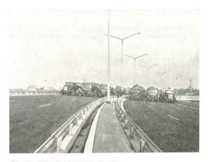
Fig. 83. — Vista de las pruebas de carga.
