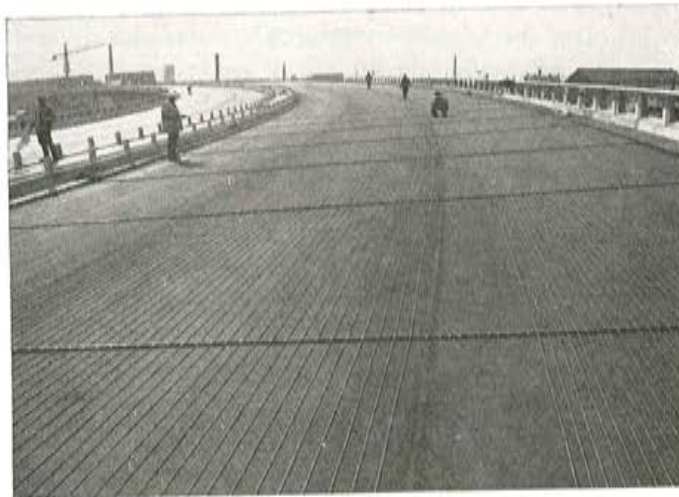
Fig. 108. — Colocación de los cables. Vista general antes de su fijación.
