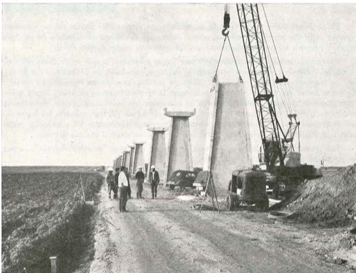
Fig. 2. — Las pilas que soportan la vía están situadas cada 20 metros, de eje a eje.
