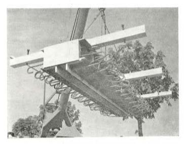
Fig. 101. - Junta de ensayo durante su colocación.
