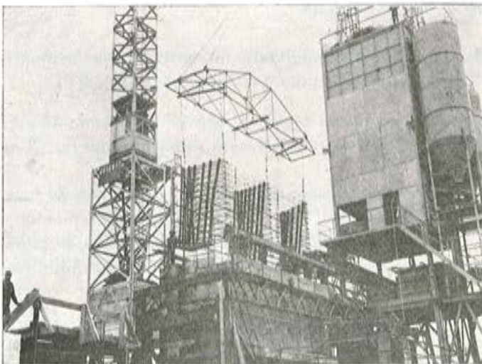
Fig. 61. — Colocación de la armadura de una dovela.
