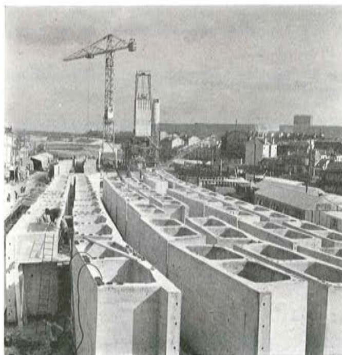
Fig. 65.—Almacén de dovelas.
