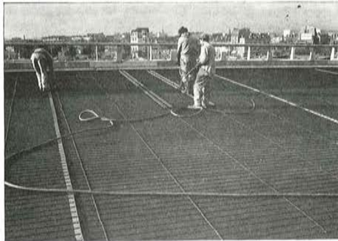
Fig. 109. — Fijación de los cables calefactores.
