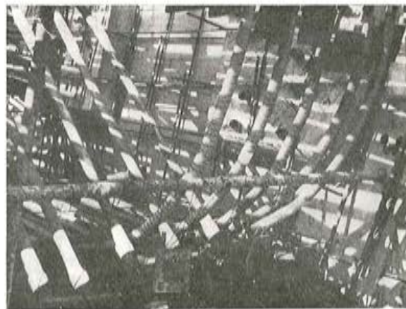
Fig. 54. — Colocación de cables en el extremo inferior de una riostra de apoyo, en su unión con el alma lateral de una sección en cajón.
