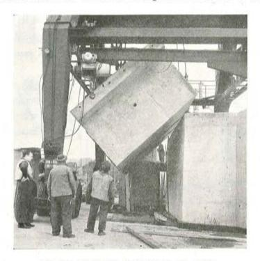
Fig. 66. — Operación de volteo de una dovela.
