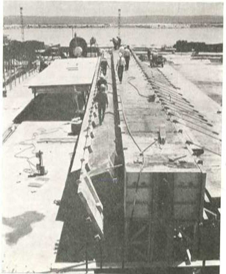
unos carretones bien al parque de pilotes o al taller de azuches. Los azuches están constituidos por un tubo de un diámetro algo menor que el interior del pilote, que lleva en su centro un anillo de chapa nervada para su acoplamiento al extremo inferior de aquél; entre el extremo del tubo y las paredes interiores del pilote se dispone otro anillo de chapa de forma que quede un espacio entre ambos tubos, cuyo espacio se inyectará con mortero a presión.
