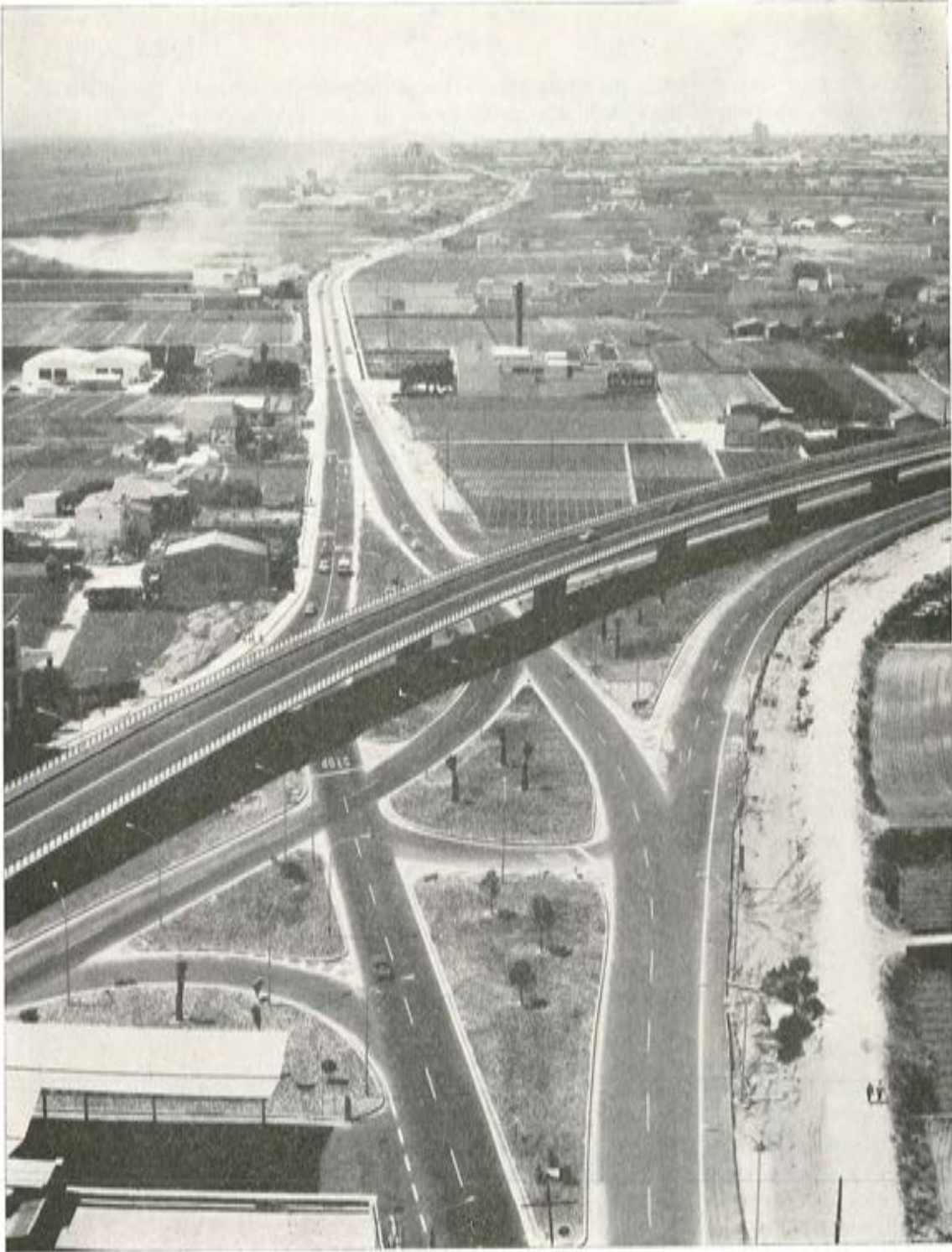
Viaducto de Mataró. Autopista Mongat-Mataró.
