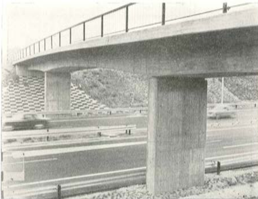
Paso superior en la autopista Mongat-Mataró.
