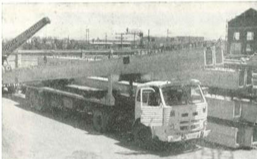
El tablero, distinto a los que actualmente venían empleándose, se forma colocando las vigas cajón unas a continuación de otras. El relleno de juntas se efectúa antes de hormigonar la losa del suplemento y tiene una gran importancia en el reparto de cargas, debido a las entalladuras que poseen las caras laterales de la viga cajón.
