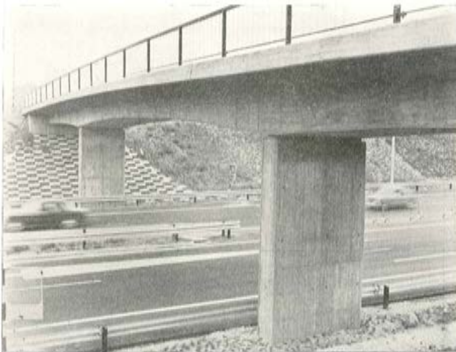
Paso superior en la autopista Mongat-Mataró.
