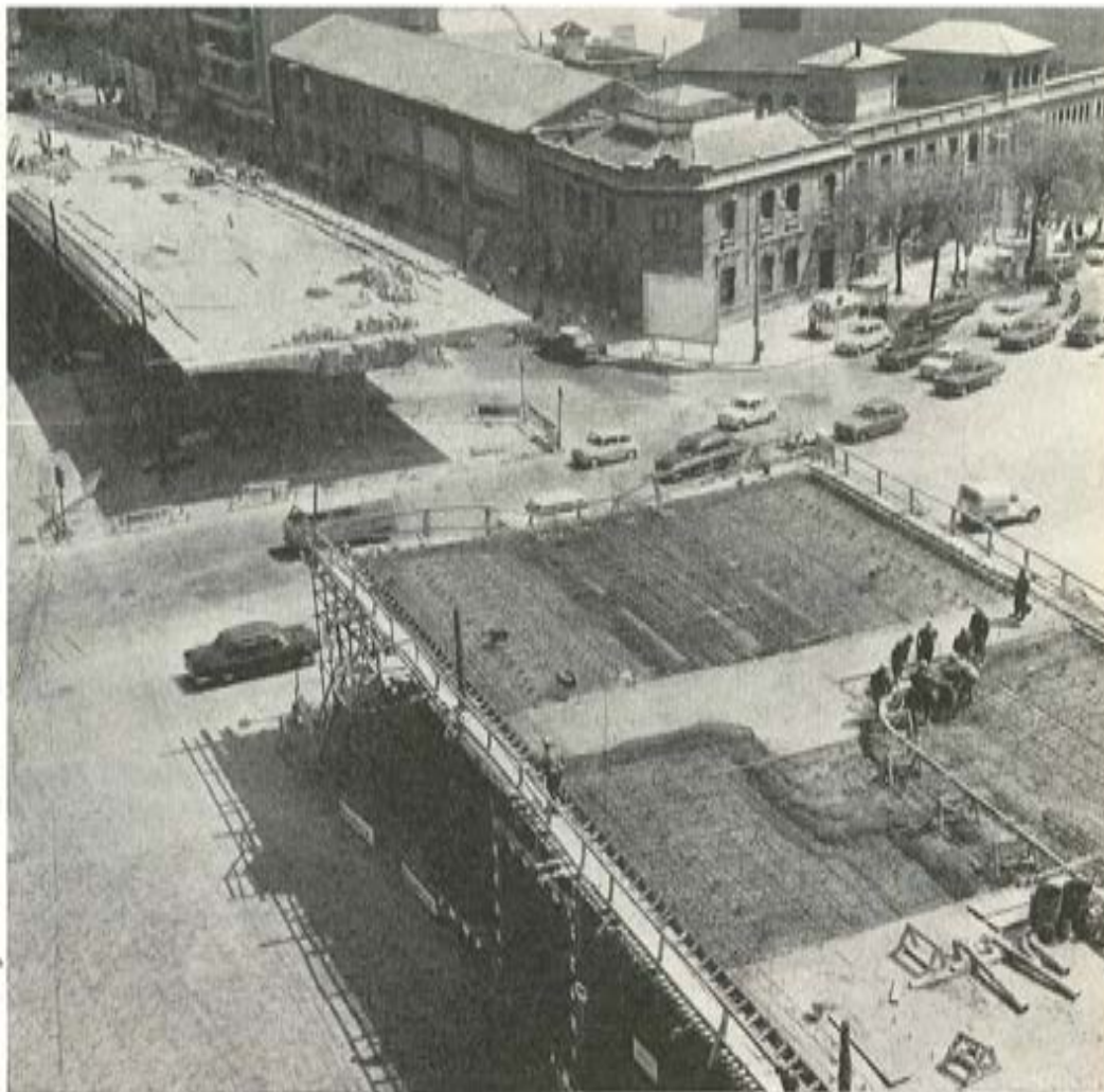
Paso superior de la glorieta de Cuatro Ca- minos.
