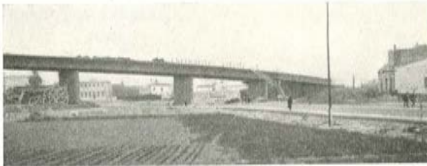
Fig. 2. — Viaducto de Mataró.
