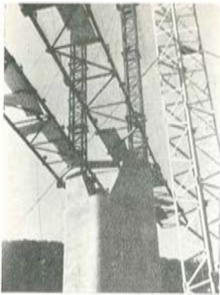
cos de seis cables de pretensado de 15,2 mm de diámetro, que transmitían sus esfuerzos a dos mástiles metálicos en celosía con sus arranques empotrados en las cabezas de las pilas.
