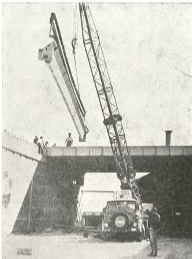
Montaje de una pieza de 16 m. de luz de 17 000 Kg. de peso propio.
