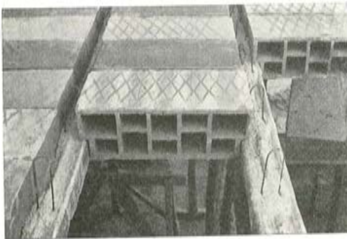
Fig. 4. — Forjado de vigüetas semirresistentes de cerámica pretensada.
