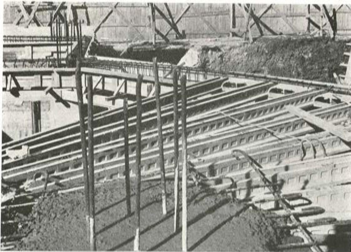
Fig. 3. — Vigüeta semirresistente con estribos salientes.
