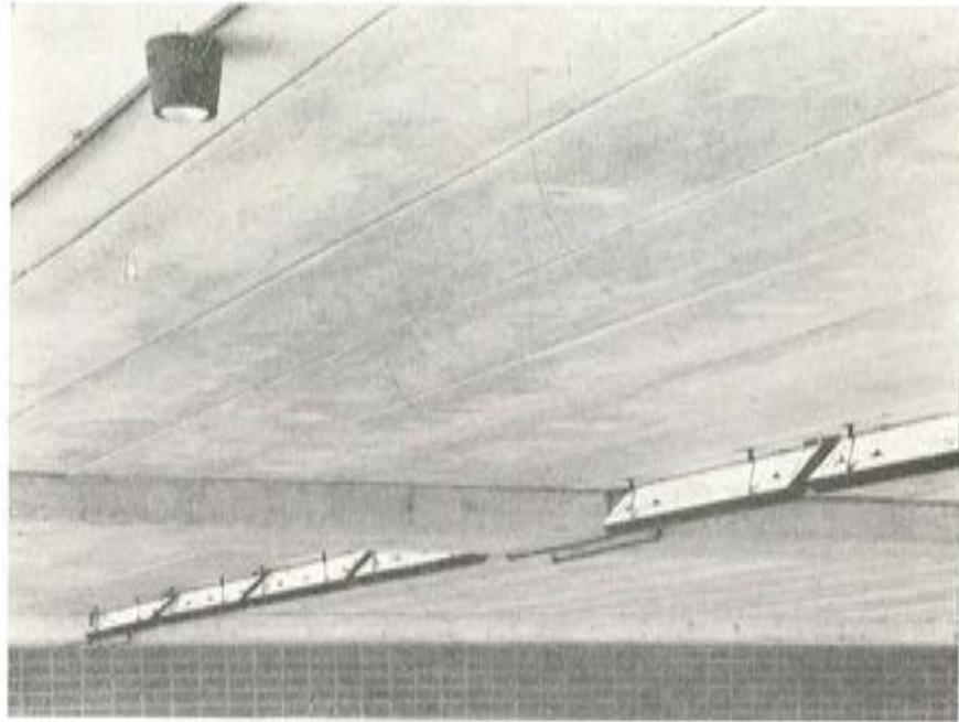
Ha de hacerse notar que este forjado apoya con gran sencillez y con entregas mínimas sobre estructura metálica, sobre estructura de hormigón y sobre albañilería; estos tipos de apoyos están resueltos y normalizados.
