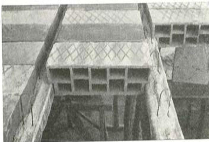
Fig. 4. — Forjado de vigüetas semirresistentes de cerámica pretensada.
