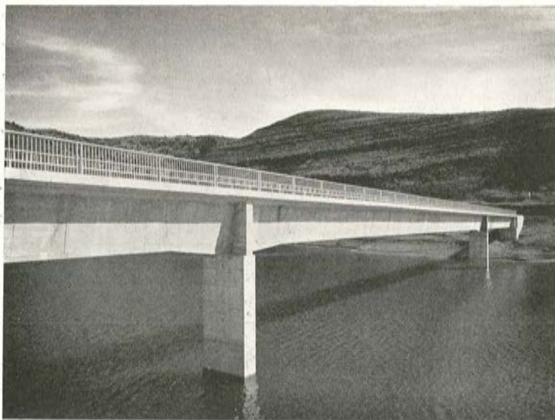
Pasarela sobre el embalse de Mansilla.
