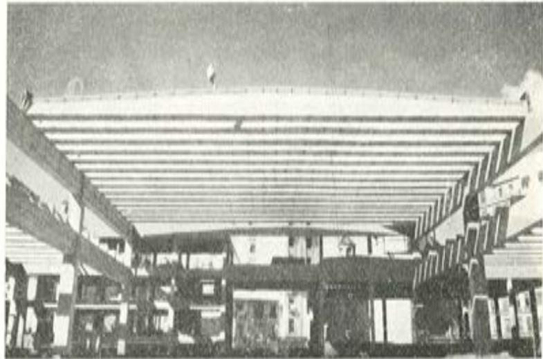
Para levantar la viga del andamio y apoyarla sobre los carriles o vagonetas con que se vaya a realizar el desplazamiento bastan unos artilugios muy simples que pueden apreciarse también en la figura 2.
