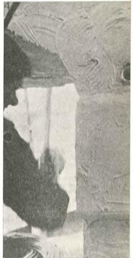
En aquellos sitios donde estaban los agujeros para el paso de los cables de pretensado se dejaba alrededor de éstos un cerco de unos 5 cm sin resina (fig. 4). Así se evitaba que este material pudiera penetrar en las vainas de los cables de pretensado, los cuales una vez colocados recibían inyecciones a las que se incorporó el aditivo plastificante expansivo Intracrete.
