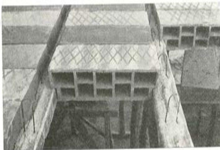
Fig. 4. — Forjado de vigüetas semirresistentes de cerámica pretensada.
