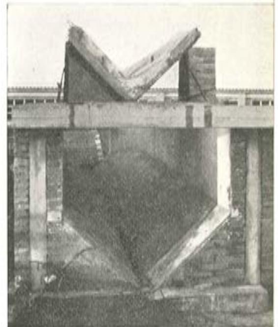
En la figura 10 se muestra un banco que sirve para piezas hasta 20 m de luz; o sea, de altura de 1 m, ya que normalmente se va a 1/20 de la luz, anchura de 2,00 m; o sea, doble de la altura, ya que los cables de la V están inclinados a 45° de la vertical. Pero naturalmente se pueden construir en el mismo banco toda clase de elementos más pequeños. Las piezas se pueden fabricar unas encima de otras hasta 3 ó 4.
