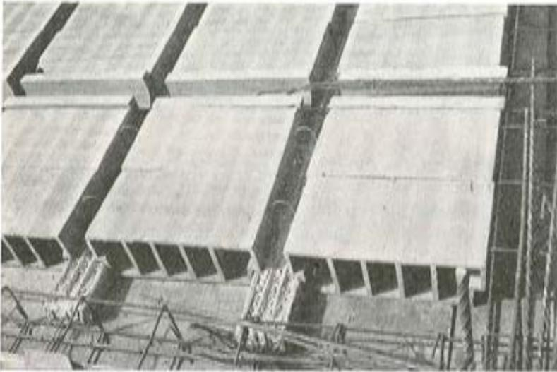
Figs. 5, 6 y 7. — Forjados reticulares en solución mixta armada-pretensada,
