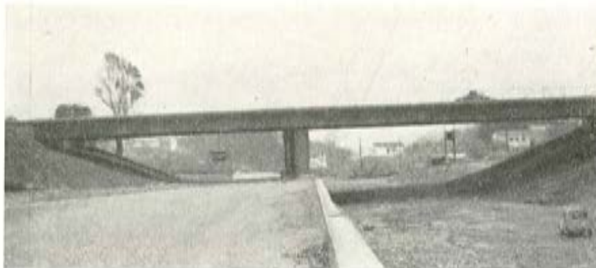
Fig. 4. — Puente Riera Alella.
