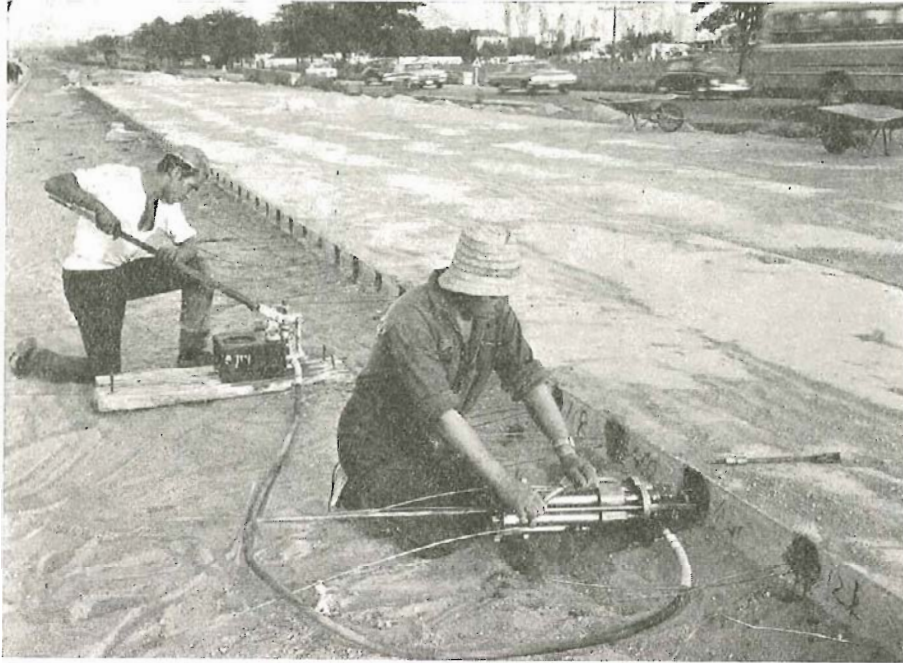
Pretensado transversal por el sistema Barredo.
