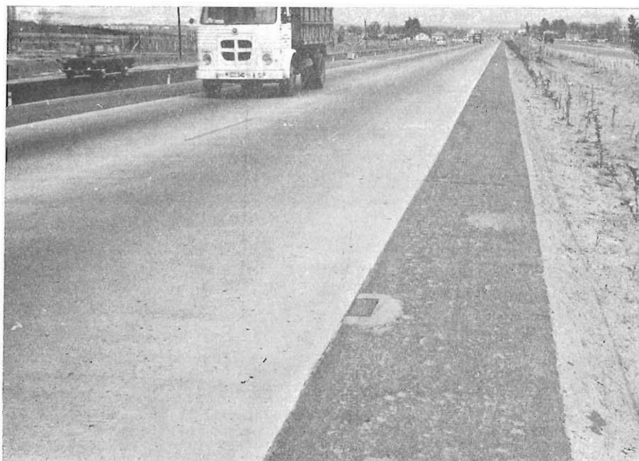
Vista general del tramo de ensayo.
