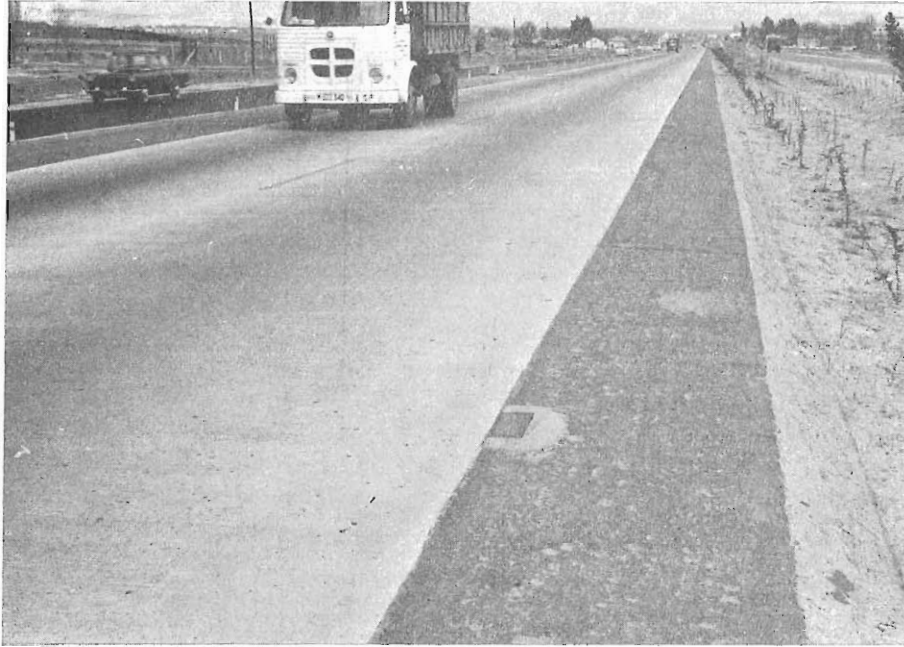
Vista general del tramo de ensayo.
