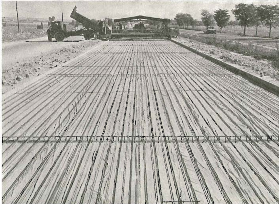
Hormigonado del tramo de 250 m. de longitud pretensado con cables.
