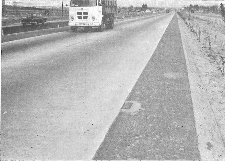
Vista general del tramo de ensayo.
