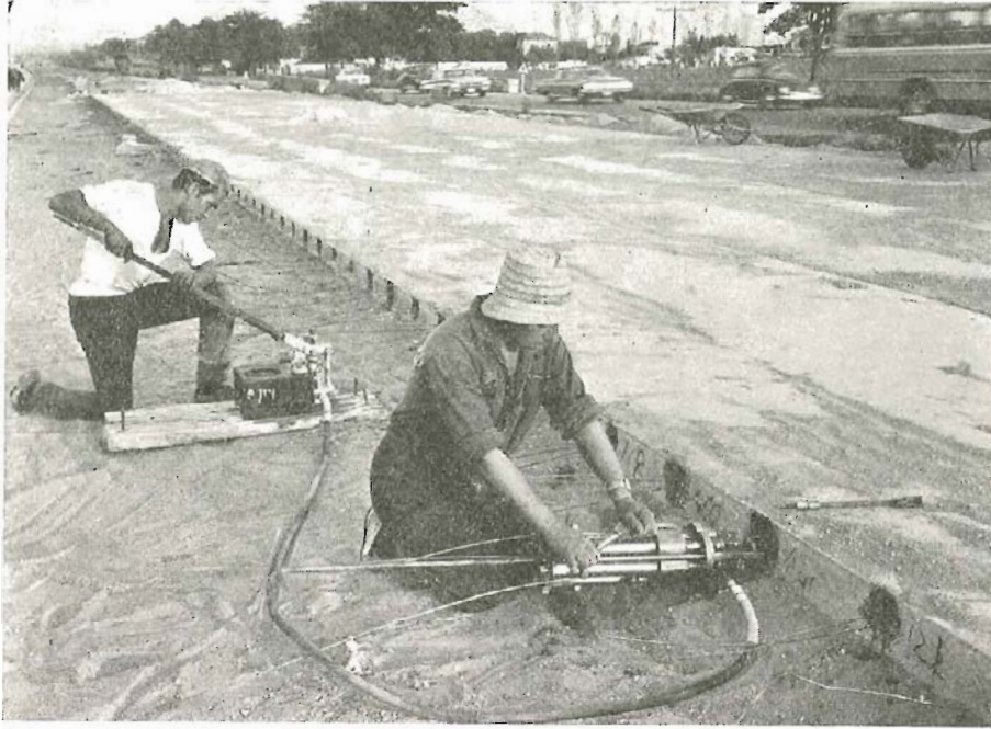
Pretensado transversal por el sistema Barredo.
