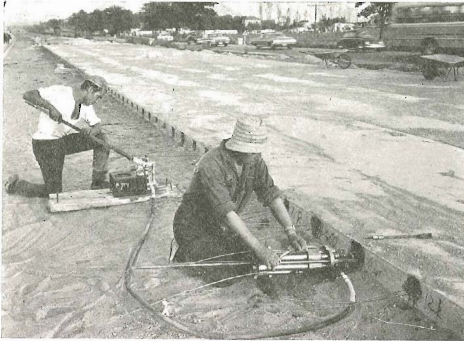
Pretensado transversal por el sistema Barredo.
