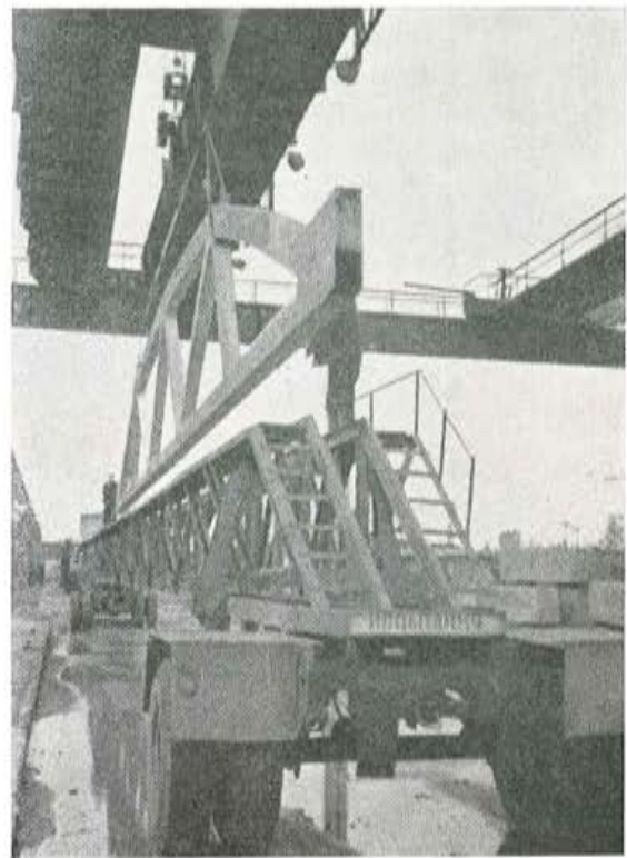
Figs. 4 y 5.—Moldes, de base reforzada, para anclaje de las armaduras.
