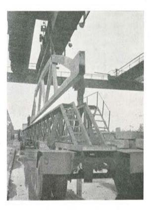
Fig. 6.— Dispositivos para retirar los moldes.
