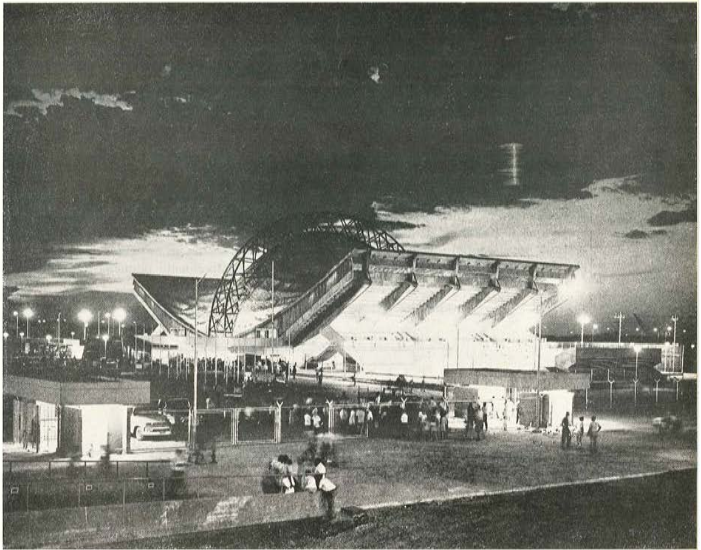
Fig. 11. — Vista exterior del gimnasio.
