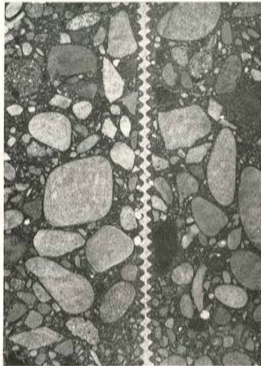
Fig. 6. — La misma unión, como en la figura 5, pero esta vez el hormigón ha sido colocado con cimbra estriada. En comparación con una superficie plana, en el presente caso el conjunto estructural de los áridos está cubierto de una capa de mortero de mayor espesor y menor resistencia. El estriado ha favorecido la prematura evaporación del agua en el hormigón fresco, así como la más rápida desintegración del hormigón envejecido y no ha aportado ninguna ventaja.
