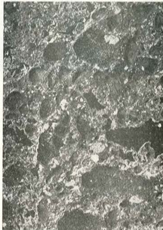
Fig. 4. — Apreciación de una rotura en la capa superficial. Es típico el desprendimiento unilateral de los áridos de tamaños medianos y grandes.
