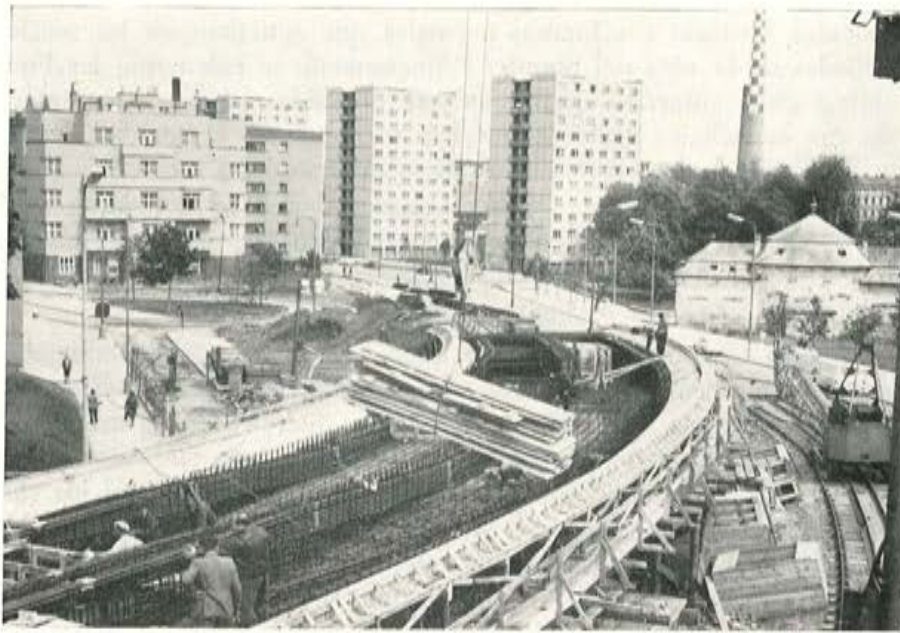
Fig. 10. — Vista general de la obra durante su construcción.
