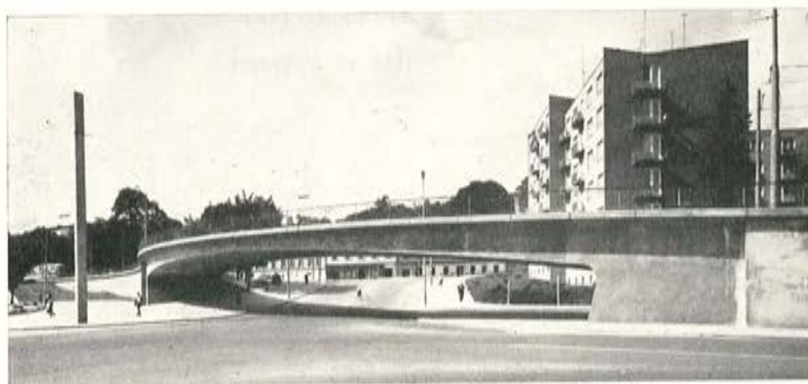
Fig. 12. — El puente en servicio resuelve satisfactoriamente todos los problemas de tráfico.
