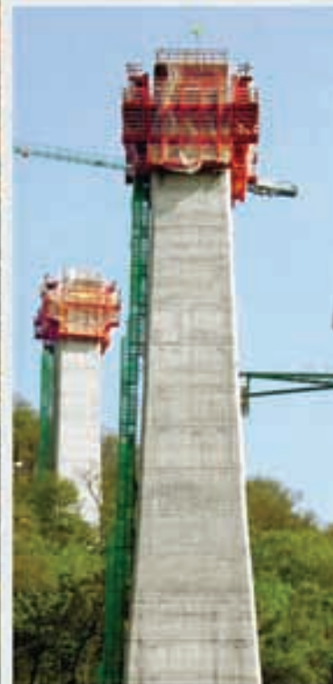
Pilas Viaducto de Montabliz
