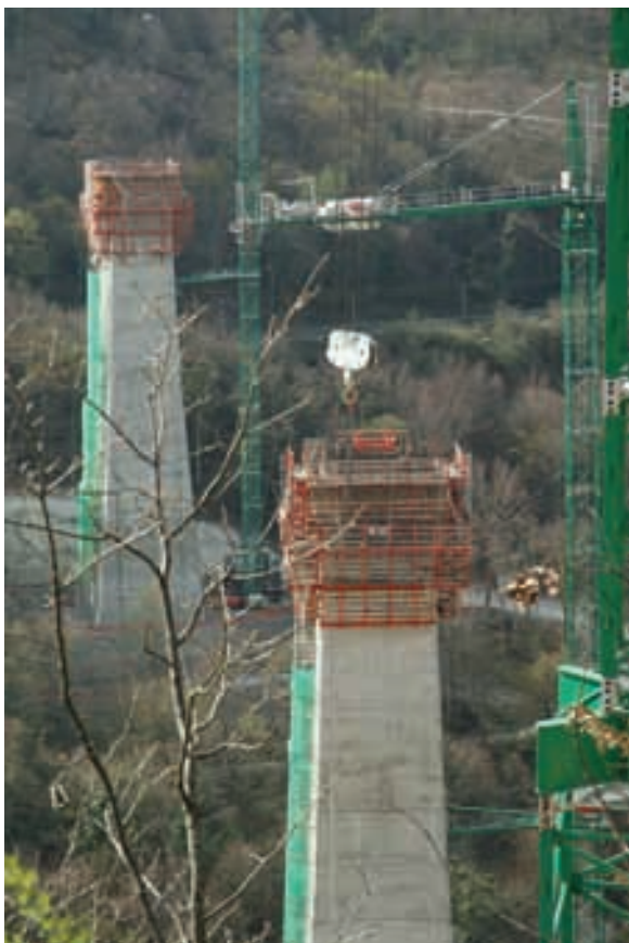
Figura 24. Ejecución de alzados de pilas 2 y 3. Figure 24. Execution of piers 2 and 3 elevations.
