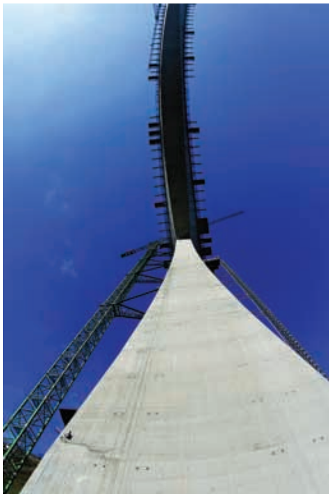
Figura 15. Vista inferior de fondo de tablero desde pila 2. Figure 15. Underneath view of the deck bottom from pier 2.
