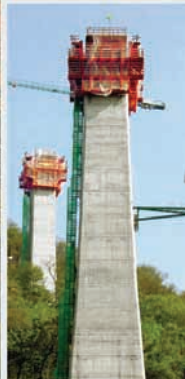
Pilas Viaducto de Montabiz
