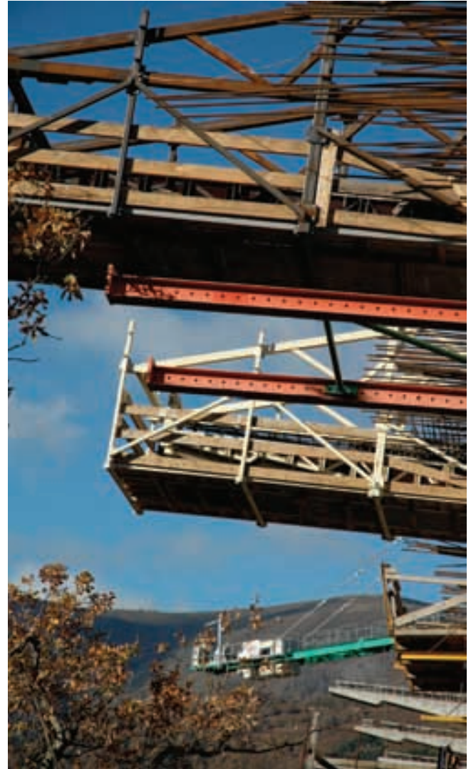
Figura 35. Carros de nervios transversales de voladizos.
