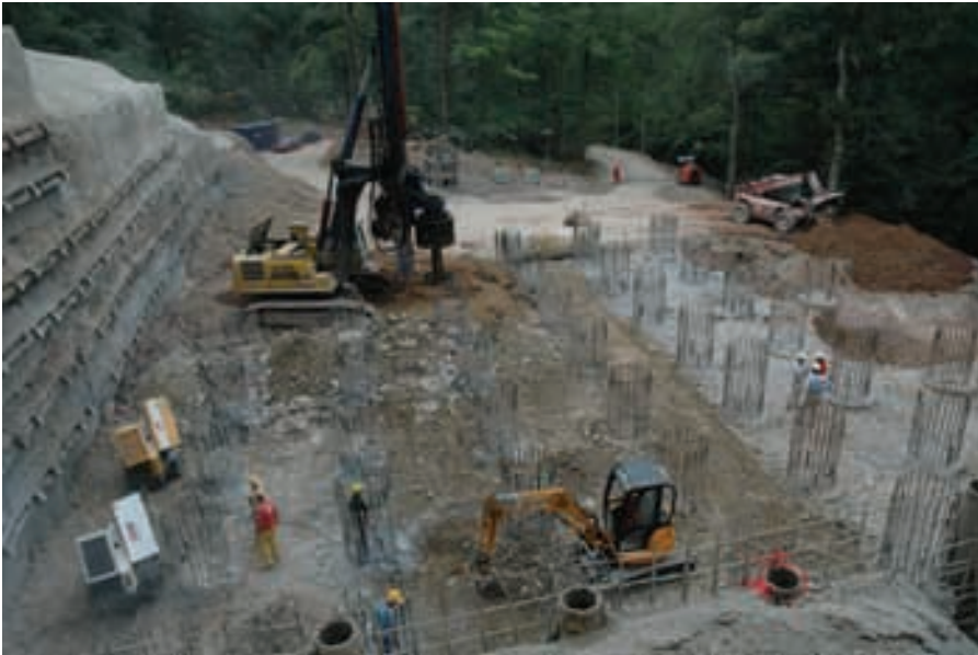
Figura 7. Descabezado de pilotes en pila 3. Figure 7. Beheading piles in pier 3
