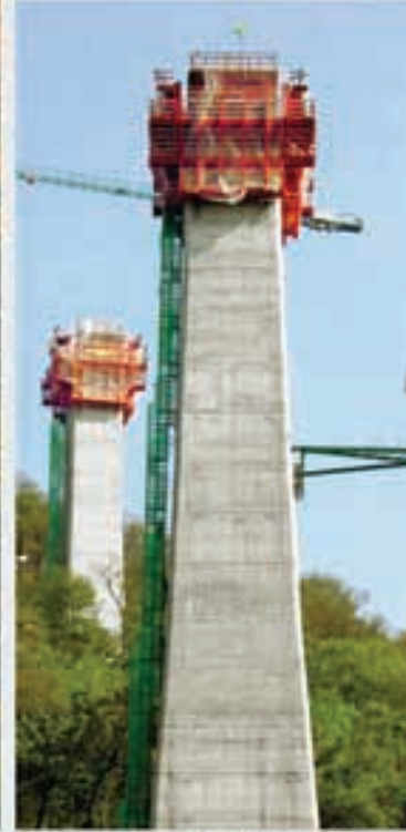
Pilas Viaducto de Montabiz
