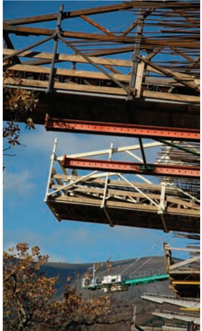
Figura 35. Carros de nervios transversales de voladizos.
