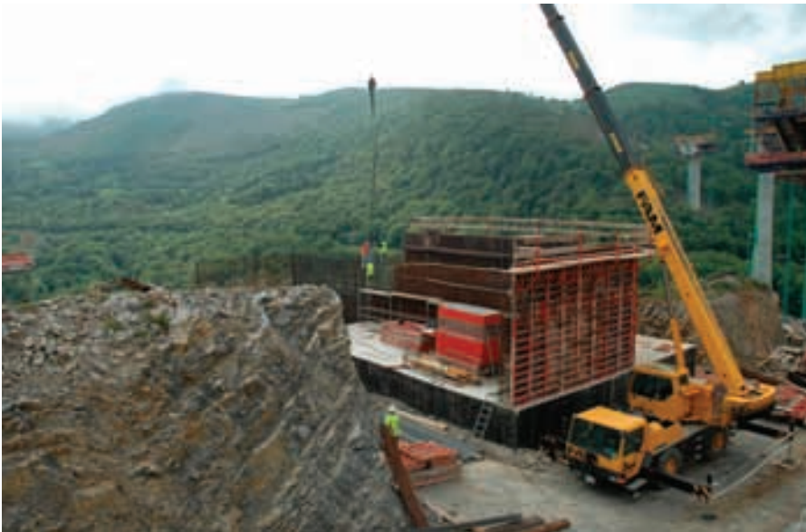
Figura 12. Ejecución de alzado de estribo 1. Figure 12. Executing abutment 1's elevation 1.
