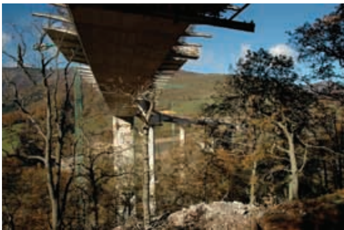
Figura 34. Vista inferior de tablero desde estribo 2.
