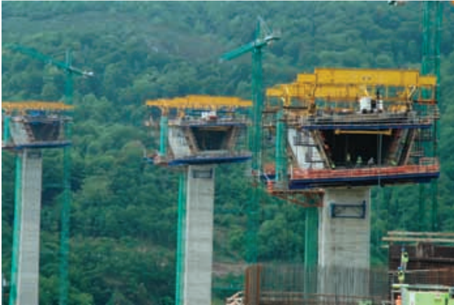
Figura 27. Ejecución de dovelas tipo mediante carros de avance. Figure 27. Building standard segments with travellers.
