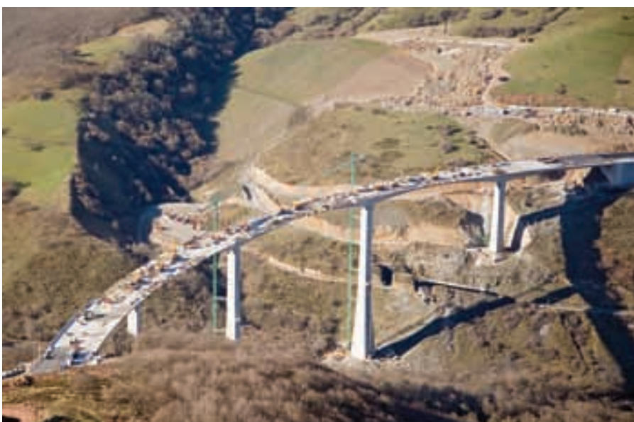
Figura 32. Detalle de cierre de vano 5 sobre el bosque mixto de Montabliz. Figure 32. Detail of span 5's closing over the mixed Montabliz wood.
