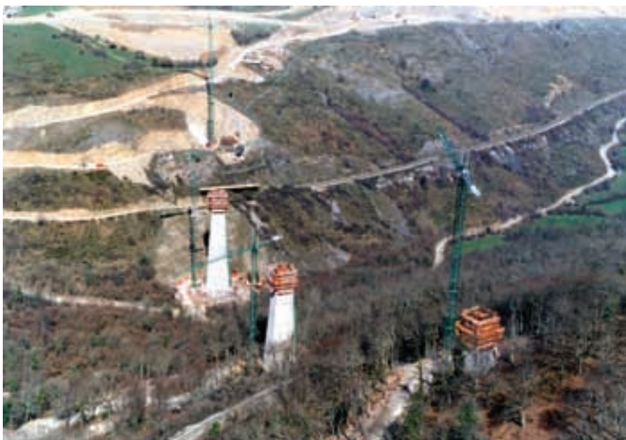
Figura 9. Vista general de ejecución de alzados de pilas. Figure 9. General view of the pier elevation construction.
