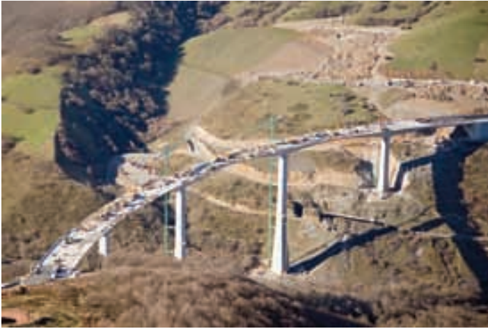
Figura 33. Vista aérea de la estructura durante la ejecución de los voladizos laterales.
