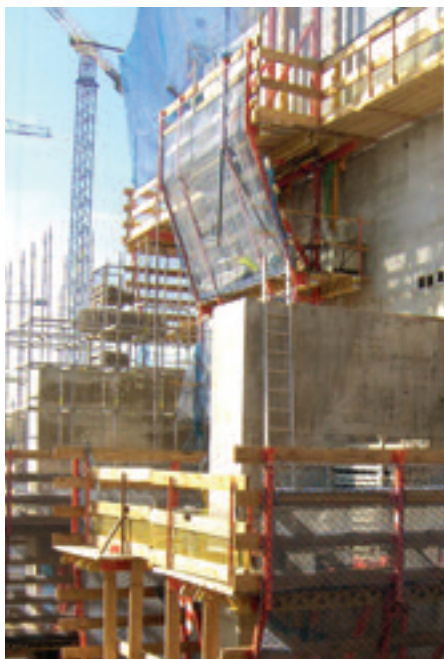
Figuras 12 y 13. Encofrado Autotrepante. Figures 12 and 13. Slipforms.
