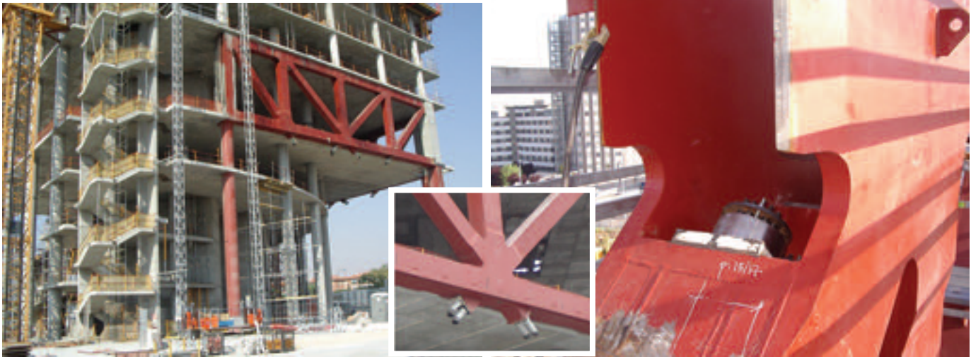
Figura 19. Vigas cargaderas en la zona de accesos al edificio (en el sentido de las agujas del reloj): vista general antes de la instalación de la fachada; detalle con los anclajes inferiores; detalle con los anclajes superiores durante el montaje.
