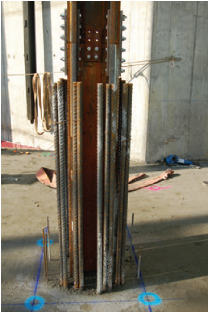
Figura 8. Uniones entre tramos de soportes metálicos con capacidad para resistir los esfuerzos debidos al viento durante la construcción. Figure 8. Joints between sections of steel supports, capable of withstanding the wind loads during construction.
