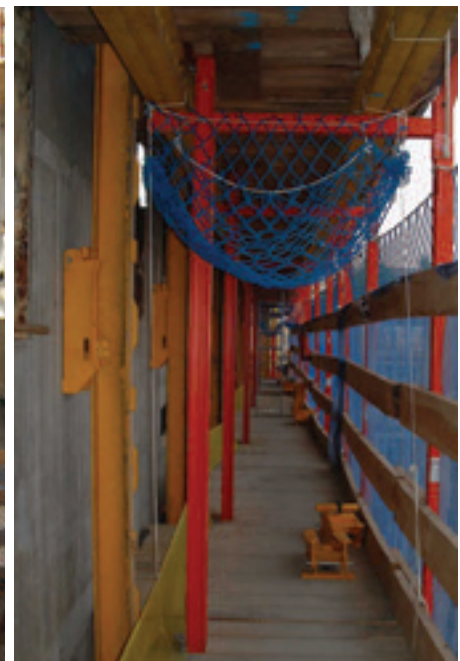
Figuras 12 y 13. Encofrado Autotrepante. Figures 12 and 13. Slipforms.
