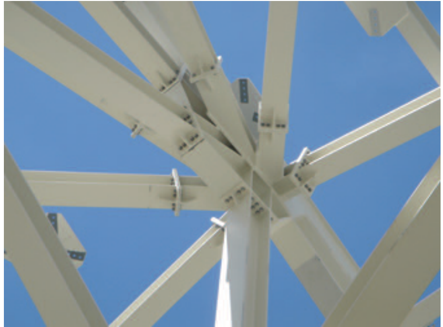
Figura 26. Detalle de Cubierta. Figure 26. Roof detail.
