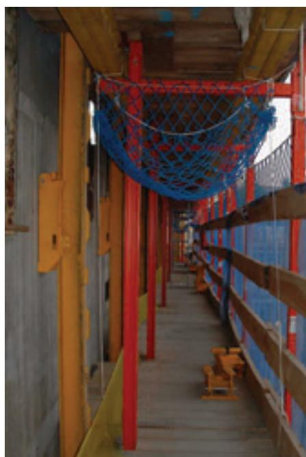
Figuras 12 y 13. Encofrado Autotrepante.
