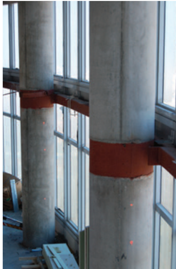
Figura 24. Estructura metálica auxiliar para sujeción de la fachada: vista general (izqda.); detalle de conexión con los soportes (dcha.).
