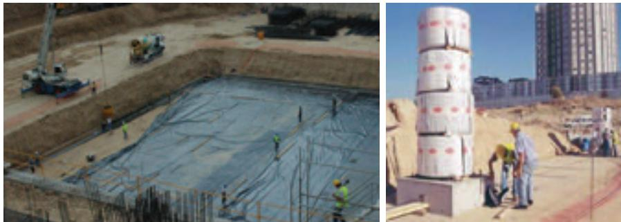
Figura 6. Dispositivos para reducir el rozamiento entre el terreno y la losa de cimentación: colocación de la doble lámina de polietileno (izqda.) y ensayo en verdadera magnitud de su eficacia (dcha.)
