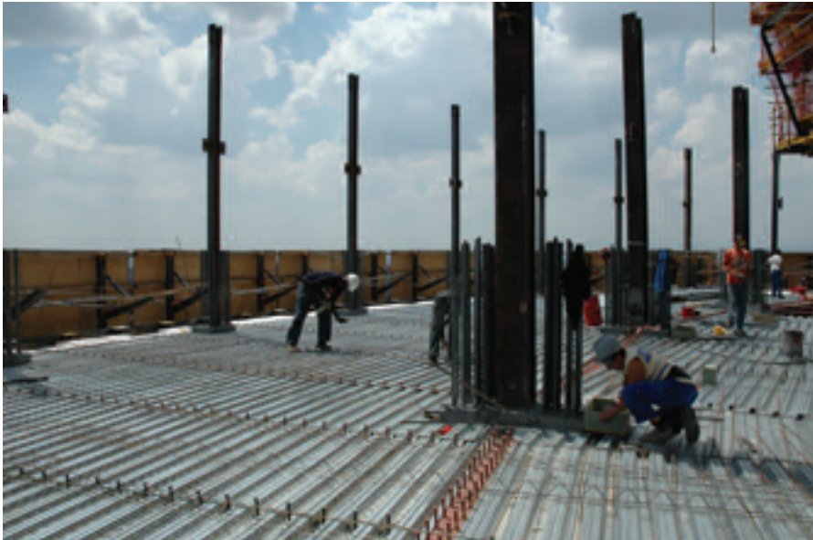
Figura 22. Montaje de la chapa plegada del forjado con el despiece adaptado a la geometría radial de la planta.
