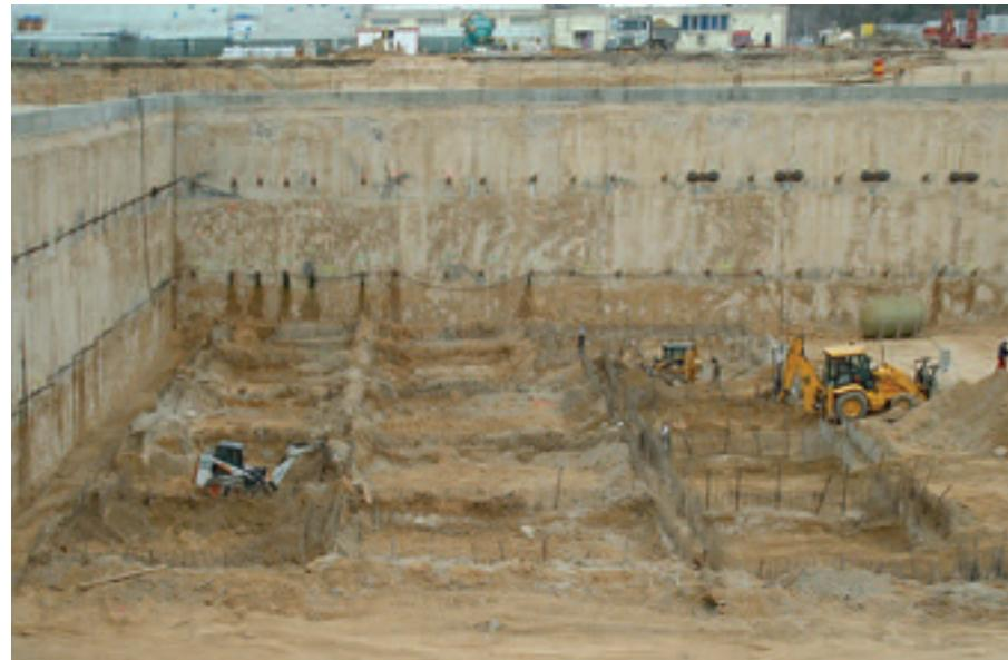
Figura 2. Excavación y muro pantalla.
