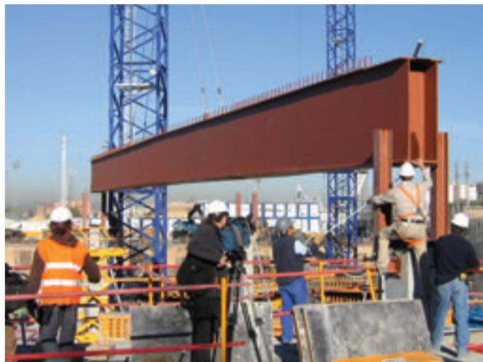
Figura 26. Montaje de las vigas metálicas para el cubrimiento del salón de convenciones.
