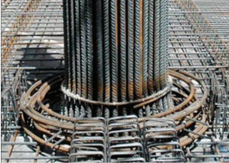
Figura 15. Zunchado de soportes con hormigón de alta resistencia en el cruce con los forjados.
