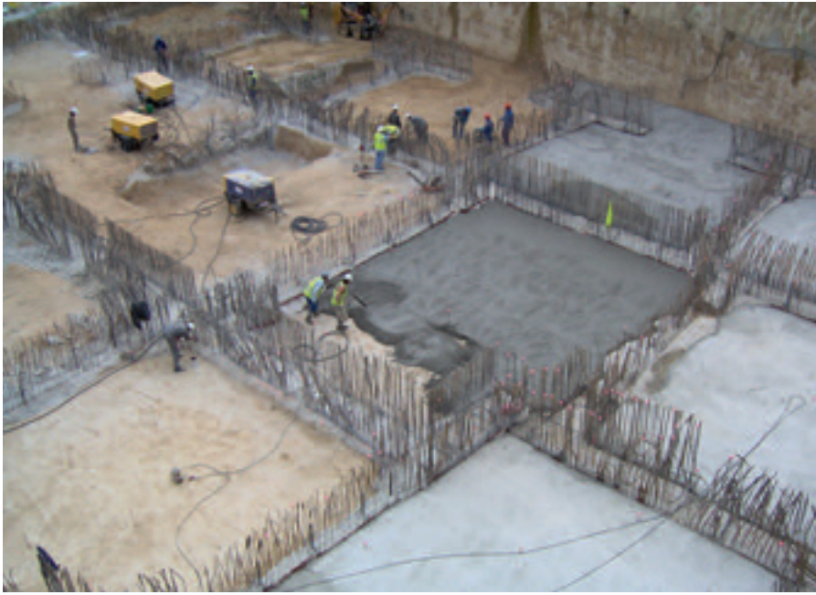
Figura 8. Cimentación. Vista general. Figure 8. Foundations. Overview.
