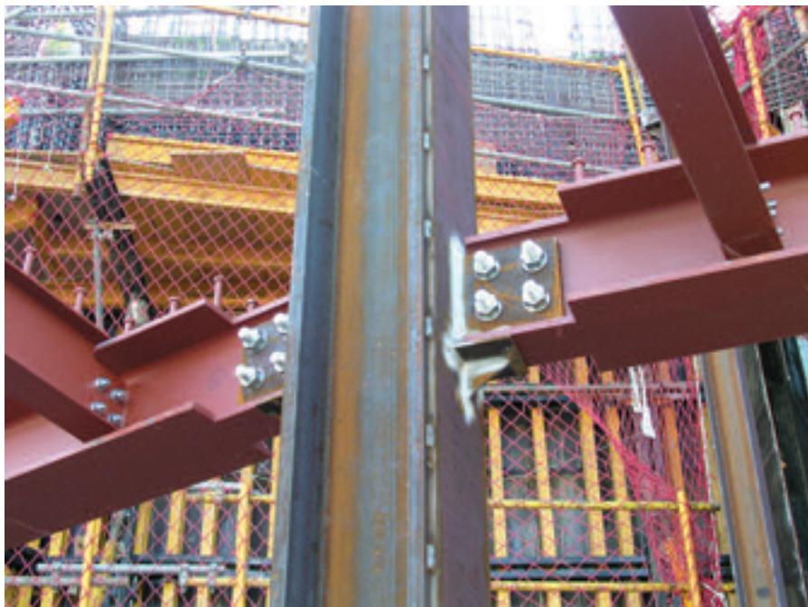
Figura 20. Unión atornillada de vigas principales con los soportes metálicos y embrochalamiento de viguetas en vigas principales.
