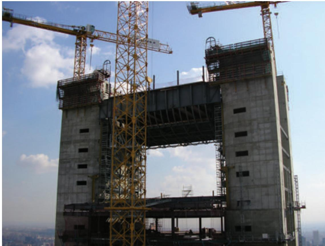
Figura 25. Elevación del entramado de vigas pared y arco de coronación a su posición final.
