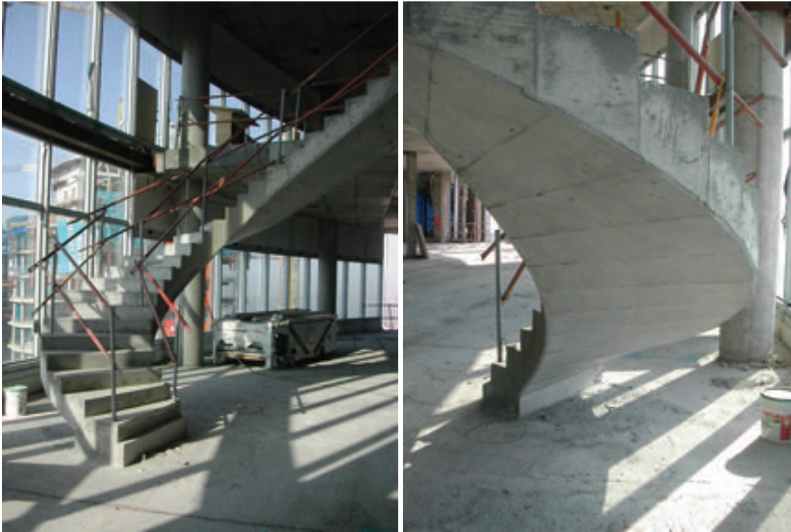
Figura 23. Escalera de caracol en la zona de Dirección del edificio (Plantas 44 y 45). Figure 23. Winding staircase in the building's Management area (44th and 45th floors).
