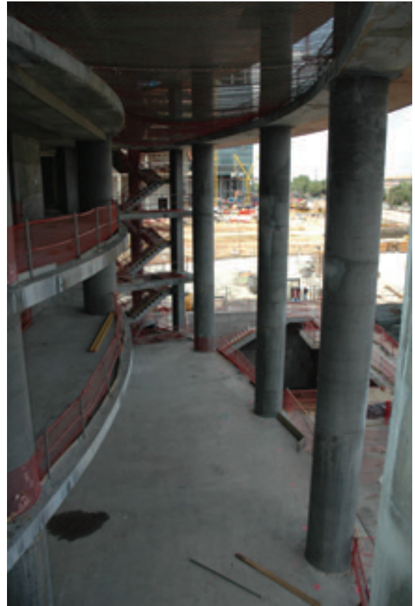
Figura 17. Forjados de hormigón armado en las zonas de acceso.
