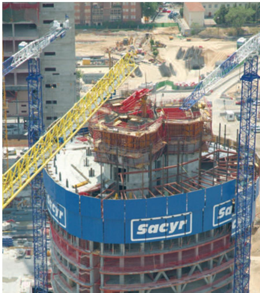
Figura 24. Vista general de la obra en una de las plantas tipo en la que se muestra la superposición de las actividades de construcción del núcleo mediante autotrepia y de la estructura metálica de la planta.
