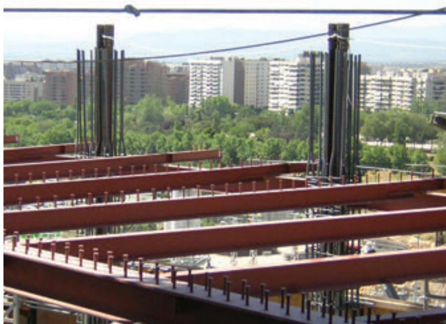
Figura 21. Viguetas principales de canto variable embrochaladas en la viga principal central apoyadas en la viga principal exterior.
