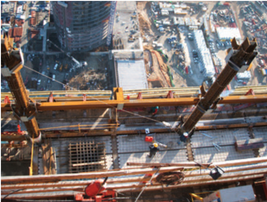
Figura 20. Estructura Exterior del núcleo. Figure 20. Structure outside the core.
