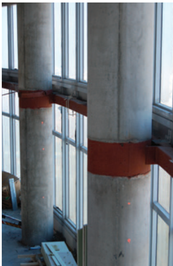
Figura 24. Estructura metálica auxiliar para sujeción de la fachada: vista general (izqda.); detalle de conexión con los soportes (dcha.). Figure 24. Auxiliary metal structure to secure the façade: general view (left); detail of connection to supports (right)
