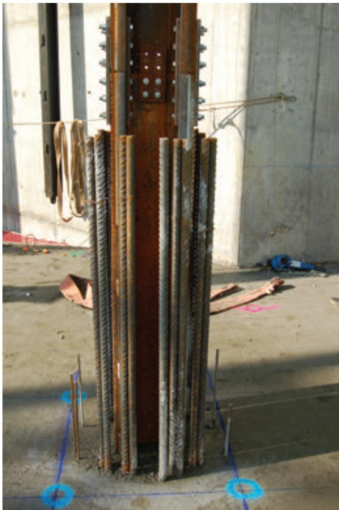
Figura 8. Uniones entre tramos de soportes metálicos con capacidad para resistir los esfuerzos debidos al viento durante la construcción.
