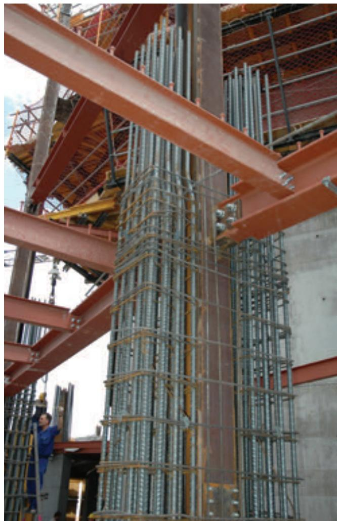
Figura 9. Soporte mixto densamente armado en la zona baja de la torre preparado para la colocación del encofrado.
