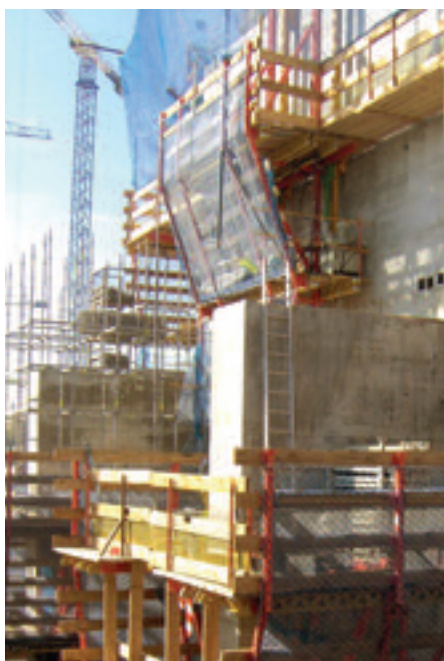
Figuras 12 y 13. Encofrado Autotrepante. Figures 12 and 13. Slipforms.
