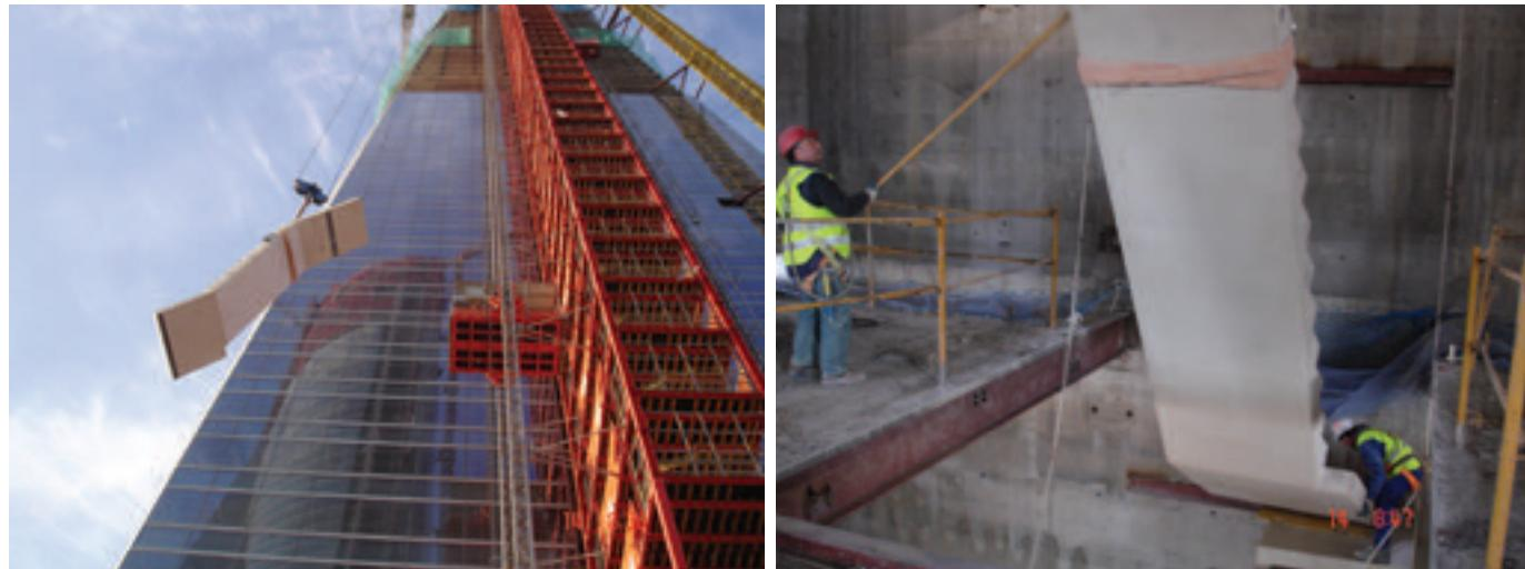
Figura 24. Montaje de un tramo de escalera prefabricada.
