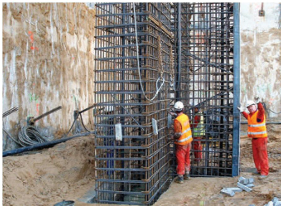
Figura 7. Ferralla para paneles de pantallas de cimentación.
