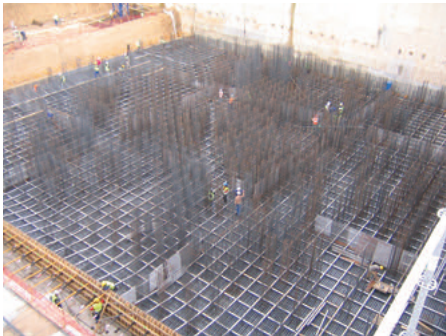
Figura 3. Vista general de la losa de cimentación, incluyendo los cables de pretensado y la armadura de cortate.
