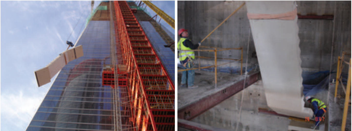
Figura 24. Montaje de un tramo de escalera prefabricada. Figure 24. Assembly of flight of precast stairs.
