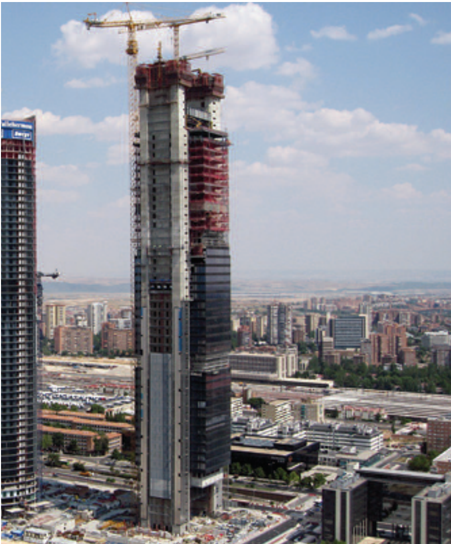
Figura 1. Vista del edificio antes de la elevación de la estructura del puente de coronación (cortesía de Vistaarea)
