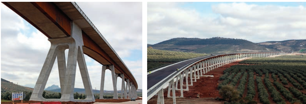
Viaducto de Archidona (Málaga).
