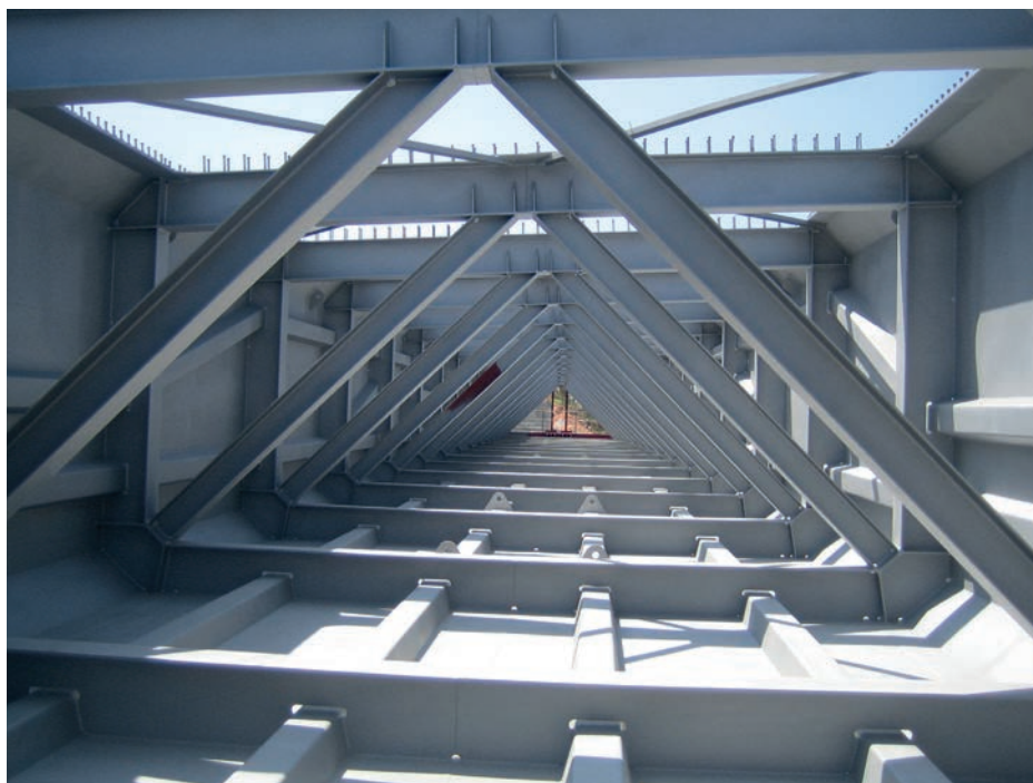
Figura 1. Sección formada por placas esbeltas rigidizadas.
