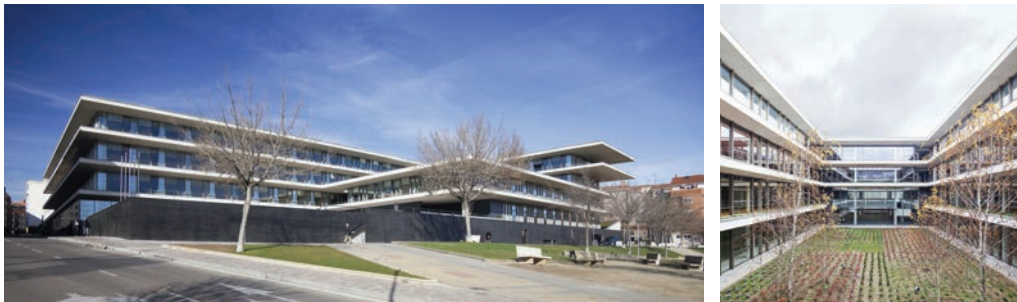
Edificio administrativo para usos múltiples (Salamanca).
