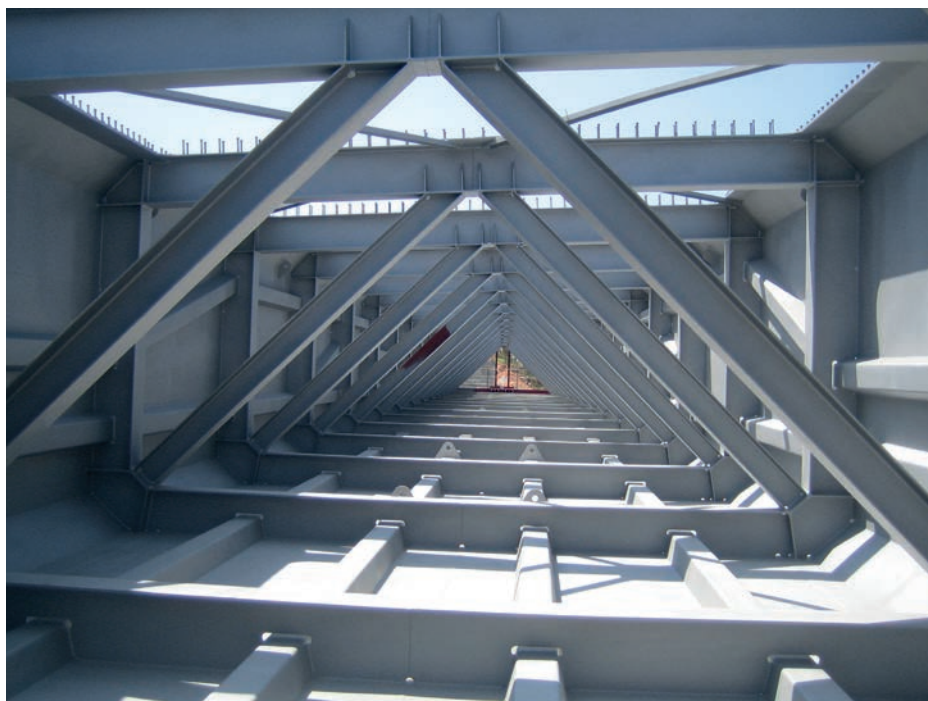
Figura 1. Sección formada por placas esbeltas rigidizadas.
