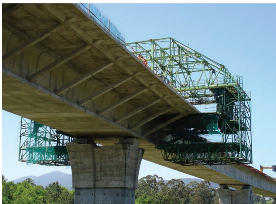
Figura 18. Hormigonado de voladizos. Figure 18. Cantilever casting.
