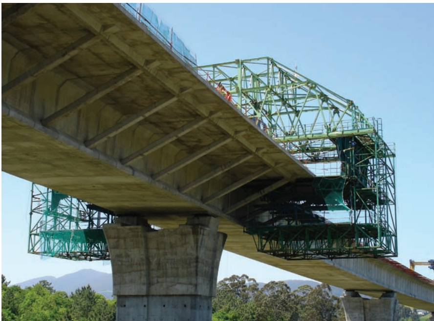
Figura 18. Hormigonado de voladizos. Figure 18. Cantilever casting.
