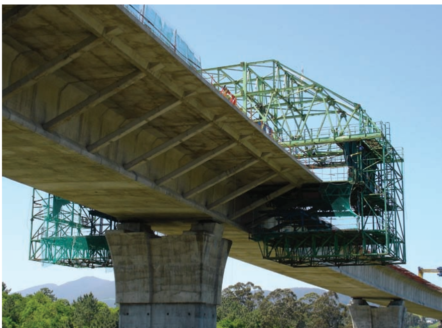
Figura 18. Hormigonado de voladizos. Figure 18. Cantilever casting.
