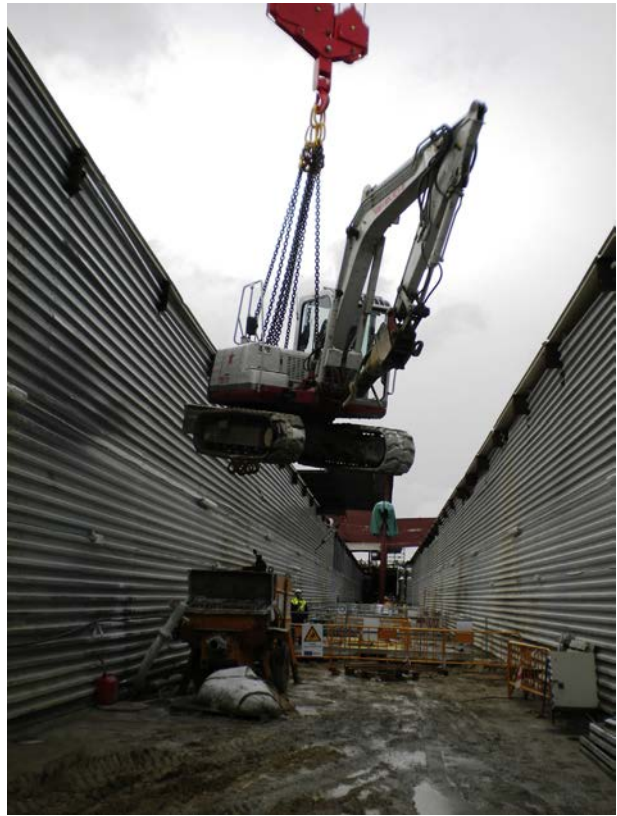
Figura 45. Acceso de maquinaria a los andenes.
