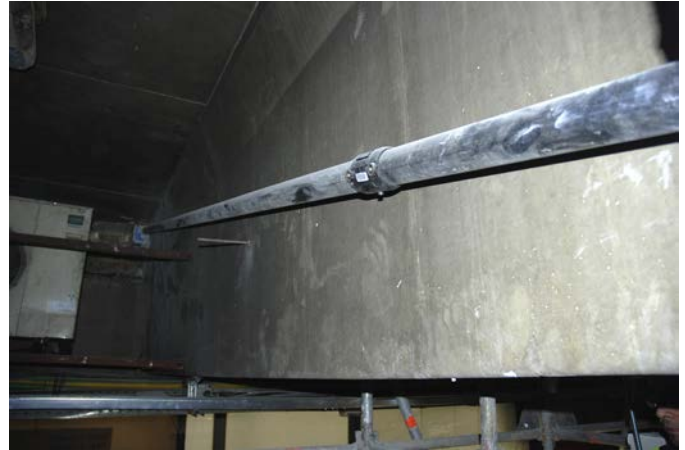
Figura 24. Refuerzo viga existente mediante postesado exterior.
