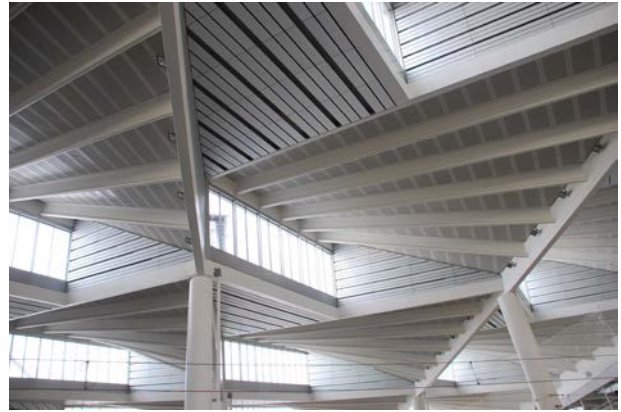
Figura 3. Vista desde el interior de la cubierta alta terminada.
