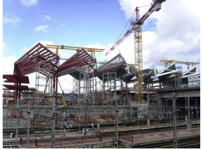
Figura 53. Torres de apeo sobre cercanías.
