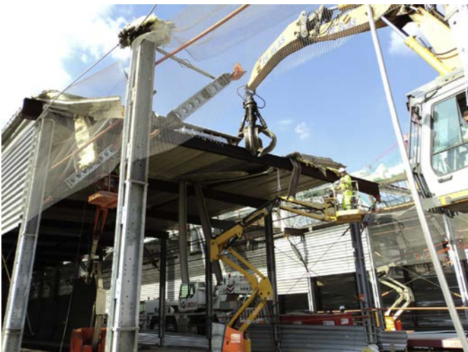
Figura 44. Demolición de los túneles provisionales.
