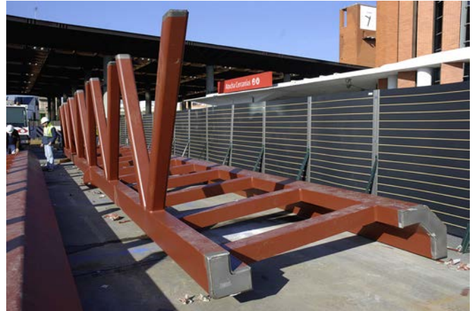
Figura 58. Módulo de cubierta a pie de obra.
