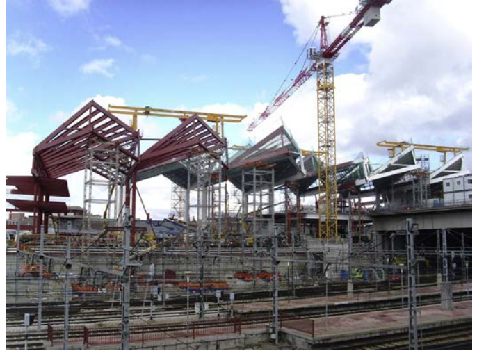
Figura 53. Torres de apeo sobre cercanías.
