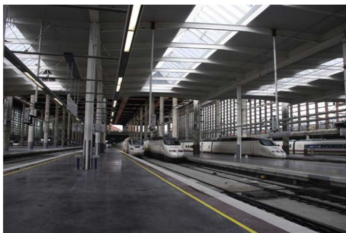
Figura 4. Cubierta baja norte.
