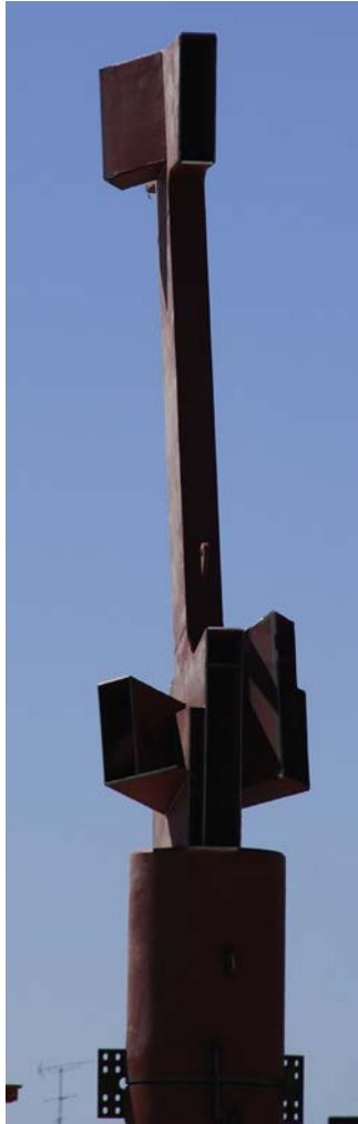
Figura 18. Nudo de cubierta alta durante el montaje.
