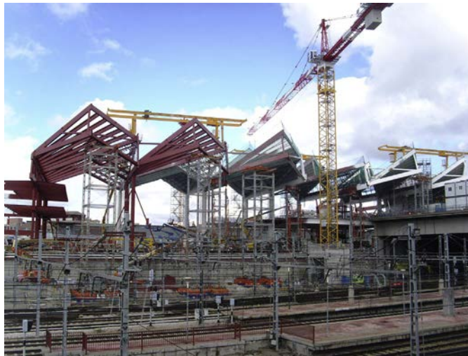
Figura 53. Torres de apeo sobre cercanías.
