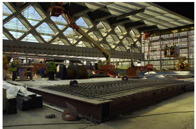
Figura 20. Ejecución del emparrillado metálico, previamente al hormigonado del forjado mixto.
