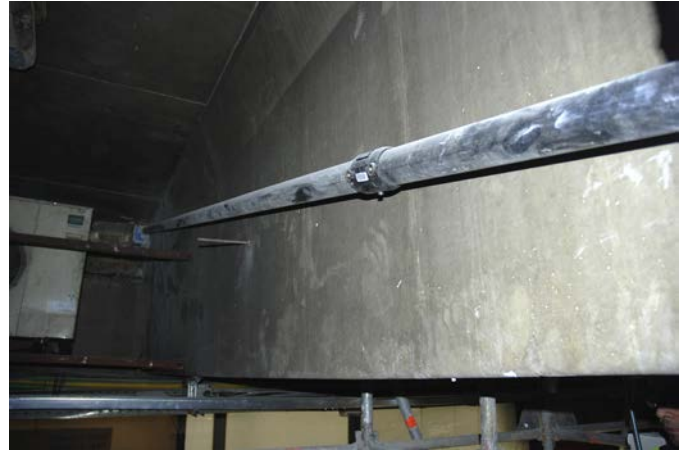
Figura 24. Refuerzo viga existente mediante postesado exterior.
