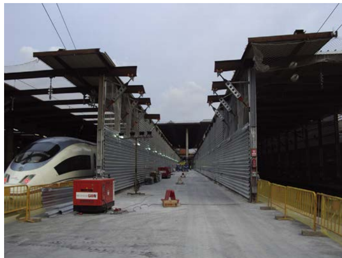
Figura 36. Túneles provisionales para la protección de vías.
