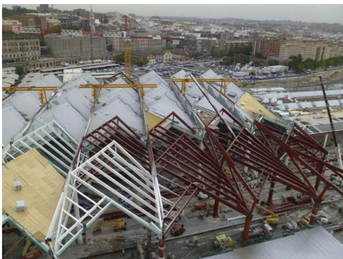
Figura 51. Puentes grúa sobre la cubierta alta.
