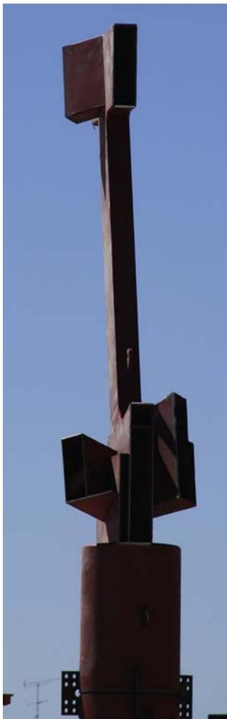
Figura 18. Nudo de cubierta alta durante el montaje.
