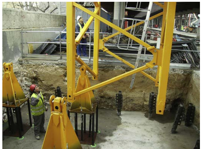
Figura 49. Montaje de la grúa del andén 8.
