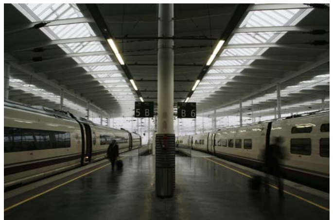
Figura 56. Aspecto terminado de marquesinas bajas.
