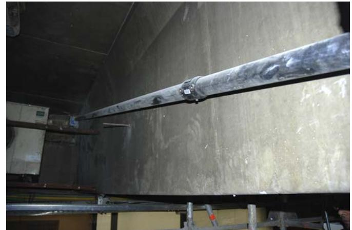
Figura 24. Refuerzo viga existente mediante postesado exterior.
