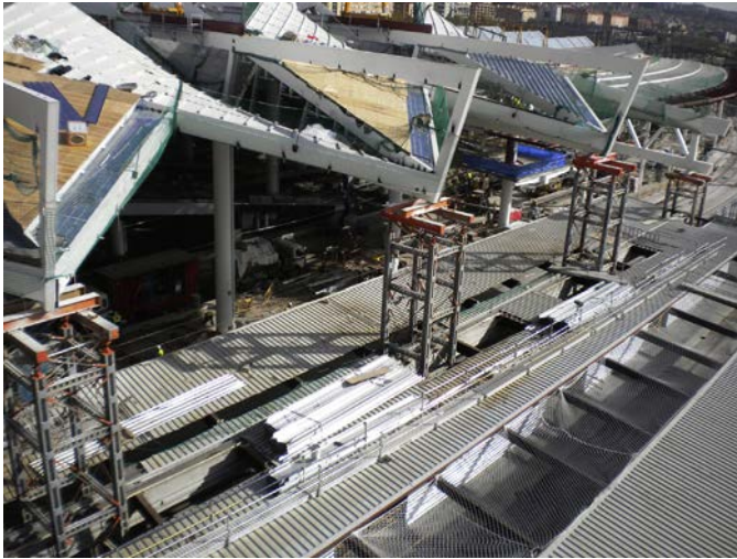
Figura 54. Torres de apeo en andén 7.
