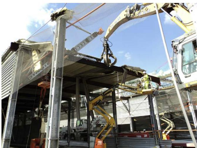
Figura 44. Demolición de los túneles provisionales.
