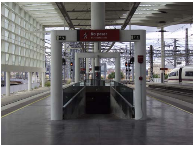
Figura 10. Rampas de catering, aspecto terminado.
