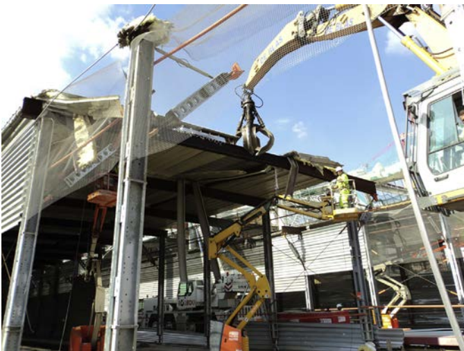
Figura 44. Demolición de los túneles provisionales.
