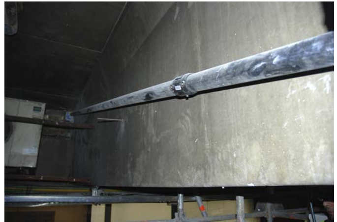
Figura 24. Refuerzo viga existente mediante postesado exterior.
