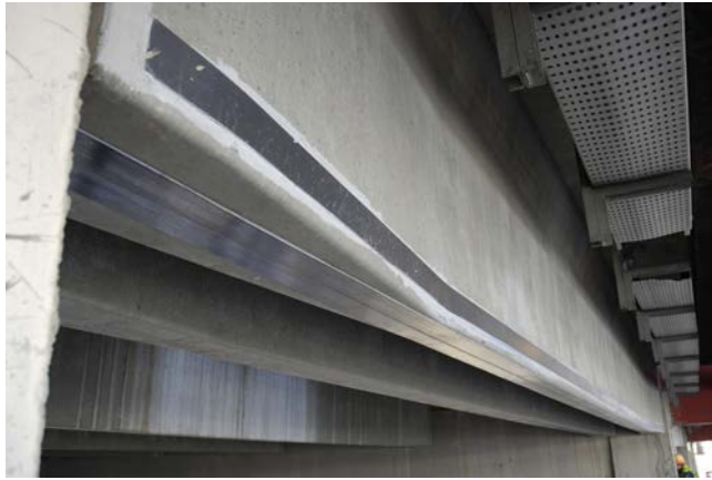
Figura 22. Refuerzo a flexión de vigas armadas mediante fibras de carbono.
