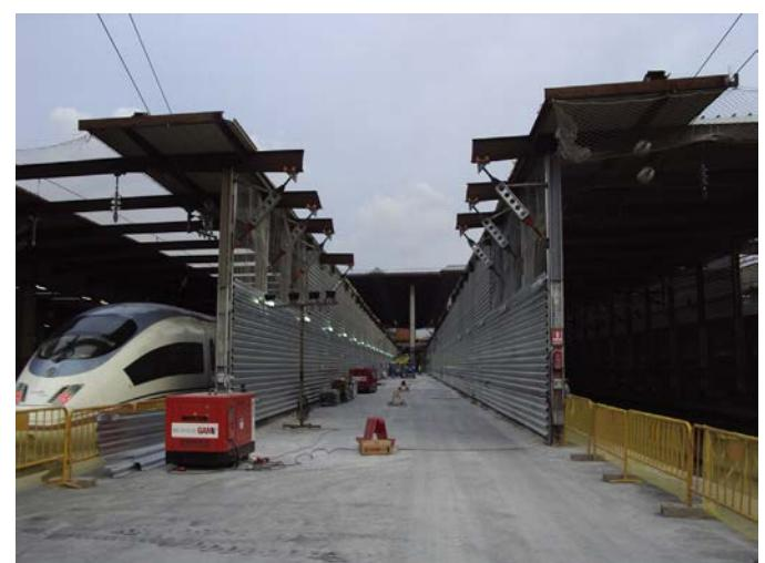
Figura 36. Túneles provisionales para la protección de vías.
