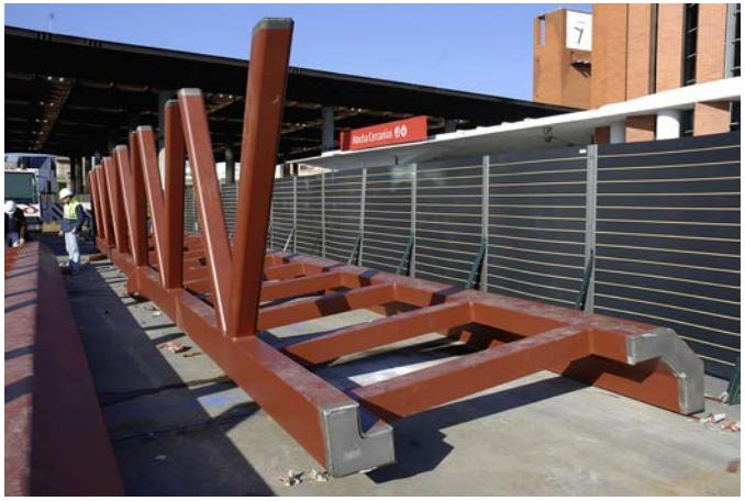
Figura 58. Módulo de cubierta a pie de obra.
