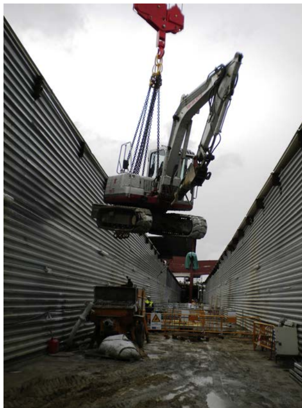
Figura 45. Acceso de maquinaria a los andenes.
