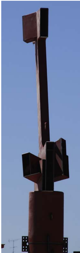
Figura 18. Nudo de cubierta alta durante el montaje.
