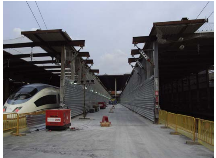
Figura 36. Túneles provisionales para la protección de vías.
