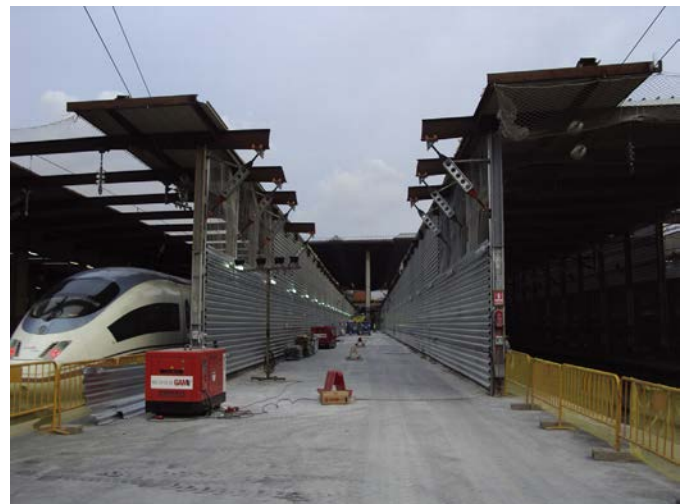
Figura 36. Túneles provisionales para la protección de vías.
