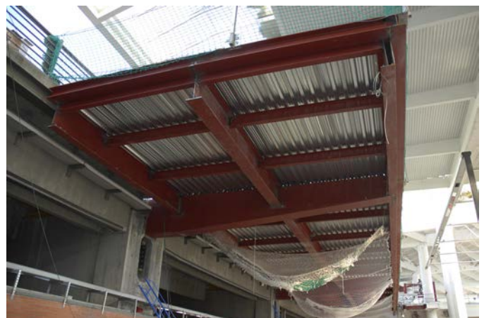
Figura 28. Vista del voladizo by-pass desde las vías del AVE.
