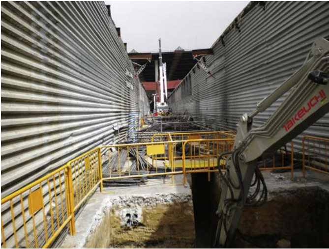
Figura 43. Ejecución de micropilotes y encepados entre túneles provisionales para la protección de vías.
