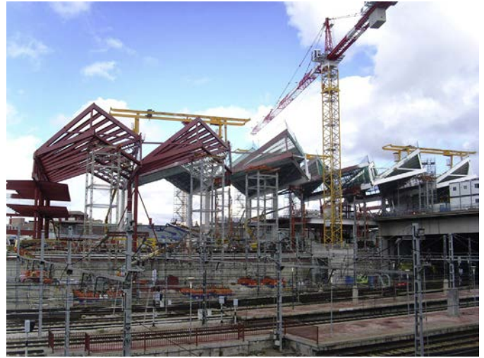
Figura 53. Torres de apeo sobre cercanías.
