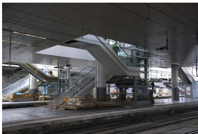
Figura 6. Escalera de acceso.
