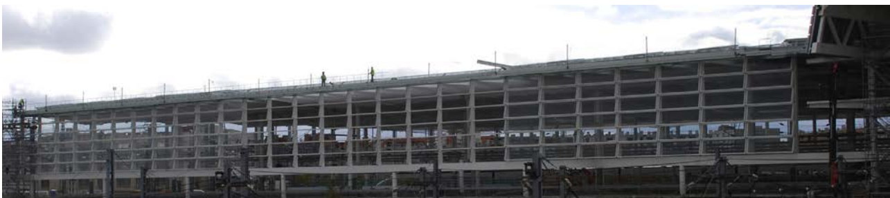
Figura 15. Muro cortina durante la ejecución de las obras.
