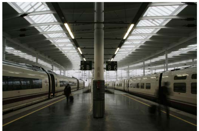
Figura 56. Aspecto terminado de marquesinas bajas.
