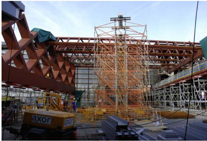
Figura 57. Montaje de la cubierta por módulos.
