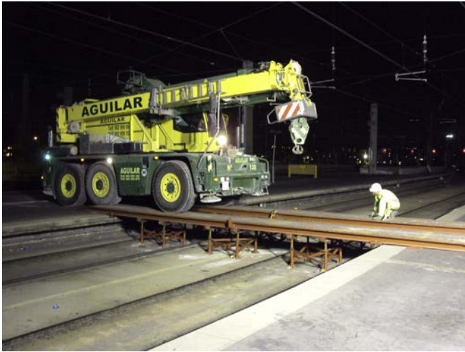
Figura 46. Tránsito de maquinaria entre andenes.
