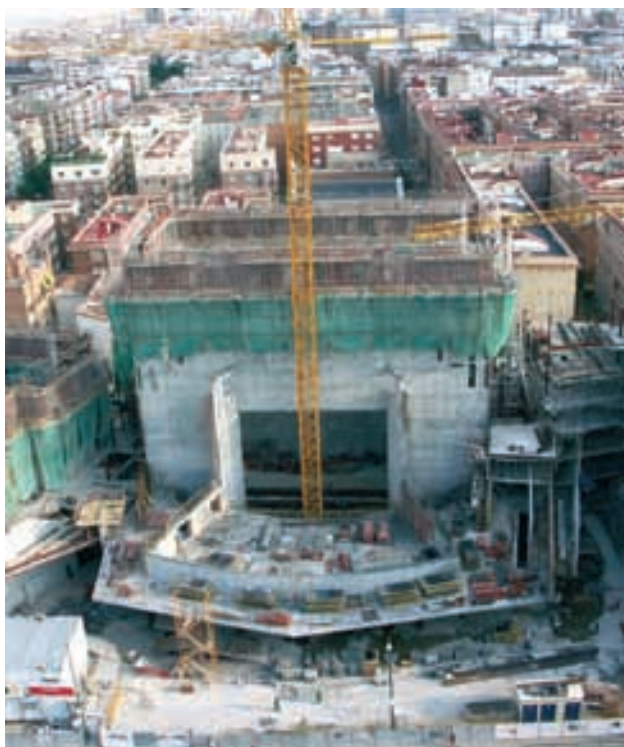
Figura 7. Imagen de la estructura colgada del Teatro Principal en construcción.
