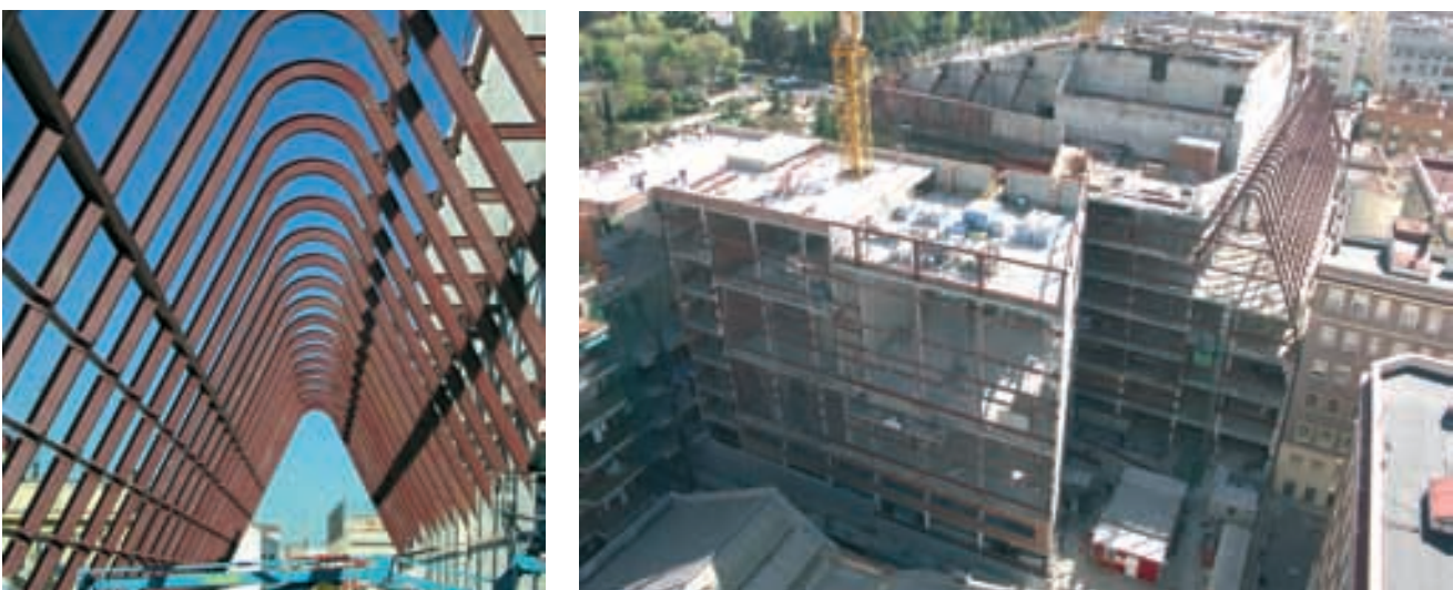
Figura 26. Lucernario de la Galería Dorsal y vista aérea del Centro Coreográfico y Galería Dorsal. Figure 26. Glass skylight in the Rear Zone and aerial view of the Rear Zone and Choreographic Centre.
