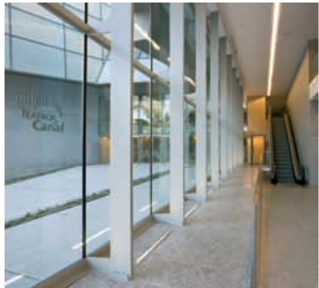
Figura 30. Fachadas inferiores terminadas.
