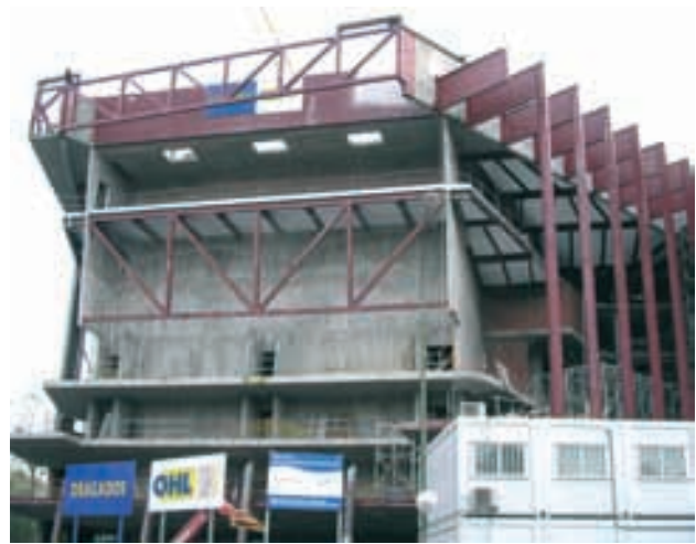
Figura 29. Estructura metálica de fachada colgada desde ménsulas en el Teatro Configurable y celosías frontales de cuelgue de perfiles de fachada.
