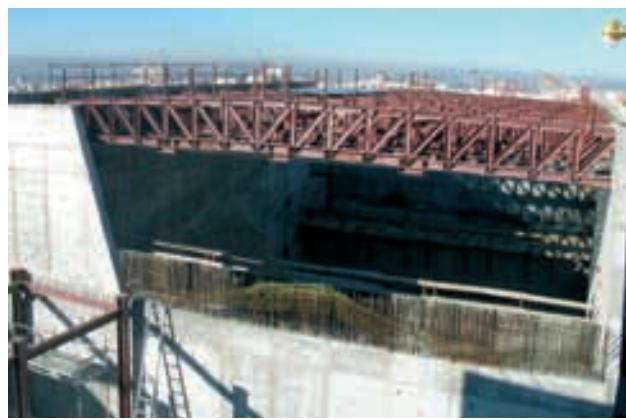
Figura 16. Celosías mixtas de la cubierta de la caja escénica.
