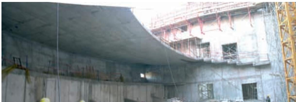
**Figura 12.** Vista inferior del sistema estructural que conforma el anfiteatro
