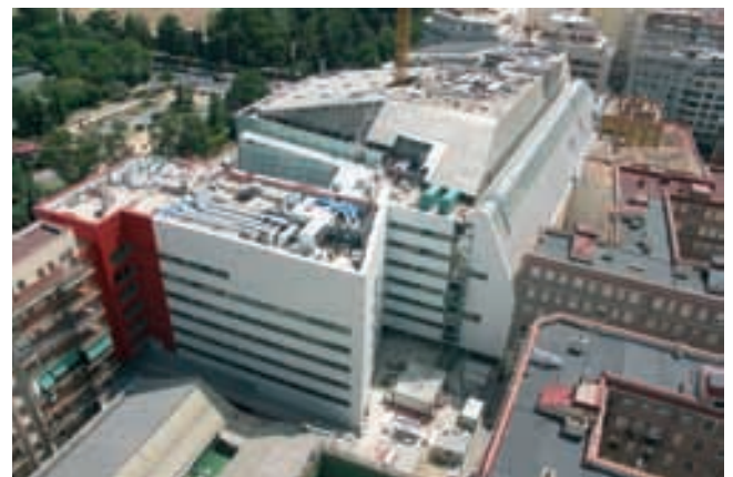
Figura 43. Vista lateral del edificio. Figure 43. Lateral view.
