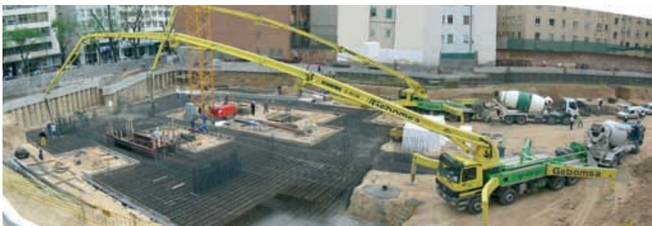
Figura 32. Hormigonado de la losa de cimentación del Teatro Configurable.
