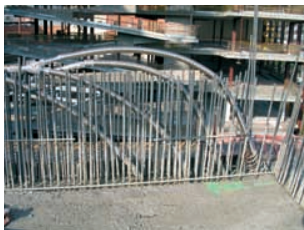
Figura 10. Pretensado de pantallas laterales del Teatro Principal
