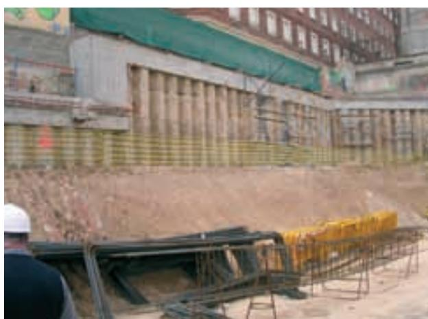
**Figura 31.** Contención perimetral del solar.
