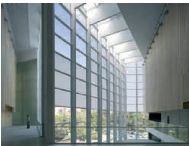
Figura 46. Atrio interior cubierto por la fachada acristalada.
