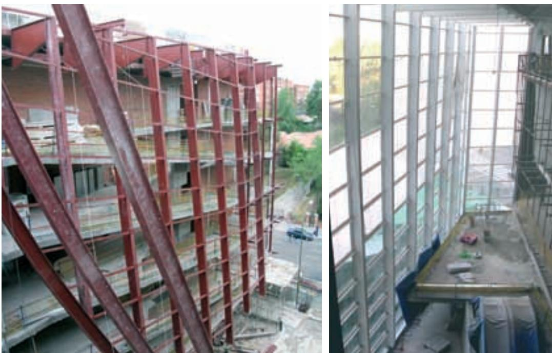
Figura 28. Estructura metálica de fachada colgada desde ménsulas en el espacio entre el Centro Coreográfico y el Teatro Principal.
