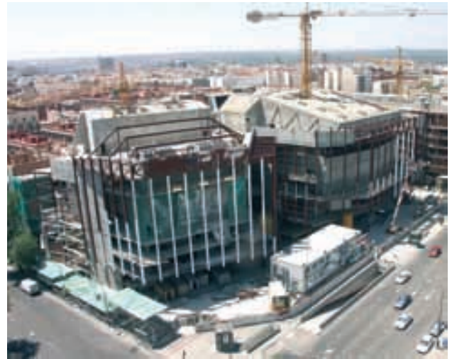
Figura 36. Construcción de la estructura de fachadas. Figure 36. Façade structure construction.
