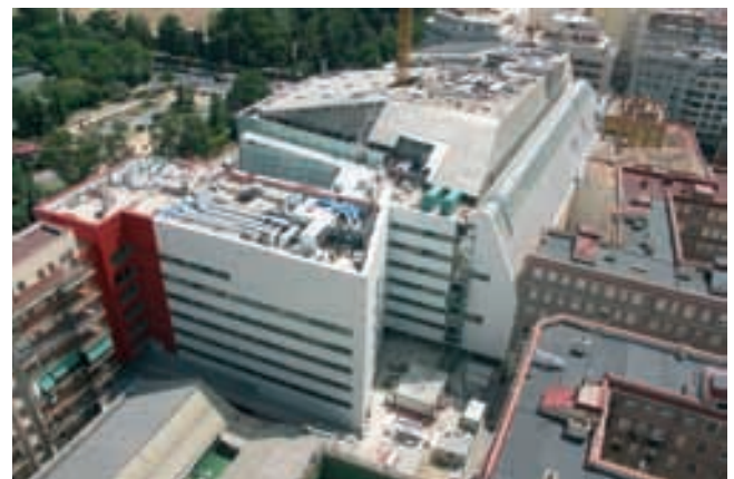
Figura 43. Vista lateral del edificio. Figure 43. Lateral view.
