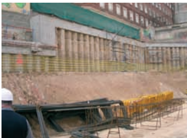
Figura 31. Contención perimetral del solar.
