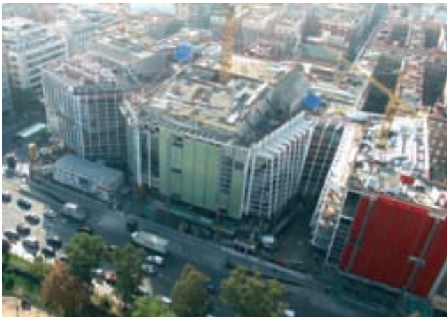
Figura 41. Colocación de vidrios de fachada. Figure 41. Façade glasses placing.
