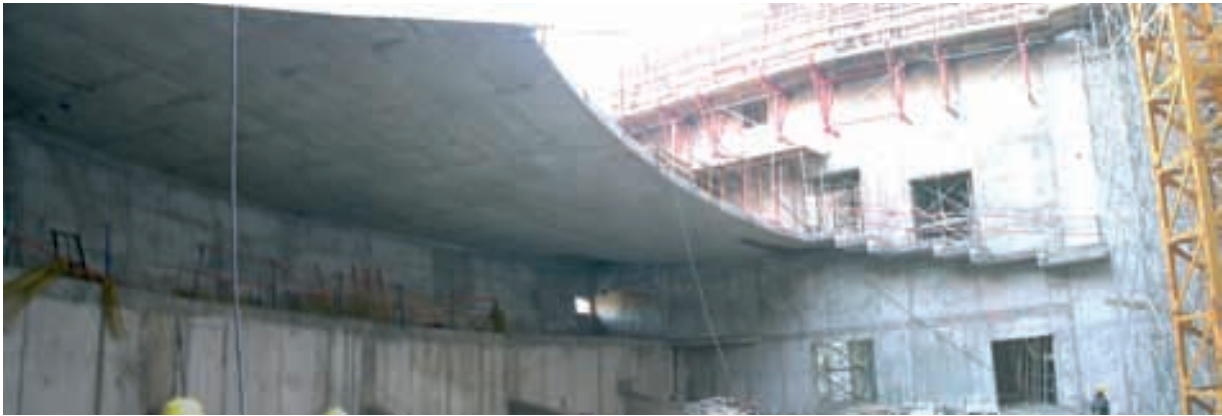
Figura 12. Vista inferior del sistema estructural que conforma el anfiteatro Figure 12. Amphitheatre structure lower view.
