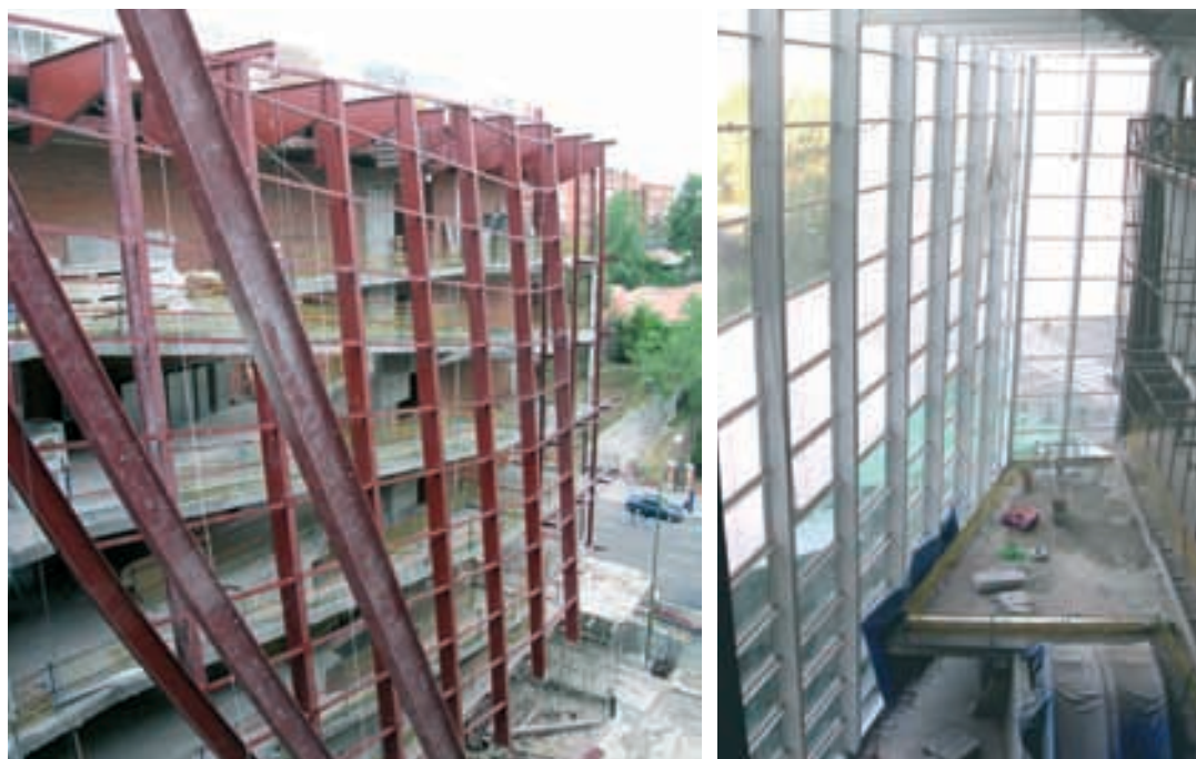
Figura 28. Estructura metálica de fachada colgada desde ménsulas en el espacio entre el Centro Coreográfico y el Teatro Principal. Figure 28. Upper façades steel structure hung from cantilevers between the Choreographic Centre and the Main Theatre.
