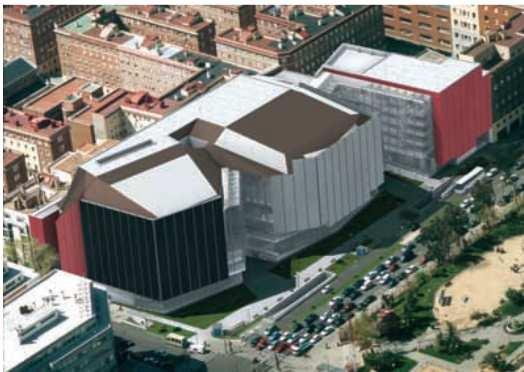
Figura 4. Imagen virtual de los edificios: Teatro Configurable, Teatro Principal y Centro Coreográfico (de izquierda a derecha)
