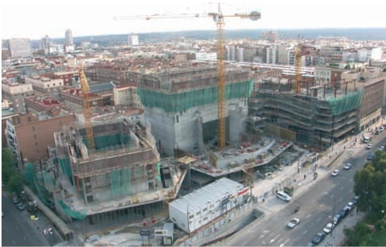
**Figura 35.** Estructura de los teatros en fase de construcción
