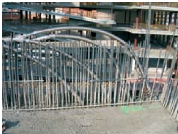
Figura 10. Pretensado de pantallas laterales del Teatro Principal
