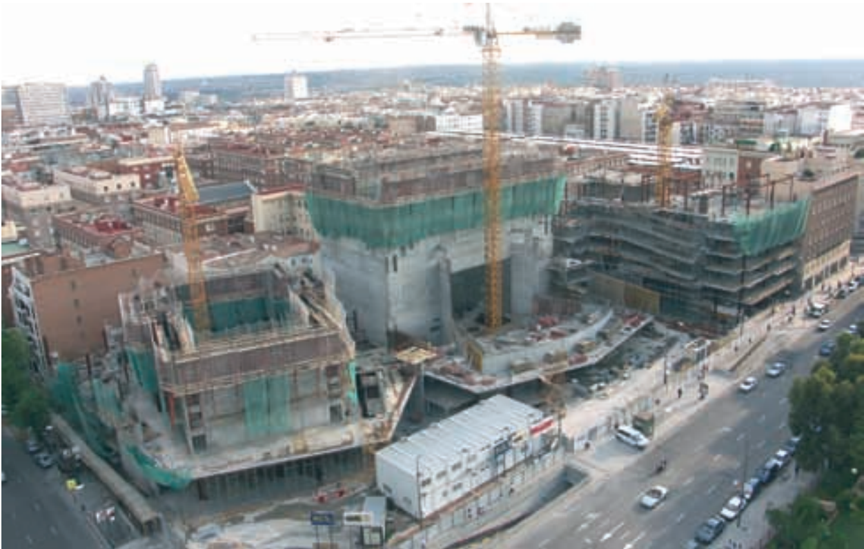
Figura 35. Estructura de los teatros en fase de construcción Figure 35. Theatres structure under construction.
