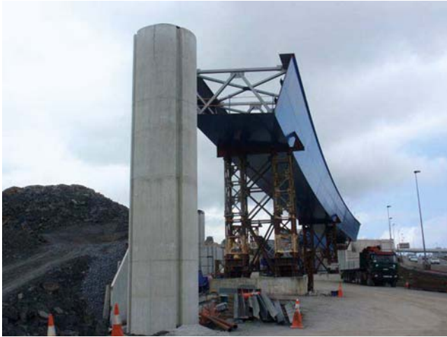
Figura 28. Pilas de los ramales de acceso.
