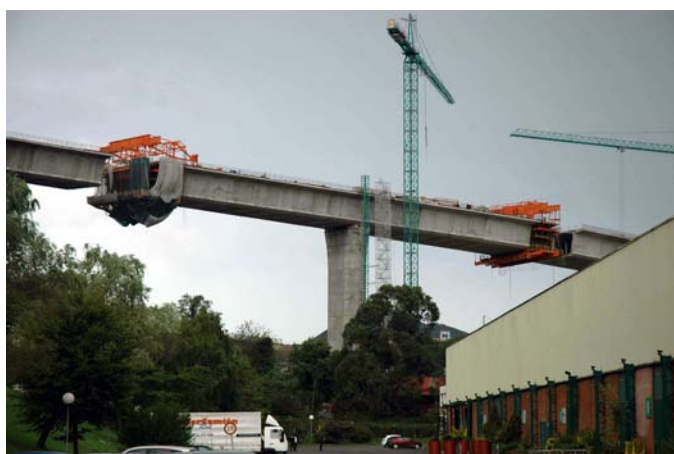
Figuras 4 y 5. Vistas de la construcción del núcleo por voladizos sucesivos.
