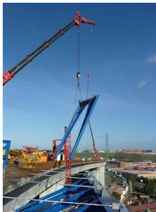
Figura 15. Viaducto principal. Montaje de jабalcones.
