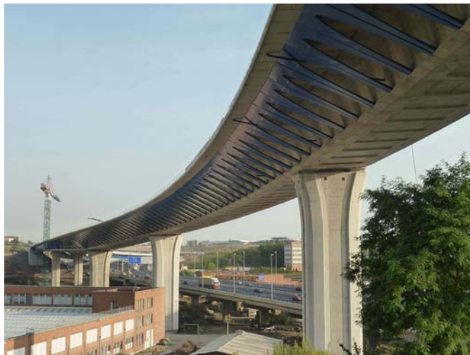
Figura 6. Vista general del viaducto principal.
