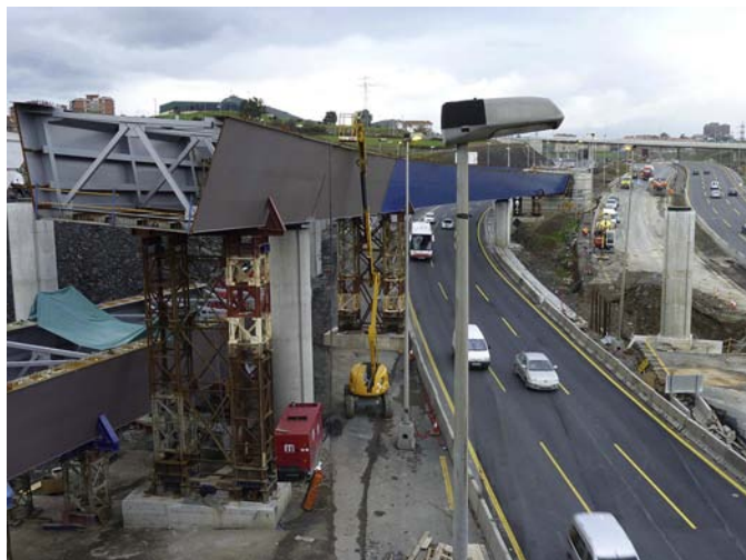
Figura 17. Viaducto de acceso. Tramos metálicos de ramales B y C.
