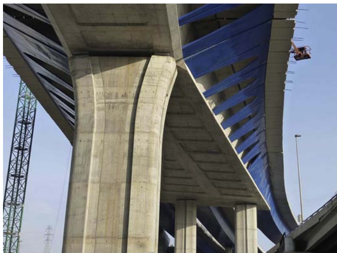
Figura 23. Vista inferior de la zona de transición.
