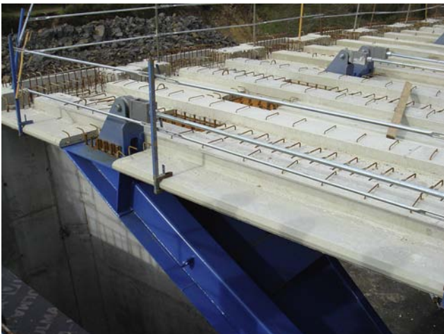
Figura 14. Viaducto principal. Prelosas colocadas.
