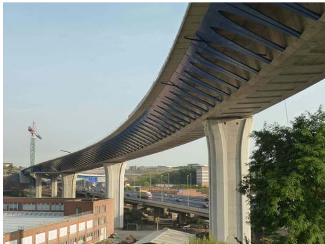
Figura 6. Vista general del viaducto principal.
