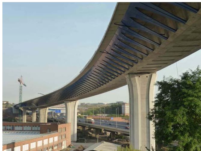
Figura 6. Vista general del viaducto principal.
