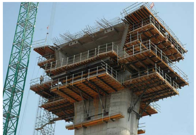
Figura 8. Plataformas de trabajo de dovela cero.
