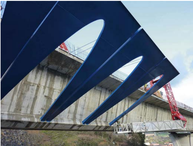
Figura 9. Viaducto principal. Vista inferior de los jabalcones durante montaje.
