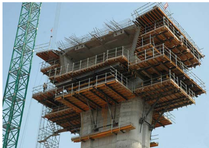
Figura 8. Plataformas de trabajo de dovela cero.
