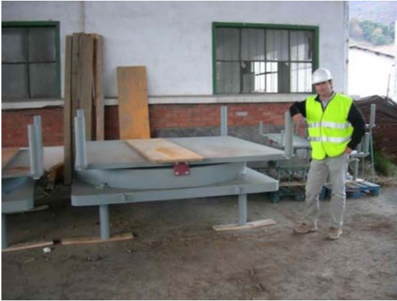
Figura 26. Imagen de los apoyos tipo POT.
