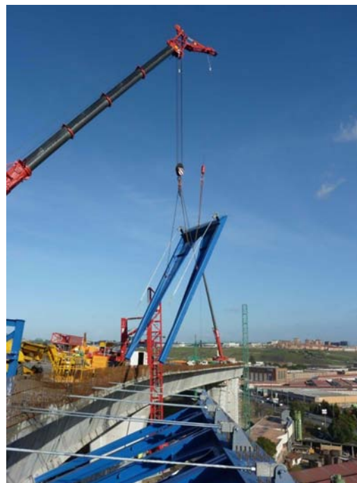
Figura 15. Viaducto principal. Montaje de jабalcones.
