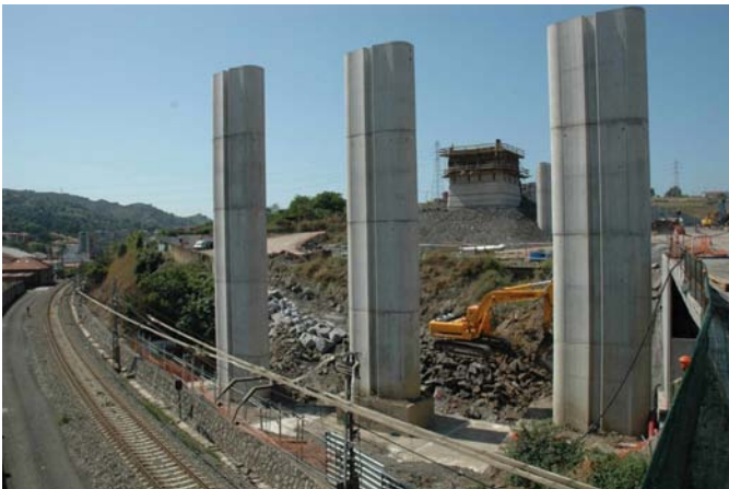
Figura 29. Pilas de la zona de transición.
