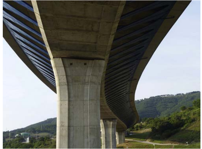
Figura 12. Viaducto principal. Vista inferior.
