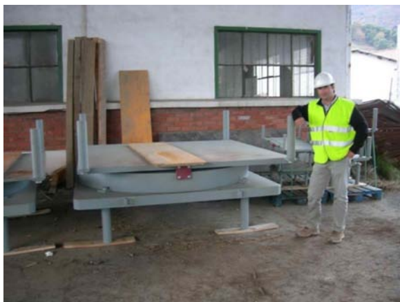
Figura 26. Imagen de los apoyos tipo POT.
