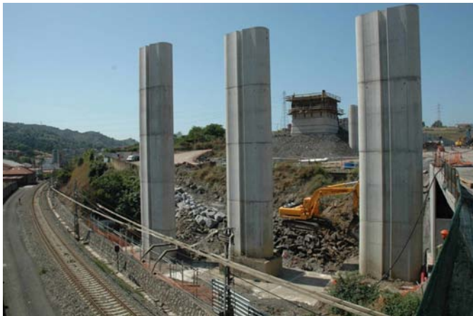
Figura 29. Pilas de la zona de transición.
