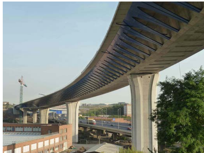
Figura 6. Vista general del viaducto principal.
