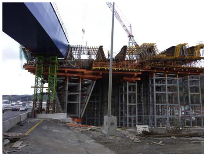
Figuras 21 y 22. Vistas de la cimbra de la zona de transición.
