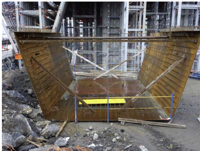
Figura 24. Vista de la dovela de conexión antes de ser izada.
