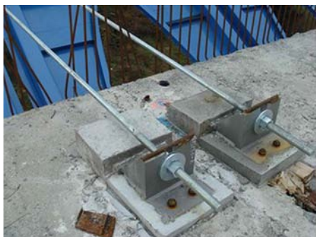
Figura 13. Viaducto principal. Tacos de sujeción en núcleo.
