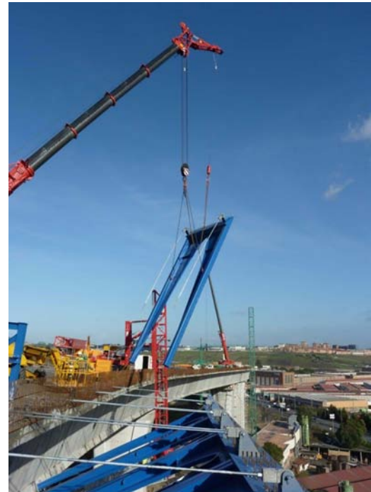
Figura 15. Viaducto principal. Montaje de jабalcones.
