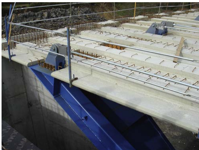
Figura 14. Viaducto principal. Prelosas colocadas.
