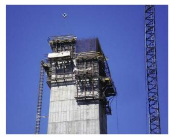
Figura 25. Encofrado trepante convencional en pilas 2, 3 y 5.
