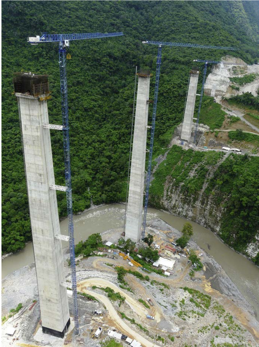
Figura 27. Vista general de las pilas 3, 4 y 5 terminadas.
