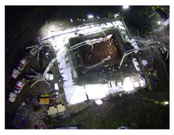
Figura 23. Hormigonado del encepado de la pila 4 en una fase.
