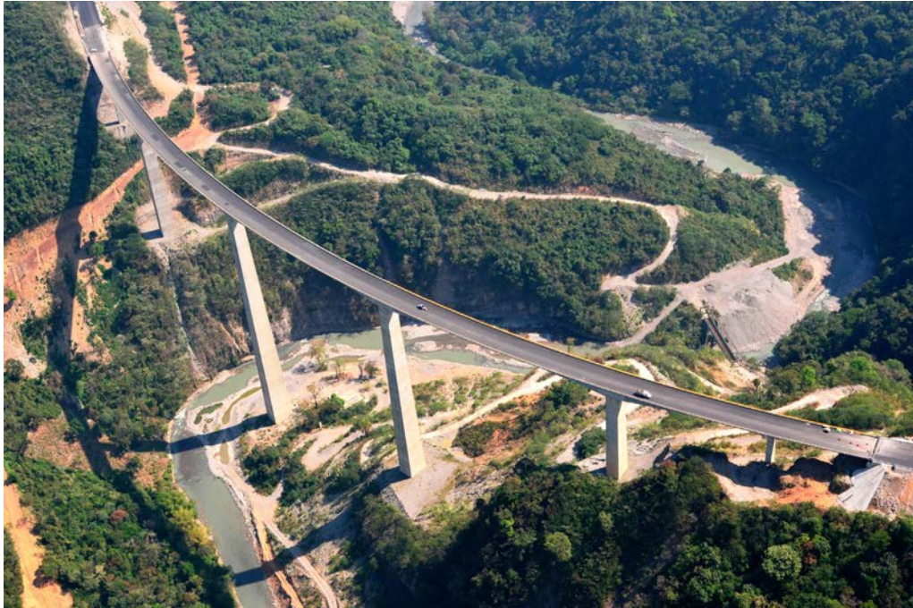
Figura 32. Vista general del puente terminado.
