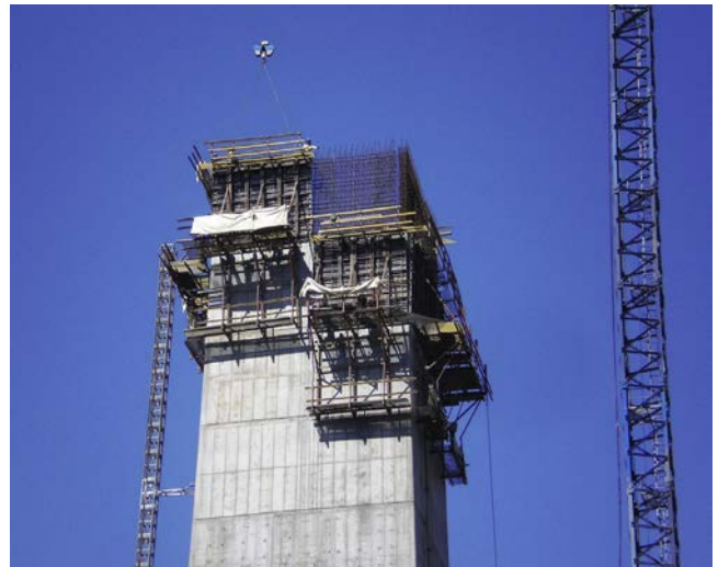
Figura 25. Encofrado trepante convencional en pilas 2, 3 y 5.
