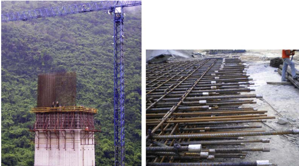
Figura 24. Premontaje de la armadura de las pilas.
