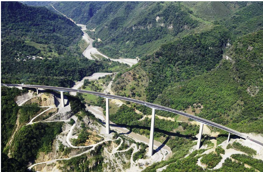
Figura 2. Vista general del puente.
