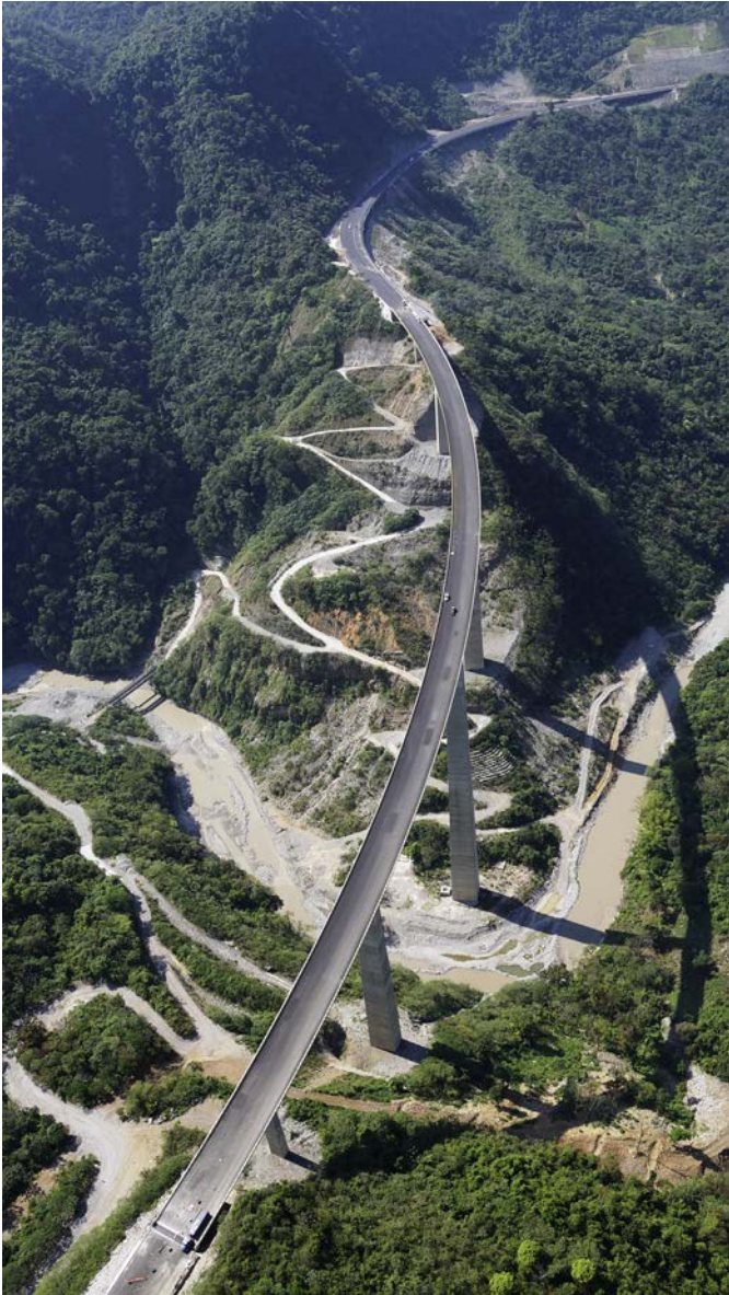
Figura 19. Vista general del camino de acceso al río por la ladera del lado México DF.
