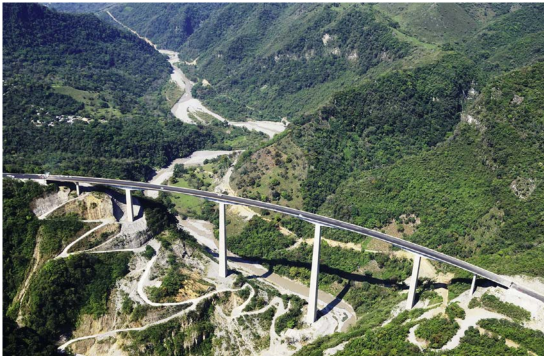
Figura 2. Vista general del puente.
