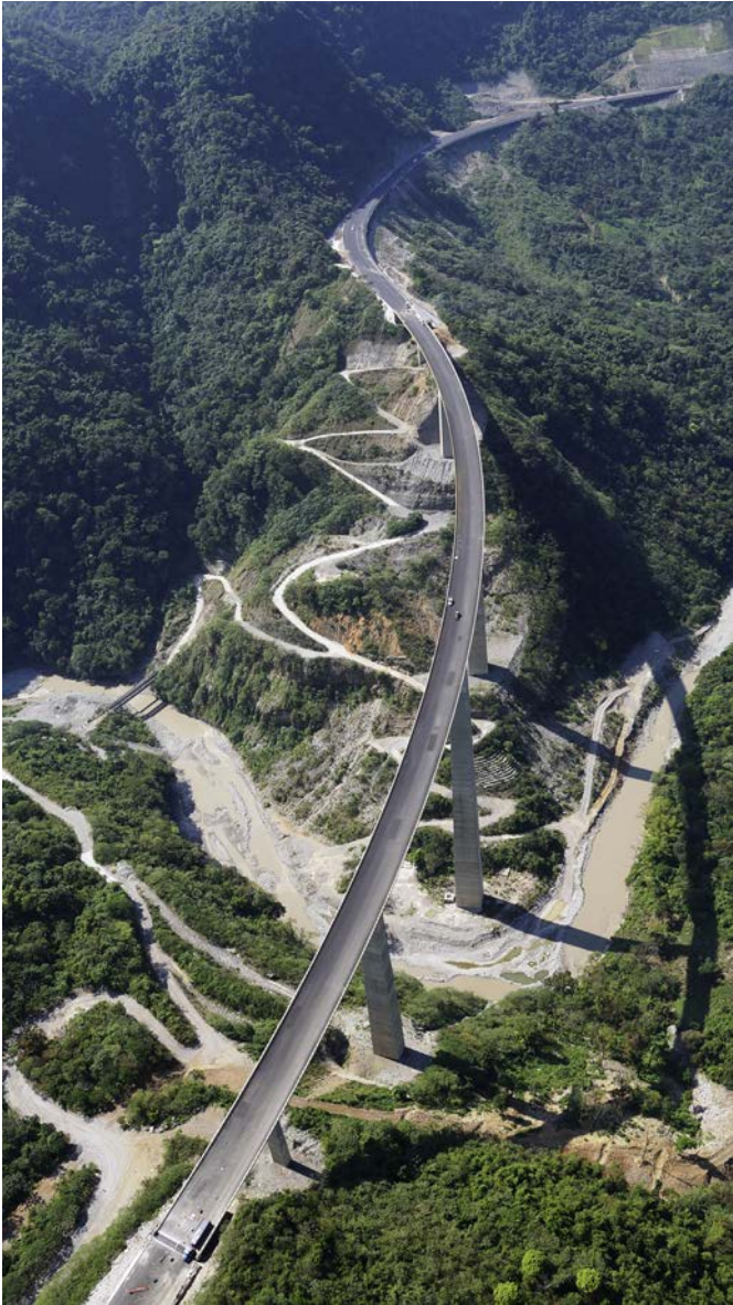
Figura 19. Vista general del camino de acceso al río por la ladera del lado México DF.
