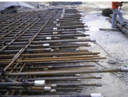
Figura 24. Premontaje de la armadura de las pilas.
