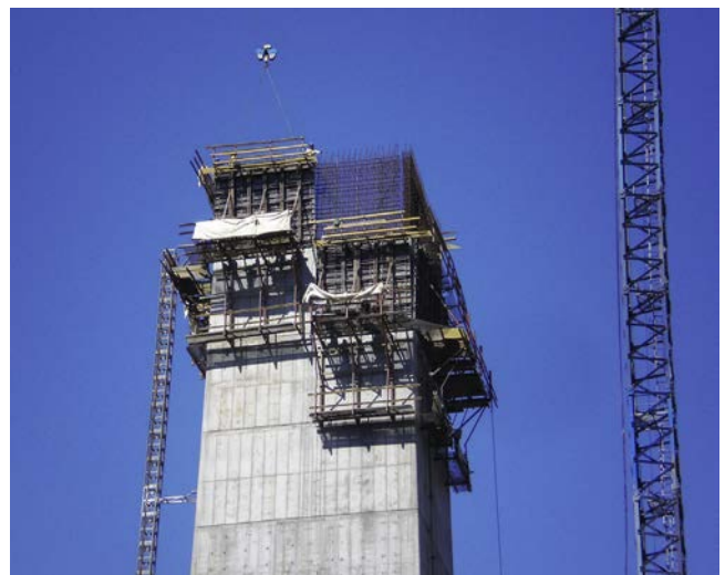
Figura 25. Encofrado trepante convencional en pilas 2, 3 y 5.
