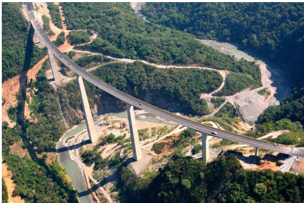
Figura 32. Vista general del puente terminado.
