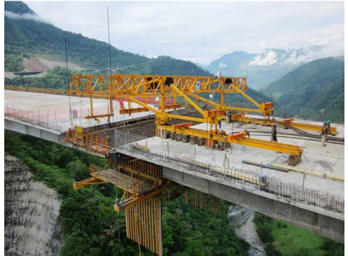
Figura 30. Cierre de un vano central.
