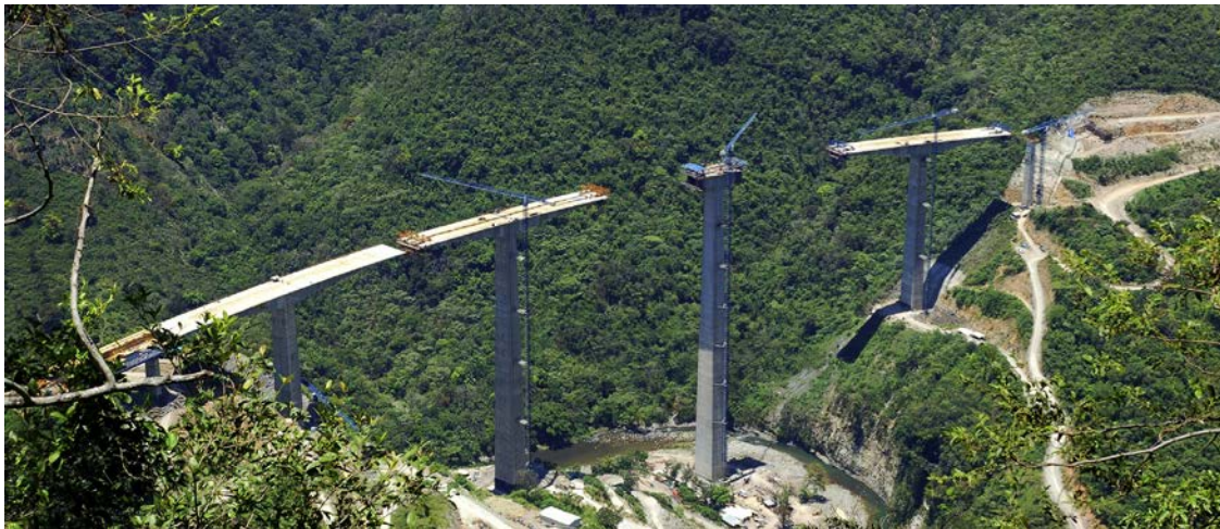
Figura 29. Trabajo simultáneo con 3 parejas de carros.
