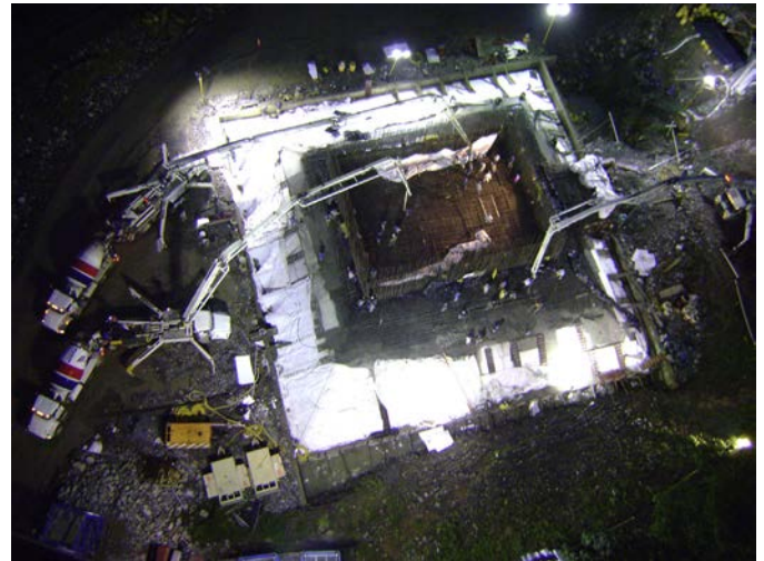
Figura 23. Hormigonado del encepado de la pila 4 en una fase.
