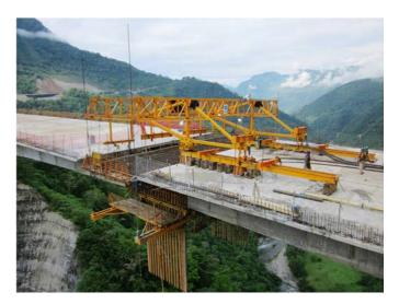
Figura 30. Cierre de un vano central.
