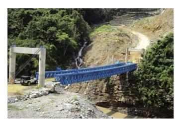
Figura 20. Puente auxiliar.
