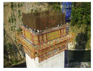
Figura 26. Encofrado autotrepante en pila 4.
