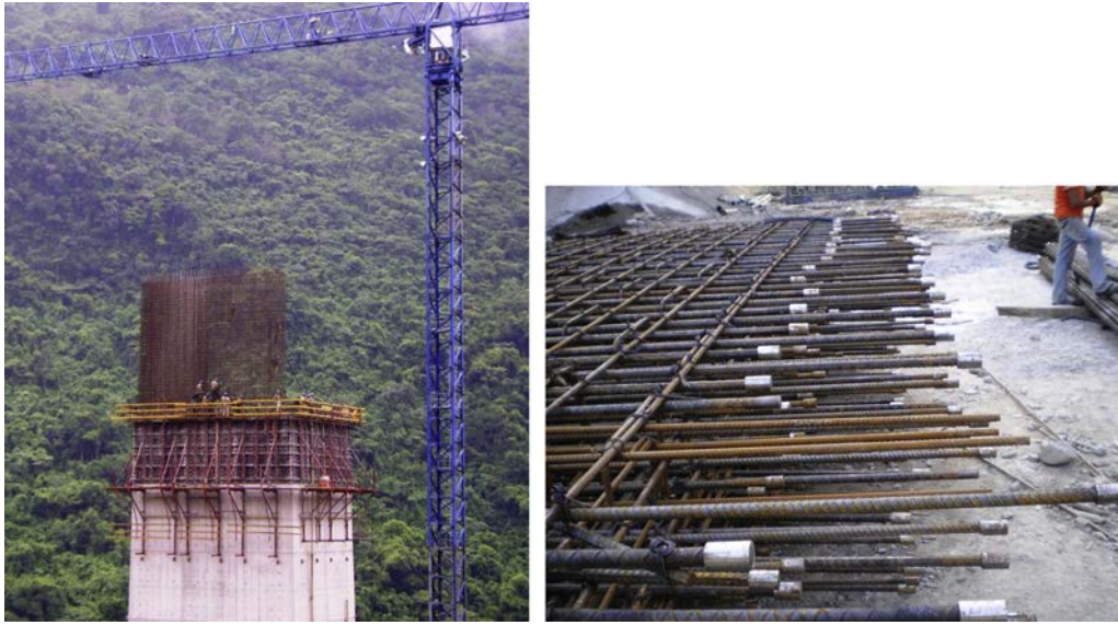
Figura 24. Premontaje de la armadura de las pilas.
