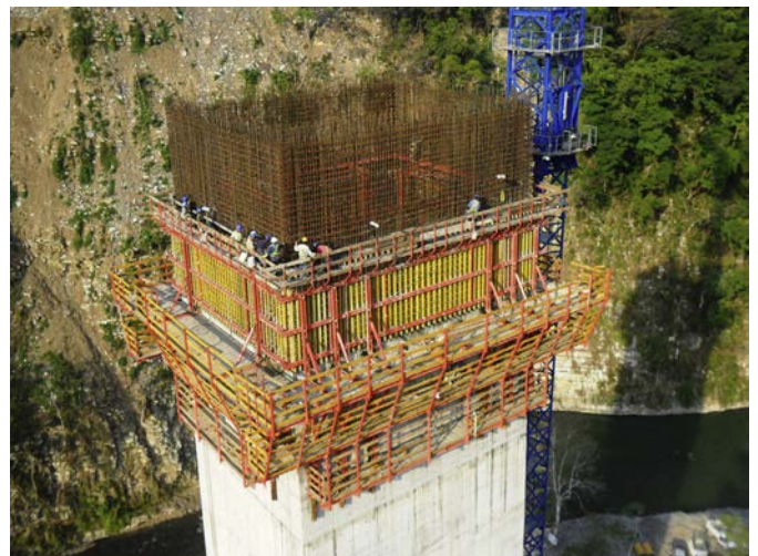
Figura 26. Encofrado autotrepante en pila 4.
