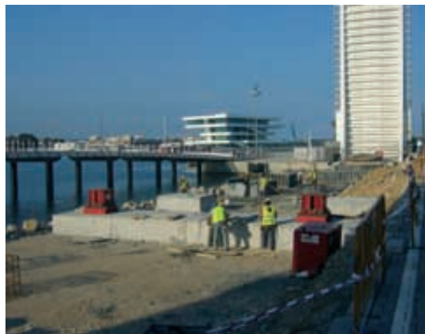
Figura 26. Ejecución de apeos sobre el relleno de la bocana. Figure 26. Fill at harbour neck to provide provisional shoring for the deck sections.
