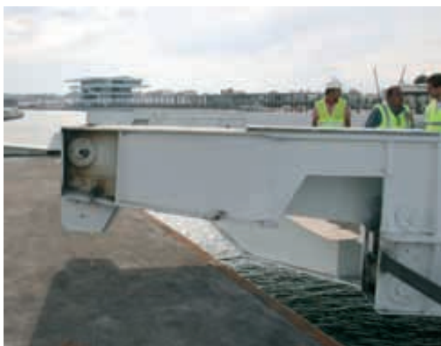
Figura 16. Hoja 2 "barriando" en el giro por encima de la hoja 1 basculada. Figure 16. Leaf 2 clearing tilted leaf 1.
