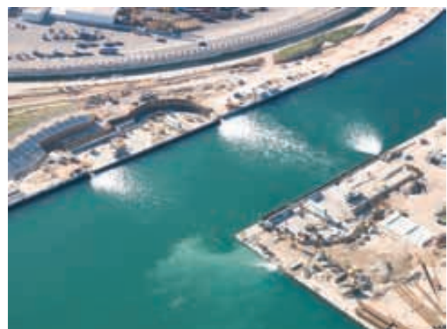
Figura 25. Vista general de los recintos durante su ejecución. Figure 25. Overview of the pits during construction
