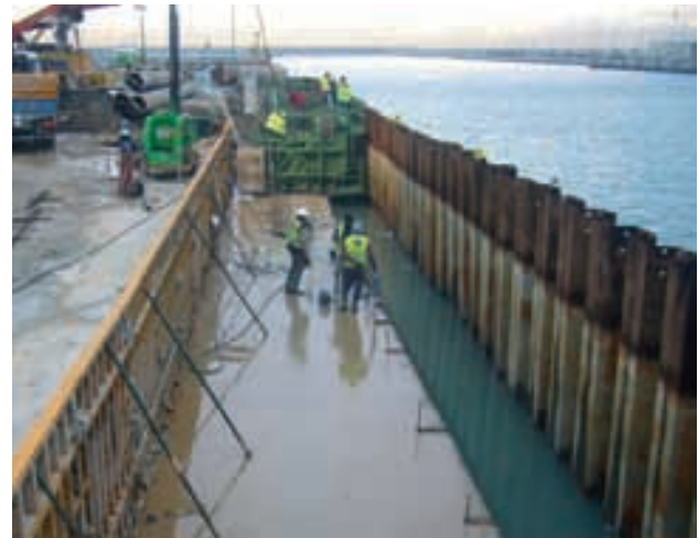
Figura 23. Ejecución del nuevo pretil del muelle Figure 23. Construction of the new guard rail for the pier.
