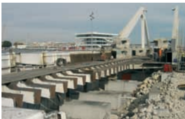
Figura 29 y 30. Cortes en estructura metálica del puente basculante. Figures 29 and 30. Splitting the steel structure on the bascule bridge.
