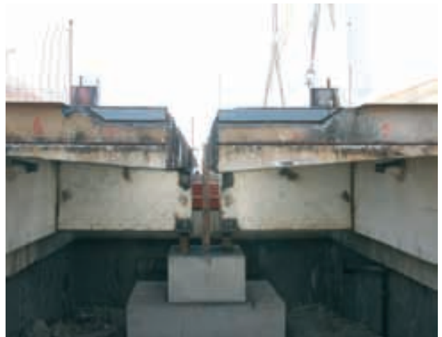
Figura 31. Corte en mamparo de giro. Figure 31. Splitting the hinge unit.
