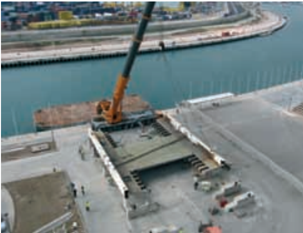
Figura 36. Traslado de los tramos de clave después del montaje en blanco.
