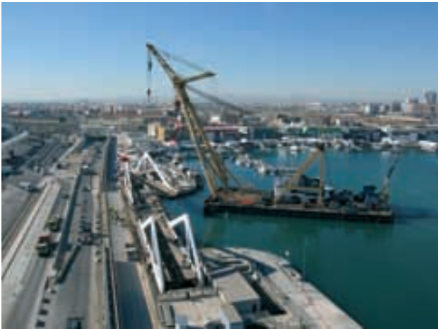
Figuras 32 y 33. Traslado con grúa flotante de las semihoja. Figures 32 and 33. Re-positioning of the half-laves with a floating crane.
