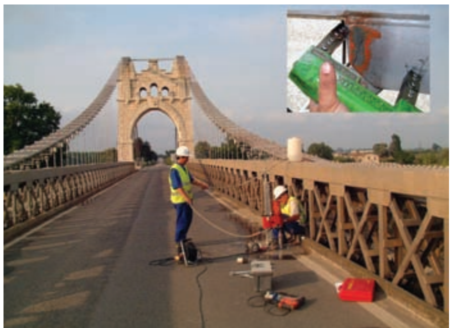
Figura 27. Extracción de testigos de la losa de hormigón y ensayo de partículas magnéticas. Figure 27. Core extraction from the concrete slab and detail of the magnetic particle test.
