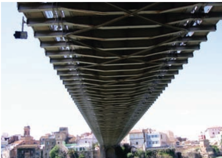
Figura 21. Parte inferior del tablero. Figure 21. Deck bottom.
