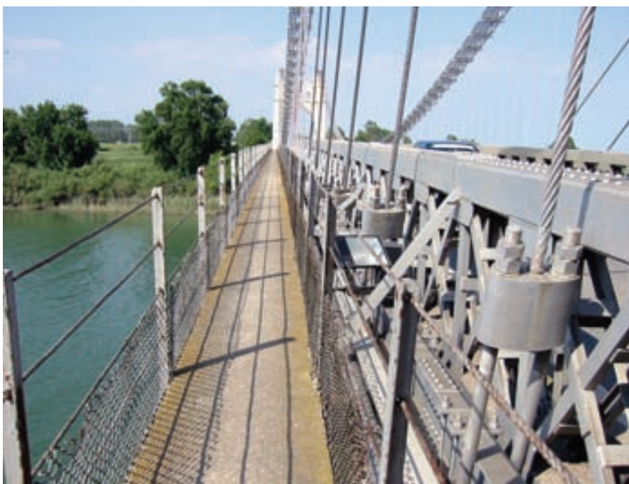
Figura 20. Acera. Figure 20. Sidewalk.
