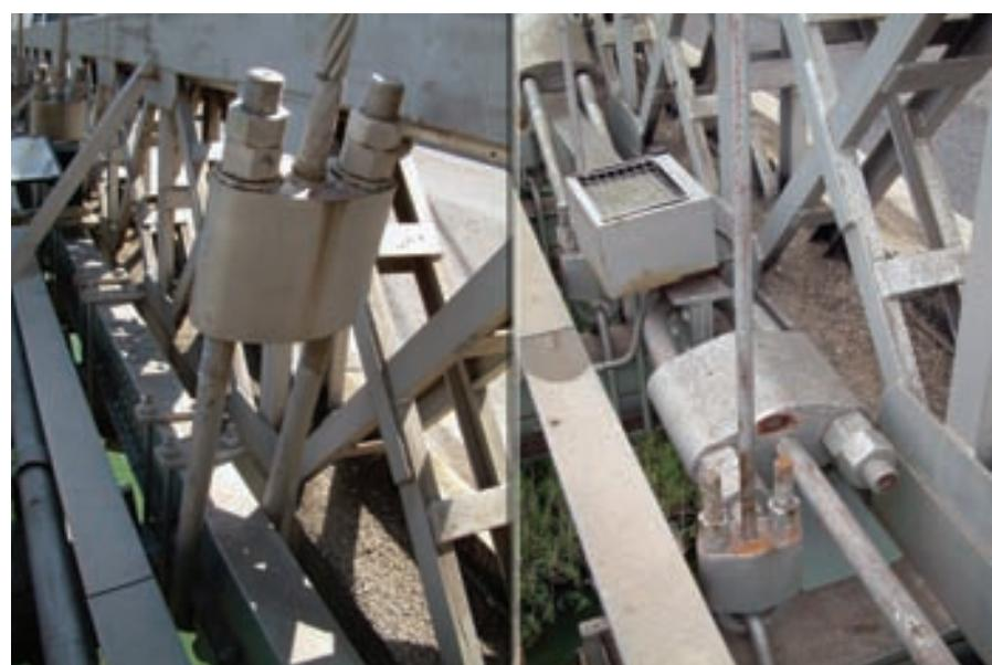
Figura 24. Anclajes del tirante inclinado y del cable horizontal.
