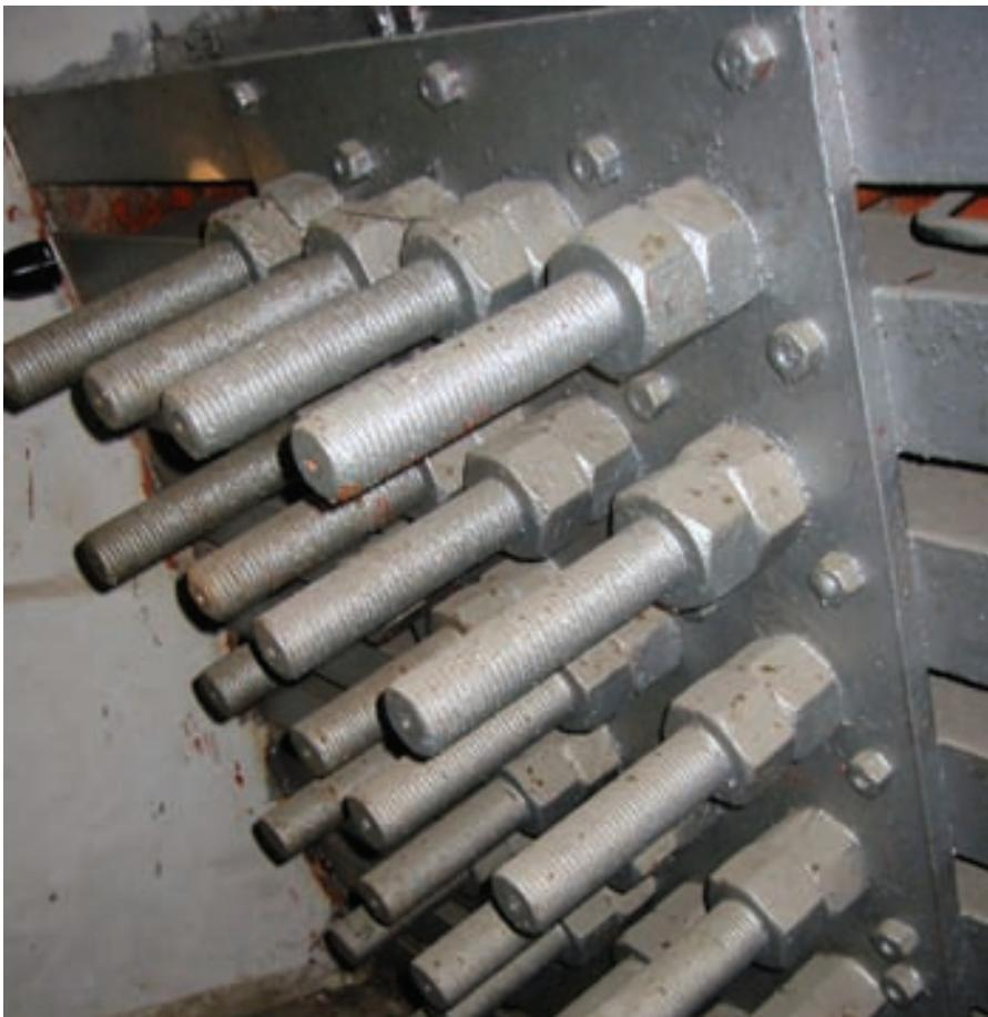
Figura 25. Detalle del emparrillado de anclaje.
