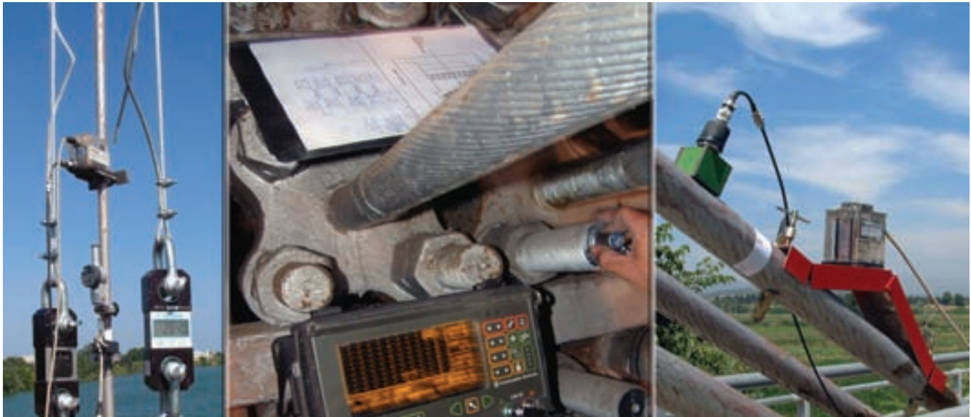
Figura 28. Ensayos: pesaje de una péndola, inspección por ultrasonidos y ensayo de cuerda vibrante. Figure 28. Tests: weighting a suspender, ultrasonic inspection and vibrating chord test.
