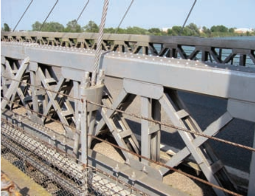
Figura 19. Viga de rigidez. Figure 19. Stiffening beam.
