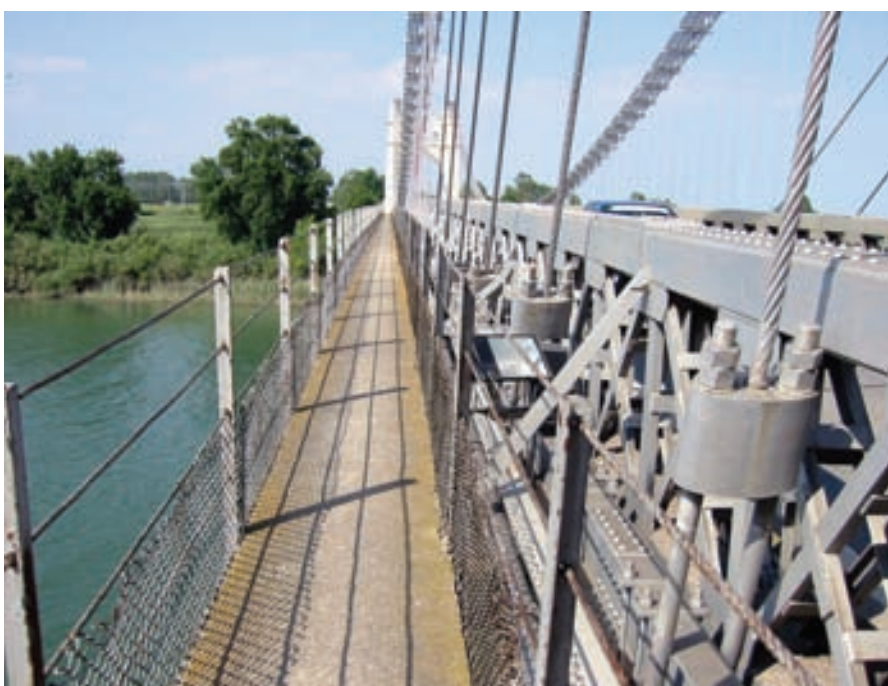
Figura 20. Acera. Figure 20. Sidewalk.
