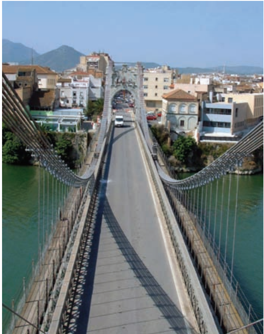
Figura 2. Vista del puente desde una de sus pilas. Figure 2. View of the bridge from one of its piers.
