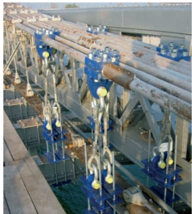
Figura 8. Péndolas provisionales cortas. Figure 8. Provisional short suspenders.
