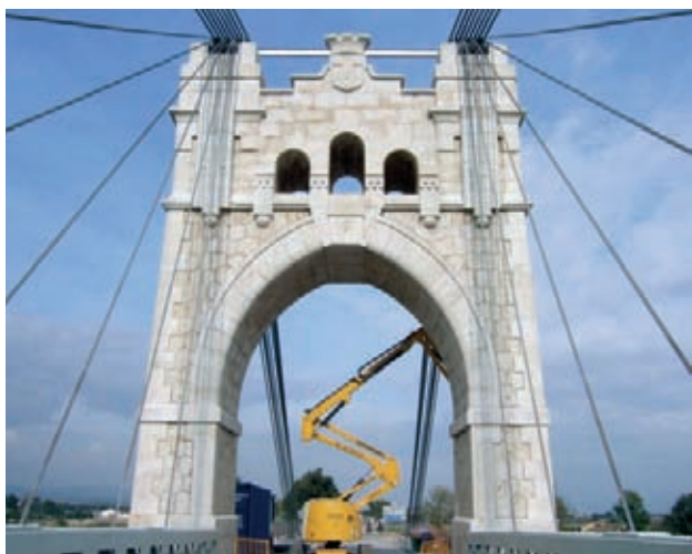
Figura 34. Pilono una vez rehabilitado. Figure 34. Rehabilitated pier.
