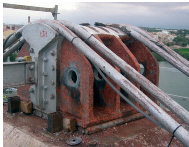
Figura 17. Una de las sillas durante la rehabilitación. Figure 17. Saddle during rehabilitation.
