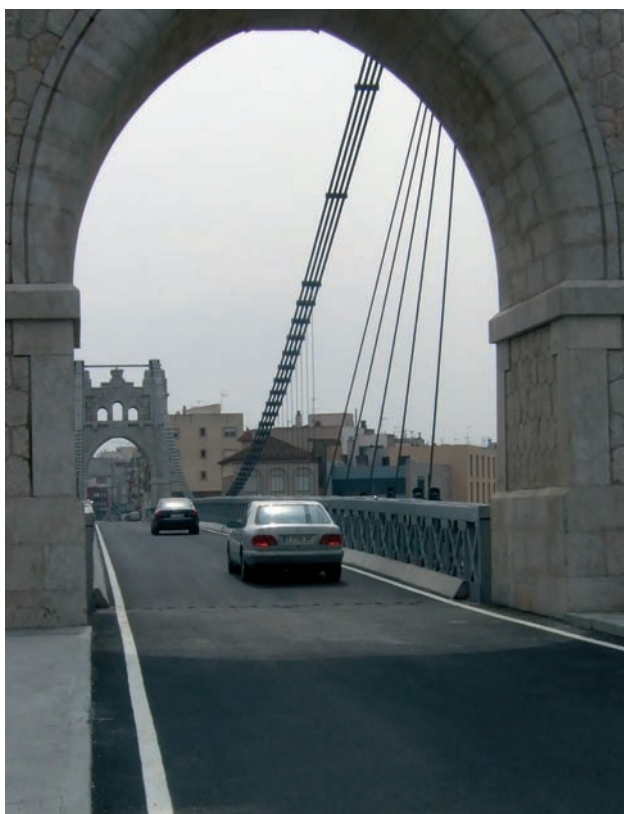
Figura 39. Tablero terminado. Figure 39. Finished deck.
