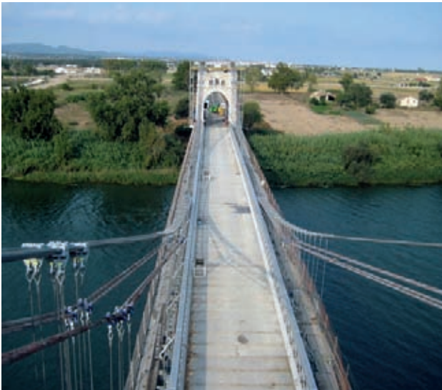
Figura 19. Cables durante la transferencia de cargas del sistema provisional al definitivo.
