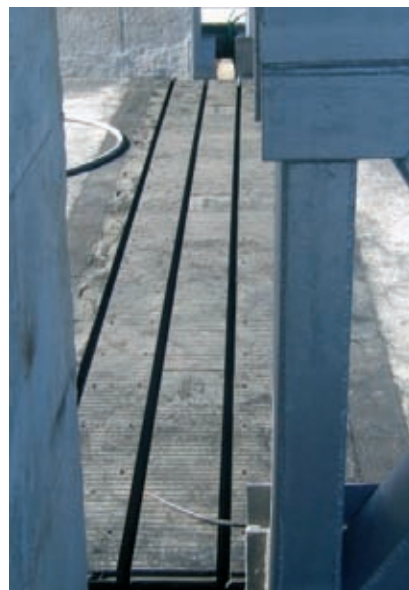
Figura 37. Junta de la calzada. Figure 37. Carriageway joint.
