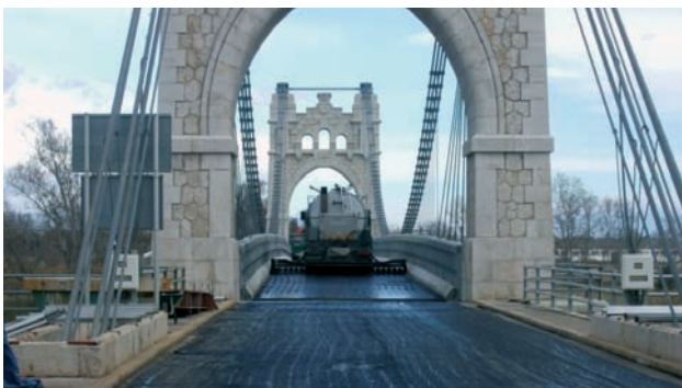
Figura 35. Trabajos de pavimentación. Figure 35. Paving operations.
