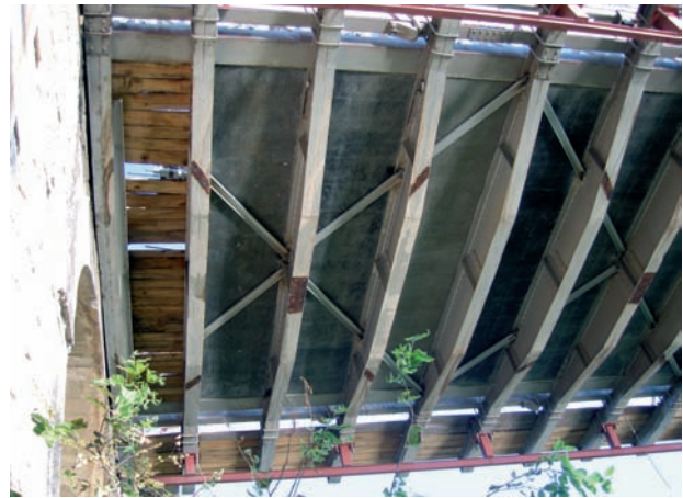
Figura 3. Colocación de nuevas Cruces de San Andrés sustitutas de las antiguas.
