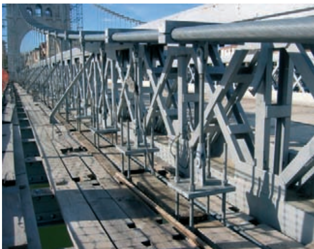
Figura 24. Nuevas péndolas y sus sistemas de unión. Figure 24. New suspenders and joining systems.
