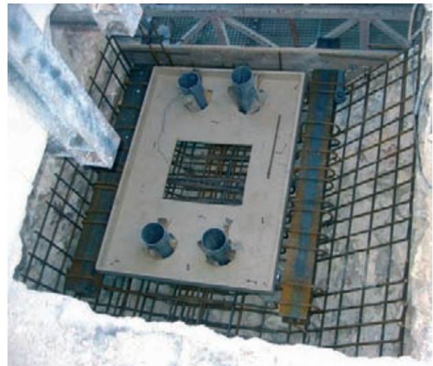
Figura 30. Interior de las cámaras de los apoyos durante su construcción.
