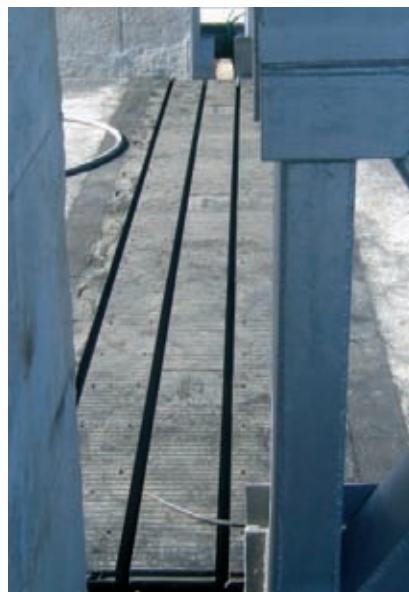
Figura 37. Junta de la calzada. Figure 37. Carriageway joint.
