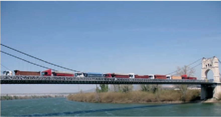
Figura 38. Prueba de carga. Figure 38. Load test.
