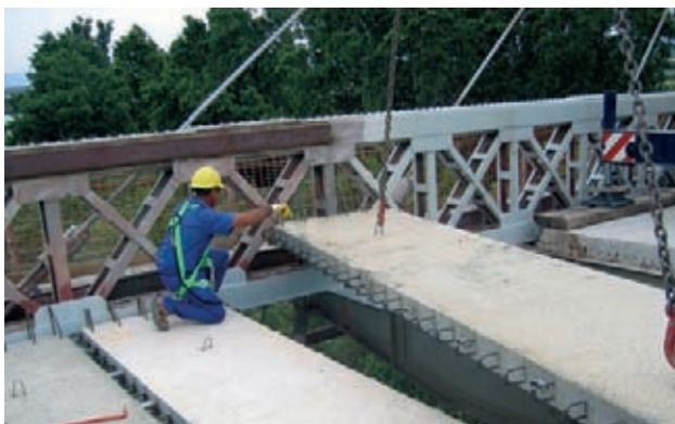
Figura 4. Colocación de la nueva losa, una vez demolida la existente.
