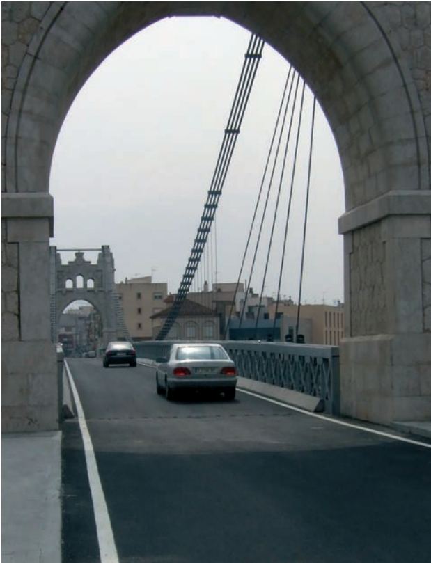
Figura 39. Tablero terminado. Figure 39. Finished deck.
