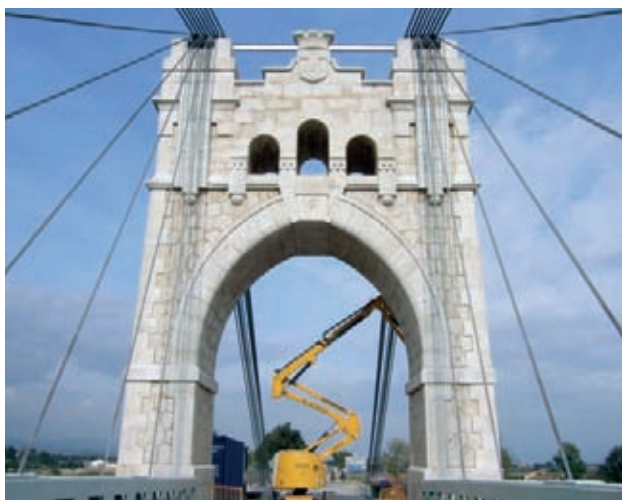
Figura 34. Pilono una vez rehabilitado. Figure 34. Rehabilitated pier.
