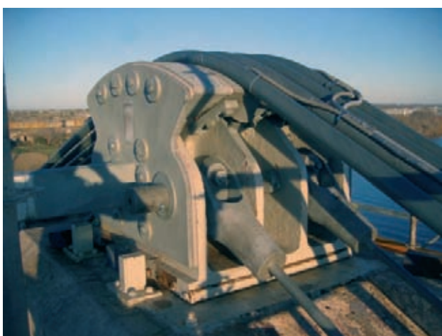
Figura 28. Una de las sillas rehabilitada, mostrando la cara de los terminales de cables de retenida.
