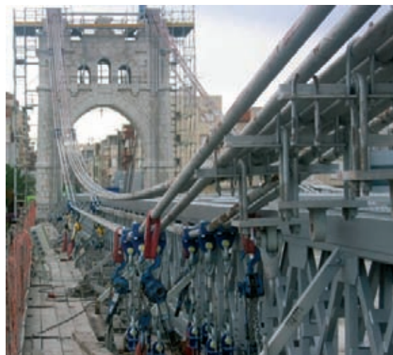
Figura 14. Retirada de péndolas con eslingas y polipastos.
