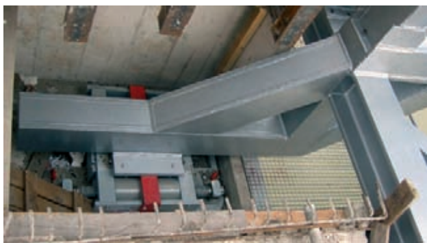
Figura 31. Apéndice metálico y aparato de apoyo POT con bloqueador. Figure 31. Steel appendix and POT bearing with lock-up device.
