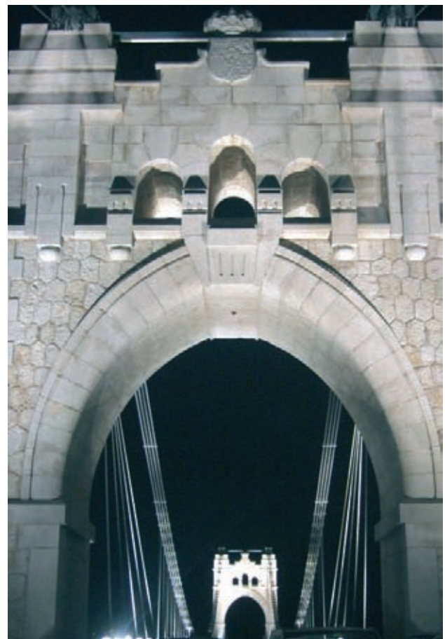
Figura 43. El puente con su iluminación monumental. Figure 43. Bridge with monumental lighting.
