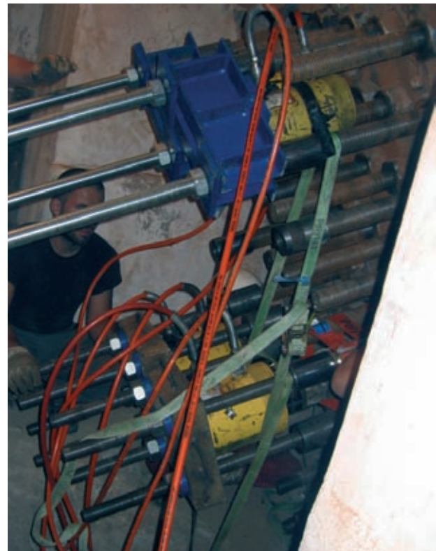
Figura 9. Tesado de cables desde las cámaras de anclaje. Figure 9. Tensioning cables from anchorage chambers.
