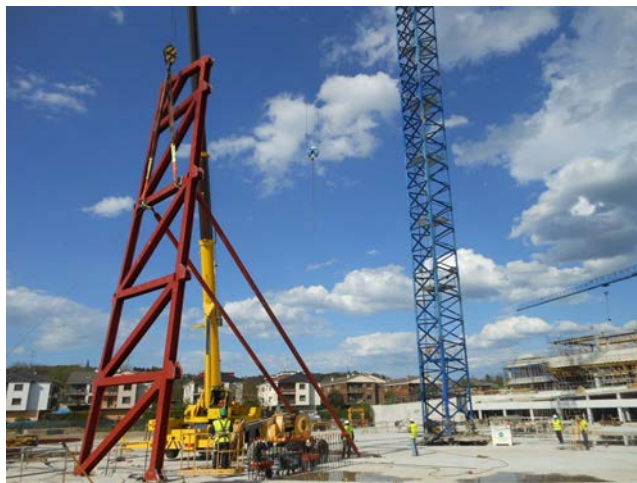
Figura 24. Montaje del primer paño de celosía. Obsérvense los puntales provisionales colocados para dotar a la estructura de estabilidad durante el proceso.
