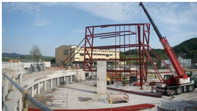
Figura 23. Montaje del primer sector de estructura en altura, compuesto por dos paños opuestos de celosía y las vigas y soportes intermedios.
