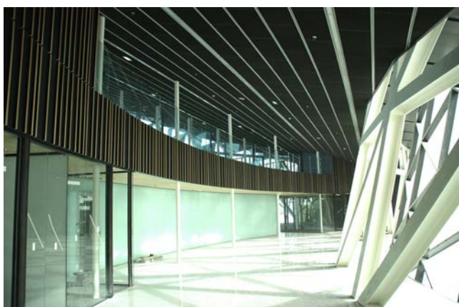
Figura 29. Vista del interior del edificio en la que puede apreciarse la celosía interior y las dos alineaciones de soportes interiores.
