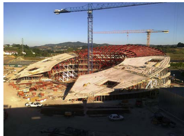
Figura 11. Ejecución del forjado de cubierta.
