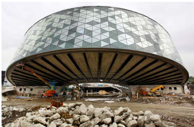
Figura 28. Vista frontal del edificio tras la colocación de la fachada.
