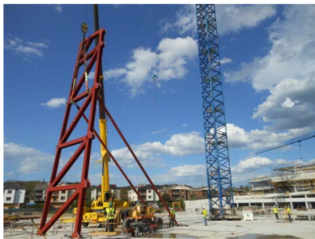
Figura 24. Montaje del primer paño de celosía. Obsérvense los puntales provisionales colocados para dotar a la estructura de estabilidad durante el proceso.
