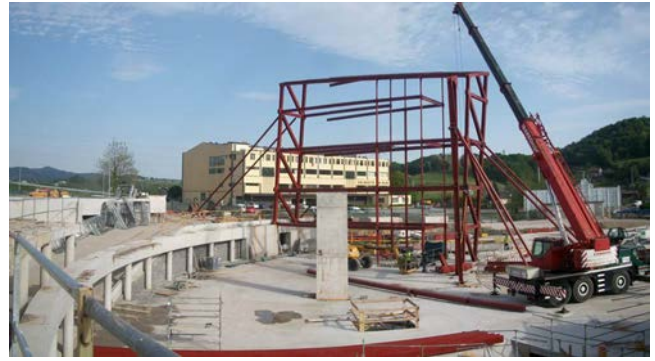
Figura 23. Montaje del primer sector de estructura en altura, compuesto por dos paños opuestos de celosía y las vigas y soportes intermedios.
