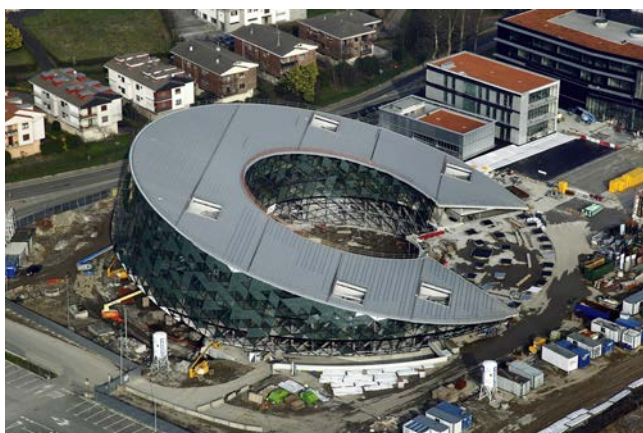
Figura 4. Vista superior de la cubierta.
