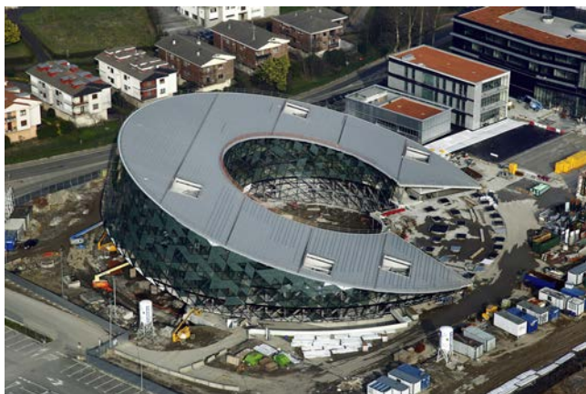
Figura 4. Vista superior de la cubierta.
