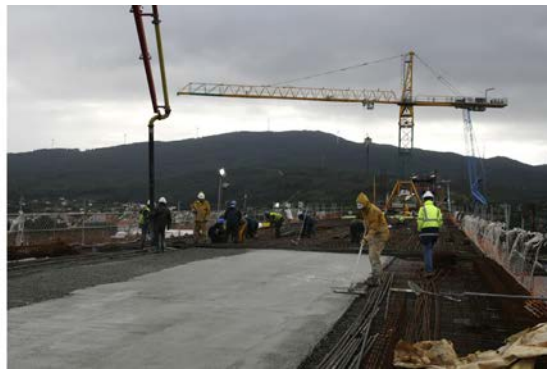
Figura 46. Colocación de prelasas de todo el ancho en el tablero y hormigonado de losa superior.
