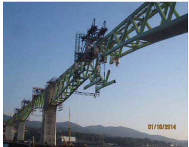
Figura 43. Izado de dovela de cierre del vano 8.
