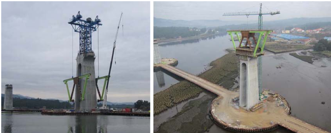
Figura 31. Izado de la dovela cero y ejecución de la cabeza de pila.
