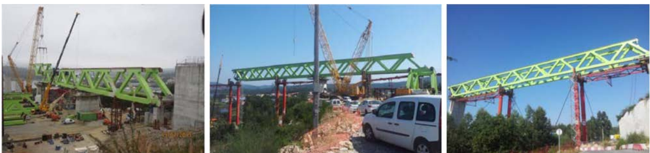
Figura 23. Izado de dovelas, imagen del primer lanzamiento y tramo lanzado entre P-2 y P-3.
