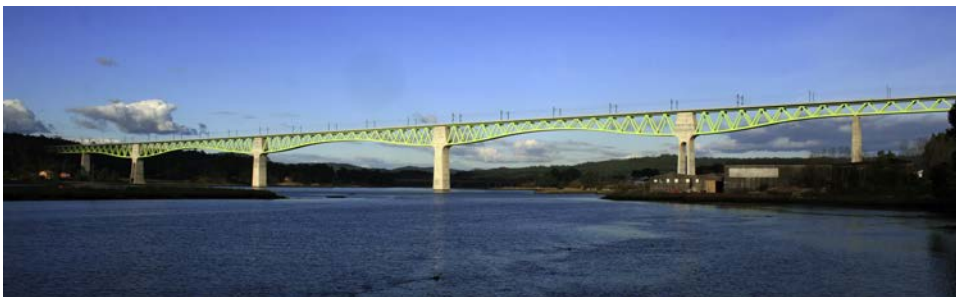
Figura 47. Vista del viaducto concluido.
