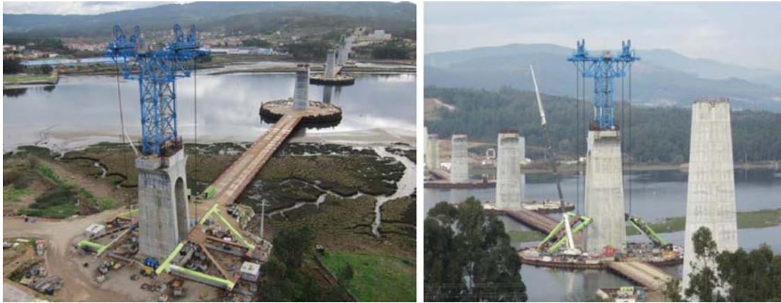
Figura 30. Ejecución de dovela cero en el pie de pila y operación de verticalizado.
