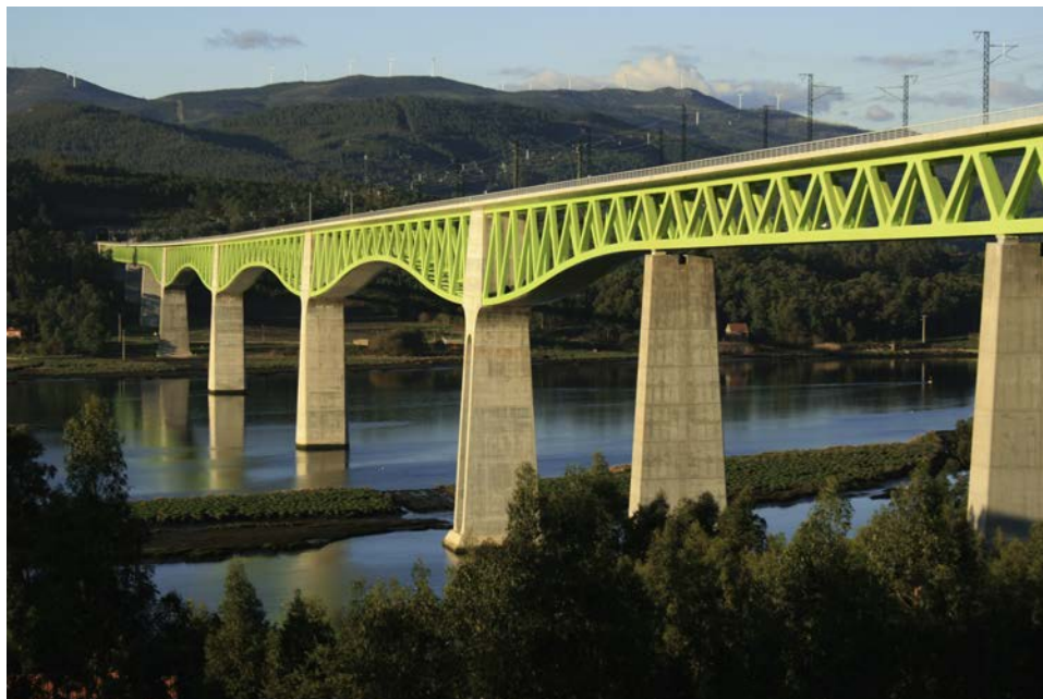
Figura 48. Vista lateral del viaducto concluido.
