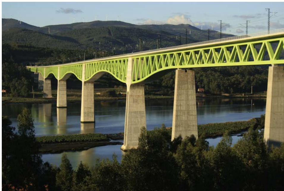
Figura 48. Vista lateral del viaducto concluido.
