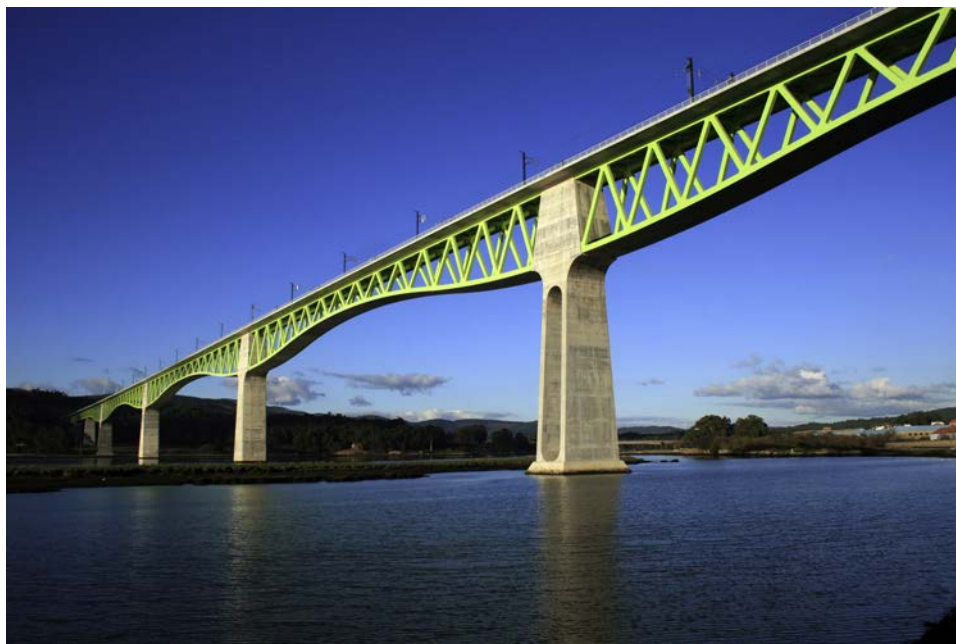
Figura 2. Imagen de los vanos de canto variable centrales del viaducto. Pila 5 en primer término.
