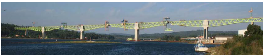
Figura 42. Izado de dovela de cierre del vano 6.
