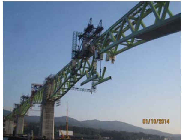
Figura 43. Izado de dovela de cierre del vano 8.
