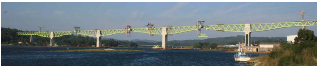
Figura 42. Izado de dovela de cierre del vano 6.
