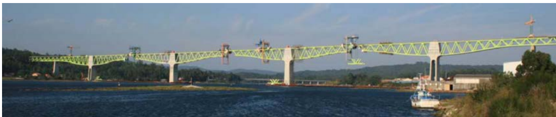
Figura 42. Izado de dovela de cierre del vano 6.
