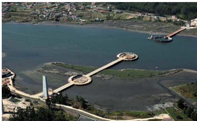
Figura 5. Vista del pantalán y los recintos de las cimentaciones de las pilas P-5, P-6 y P-7 en el cauce.
