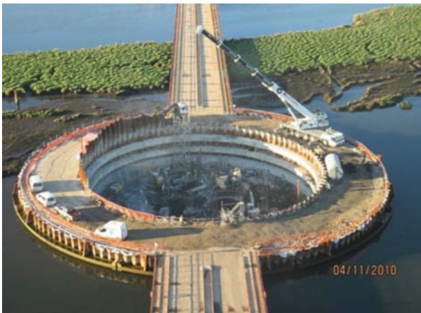
Figura 8. Excavación del interior del recinto de P-5.
