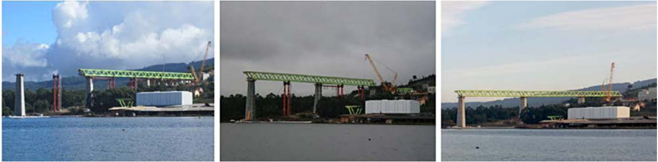
Figura 24. Segunda fase de lanzamiento, tramo de 240 m ya lanzado entre P-3 y P-4 y ejecución de fase 3.
