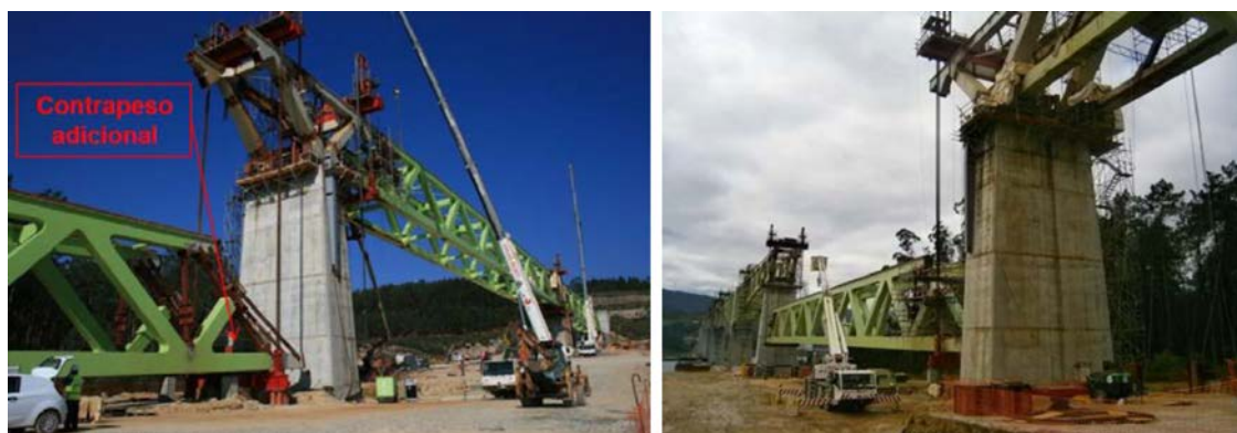
Figura 28. Secuencia del proceso de izado del vano 11 y 10, respectivamente.
