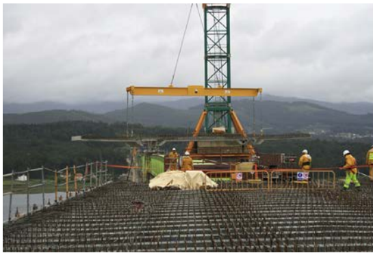
Figura 46. Colocación de prelasas de todo el ancho en el tablero y hormigonado de losa superior.
