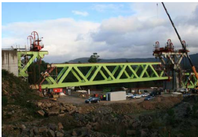
Figura 27. Secuencia del proceso de izado del vano lateral 12 entre el E-2 y la P-11. Izado de unas 465 t.
