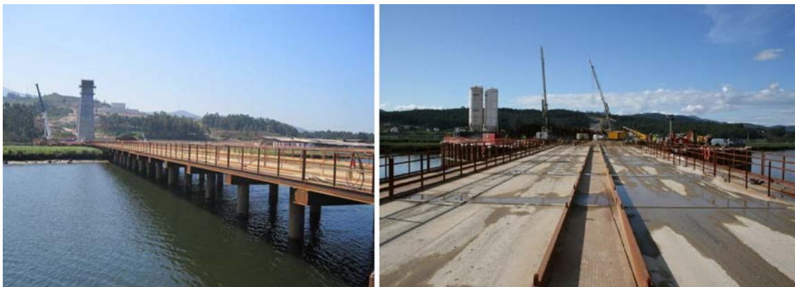
Figura 6. Vistas del pantalán de acceso a las cimentaciones de las pilas P-5, P-6 y P-7.
