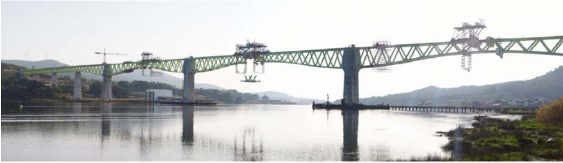
Figura 44. Izado de dovela de cierre del vano 7.
