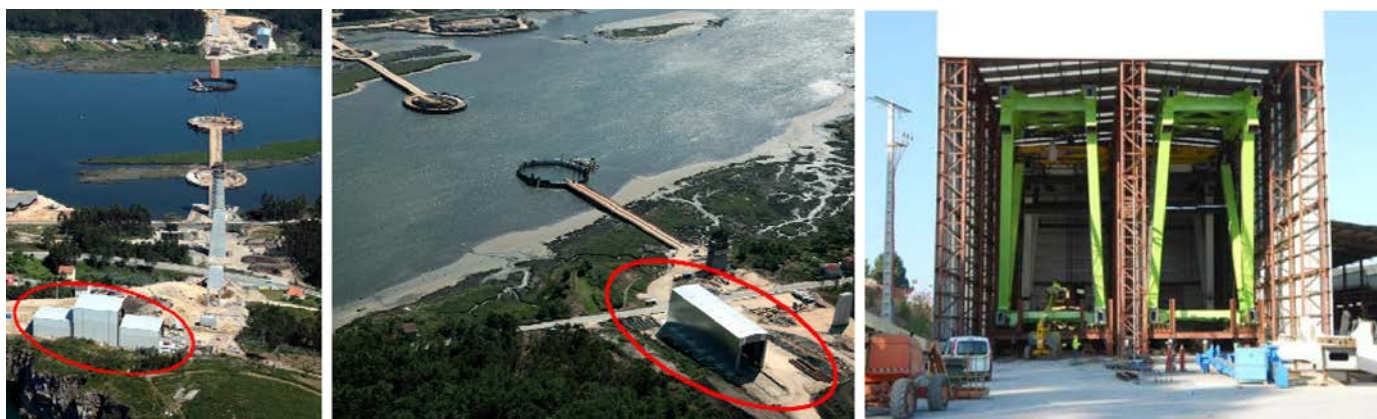
Figura 14. Talleres de obra para ensamblaje de dovelas.
