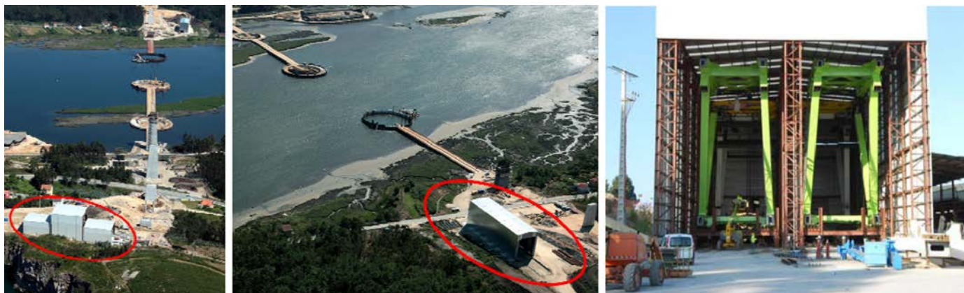
Figura 14. Talleres de obra para ensamblaje de dovelas.
