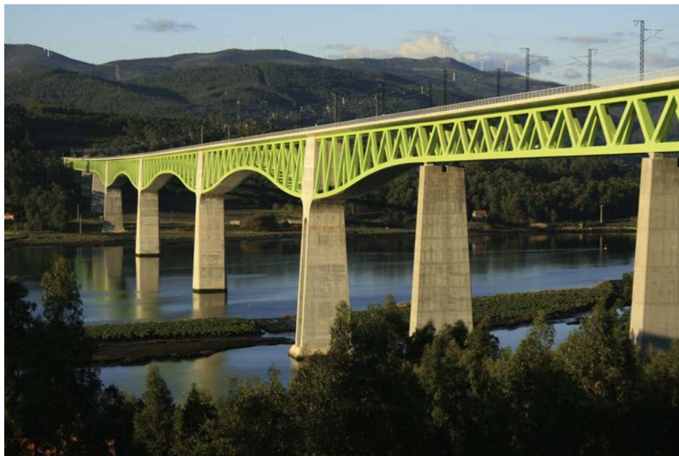
Figura 48. Vista lateral del viaducto concluido.
