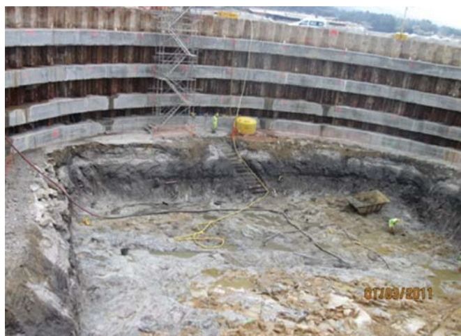
Figura 11. Vista del fondo rocoso de P-7 previo hormigón de limpieza (27 × 24 × 5,25 m).
