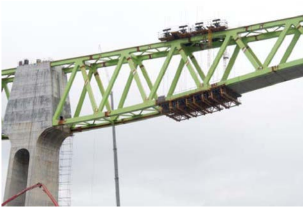
Figura 45. Vista del carro de encofrado del hormigón de fondo.
