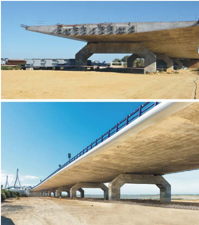
Figura 32. Vista del viaducto de acceso lado Puerto Real, canto 2,00 m.
