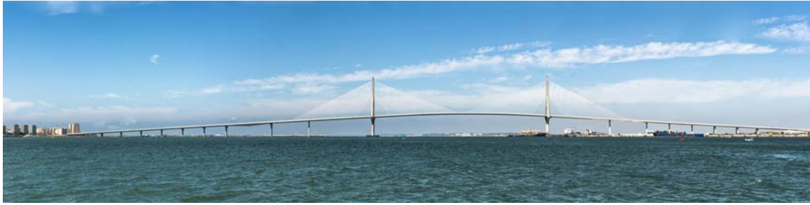
Figura 6. Vista general del puente.
