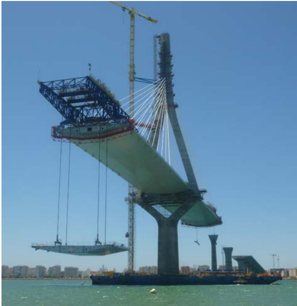
Figura 6. Operación de izado de una dovela típica.
