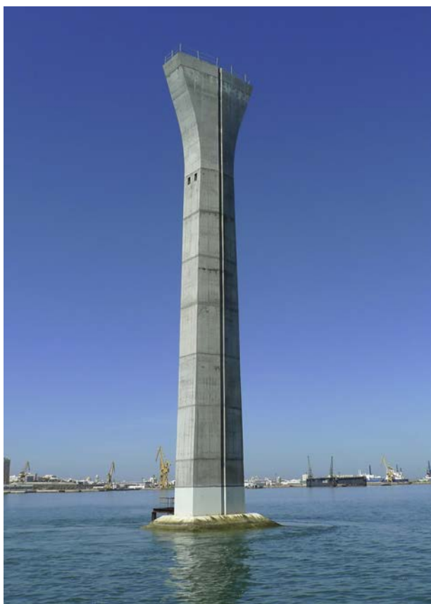
Figura 15. Fuste de las pilas.
