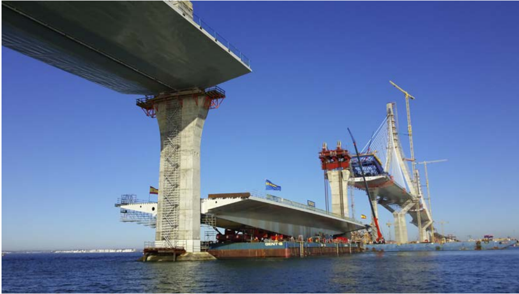
Figura 9. Vista del puente desmontable previa a la operación de izado.
