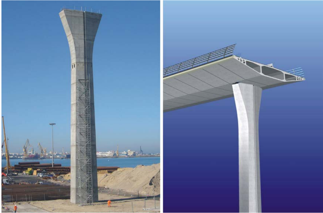
Figura 29. Vista del viaducto de acceso al lado de Puerto Real, canto 3,00 m.
