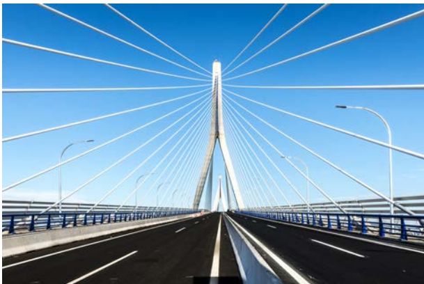
Figura 7. Fuste superior de la torre.
