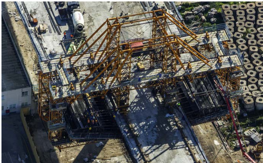
Figura 4. Tablero de hormigón. Carro de encofrado de segunda fase.
