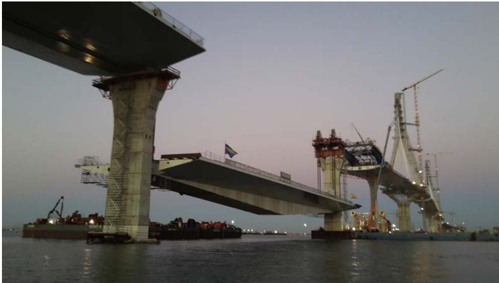
Figura 18. Izado del tramo desmontable.
