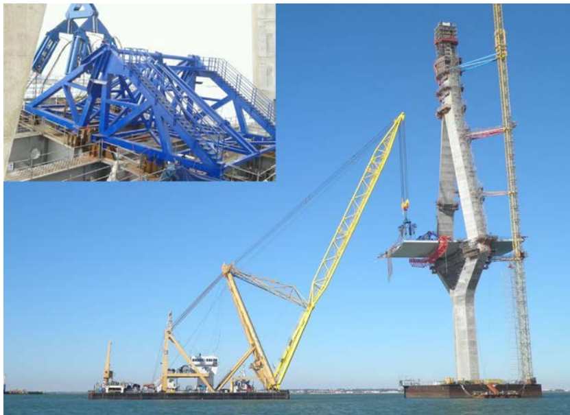
Figura 10. Elemento especial para colocación de dovelas iniciales.
