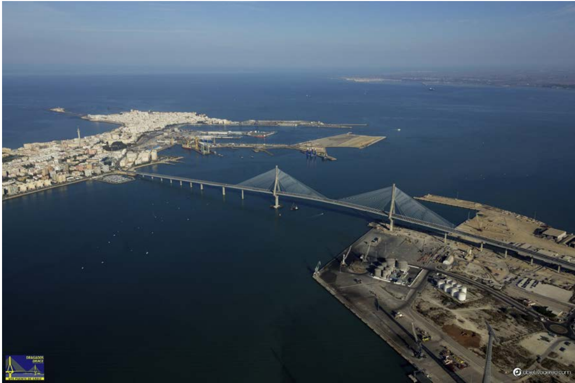
Figura 1. Vista general. Fuente: DRAGADOS UTE.
