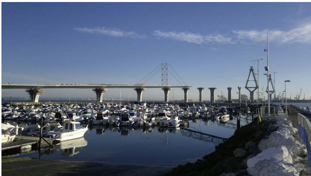
Figura 5. Puente de acceso desde Cádiz. Proceso de empuje de la parte metálica.
