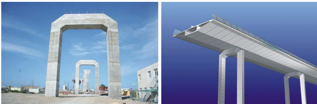
Figura 30. Pilas dobles por presencia de calzada bajo el tablero.
