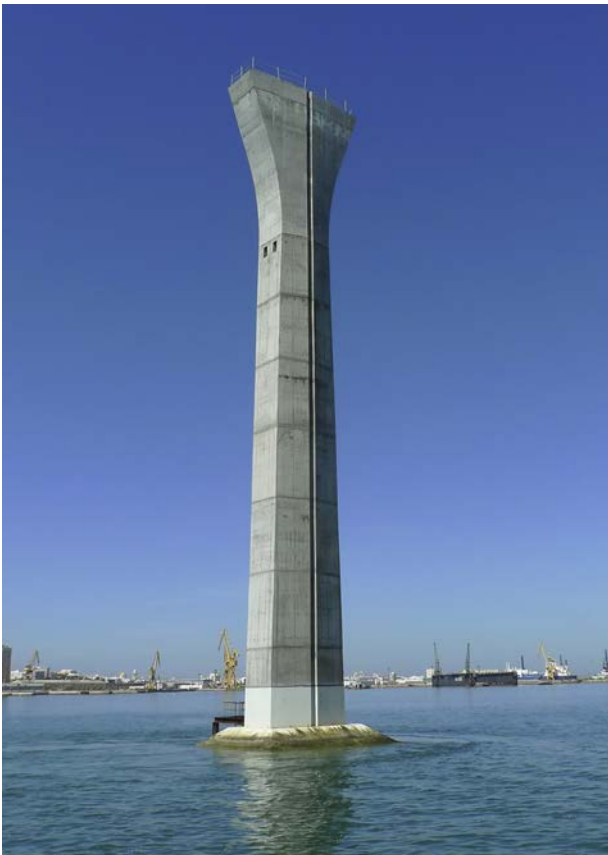
Figura 15. Fuste de las pilas.
