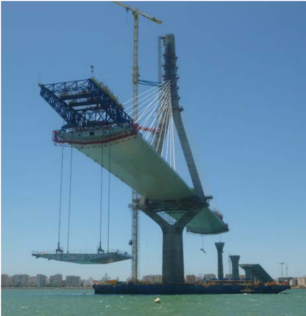
Figura 6. Operación de izado de una dovela típica.
