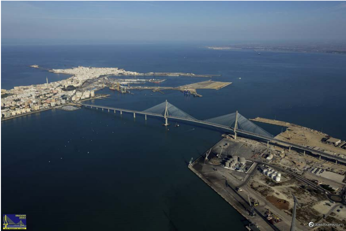
Figura 1. Vista general. Fuente: DRAGADOS UTE.
