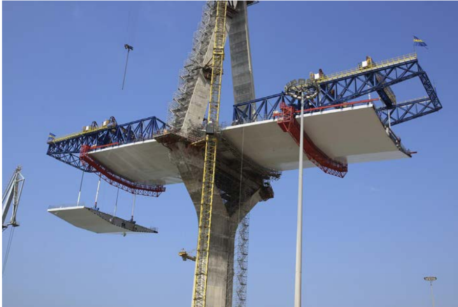
Figura 10. Izado de dovela antes de la llegada a los primeros tirantes.
