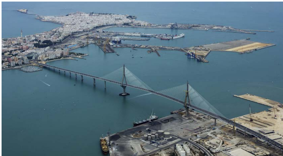
Figura 13. Vista general del puente.
