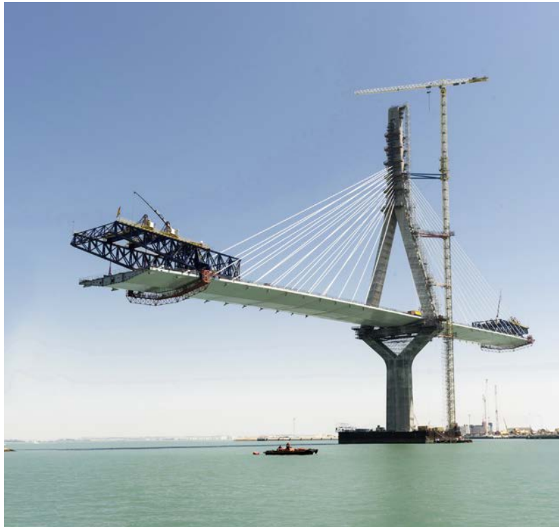
Figura 26. Construcción por avance en voladizo simétrico.
