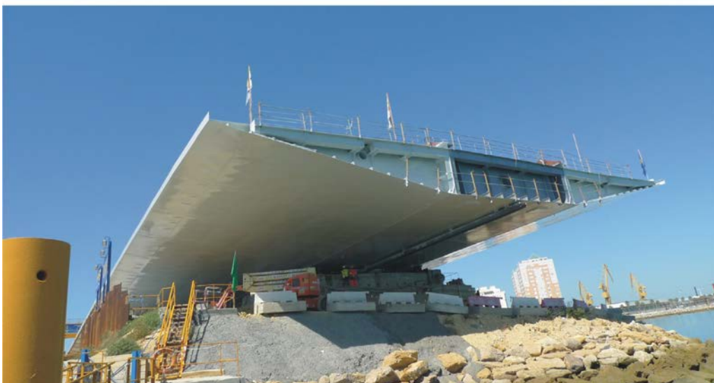
Figura 11. Sección transversal del viaducto de acceso al lado de Cádiz.
