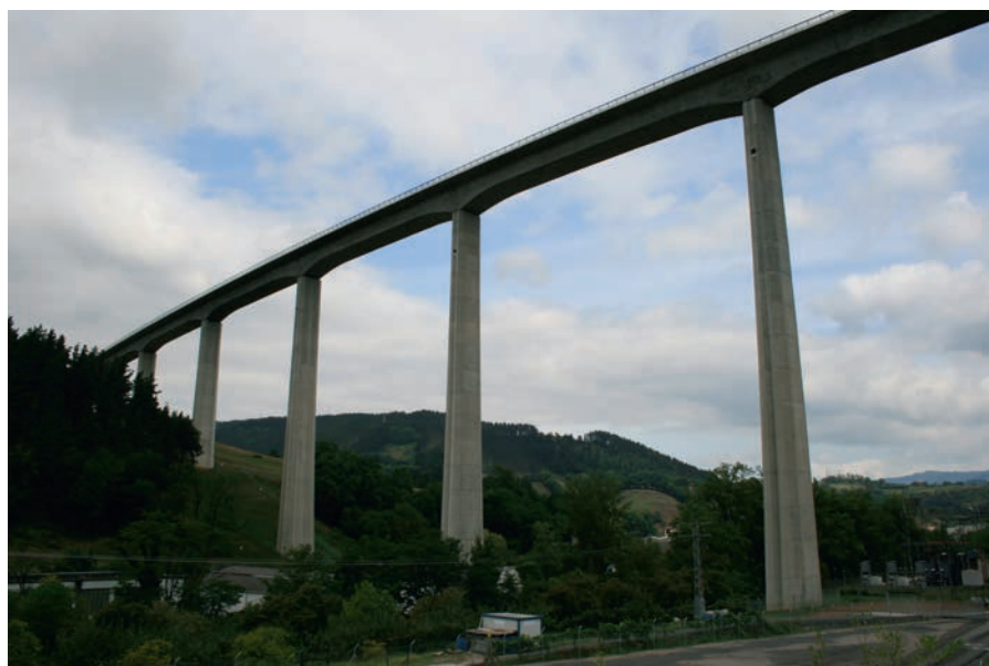
Figura 44. Imagen del viaducto concluido.
