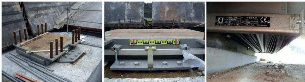
Figura 13. Vista de un apoyo, sistema de medición con regleta y protección guardapolvo.
