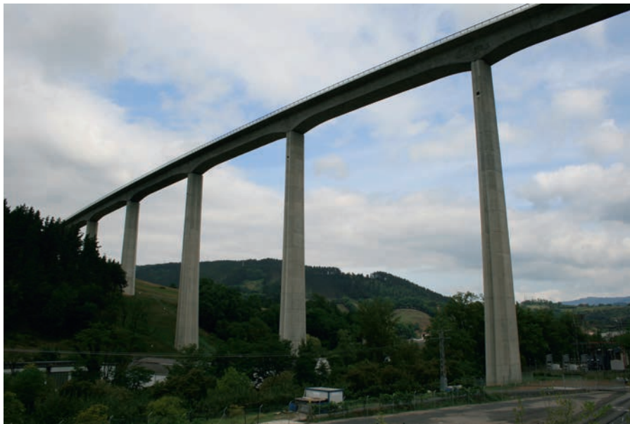
Figura 44. Imagen del viaducto concluido.
