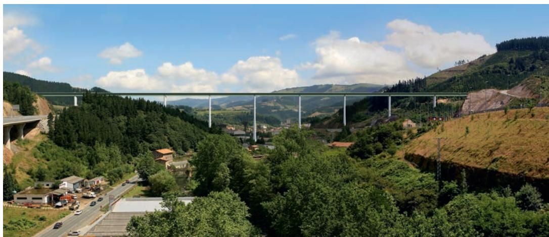
Figura 8. Fotomontaje del viaducto en la solución mixta con alma llena empujada.
