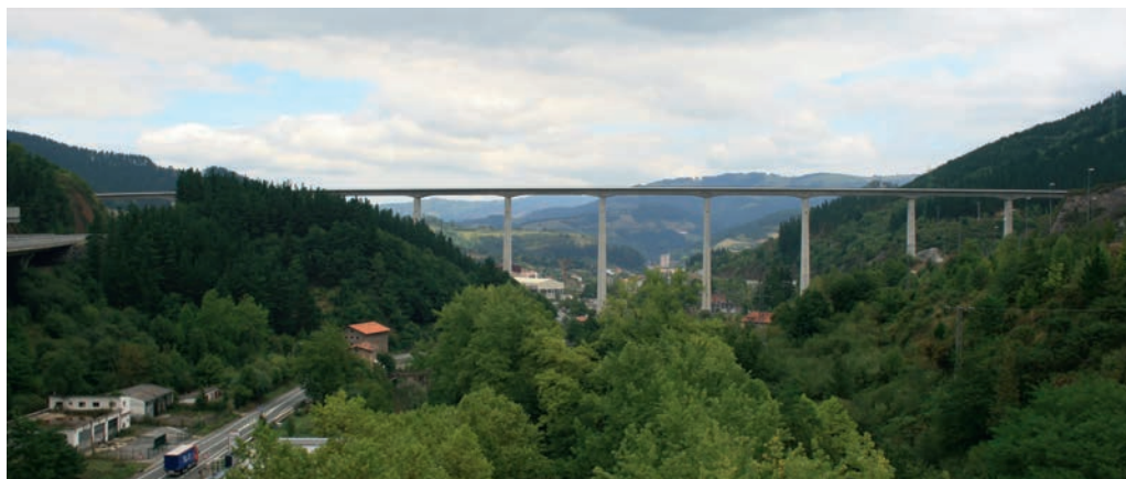
Figura 11. Imagen del viaducto construido de hormigón pretensado.
