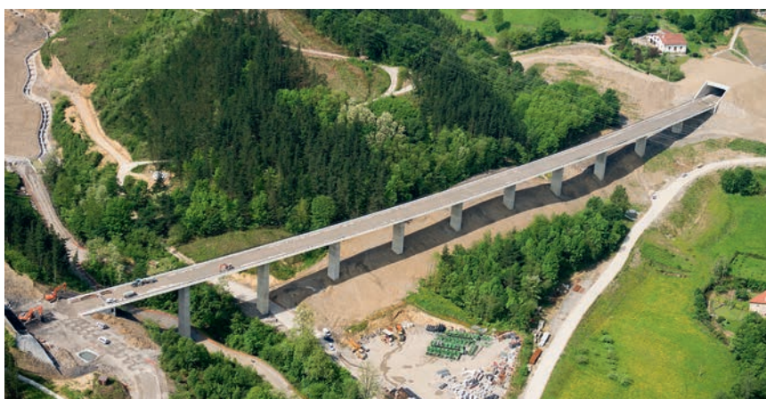
Figura 2. Imagen del viaducto de Lamiategui.
