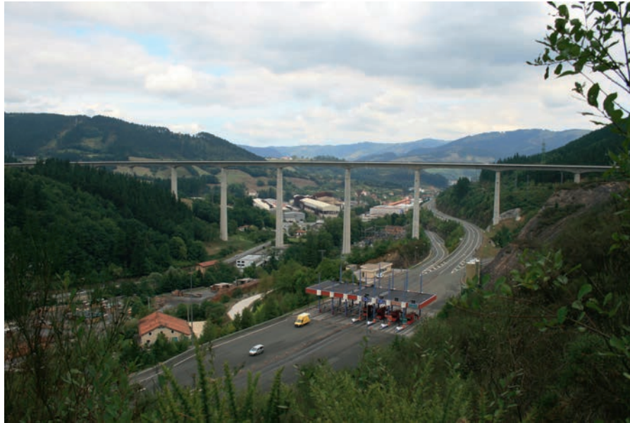
Figura 45. Imagen del viaducto concluido.
