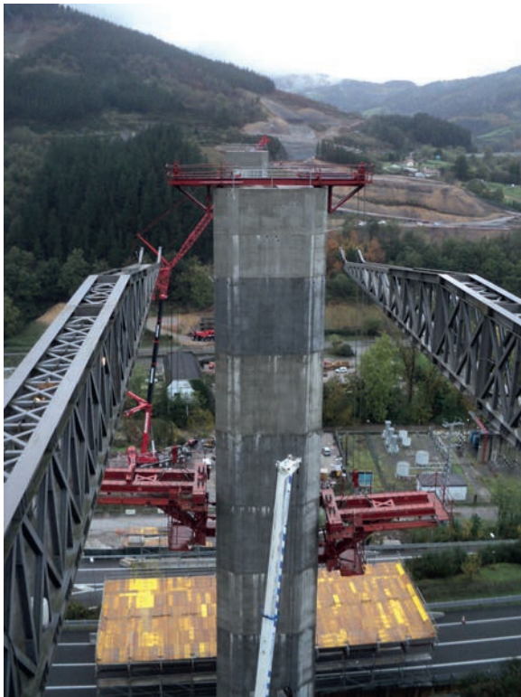
Figura 31. Izado de las ménsulas del anillo de apoyo de la autocimbra.
