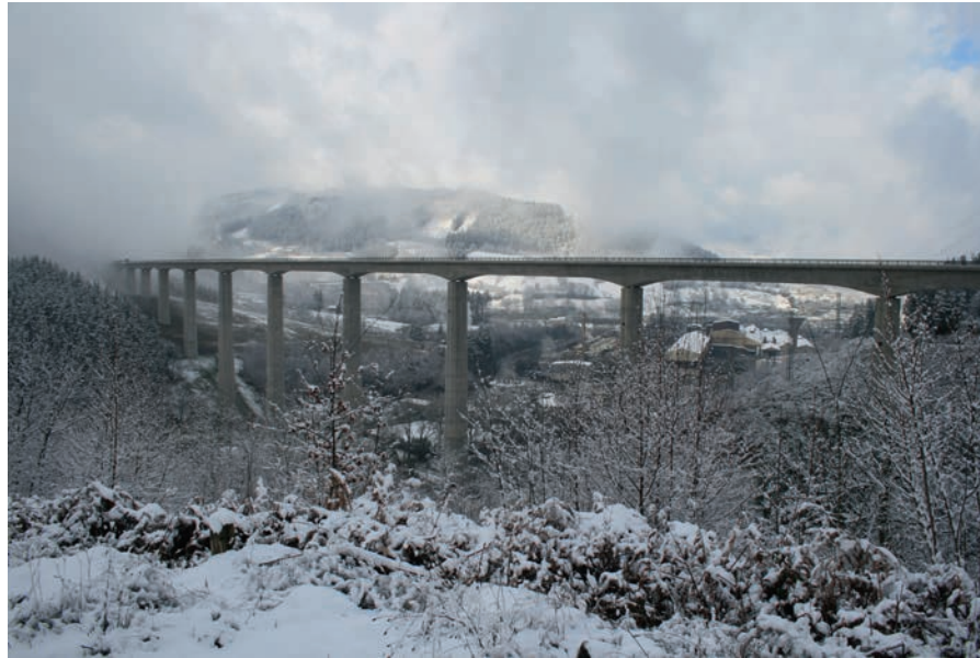
Figura 43. Imagen del viaducto durante la prueba de carga con camiones (4 de febrero de 2015).
