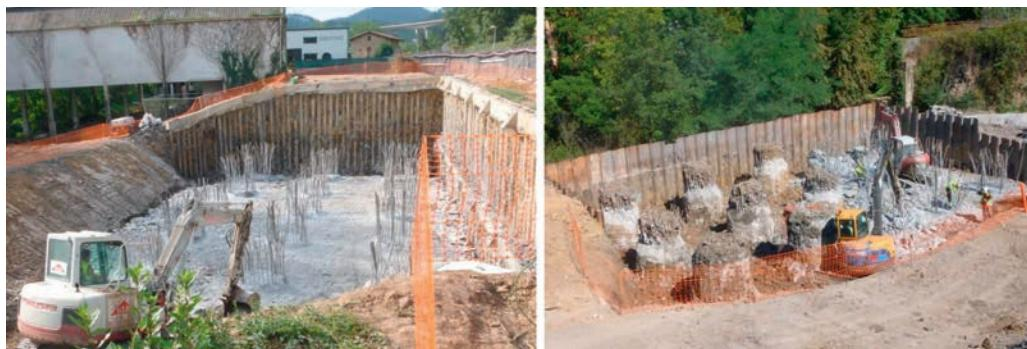
Figura 16. Pantallas de micropilotes anclados en la contención de la cimentación de la P-7 (imagen izquierda) y pantallas de tablestacas en la cimentación pilotada de P-8.
