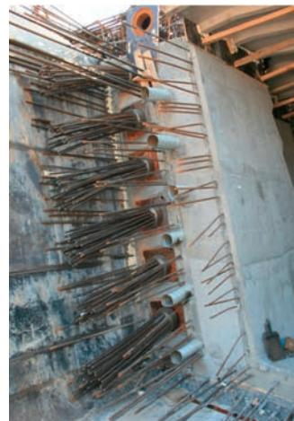
Figura 28. Anclajes de tendones de continuidad, con cruce de cables: anclajes activos en frente de fase y anclajes pasivos.
