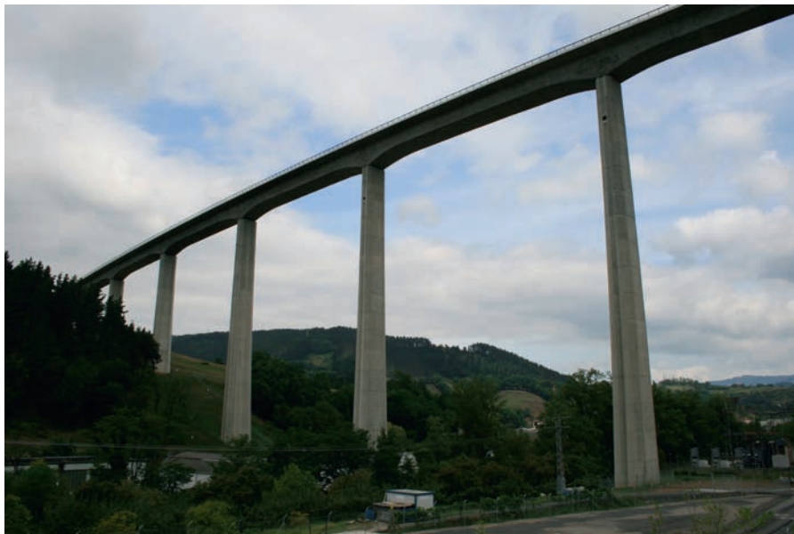
Figura 44. Imagen del viaducto concluido.
