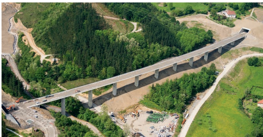
Figura 2. Imagen del viaducto de Lamiategui.
