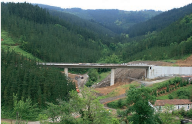
Figura 4. Imagen del viaducto sobre el arroyo de Olzaileko.
