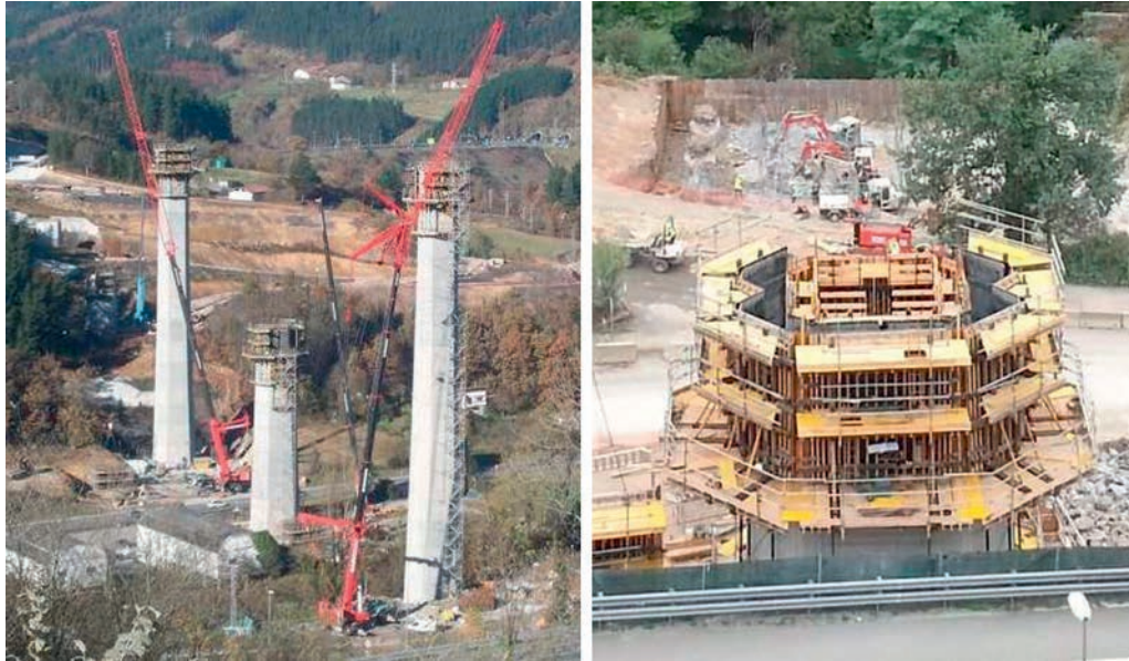
Figura 18. Vista general y de detalle de la ejecución de las trepas del fuste de las pilas.
