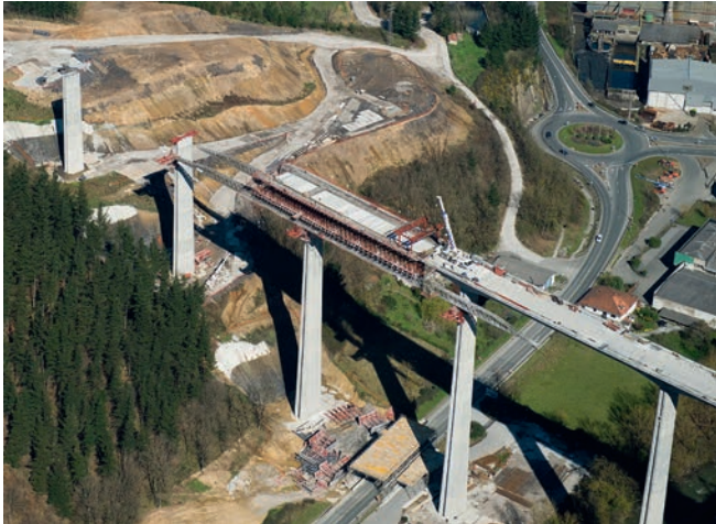
Figura 23. Colocación de prelosas sobre la sección artesa previamente hormigonada.
