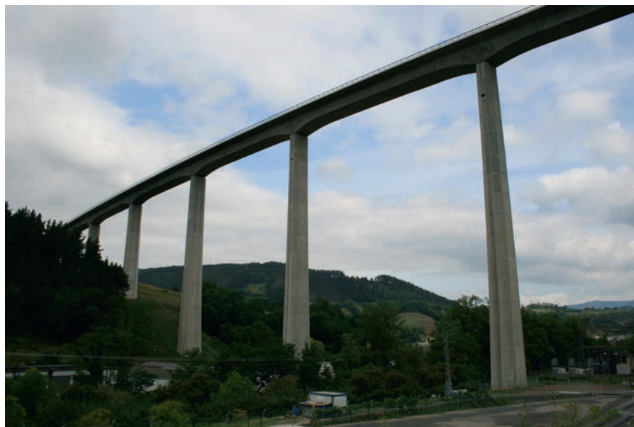
Figura 44. Imagen del viaducto concluido.
