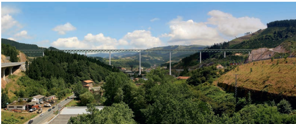
Figura 6. Fotomontaje de la solución en celosía mixta con pilas verticales elegida por ETS tras el estudio de tipologías.
