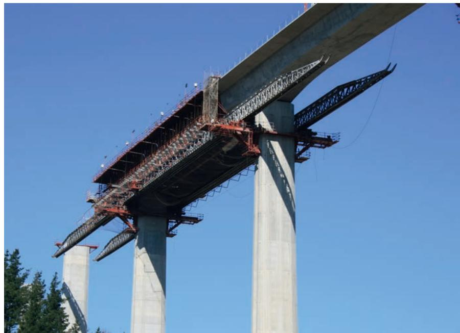
Figura 32. Imagen de los anillos de apoyo de la autocimbra en cabeza de pilas.
