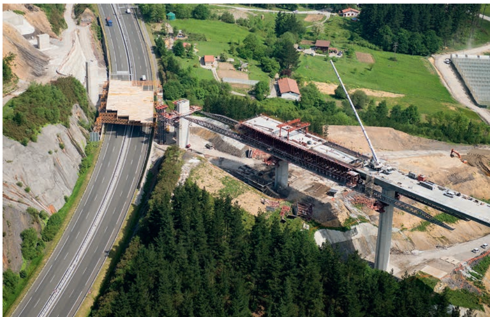
Figura 25. Vista de la zona de negativos completamente hormigonada y colocación de prelosas en el tramo de positivos sobre el que se ferrallará y hormigonará la losa posteriormente.
