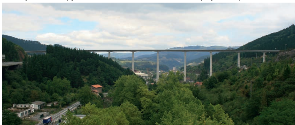
Figura 11. Imagen del viaducto construido de hormigón pretensado.
