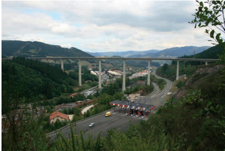
Figura 45. Imagen del viaducto concluido.
