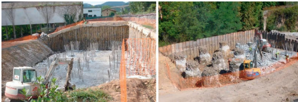
Figura 16. Pantallas de micropilotes anclados en la contención de la cimentación de la P-7 (imagen izquierda) y pantallas de tablestacas en la cimentación pilotada de P-8.
