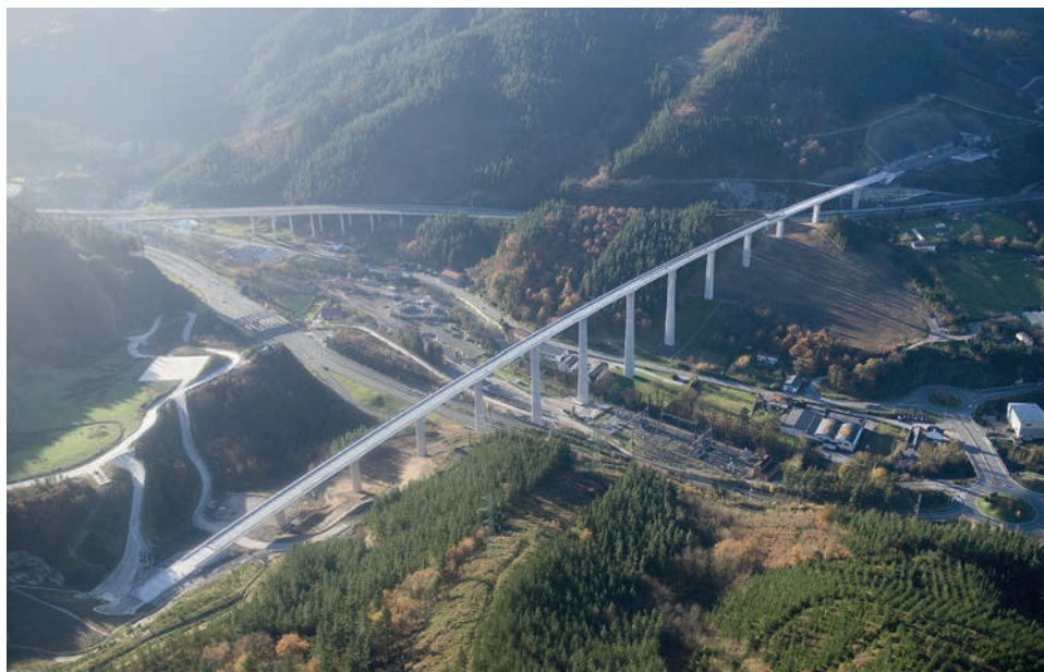
Figura 1. Imagen del viaducto sobre el río Deba concluido.
