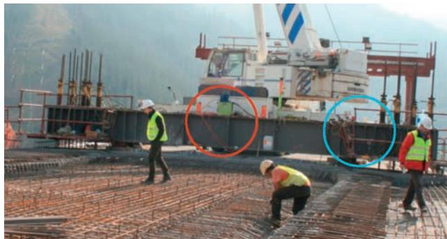
Figura 33. Vista de la viga transversal de cuelgue; en rojo: extensómetros en las alas en el centro de vano; en azul: extensómetro de alma junto al apoyo lateral.
