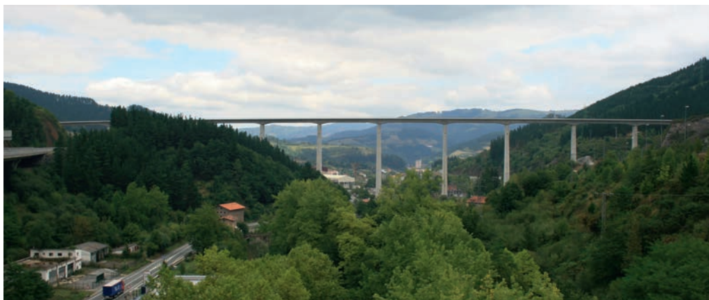
Figura 11. Imagen del viaducto construido de hormigón pretensado.
