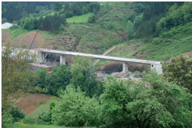
Figura 3. Imagen del viaducto sobre el arroyo de Altzeta.
