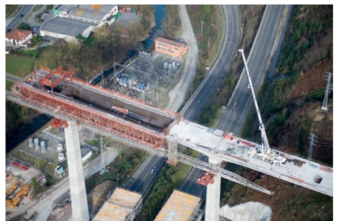
Figura 22. Vista del ferrallado y colocación de tendones de pretensado en la subsección en artesa (tabla inferior y almas).
