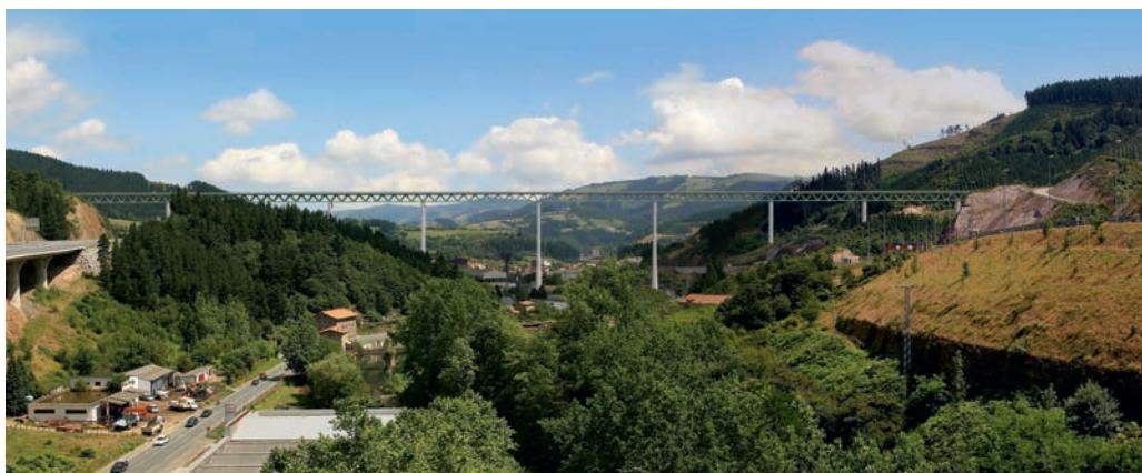
Figura 6. Fotomontaje de la solución en celosía mixta con pilas verticales elegida por ETS tras el estudio de tipologías.
