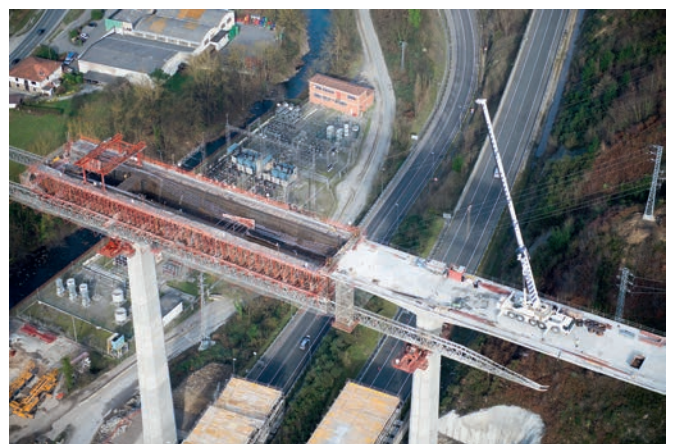
Figura 22. Vista del ferrallado y colocación de tendones de pretensado en la subsección en artesa (tabla inferior y almas).
