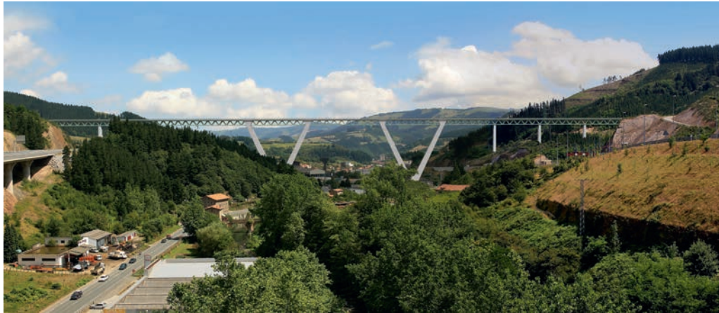
Figura 5. Fotomontaje de la solución en celosía mixta con 2 pilas en V, ganadora del concurso de ideas en 2007.
