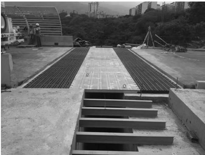
Figura 8. Vista de la junta durante su instalación.
