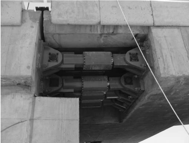
Figura 5. Transmisores de choque.
