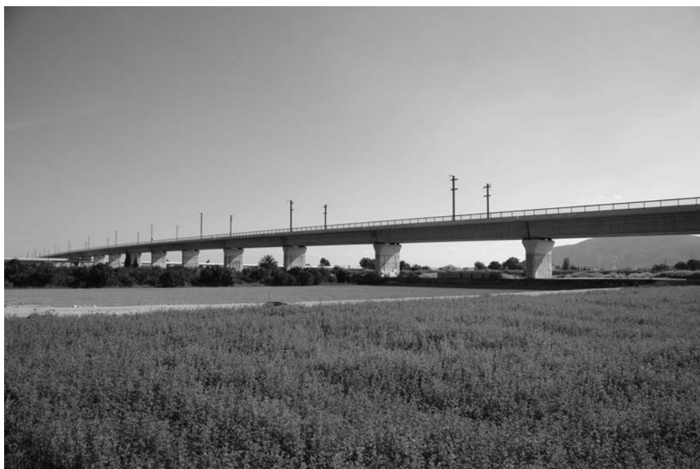
Figura 13. Fotografía Viaducto sobre Tránsito Tajo-Segura.
