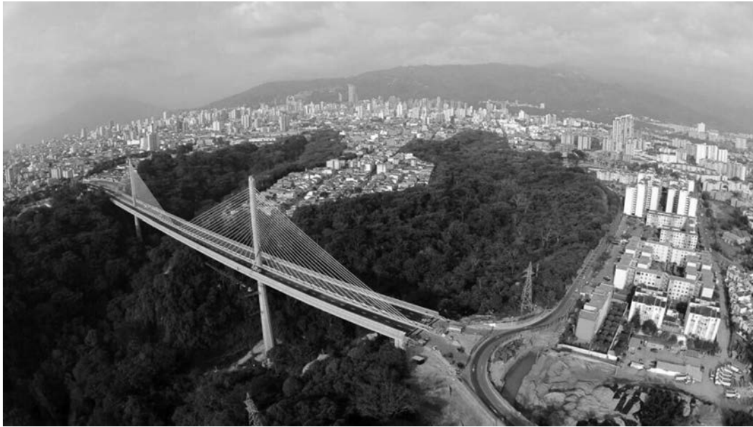
Figura 7. Viaducto Carrera Novena. Vista general del puente.
