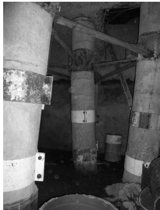
Figura 14. Pilotes inclinados.
