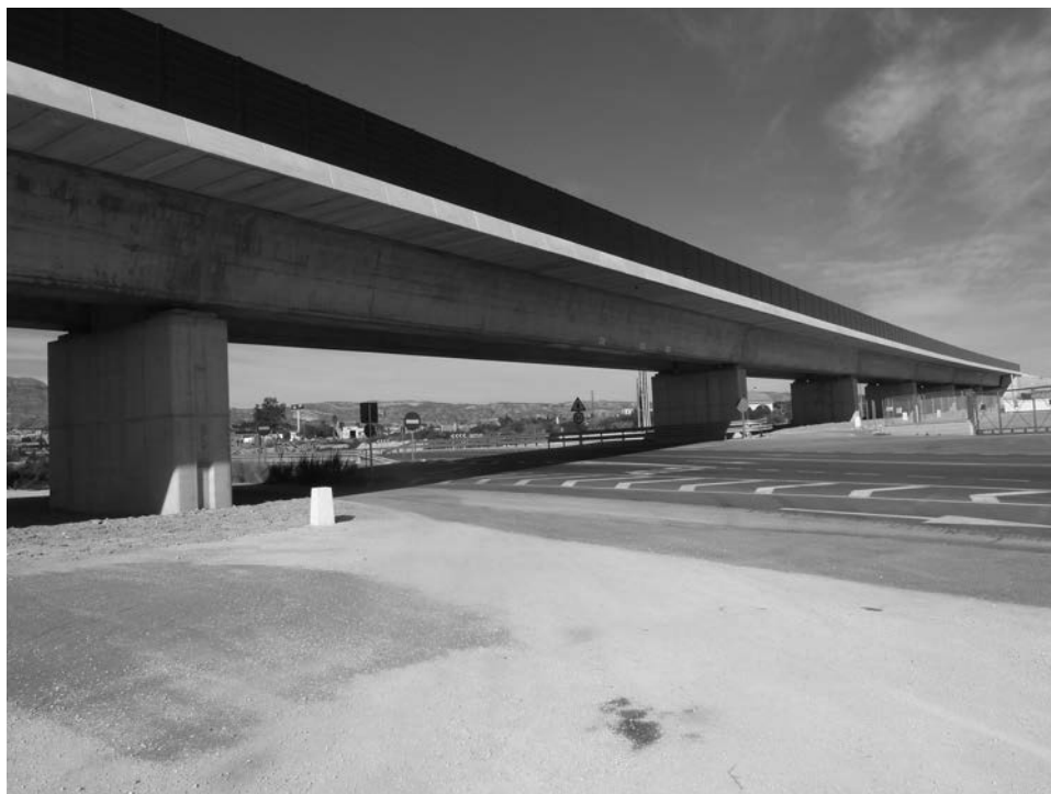
Figura 5. Fotografía Viaducto sobre CV-875.
