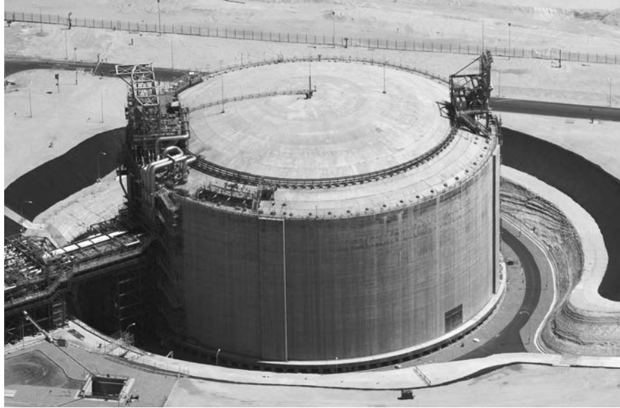
Figura 1. Vista general del tanque de GNL de Mejillones.
