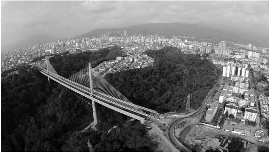
Figura 7. Viaducto Carrera Novena. Vista general del puente.
