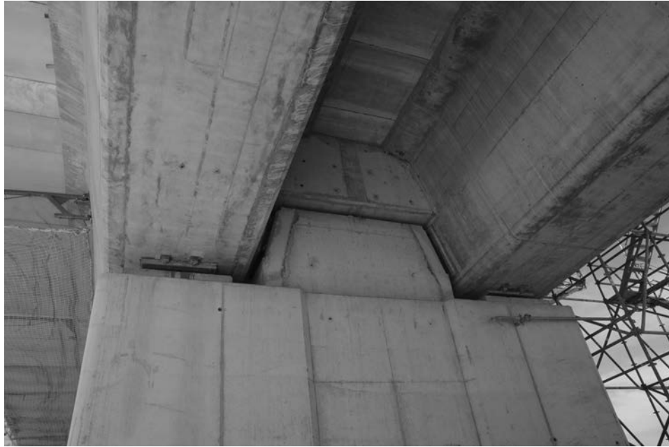
Figura 6. Fotografía detalle tope transversal en Viaducto sobre CV-875.
