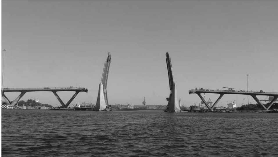
Figura 3. Puente Albatros. Tramo basculante.
