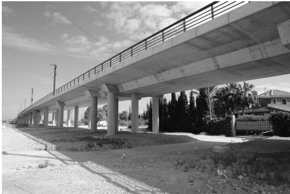
Figura 16. Fotografía Viaducto sobre CV-95.
