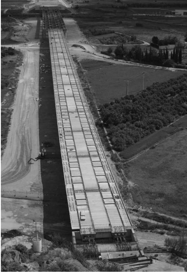
Figura 9. Fotografía Viaducto Callosa-Cox en construcción.
