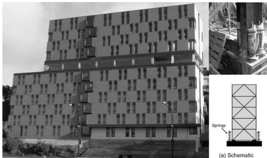
Figura 7. Te Puny Village, anclaje a cimentación mediante muelle-disipador.
