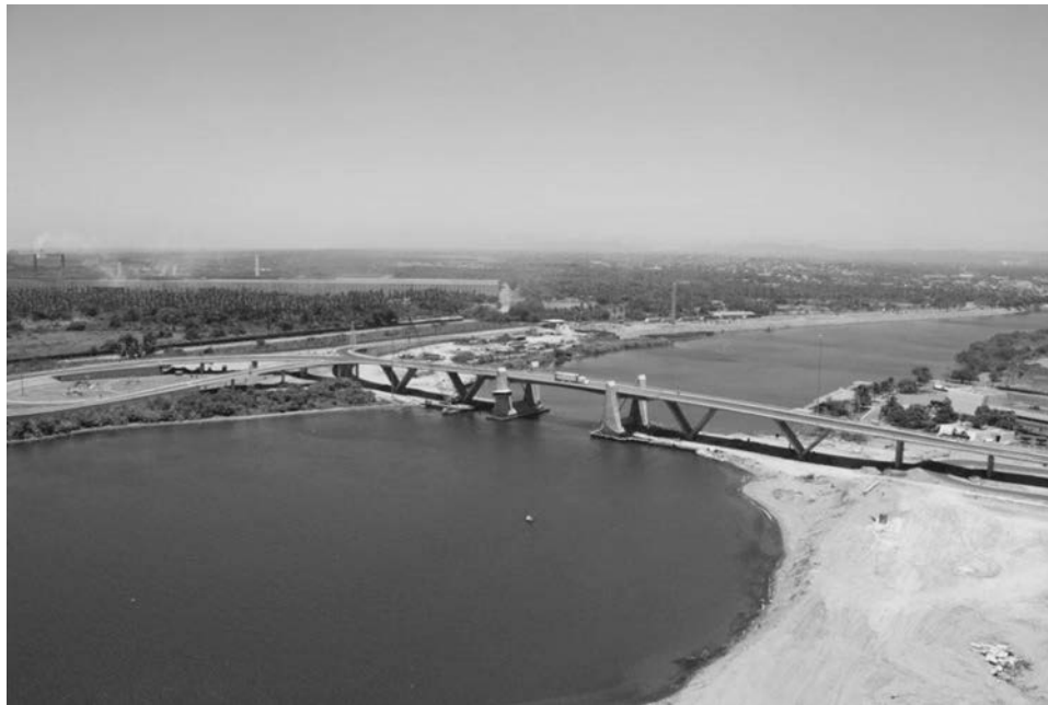
Figura 4. Puente Albatros. Visión general del conjunto.
