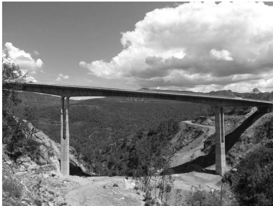
Figura 6. Puente Paso de Piedra. Vista general del puente.
