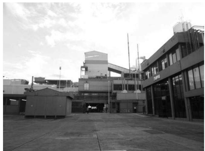
Figura 2. Fachada sur del edificio Pasillo Central.
