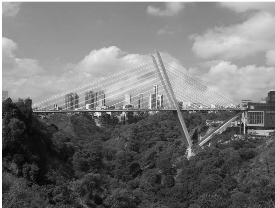
Figura 10. Puente Vidalta. Vista general del puente.
