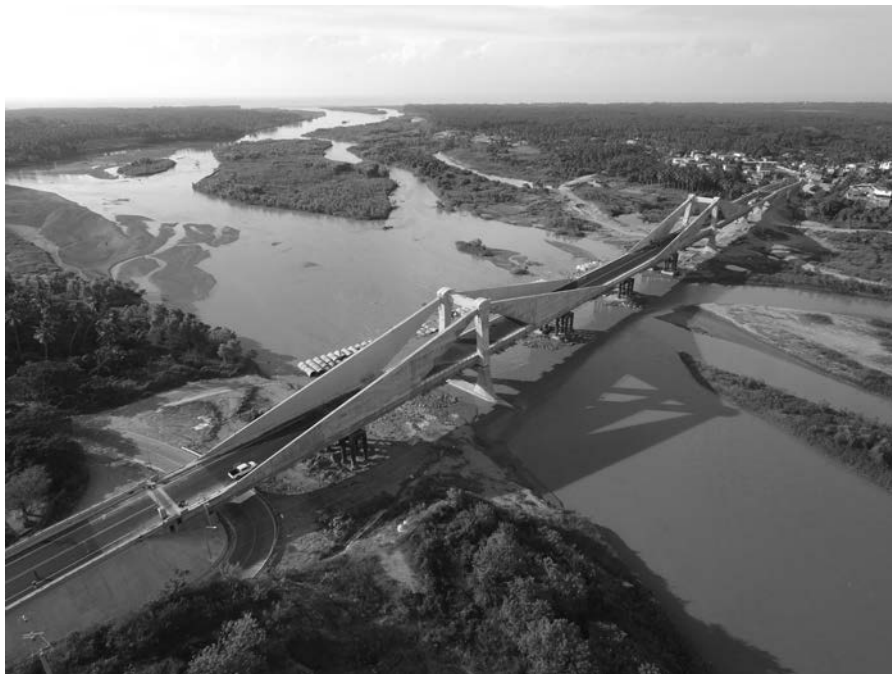
Figura 15. Puente Barra Vieja. Vista general.
