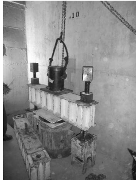
Figura 17. Ajuste de cargas en pilotes con gato hidráulico y puente de reacción.
