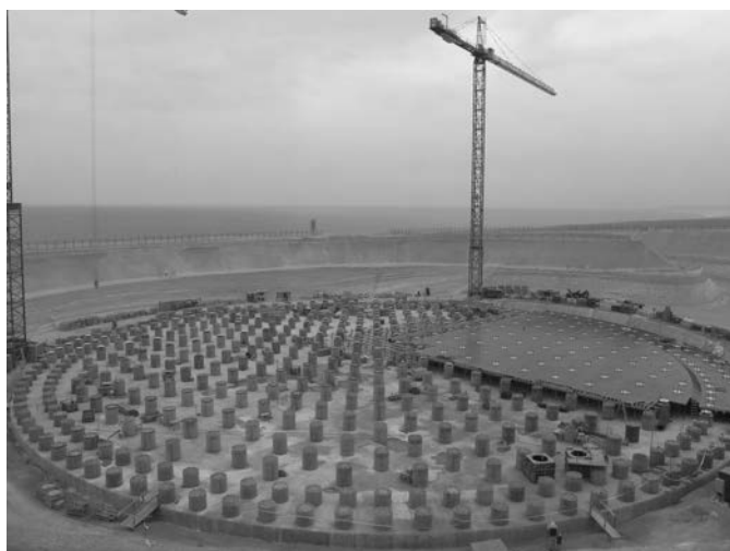
Figura 12. Vista general de los pedestales y aisladores durante la fase de construcción.
