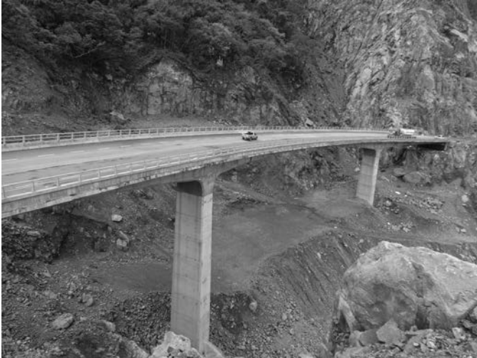
Figura 9. Puento Platanito. Vista general del puente.
