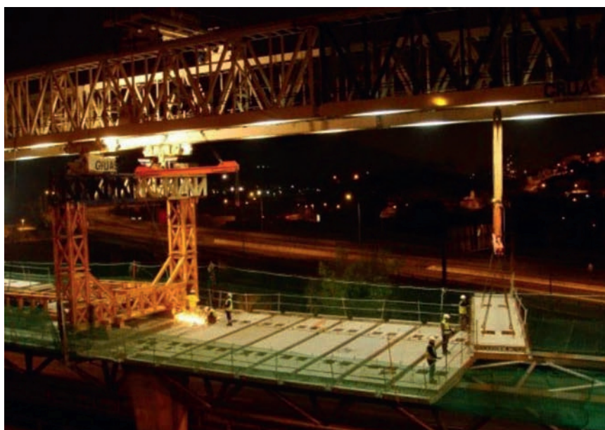
Figura 26. Montaje de losas prefabricadas con el lanzador.
