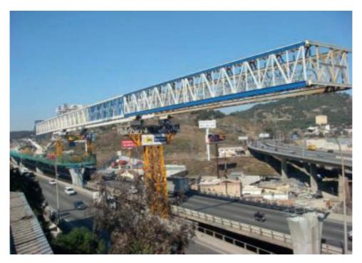
Figura 18. Viga de lanzamiento, de 120 m de longitud, con el extremo frontal en voladizo.
