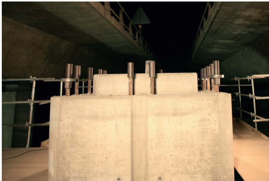
Figura 15. Cabeza superior de la fracción de pila construida in situ. Pueden verse barras salientes verticales de 50 mm de diámetro en situación previa a la operación de montaje de la pieza superior prefabricada. En las barras de esquina se han colocado tuercas de compresión y placas de apoyo por debajo de los manguitos de empalme. En el resto de las barras solamente se han colocado manguitos de empalme.
