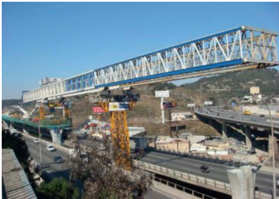
Figura 18. Viga de lanzamiento, de 120 m de longitud, con el extremo frontal en voladizo.
