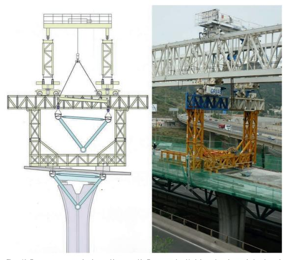
Figura 19. Estructura trasera montada sobre un tablero construido. Esquema en situación de lanzamiento de una celosía y vista real.
