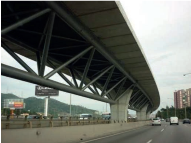
Figura 1. Vista del tablero.
