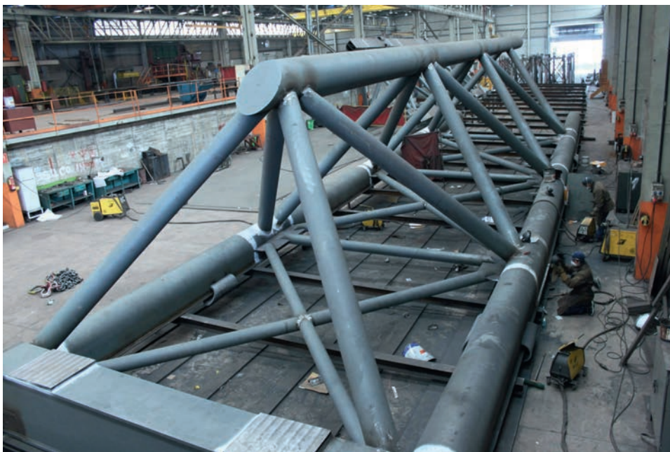
Figura 23. Montaje en taller de una celosía de tablero.
