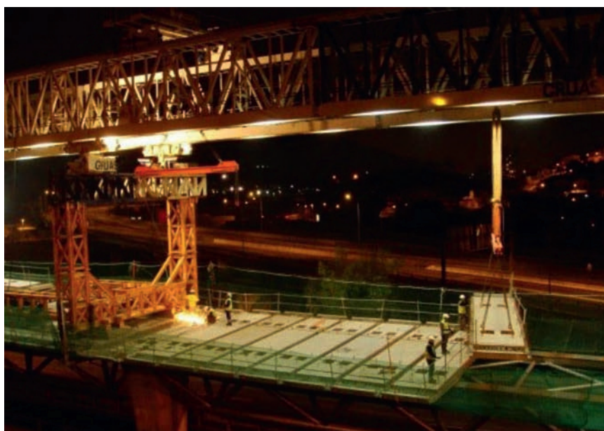
Figura 26. Montaje de losas prefabricadas con el lanzador.
