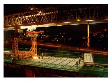
Figura 26. Montaje de losas prefabricadas con el lanzador.
