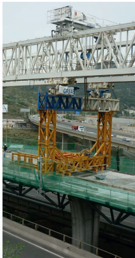
Figura 19. Estructura trasera montada sobre un tablero construido. Esquema en situación de lanzamiento de una celosía y vista real.
