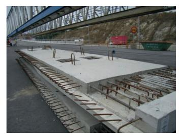
Figura 12. Losas prefabricadas de tablero.
