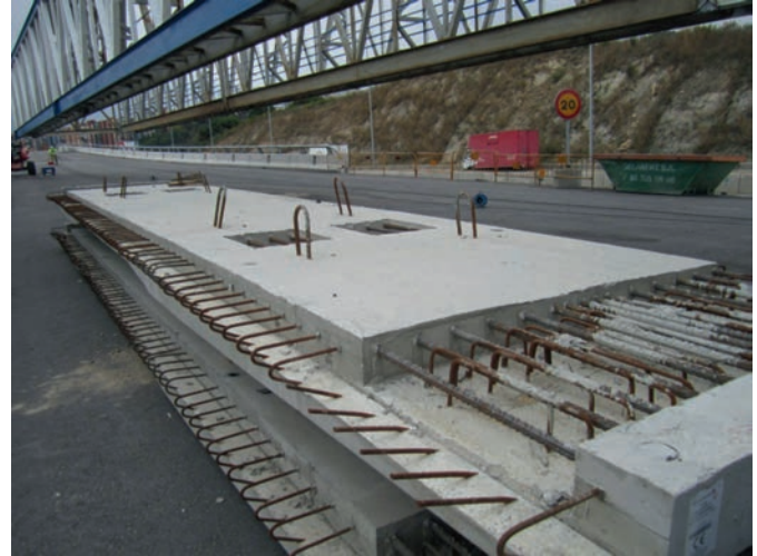
Figura 12. Losas prefabricadas de tablero.
