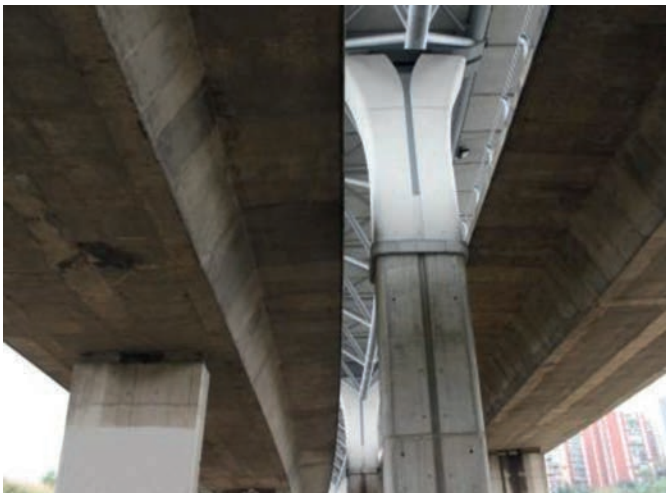
Figura 2. Pila del viaducto Bus-Vao.
