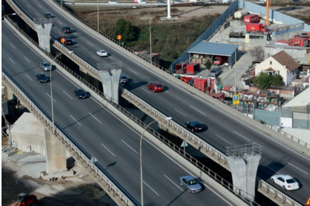
Figura 17. Pilas del viaducto, en la situación previa a la construcción del tablero.
