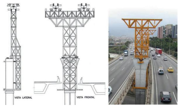
Figura 20. Estructura auxiliar delantera en cabeza de pila. Esquemas y vista frontal real.
