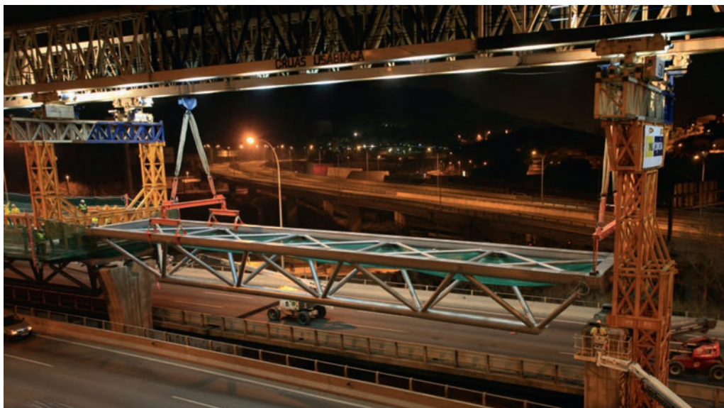
Figura 25. Colocación de una celosía en su posición definitiva mediante el lanzador.
