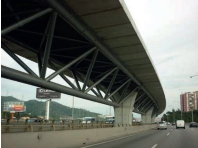
Figura 1. Vista del tablero.
