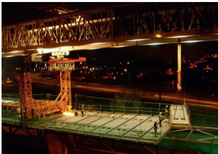
Figura 26. Montaje de losas prefabricadas con el lanzador.
