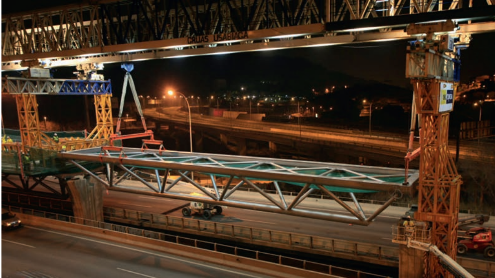
Figura 25. Colocación de una celosía en su posición definitiva mediante el lanzador.
