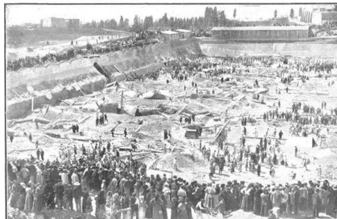
Figura 3. Vista general del lugar de la catástrofe (Nuevo Mundo, abril 1905).
