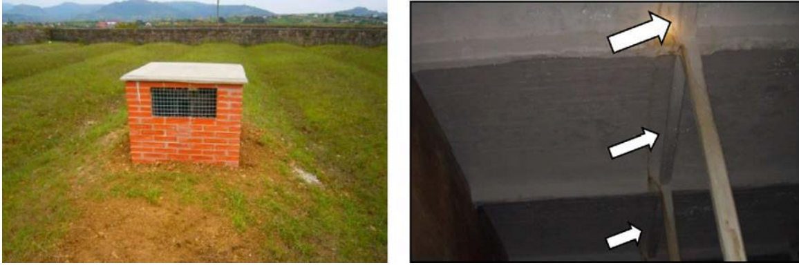
Figura 16. El Depósito de Rocés III (Gijón) en la actualidad (cortesía de la EMA de Gijón).
