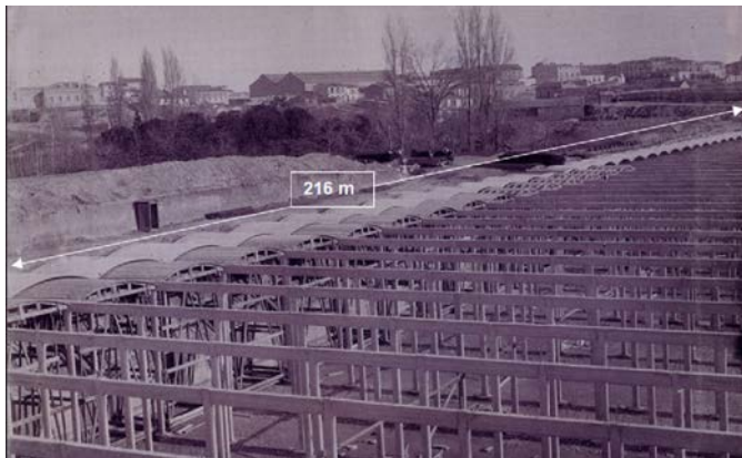
Figura 6. Construcción del Tercer Depósito del Canal de Isabel II. Madrid, 1905.
