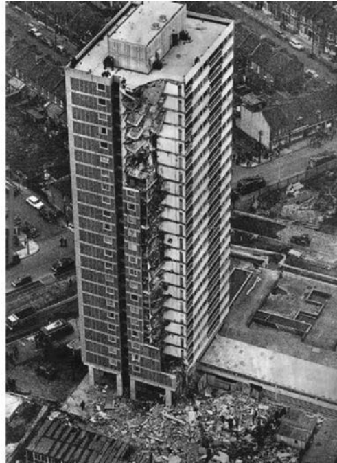
Figura 1. Hundimiento parcial de la torre Ronan Point el 16 de mayo de 1968. Londres. Fuente Levy y Salvadori [2].
