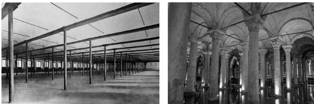
Figura 17. Bóvedas tabicadas enlucidas con yeso de la fábrica Batlló, Barcelona (R. Guastavino, 1875) y Cisterna Estambul (532 d.C) (derecha).
