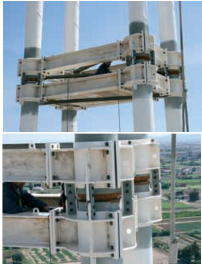
Figura 29. Unión para posicionado y soldadura de tubos de retenida. Figure 29. Connection for geometrical reference prior to welding of back stay tubes.
