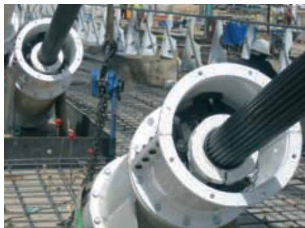
Figura 34. Amortiguador ya montado. Figure 34. Damper on site.
