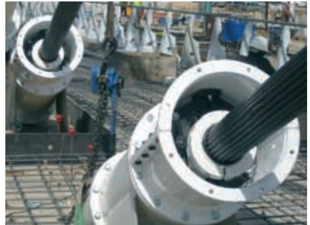
Figura 34. Amortiguador ya montado. Figure 34. Damper on site.
