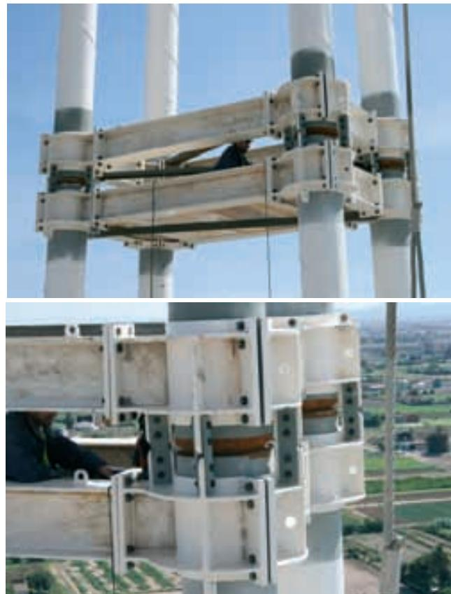
**Figura 29.** Unión para posicionado y soldadura de tubos de retenida.
