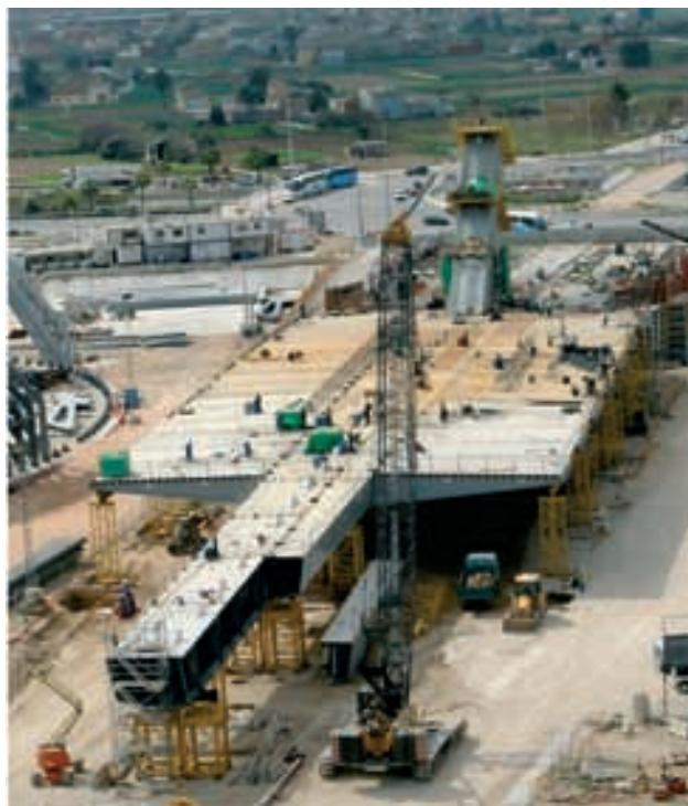
**Figura 24. Montaje de tablero y comienzo de pylon.**
