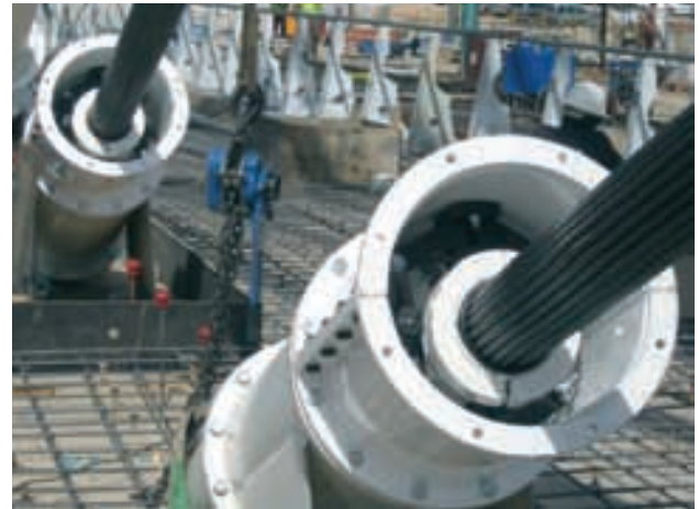
Figura 34. Amortiguador ya montado. Figure 34. Damper on site.
