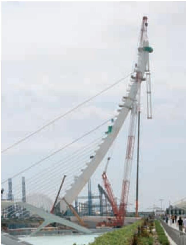
**Figura 28.** Montaje de tubos de retenida.
