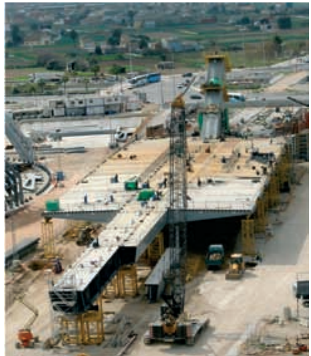
Figura 24. Montaje de tablero y comienzo de pilono. Figure 24. Erection of deck and first stage of pylon.
