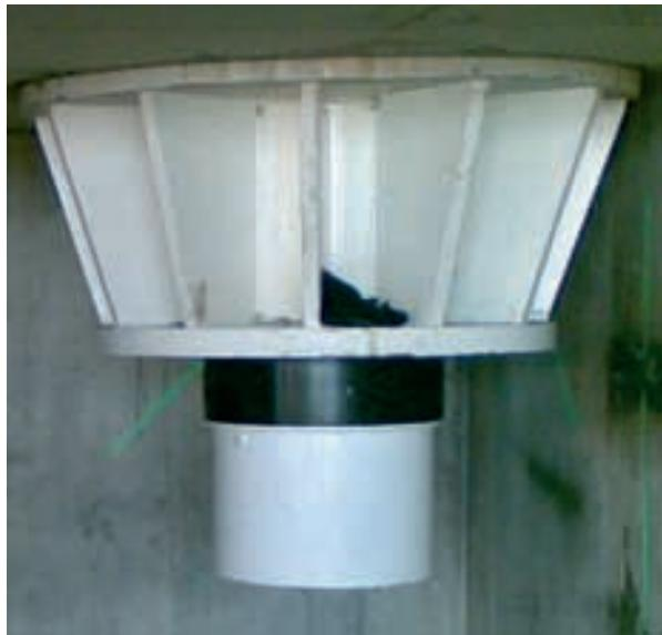
**Figura 31.** Anclaje retenida en cámara de contrapeso.
