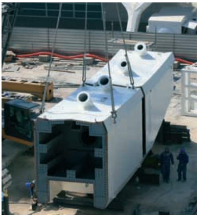
Figura 25. Dovela de pilono. Figure 25. Pylon erection unit.
