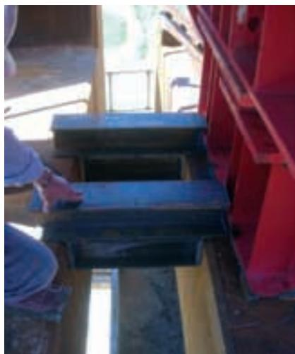
**Figura 22.** Topes de junta después izado
