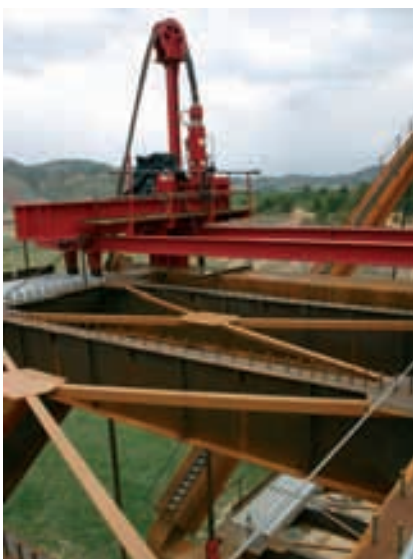
Figura 19. Gatos de izado Figure 19. Hoisting jacks
