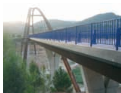
Figura 30. Imposta metálica Figure 30. Steel railing
