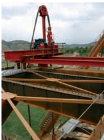
Figura 19. Gatos de izado Figure 19. Hoisting jacks
