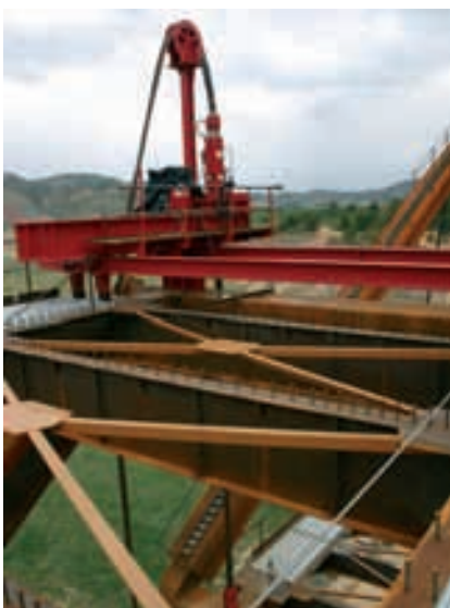
Figura 19. Gatos de izado Figure 19. Hoisting jacks
