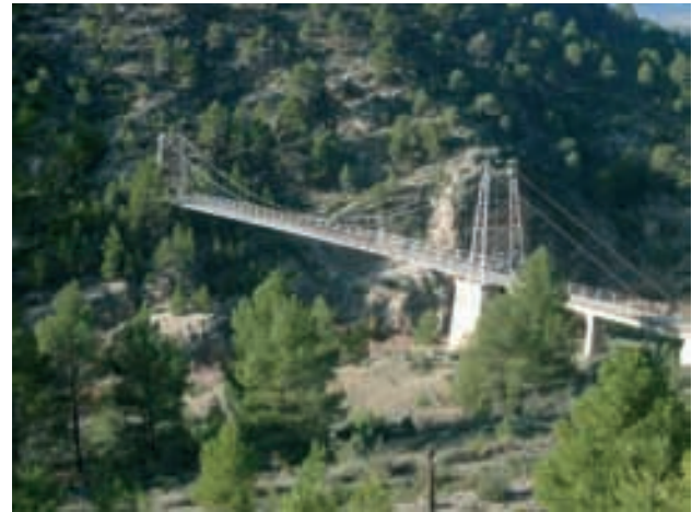
Figura 3. Reposición de caminos sobre el embalse Figure 3. Pathways rebuilt over the reservoir
