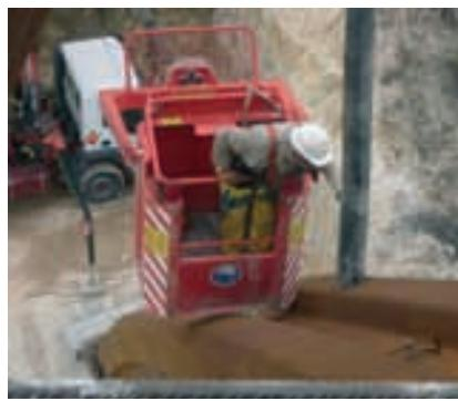
Figura 26. Hormigonado de módulo
