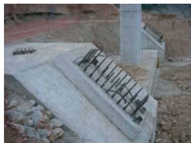
Figura 11. Cimentación de los arcos Figure 11. Arch foundations
