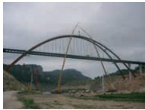
Figura 25. Hormigonado de una fase del arco
