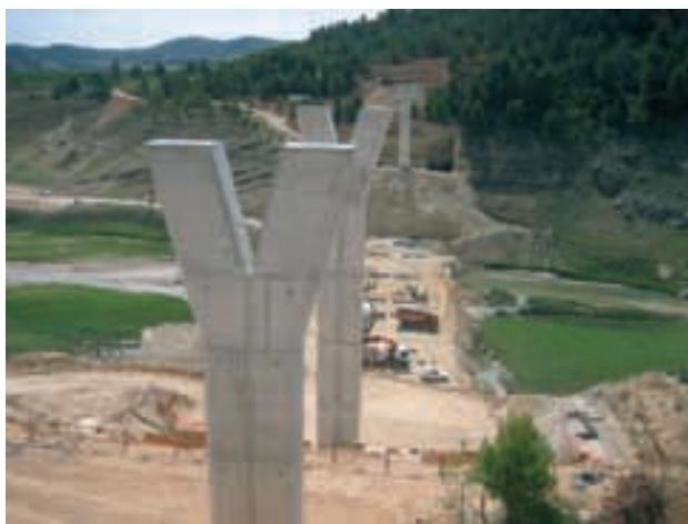
**Figura 9.** Pilas y plataforma del bowstring
