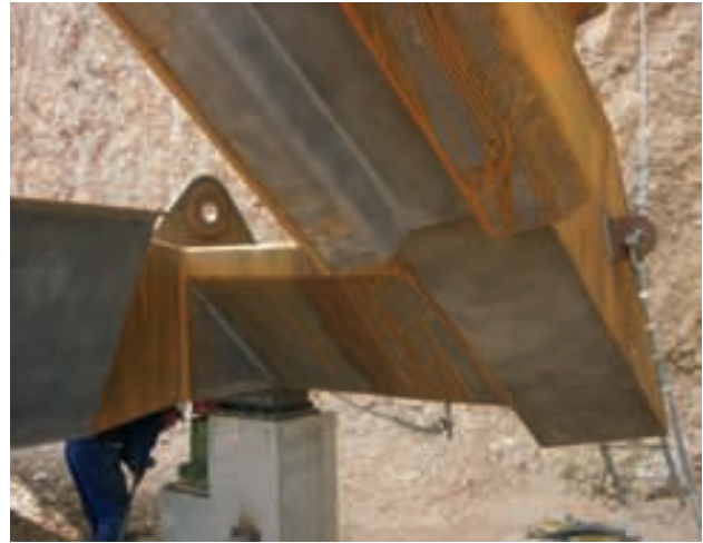
Figura 48. Bowstring: Muñón de riostra, gato de desapeo, orejeta de izado Figure 48. Bowstring: bracing stump, de-shoring jack, hoisting stud
