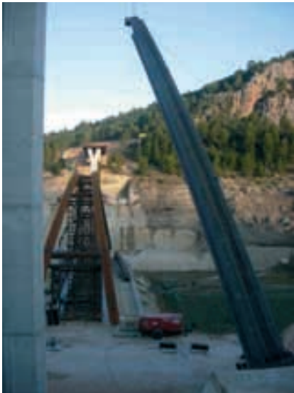
Figura 16. Voladizo (I). Arranques de arco Figure 16. Cantilever (I). Arch springers
