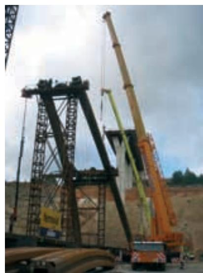
**Figura 14.** Bowstring (II).Montaje de arco
