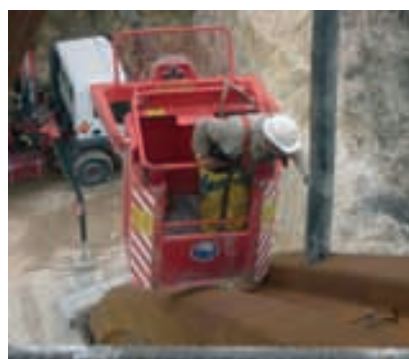
Figura 26. Hormigonado de módulo Figure 26. Concrete casting in a module
