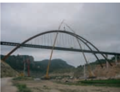
Figura 25. Hormigonado de una fase del arco Figure 25. Concrete casting in the arch
