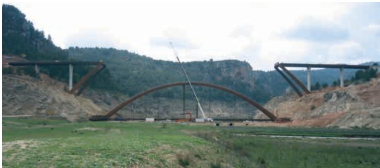
**Figura 12.** Montaje de la estructura metálica, con el bowstring y los voladizos laterales
