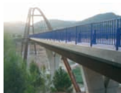
Figura 30. Imposta metálica Figure 30. Steel railing
