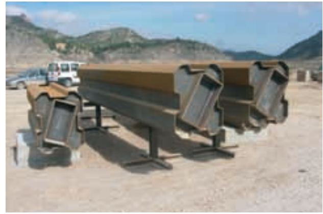
Figura 43. Acopio de riostras entre arcos Figure 43. On-site store of inter-arch braces
