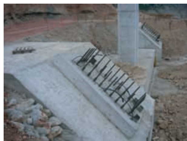
Figura 11. Cimentación de los arcos Figure 11. Arch foundations
