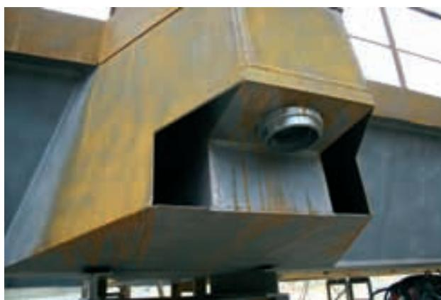
**Figura 42.** Anclaje pendola en tablero, en construcción
