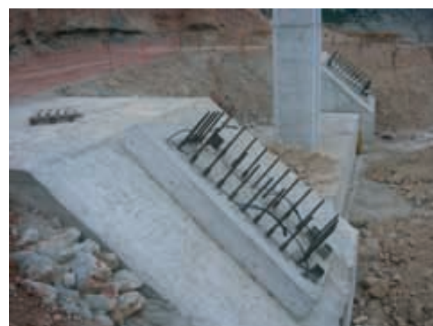
Figura 11. Cimentación de los arcos Figure 11. Arch foundations
