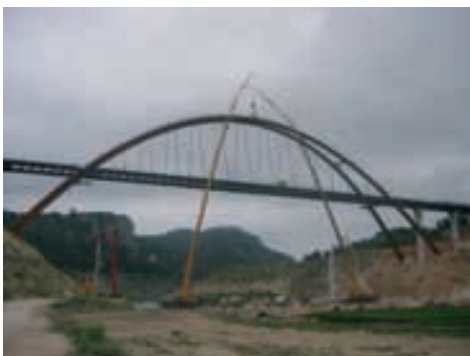
Figura 25. Hormigonado de una fase del arco Figure 25. Concrete casting in the arch
