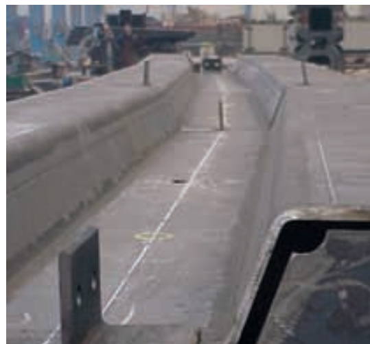
Figura 46. Control geométrico por tramos conjugados Figure 46. Geometric control via matching sections
