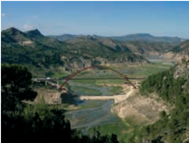
Figura 4A. Vista desde aguas arriba Figure 4A. Downstream view
