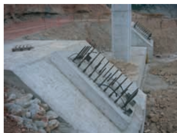
Figura 11. Cimentación de los arcos Figure 11. Arch foundations
