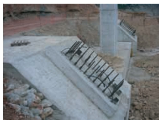
Figura 11. Cimentación de los arcos Figure 11. Arch foundations
