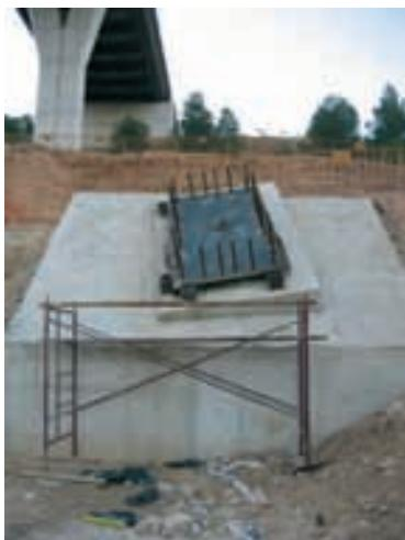
**Figura 45.** Replanteo placa apoyo
