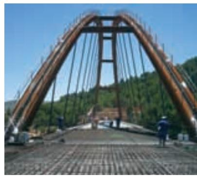
Figura 27. Hormigonado del tablero
