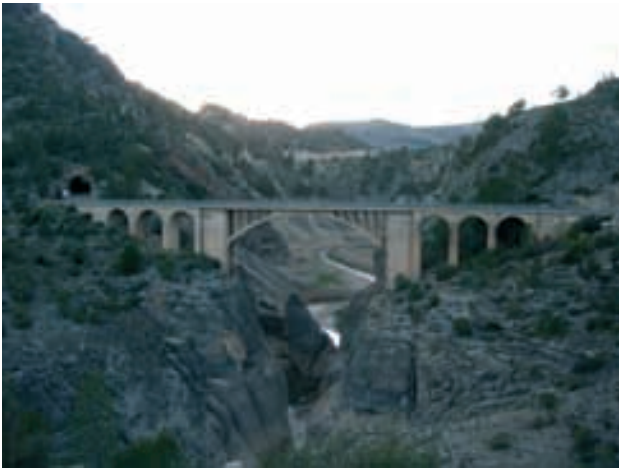
Figura 2. Carretera de acceso a Yeste, sobre el Tus Figure 2. Road to Yeste, bridge over the Tus River
