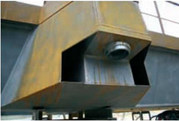
Figura 42. Anclaje péndola en tablero, en construcción Figure 42. Hanger anchorage on deck, under construction
