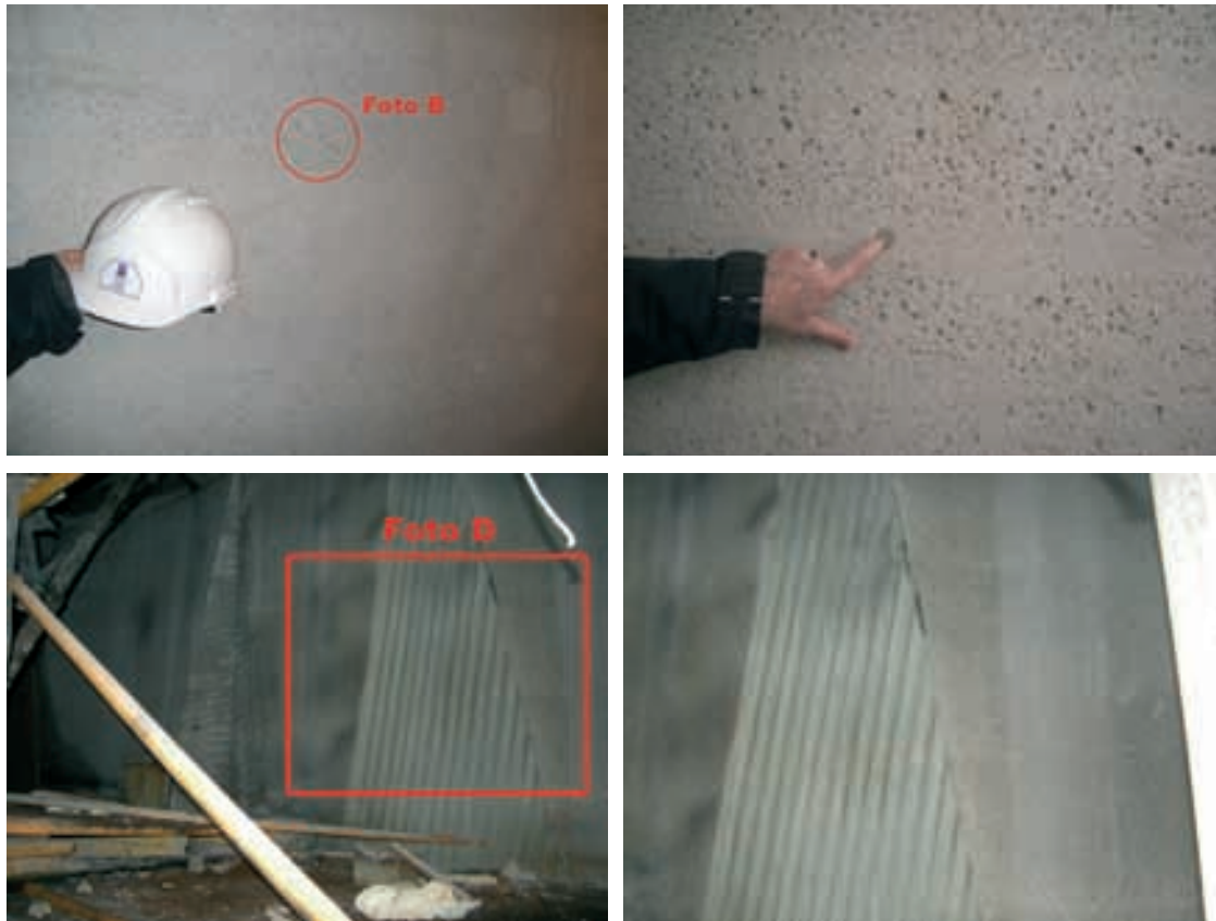
Figura 21. Pruebas de acabado: a y b) de HAC y c y d) HAR. Fuente propia Figure 21. Finishing tests: a) and b) SCC finishing and c) and d) HSC finishing. Source: authors
