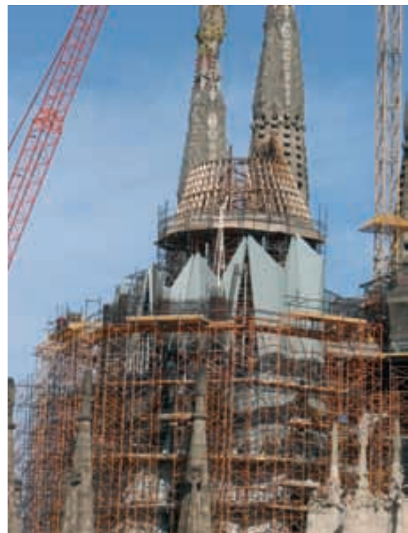
Figura 23. Construcción del ábside: a) primeros pisos y b) cimbra del hiperboloide central ya colocada Figure 23. Apse construction: a) first storeys and b) hyperboloid formwork in place
