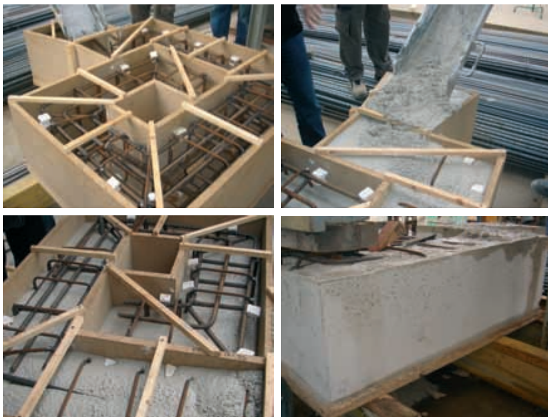
Figura 18. Estructura para la primera prueba del HAC realizada el 20 de febrero del 2009. Fuente propia Figure 18. Mould for the first SCC test conducted on 20 February 2009. Source: authors
