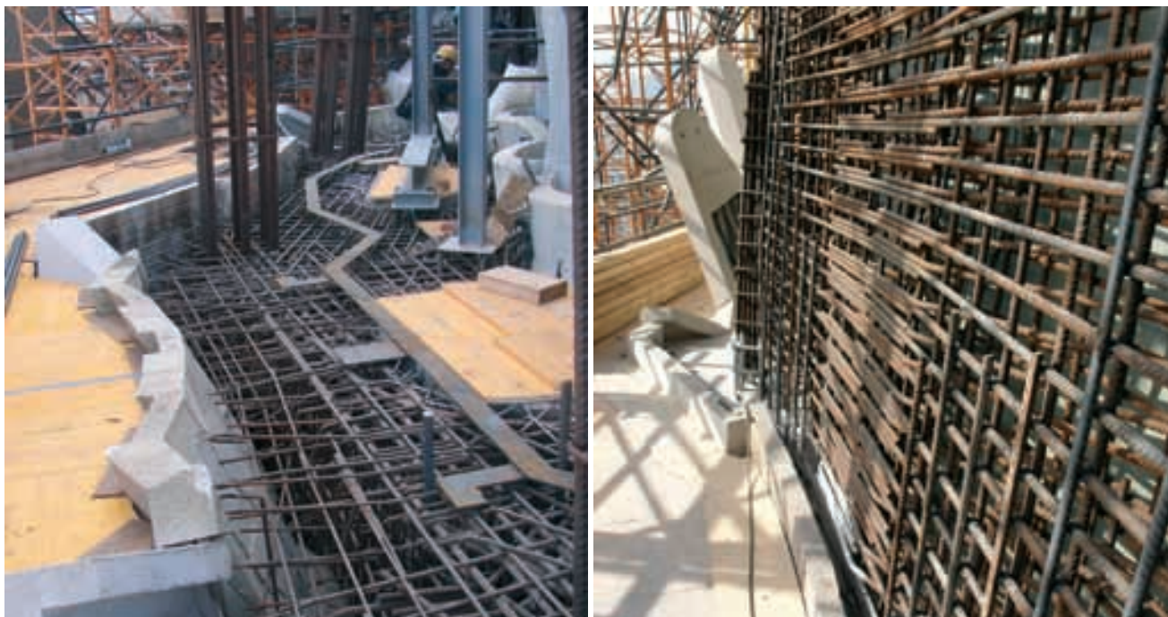
Figura 29. Ábside: a) armado de la base y b) armado del paramento Figure 29. Concrete placement in apse: a) base and b) wall reinforcement
