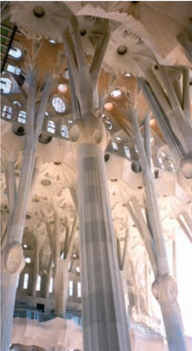
Figura 2. Cubiertas de las naves del cuerpo principal. Fuente: ATESF
