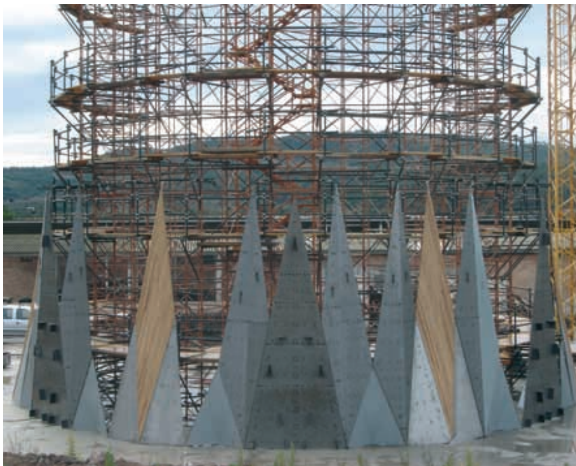
Figura 24. Diferentes tipos de encofrado utilizados en los muros del ábside. Fuente: ATESEF Figure 24. Formwork types used in the apse walls. Source: ATESEF
