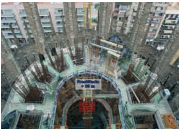
Figura 23. Construcción del ábside: a) primeros pisos y b) cimbra del hiperboloide central ya colocada Figure 23. Apse construction: a) first storeys and b) hyperboloid formwork in place
