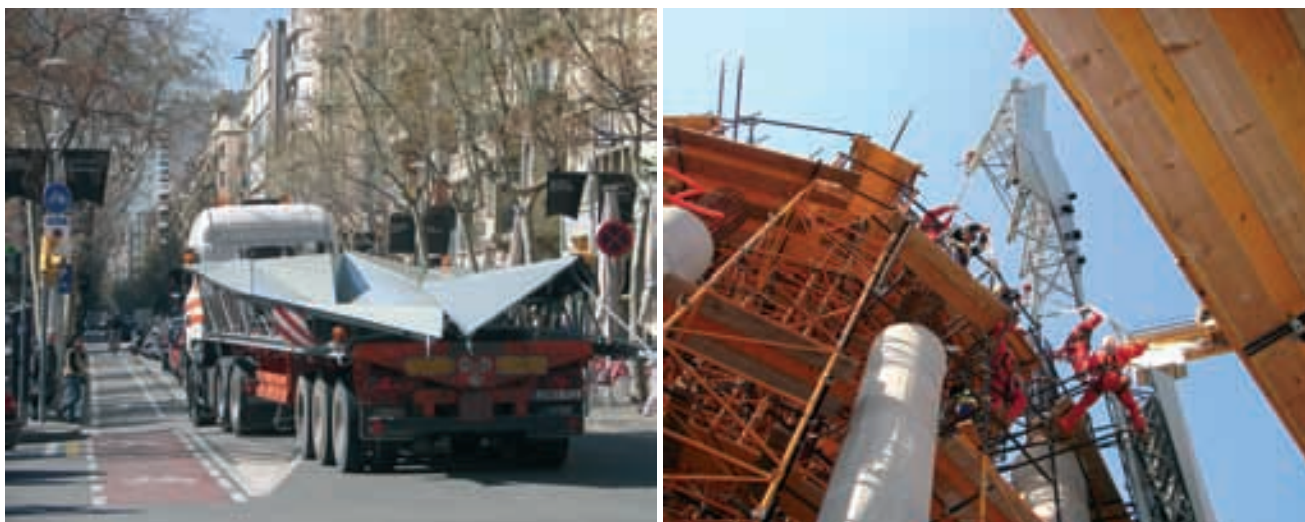
Figura 28. Armado y encofrado: a) transporte y b) colocación. Fuente ATESF Figure 28. Reinforcement and formwork: a) transport and b) placement. Source: ATESF
