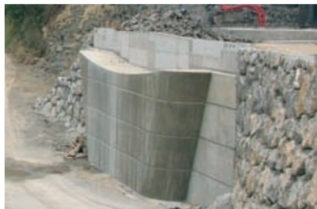
Figura 26. Estribo 2 del lado del puente arco antes del túnel Figure 26. Arch bridge abutment 2 before the tunnel
