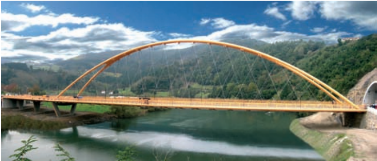
Figura 11. Vista desde aguas abajo Figure 11. Downstream view
