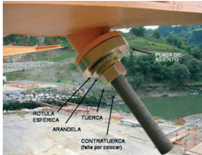
Figura 23. Anclaje inferior de las péndolas a las costillas transversales del tablero
