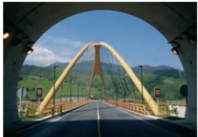
Figuras 9a y 9b. Vista del arco desde el exterior y desde el interior del túnel
