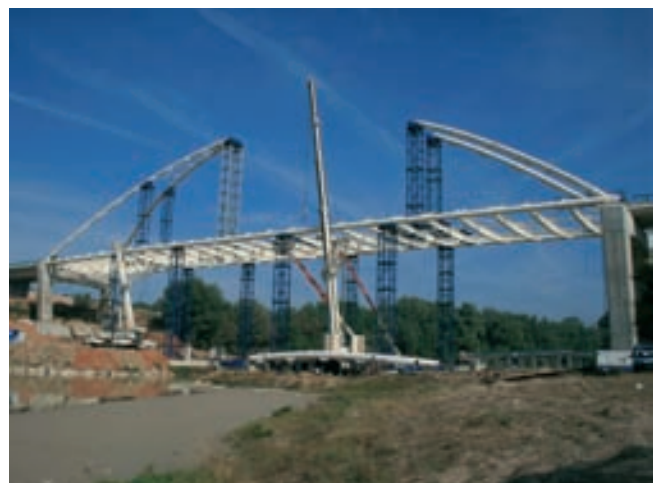
Figuras 40a y 40b. Izado de un tramo de tablero y vista del tablero metálico del puente concluido y apeado Figures 40a and 40b. Hoist of deck segment and view of the deck shored after completion
