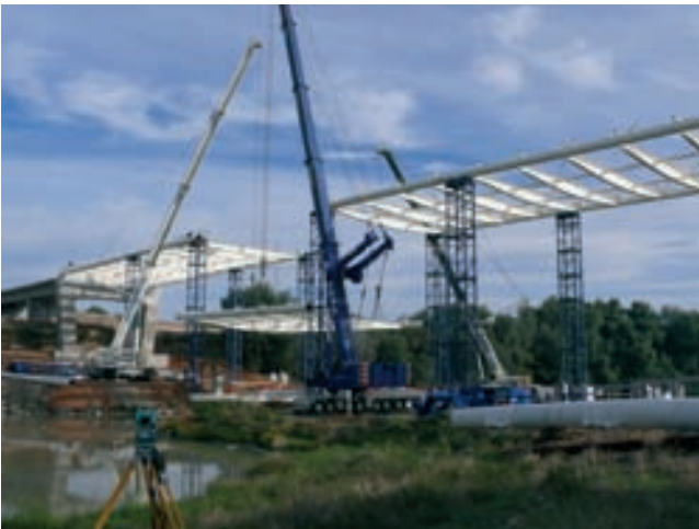
Figuras 40a y 40b. Izado de un tramo de tablero y vista del tablero metálico del puente concluido y apeado Figures 40a and 40b. Hoist of deck segment and view of the deck shored after completion
