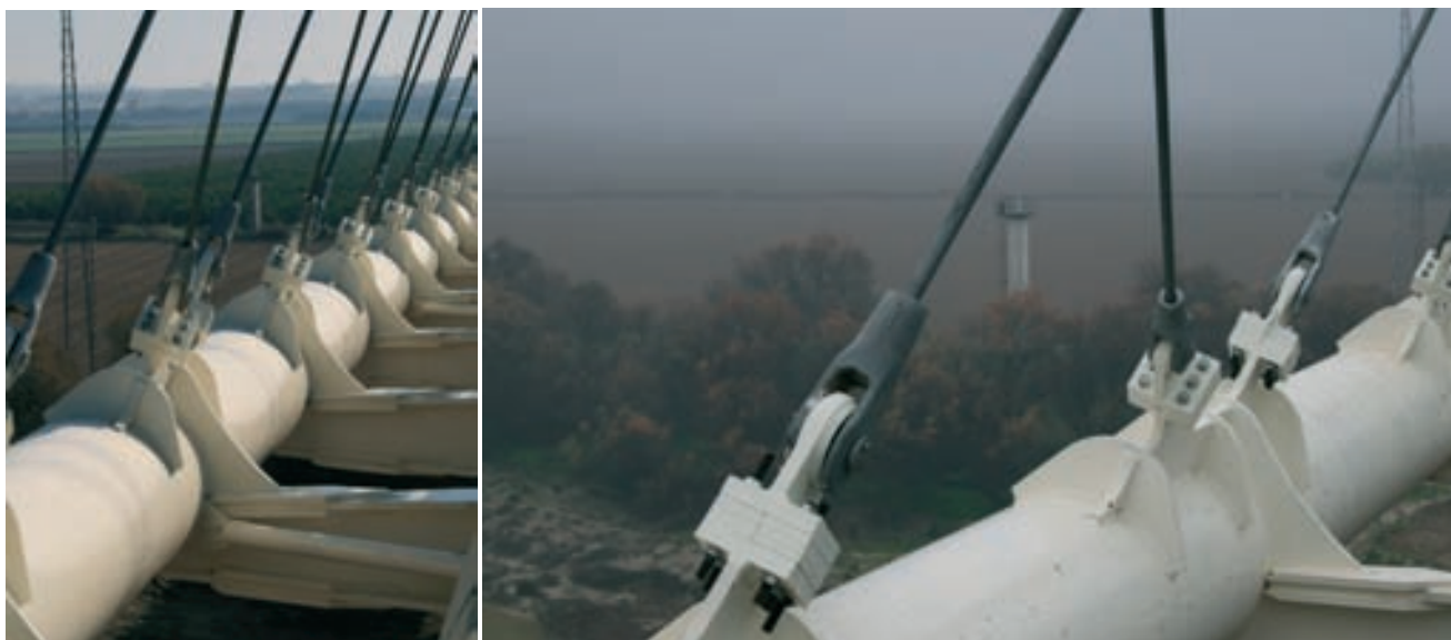
Figuras 33a y 33b. Detalles de anclajes de péndolas inferiores y arranques de vigas transversales dispuestas cada 5 m en el tablero Figures 33a and 33b. Details of hanger anchorage and transverse girders ends at 5 m intervals along the bridge
