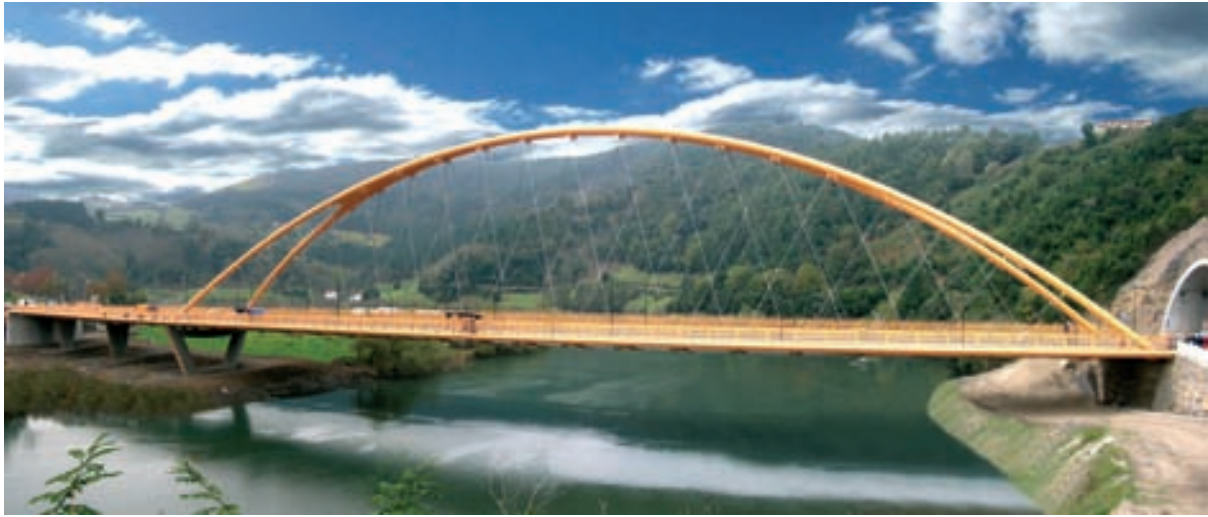
Figura 11. Vista desde aguas abajo Figure 11. Downstream view
