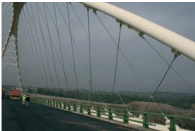
Figuras 38a y 38b. Detalle de péndolas en dos planos paralelos con los dispositivos de cruce de péndolas Figures 38a and 38b. Detail of hangers on two parallel planes with the crossing device
