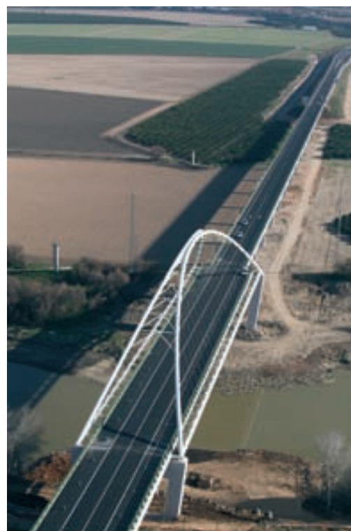
Figuras 32a y 32b. Sección transversal y vista aérea frontal Figures 32a and 32b. Cross-section and front bird's eye view
