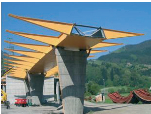
Figura 15. Estructura metálica del viaducto de acceso en ejecución
