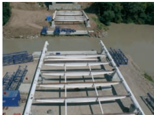
Figura 39. Vista de las penínsulas artificiales y de las labores de ensamblaje de la estructura metálica del tablero Figure 39. Artificial embankments and steel deck assembly operations
