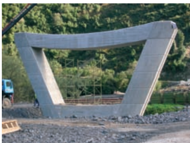
Figura 25. Pila de apoyo de los vanos de acceso y el arco Figure 25. Common pier for access viaduct and arch bridge
