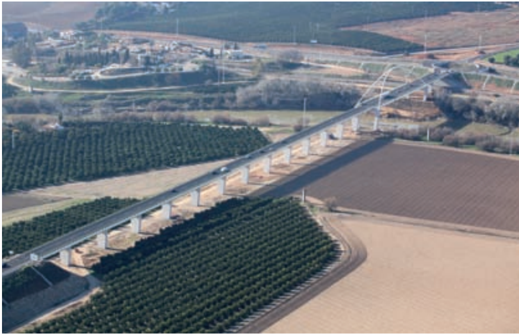
Figura 29. Vista aérea en primer plano del Viaducto de acceso Sur, del Puente arco, del Viaducto de acceso Norte y de la glorieta Figure 29. Bird's eye view of the South Access viaduct (foreground), the arch bridge, the North Access viaduct and the roundabout
