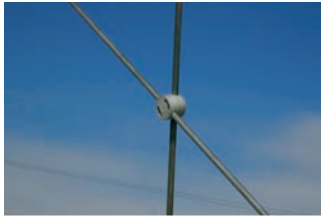
Figuras 38a y 38b. Detalle de péndolas en dos planos paralelos con los dispositivos de cruce de péndolas Figures 38a and 38b. Detail of hangers on two parallel planes with the crossing device
