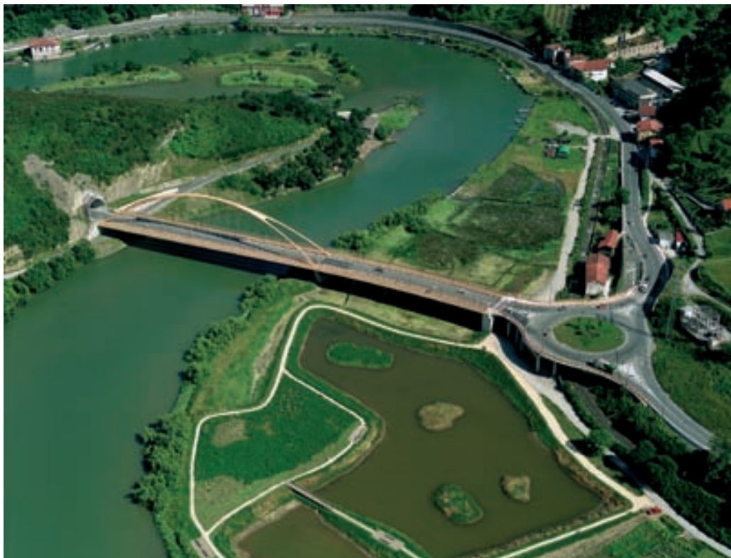
Figura 8. Vista aérea del puente y del viaducto de acceso Figure 8. Bird's eye view of the bridge and the access viaduct
