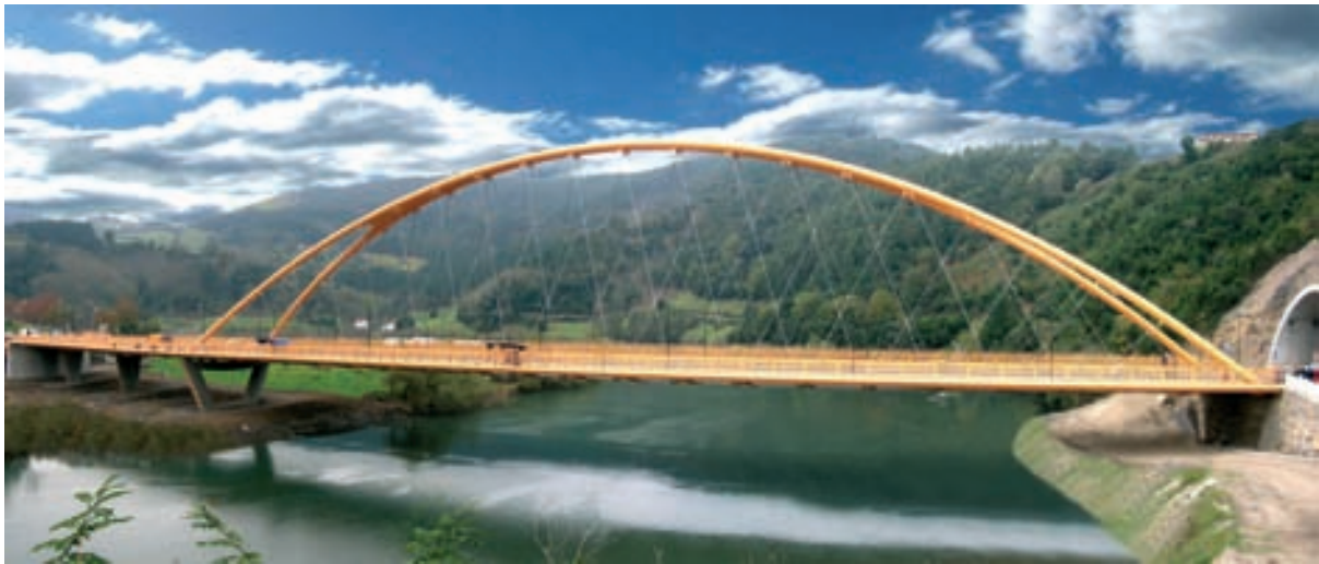
Figura 11. Vista desde aguas abajo Figure 11. Downstream view
