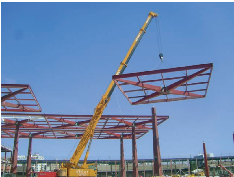
Figura 14. Montaje de un módulo mediante grúa
