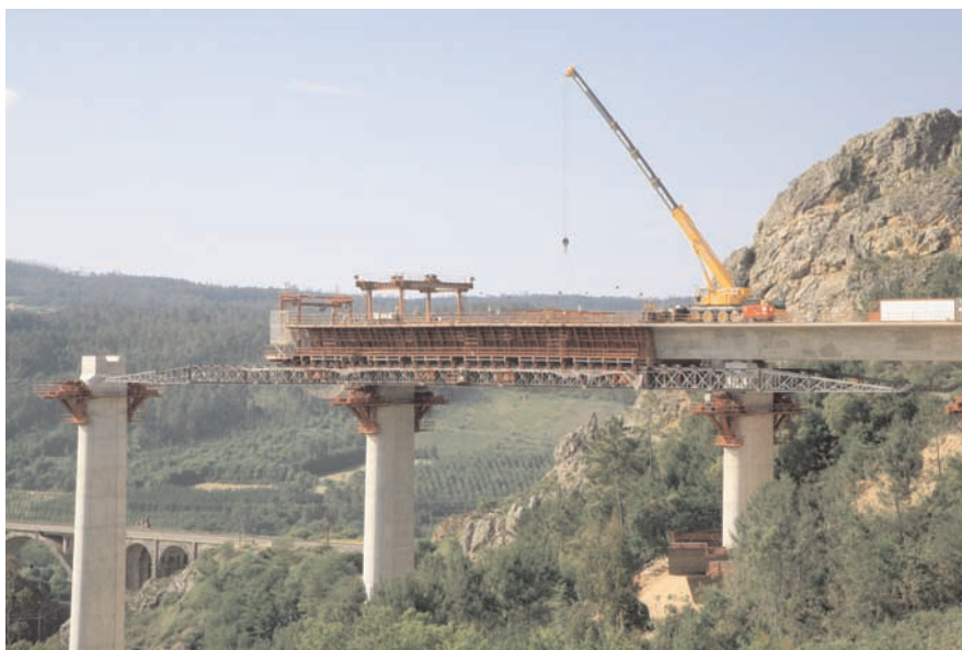
Figura 11. Ejecución del tablero con cimbra autolanzable
