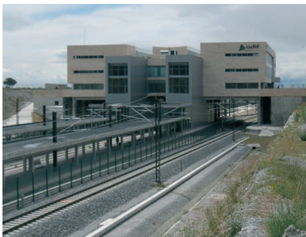
Figura 1. Situación actual de la estación Segovia Guiomar
