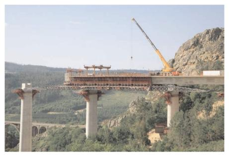
Figura 11. Ejecución del tablero con cimbra autolanzable
