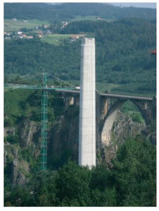
Figura 12. Fustes de pilas de tramos de acceso
