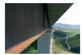
Figura 5. Vista de la viga del lado oeste al caer el sol al inicio del atardecer, con la parte inferior de la viga expuesta al sol y el resto de la viga todavía en sombra (fotografía de enero-09)
