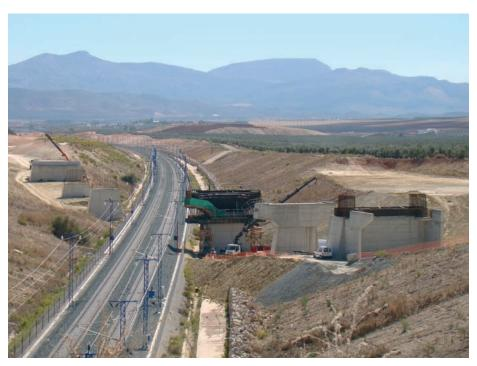
Figura 9. Vista general del puente durante la ejecución de pilas y estribos
