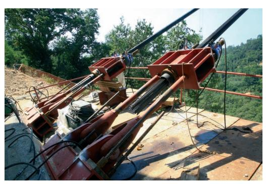
Figura 22. Estructura de transferencia en anclaje de retenida
