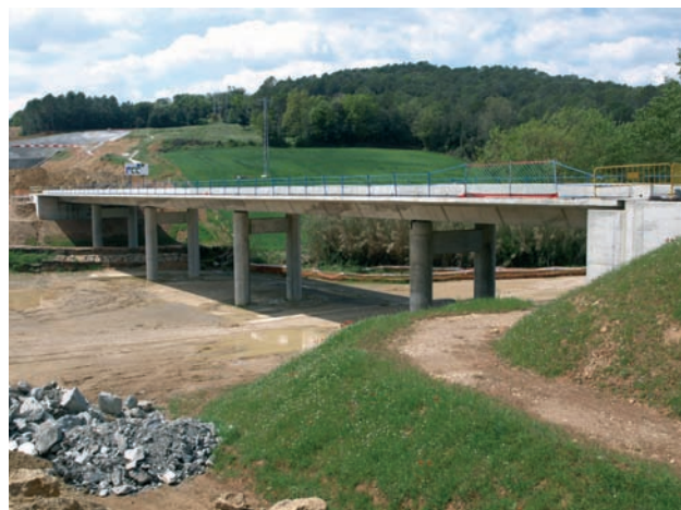
Figura 14. Viaducto sobre la riera de Casinyola
