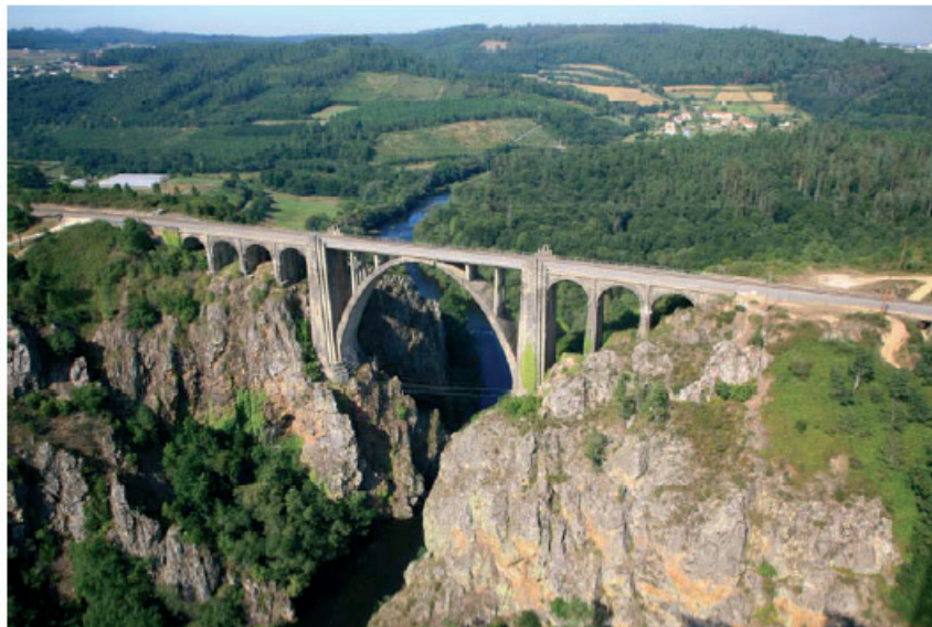
Figura 3. Viaducto de Gundían, situado inmediatamente aguas arriba del nuevo viaducto sobre el río Ulla
