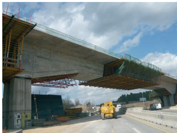
Figura 15. Viaducto sobre la carretera C-66
