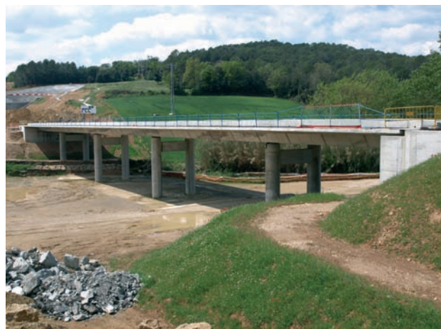
Figura 14. Viaducto sobre la riera de Casinyola
