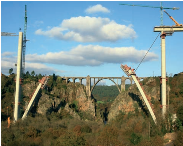
Figura 8. Alzado del arco en construcción
