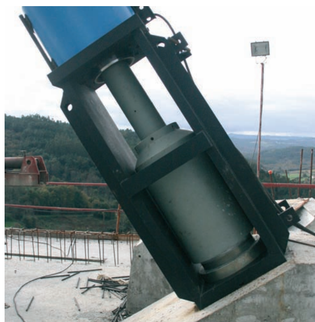
Figura 23. Gatos de tesado de tirantes con puente
