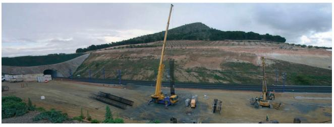
Figura 7. Ejecución de pilotes de cimentación de pilas del vano central en obra
