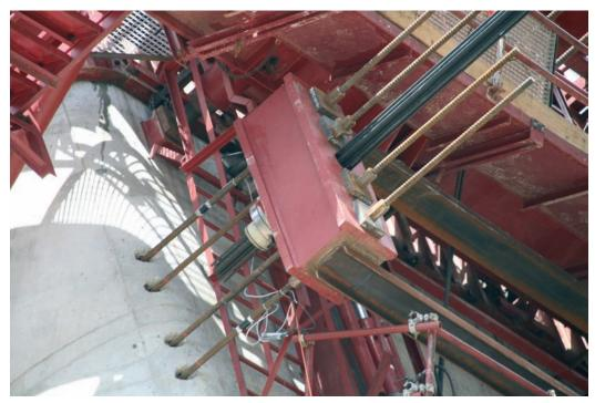
Figura 21. Estructura de transferencia en anclaje pasivo de tirante
