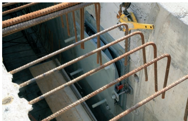
Figura 26. Apoyo POT instrumentado en estribo E1
