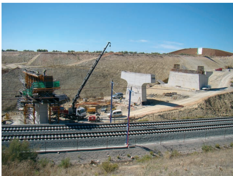
Figura 8. Ejecución de dintel de pila del vano central
