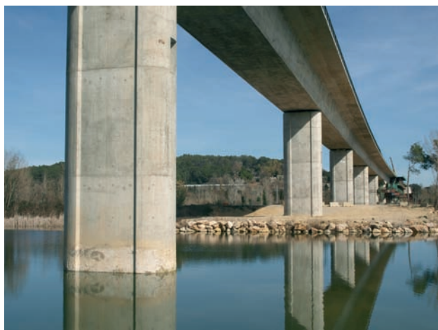
Figura 12. Viaducto sobre el río Fluvià
