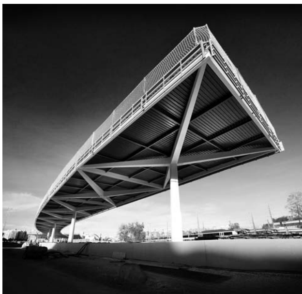
Figura 9. Extremo de la marquesina del andén curvo
