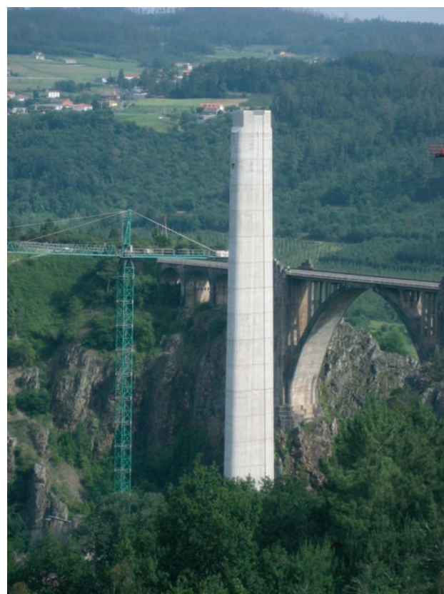
Figura 12. Fustes de pilas de tramos de acceso
