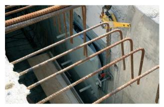
Figura 26. Apoyo POT instrumentado en estribo E1
