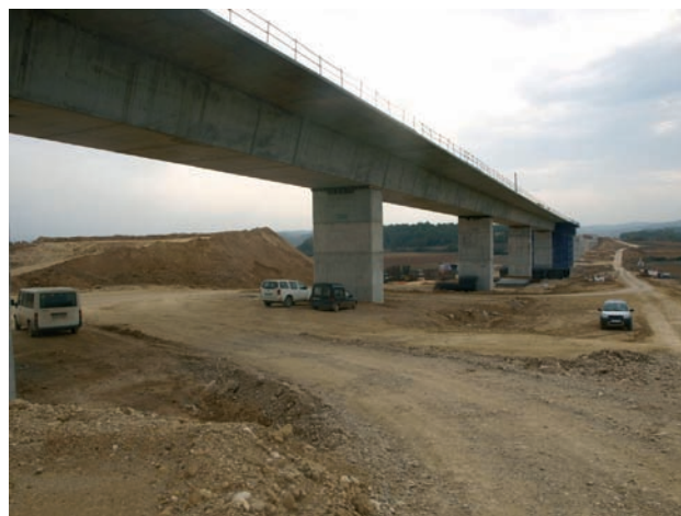
Figura 13. Viaducto sobre el Pla dels Caboters
