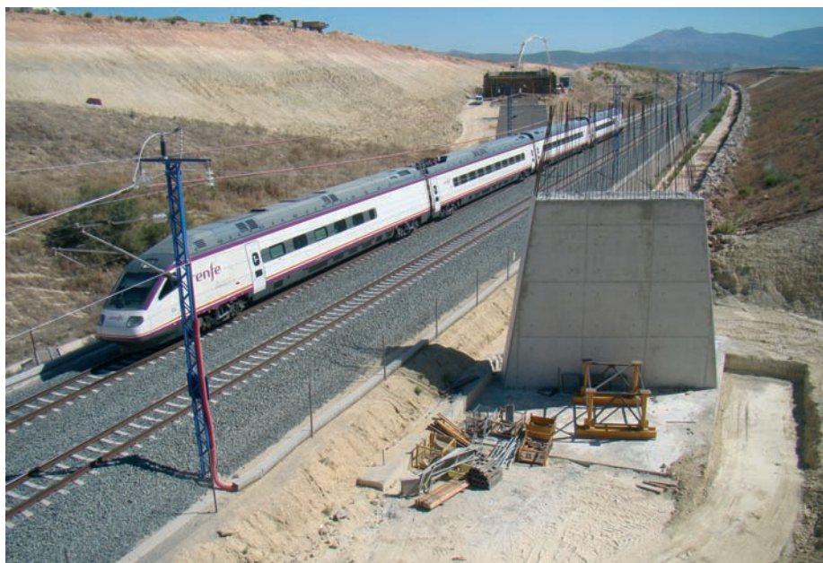
Figura 6. Paso del tren de la línea Córdoba-Málaga durante las obras
