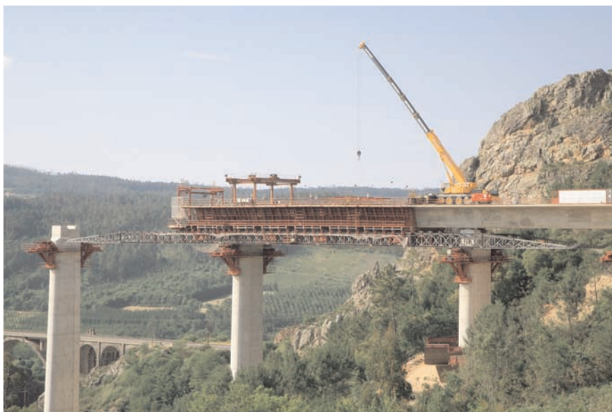
Figura 11. Ejecución del tablero con cimbra autolanzable
