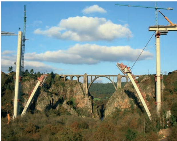
Figura 8. Alzado del arco en construcción
