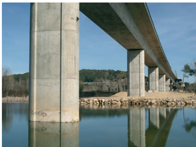
Figura 12. Viaducto sobre el río Fluvià
