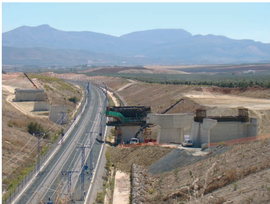
Figura 9. Vista general del puente durante la ejecución de pilas y estribos
