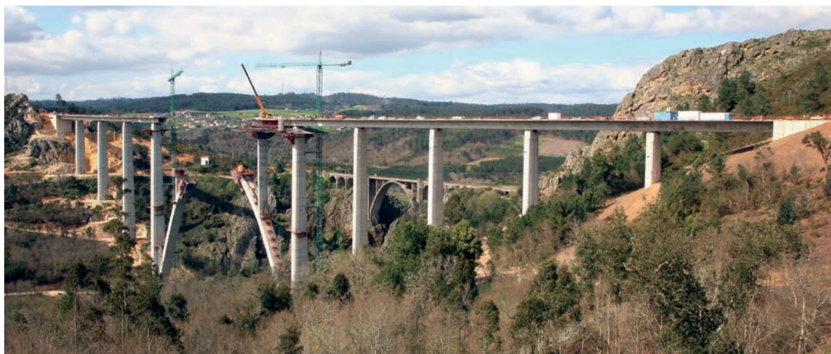
Figura 1. Situación de ejecución del viaducto en diciembre de 2009
