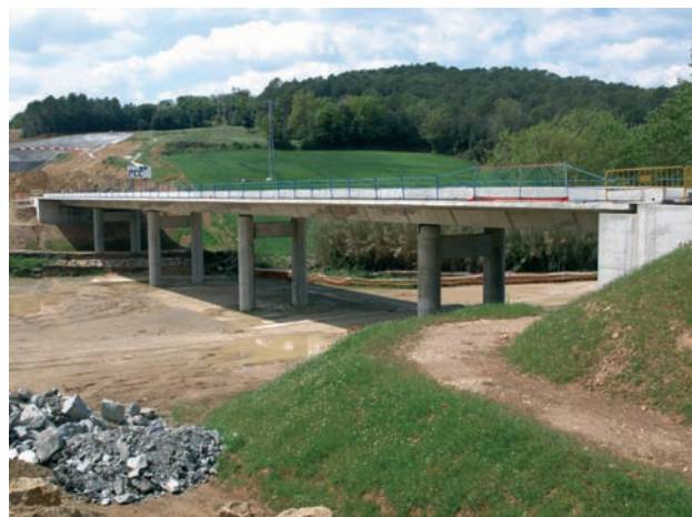
Figura 14. Viaducto sobre la riera de Casinyola
