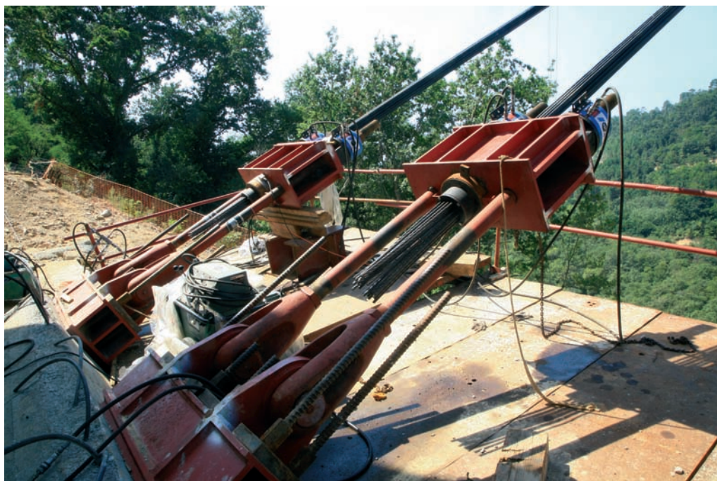
Figura 22. Estructura de transferencia en anclaje de retenida
