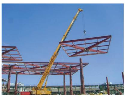
Figura 14. Montaje de un módulo mediante grúa
