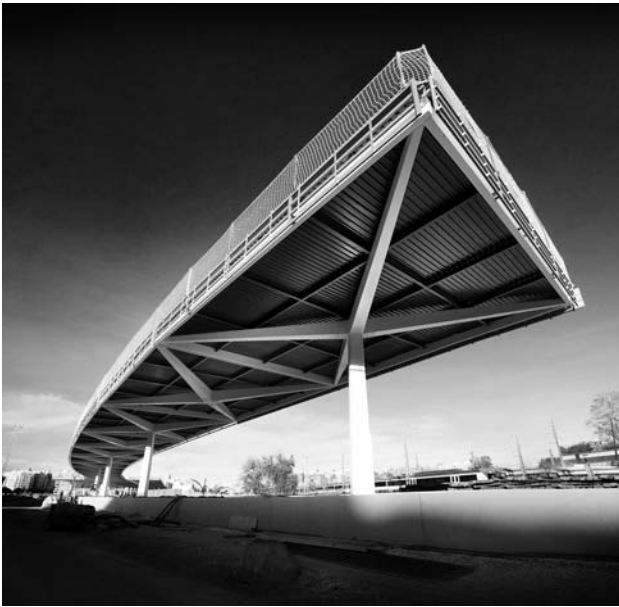
Figura 9. Extremo de la marquesina del andén curvo
