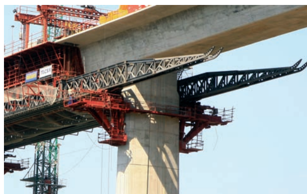
Figura 15. Apoyos de anillos en las pilas de los tramos de acceso
