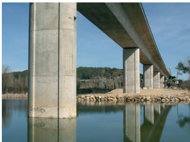
Figura 12. Viaducto sobre el río Fluvià
