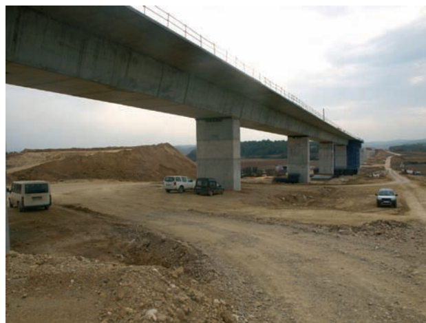
Figura 13. Viaducto sobre el Pla dels Caboters
