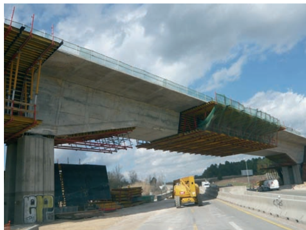
Figura 15. Viaducto sobre la carretera C-66
