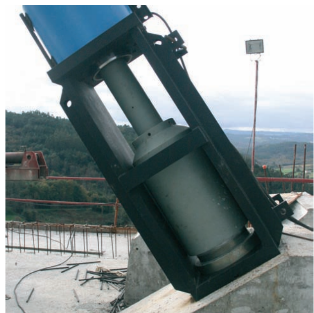
Figura 23. Gatos de tesado de tirantes con puente
