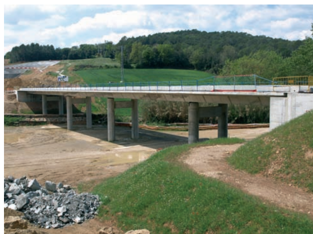
Figura 14. Viaducto sobre la riera de Casinyola
