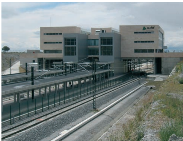
Figura 1. Situación actual de la estación Segovia Guiomar
