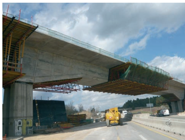
Figura 15. Viaducto sobre la carretera C-66
