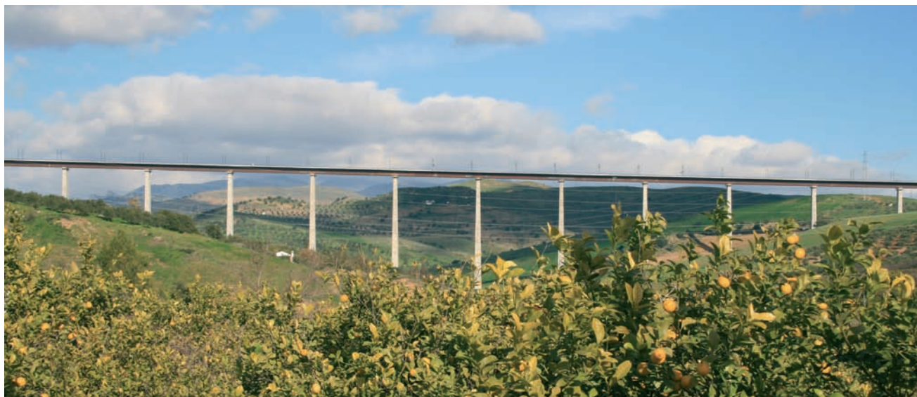
Figuras 1a y 1b. Alzado y vista del Viaducto Arroyo las Piedras
