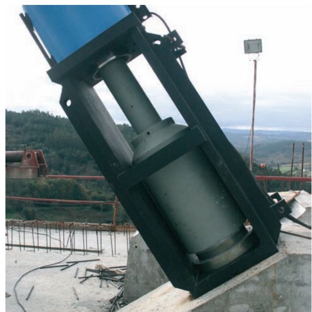
Figura 23. Gatos de tesado de tirantes con puente
