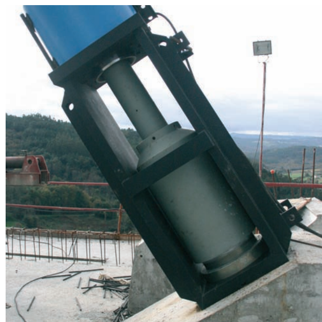
Figura 23. Gatos de tesado de tirantes con puente
