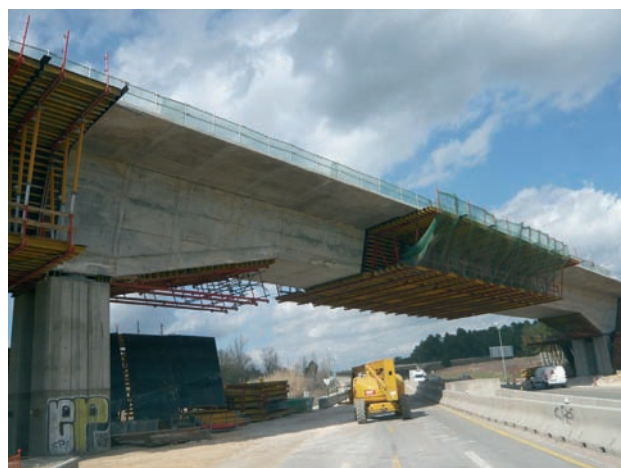
Figura 15. Viaducto sobre la carretera C-66
