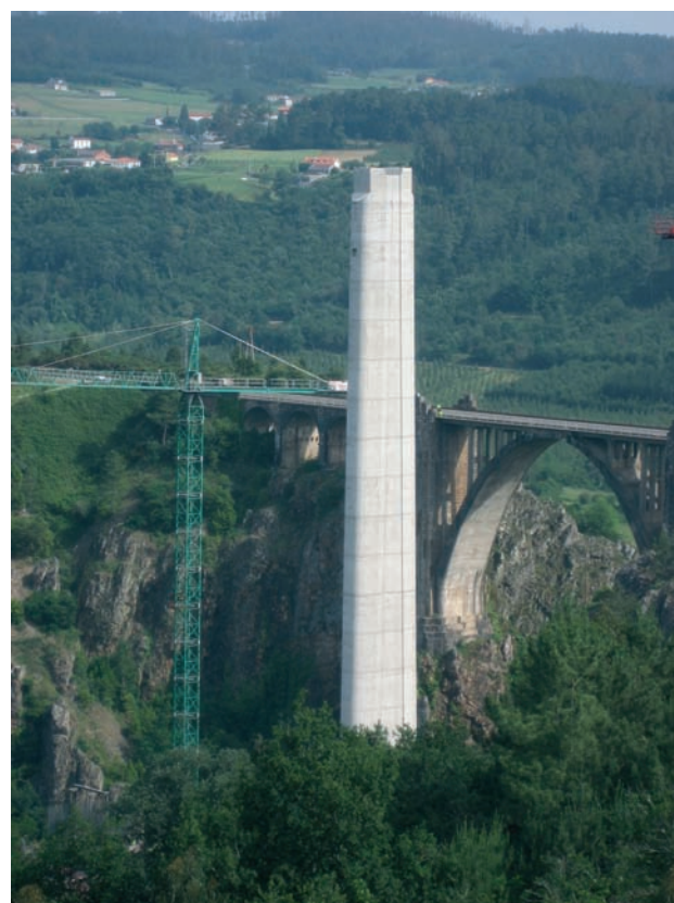
Figura 12. Fustes de pilas de tramos de acceso
