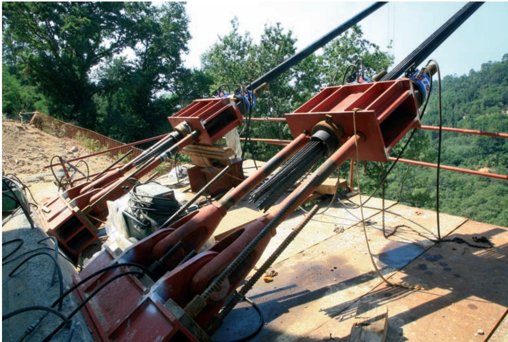
Figura 22. Estructura de transferencia en anclaje de retenida
