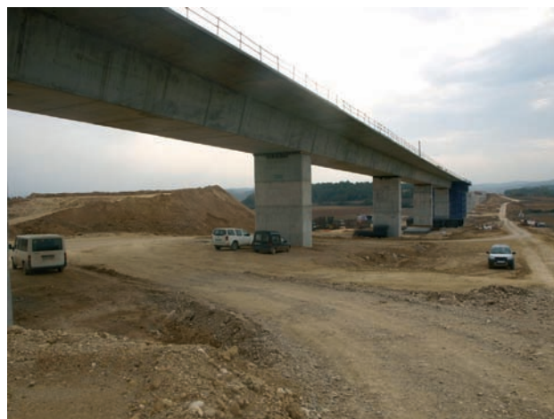
Figura 13. Viaducto sobre el Pla dels Caboters
