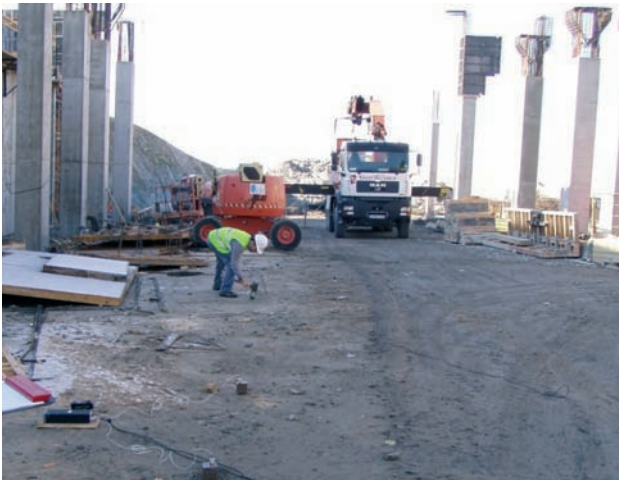
Figura 2. Disposición del equipo de medición en el ensayo SASW
