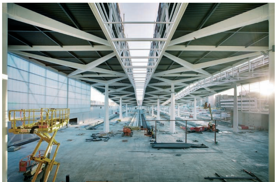
Figura 8. Vista interior desde el vestíbulo hacia andenes
