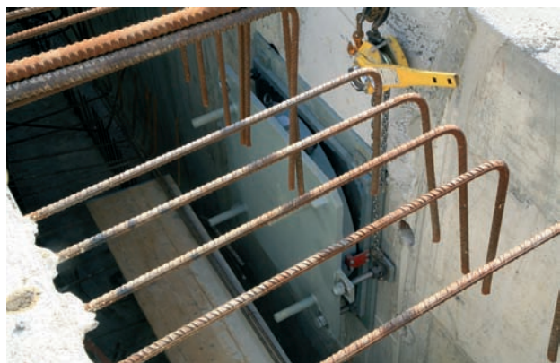
Figura 26. Apoyo POT instrumentado en estribo E1
