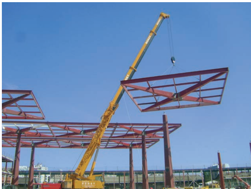
Figura 14. Montaje de un módulo mediante grúa
