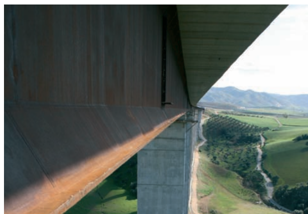
Figura 5. Vista de la viga del lado oeste al caer el sol al inicio del atardecer, con la parte inferior de la viga expuesta al sol y el resto de la viga todavía en sombra (fotografía de enero-09)
